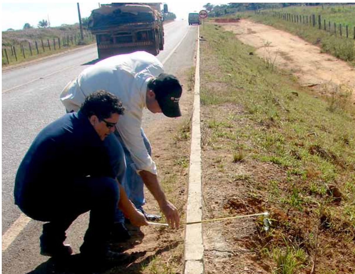
Técnicos da Secex-Obras fiscalizam também a qualidade do serviço contratado
