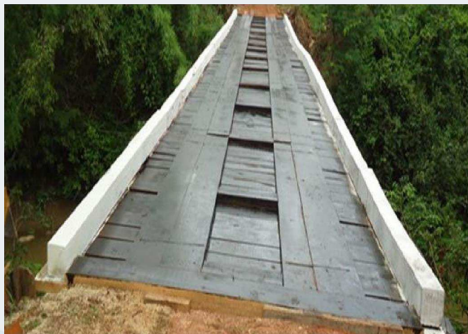
Foto da ponte demonstrando necessidade de reconstrução em 02/08/2013.
