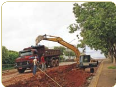
Implantação de rede de esgoto
