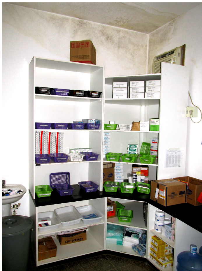
Foto 8 Teto com infiltração. PSF Ouro Fino e Serra Dourada – Cuiabá
