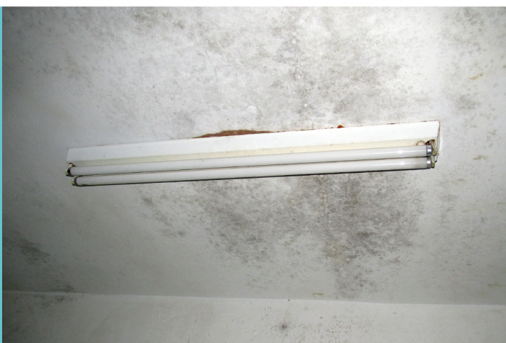
Foto 7 Sala de medicamentos com infiltração. PSF Ouro Fino e Serra Dourada – Cuiabá
