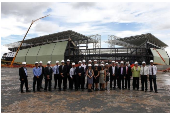
VISITA ARENA PANTANAL PELA REDE CONTROLE - DEZEMBRO/2013
