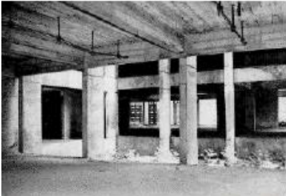
Obra: Prédio da Justiça Estadual, em Manaus (AM)
