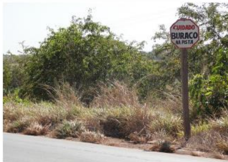
Foto 03 – placa existente no trecho
