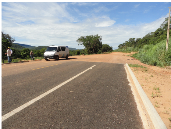
Foto 01 – fim do trecho pavimentado
