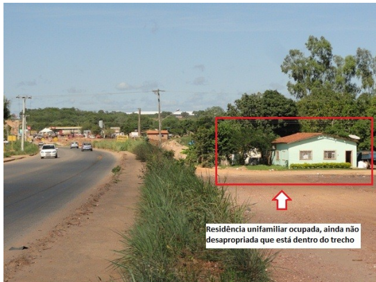
Foto 03 – casa não desapropriada no meio do trecho
