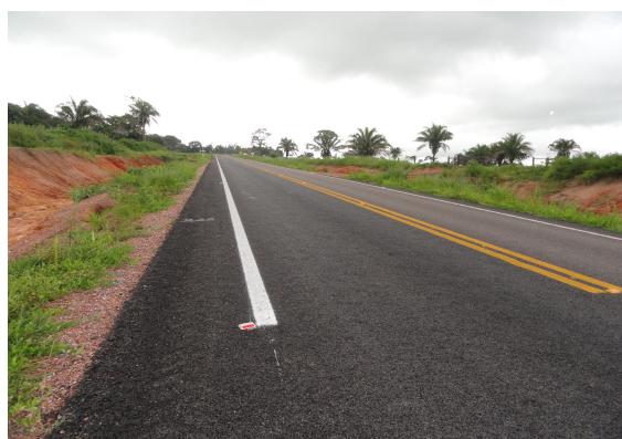
Foto 06 – pavimento sem patologias no fim do trecho
