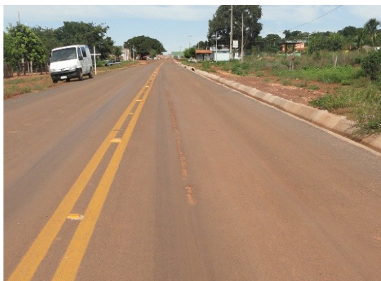
Foto 03 - desgaste no fim do trecho
