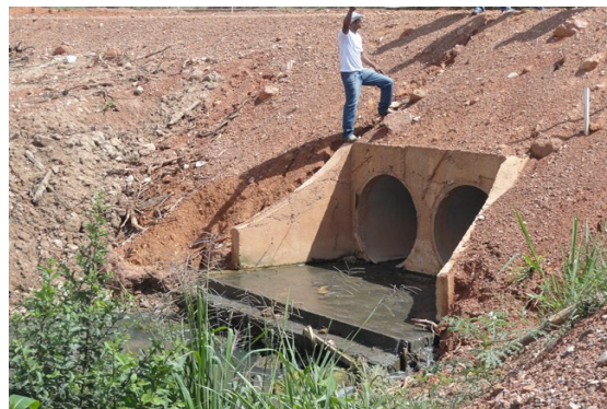
Foto 02 – medição de comprimento de bueiro
