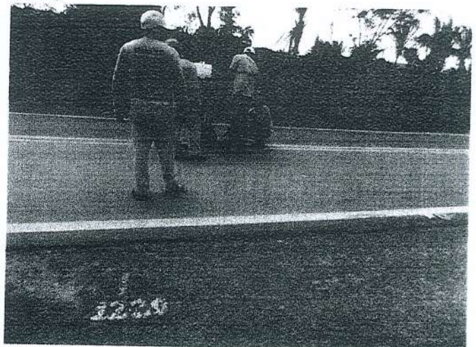
Foto 04 – coleta de amostra de CBUQ no eixo da pista.
