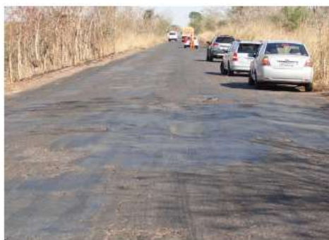
Foto 01 – pista com ondulações
