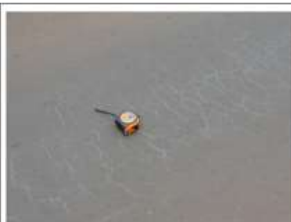
Foto 02 - fissuras a partir da estaca 130.
