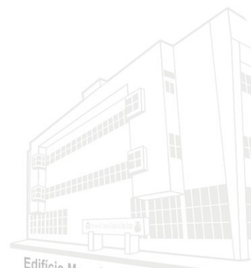
Edifício Marechal Rondon - Sede atual 2013
