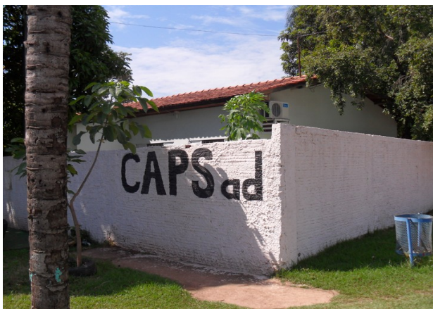
Figura 90 – Parte exterior do CAPSad
