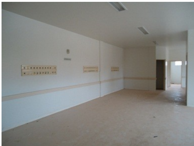
Figura 37: Obras (3) do HR de Sinop
