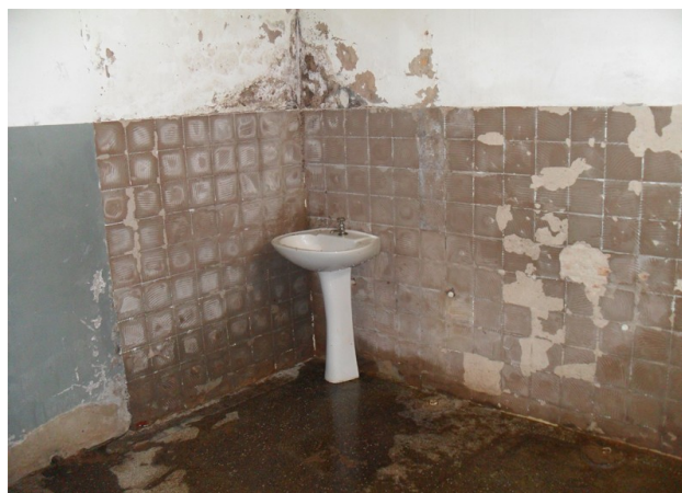
Figura 78 – Parte interna – banheiro - CIAPS Adauto Botelho (Unidade Hospitalar)
