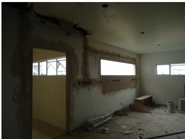
Figura 35: Obras (1) do HR de Sinop
