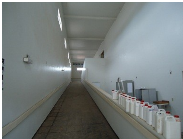
Figura 38: Obras (4) do HR de Sinop
