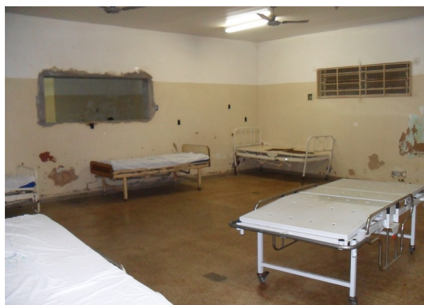
Figura 80 – Parte interna – Dormitório / Leitos - CIAPS Adauto Botelho (Unidade Hospitalar)
