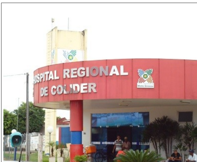
Figura 1: Fachada do Hospital Regional de Colíder
