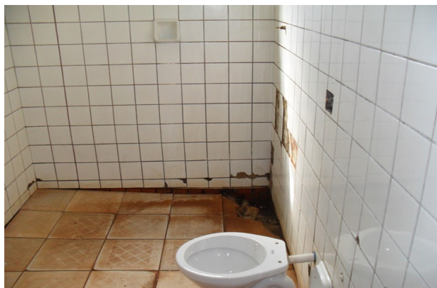
Figura 84 – Parte interna – banheiro - - CIAPS Adauto Botelho (Unidade Hospitalar)
