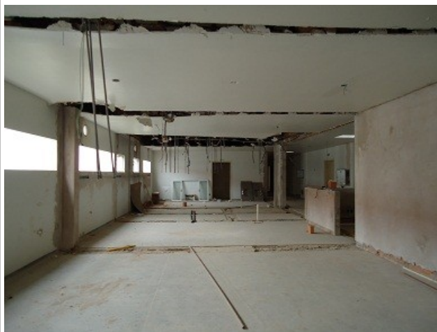
Figura 36: Obras (2) do HR de Sinop
