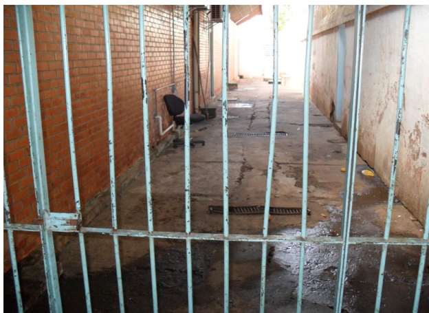
Figura 81 – Ala fechada - CIAPS Adauto Botelho (Unidade Hospitalar)
