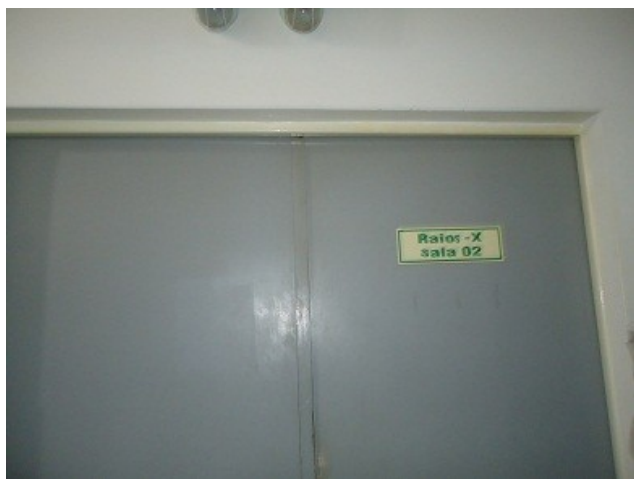
Figura 21: Sala de Raio X do HR de Sorriso
