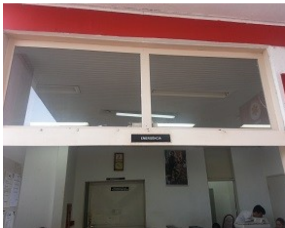
Figura 48: Entrada da emergência do HR de Rondonópolis
