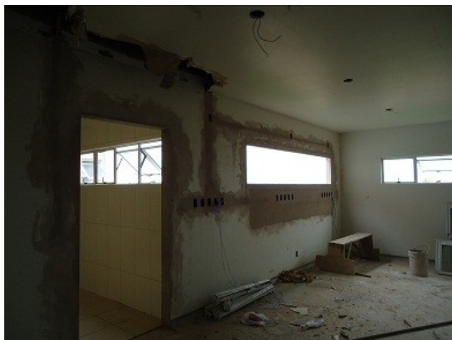
Figura 35: Obras (1) do HR de Sinop
