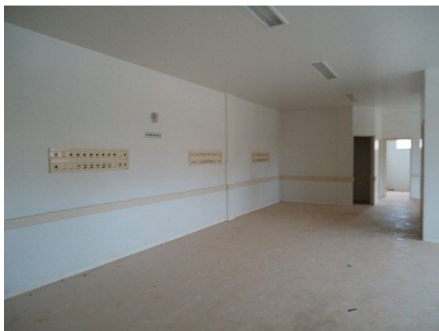
Figura 37: Obras (3) do HR de Sinop
