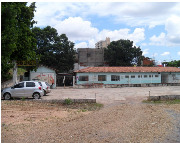
Figura 85 – Parte externa – Frente da Unidade de Atenção a Portadores de Deficiências Físico Mentais – Nosso Lar
