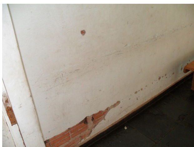
Figura 88 – Parte interior do prédio da Unidade de Atenção a Portadores de Deficiências Físico Mentais – Nosso Lar
