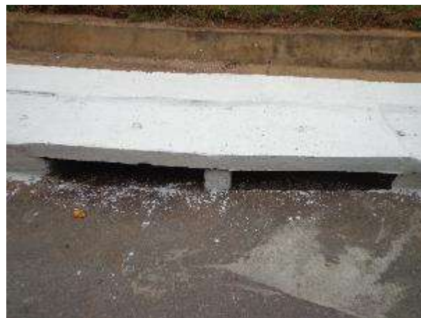
Figura 16. Pintura das canaletas concluída
