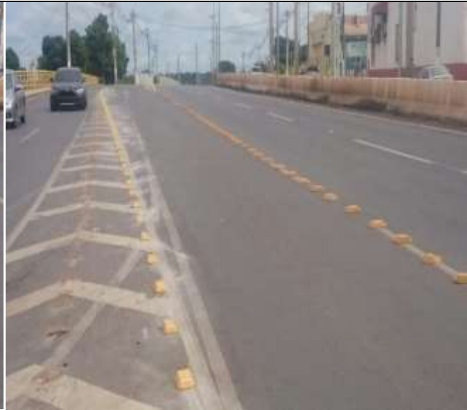
Figura 2 – Serviço corrigido, executado conforme projeto;
