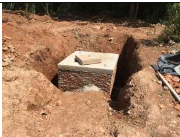
Fig. 06 – Recuperação caixa de ligação esgoto
