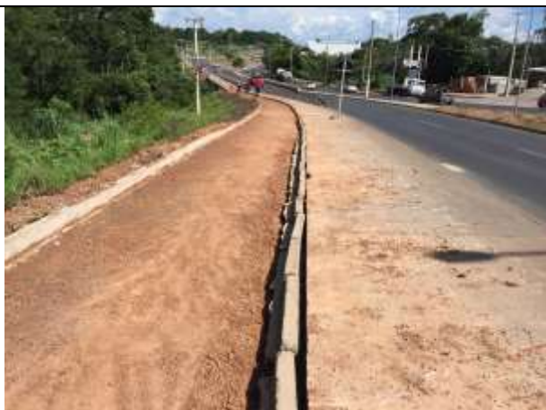
Figura 7 – Recuperação da ciclovia.
