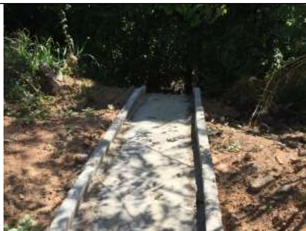
Figura 8 – Descida d'água.
