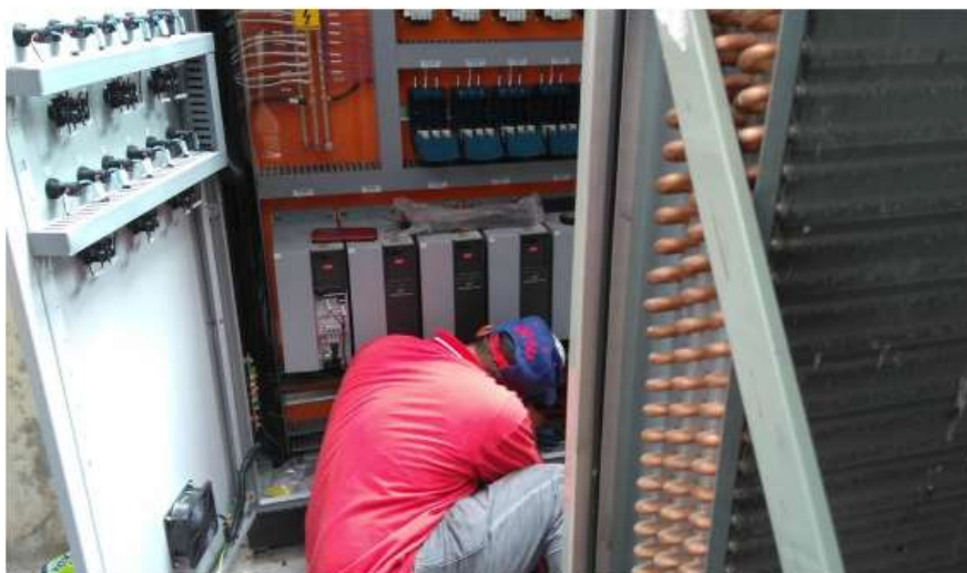
Foto 03: Instalação da infraestrutura da rede elétrica e automação Sala de Climatização 1 (TPS EIXO 3-4 Pavimento Superior)
