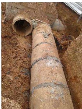
Fig. 03 – Tubo de concreto drenagem D = 1000 mm.
