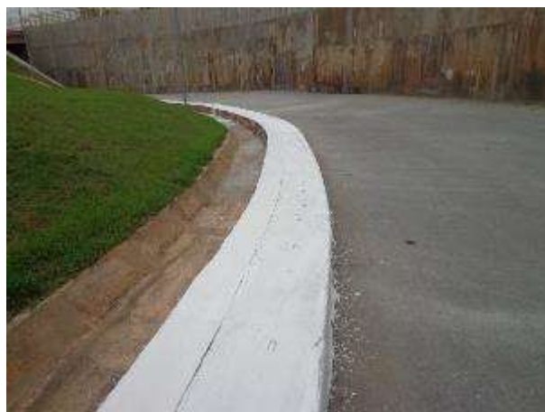
Figura 24. Pintura das canaletas concluída
