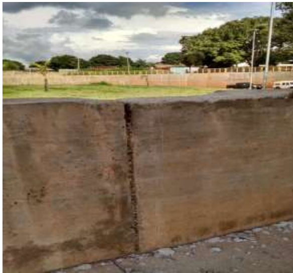
Figura 5 – Reparo de concretagem não realizado – Estaca 22 +10,00;
