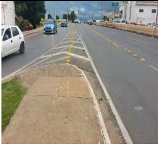
Figura 1 - Tachão colocado no centro do Zebrado;
