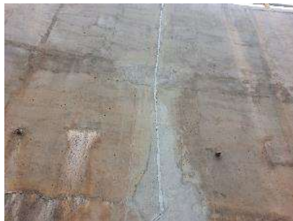
Figura 10. Reparo das juntas de dilatação
