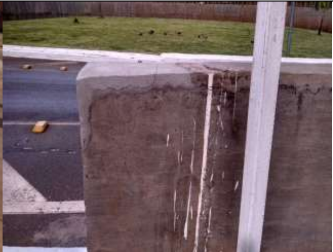
Figura 6 – Reparo de concretagem corrigido Estaca 22 +10,00;
