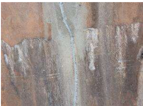
Figura 07. Reparo das juntas de dilatação
