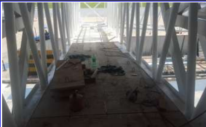
FOTO 05: Instalação de placas de concreto da base do piso da ponte de embarque 03.
