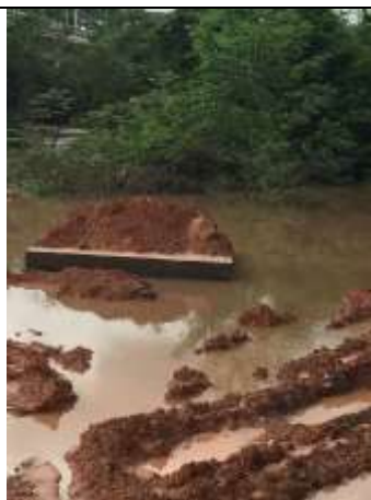
Figura 6 – CLP (caixa de ligação e passagem).
