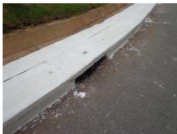
Figura 12. Pintura das canaletas concluída
