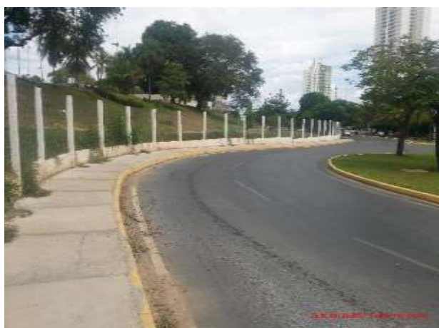
Fig. 07 – Muro limítrofe da Universidade Federal
