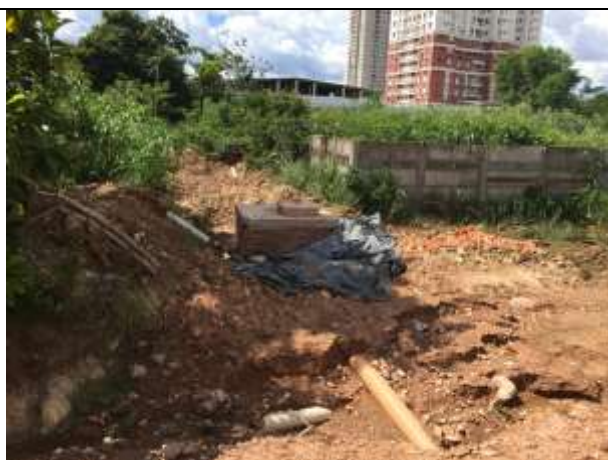
Fig. 05 – Recuperação caixa de ligação esgoto e tubulação
