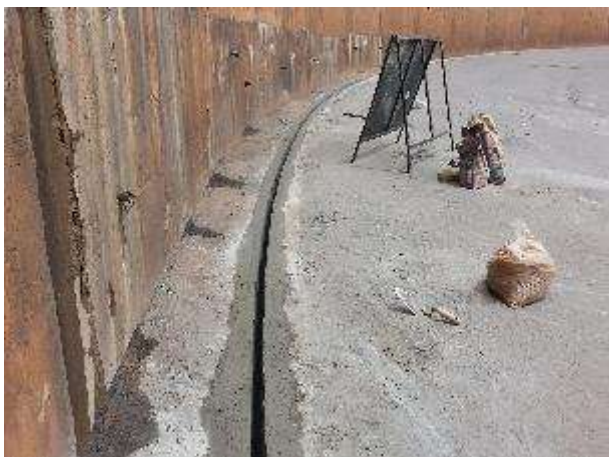
Figura 03. Finalização do serviço de construção da canaleta
