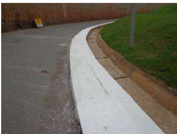
Figura 25. Pintura das canaletas concluída
