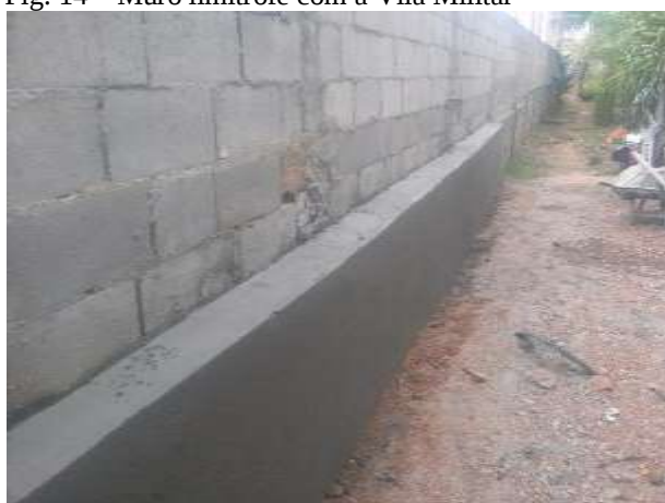
Fig. 16 – Muro limítrofe com o Aeroporto
