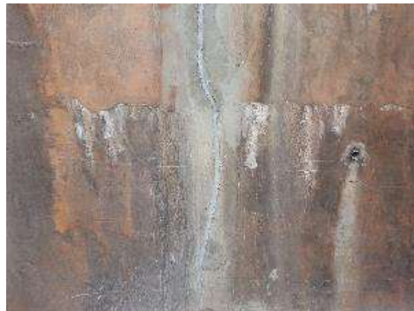
Figura 08. Reparo das juntas de dilatação
