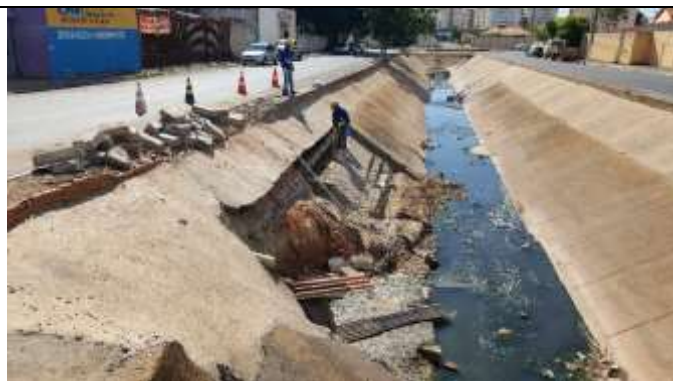
Fig. 02 – Serviço de recuperação do canal
