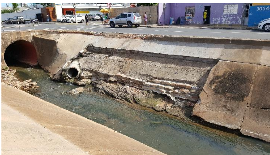
Fig. 01 – Conclusão do serviço de recuperação do canal
