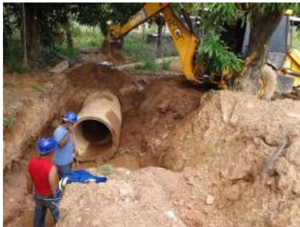
Fig. 02 – Tubo de concreto drenagem D = 1000 mm.
