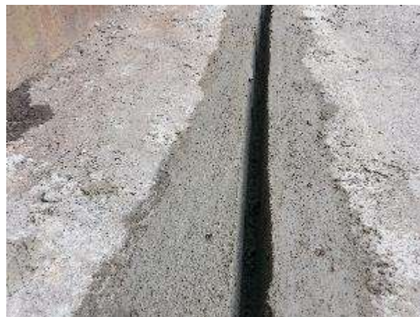
Figura 04. Finalização do serviço de construção da canaleta
