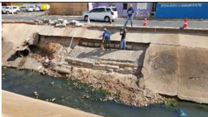
Fig. 01 – Serviço de recuperação do canal
