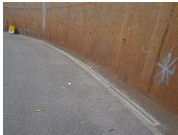
Figura 18. Construção da canaleta concluída
