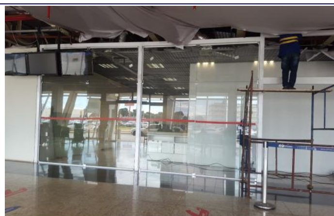
FOTO 09: Instalação de Divisória de Vidro na saída da Alfandega.
