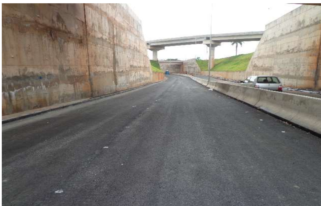
Foto 3.4 – Pavimentação asfáltica CBUQ.
