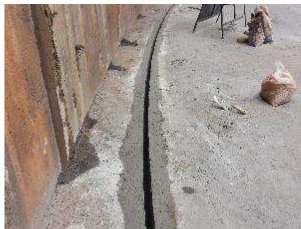
Figura 02. Finalização do serviço de construção da canaleta
