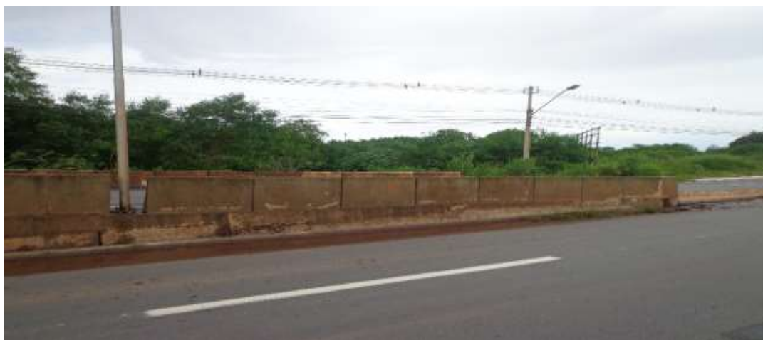
Foto 3.1 – Guarda-corpo tipo New Jersey.
