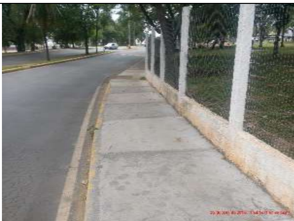
Fig. 06 – Muro limítrofe da Universidade Federal
