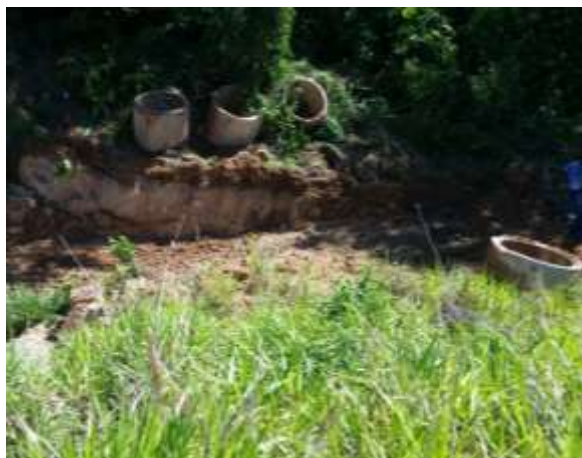
Figura 3 – Início dos Trabalhos.
