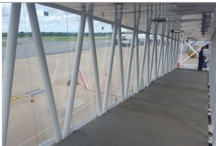
FOTO 11: Instalação do Túnel de Embarque 03
