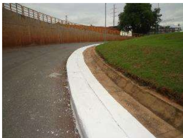
Figura 13. Pintura das canaletas concluída
