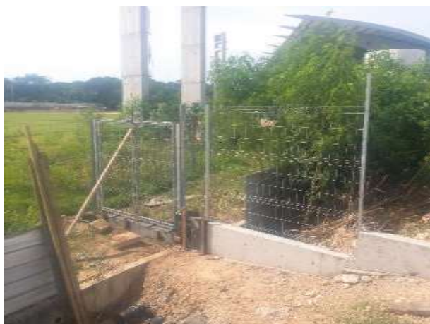
Fig. 08 – Cerca de fechamento com painéis galvanizados, h = 2,00 m.
