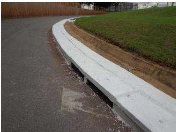
Figura 21. Pintura das canaletas concluída
