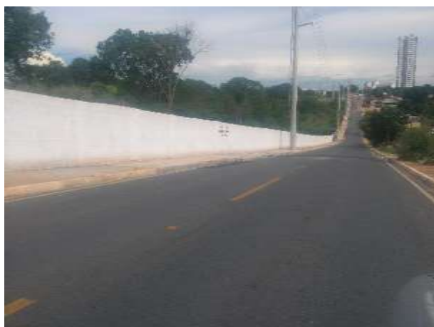
Fig. 12 – Muro limítrofe com a Vila Militar
