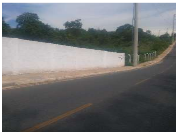
Fig. 14 – Muro limítrofe com a Vila Militar
