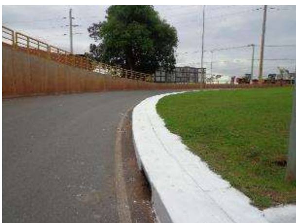
Figura 19. Pintura das canaletas concluída
