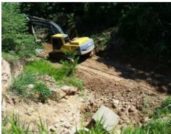
Figura 4 – Início dos Trabalhos, escavação.
