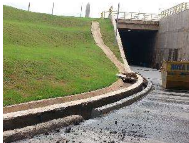
Figura 06. Recuperação da canaleta de drenagem
