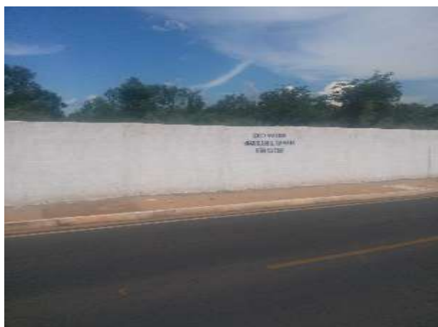
Fig. 11 – Muro limítrofe com a Vila Militar
