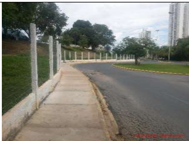
Fig. 05 – Muro limítrofe da Universidade Federal
