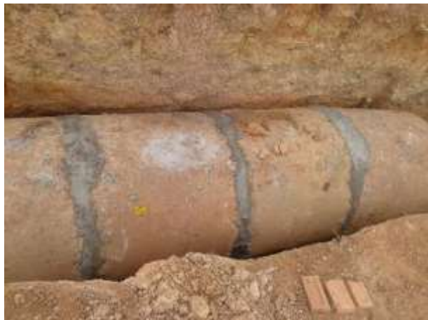
Fig. 01 – Tubo de concreto drenagem D = 1000 mm.
