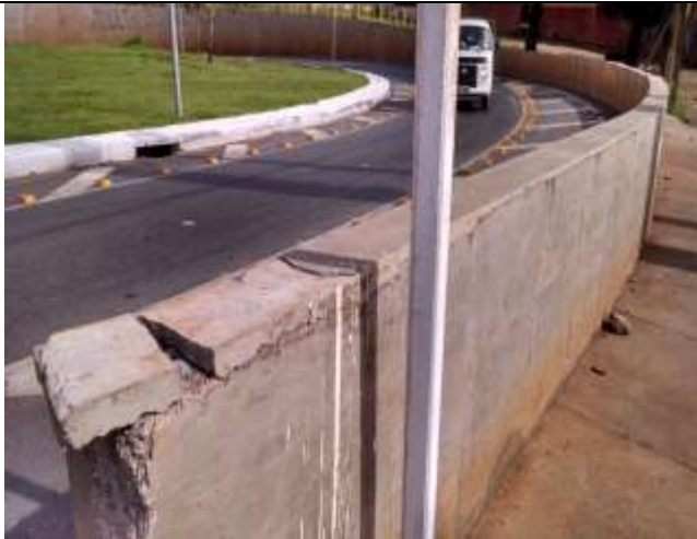
Figura 5 – Reparo de concretagem não realizado – Estaca 22 +10,00;
