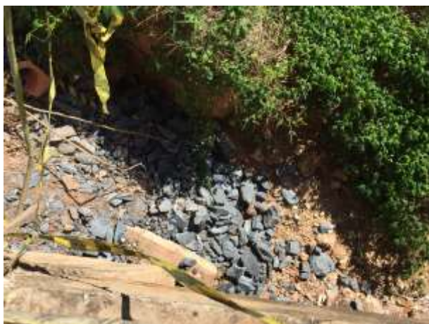
Figura 5 - Reposição Do Enrocamento Da Cabeceira Da Ponte.
