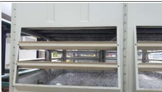
FOTO 04: Teste Hidráulico das Torres de Resfriamento.
