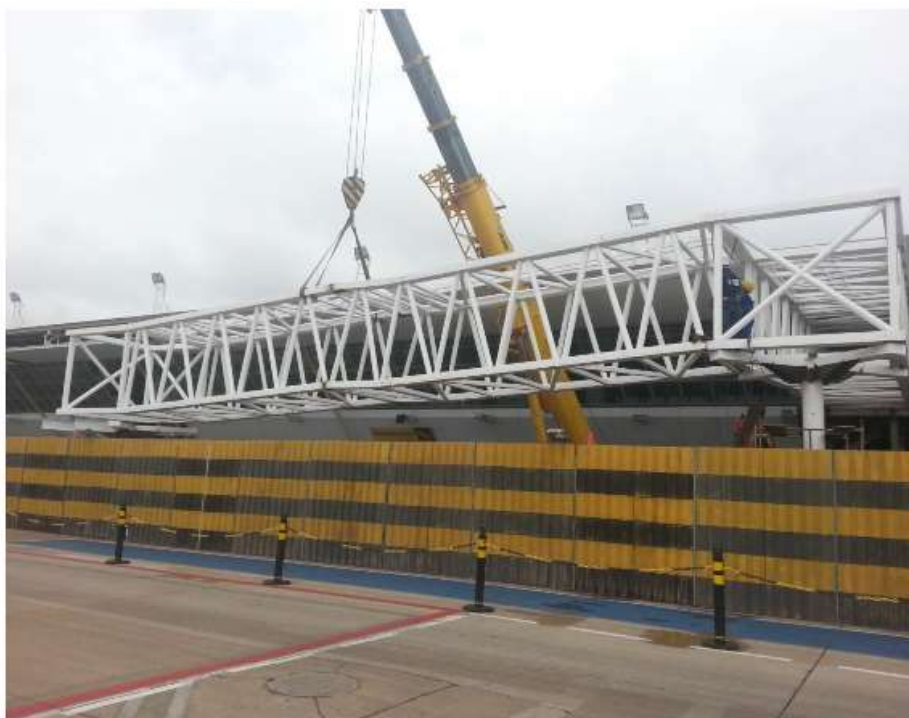
Foto 02: Instalação da Estrutura da Ponte de Embarque 03.
