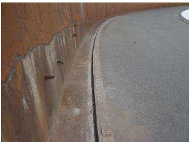
Figura 23. Construção da canaleta concluída
