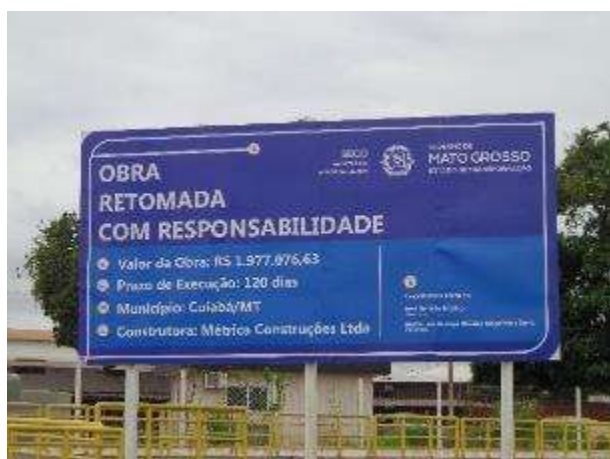
Figura 11. Instalação de placas de obra
