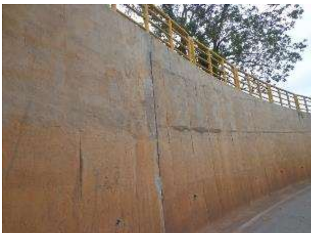
Figura 17. Reparo das juntas concluído
