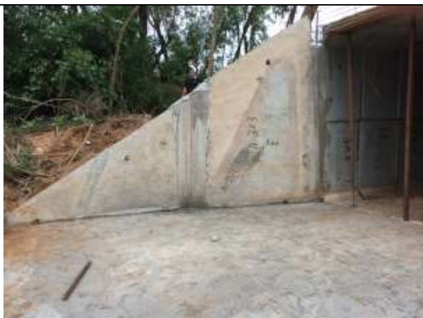
Fig. 03 – Concretagem da Boca da Galeria.
