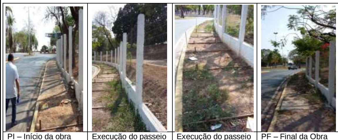
Figura 01 – Relatório fotográfico da vistoria realizada em 27/10/2015.
