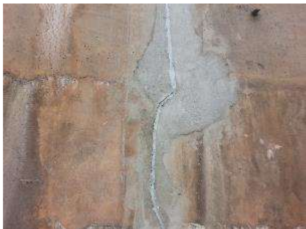
Figura 09. Reparo das juntas de dilatação
