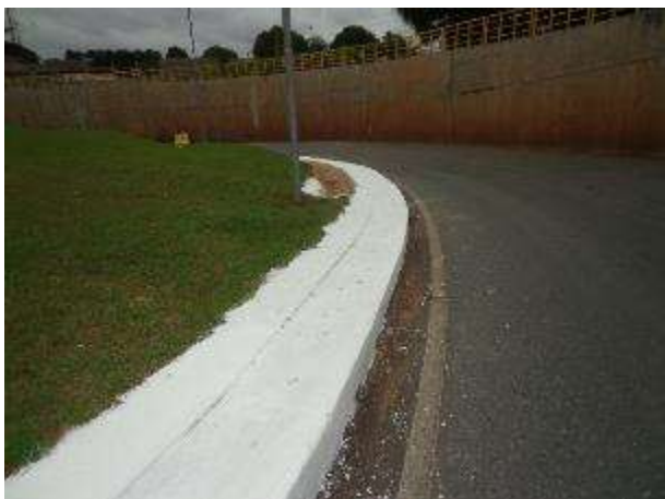
Figura 15. Pintura das canaletas concluída
