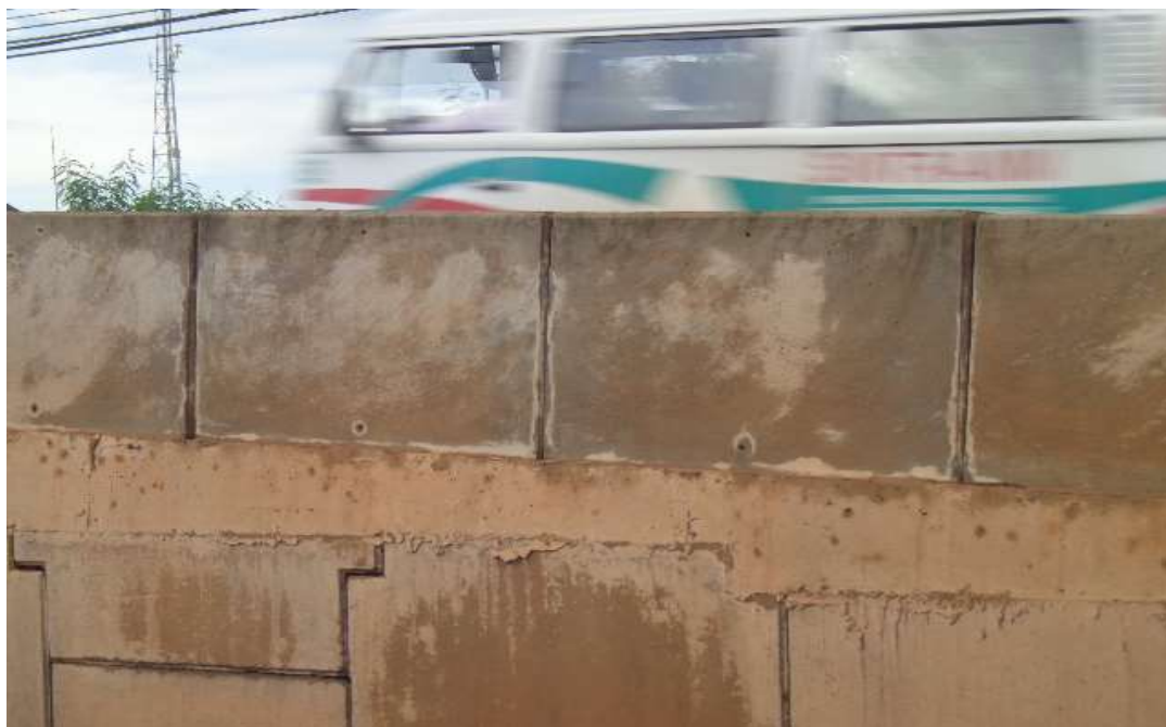
Foto 3.2 – Guarda-corpo tipo New Jersey.
