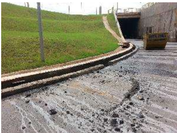
Figura 05. Recuperação da canaleta de drenagem
