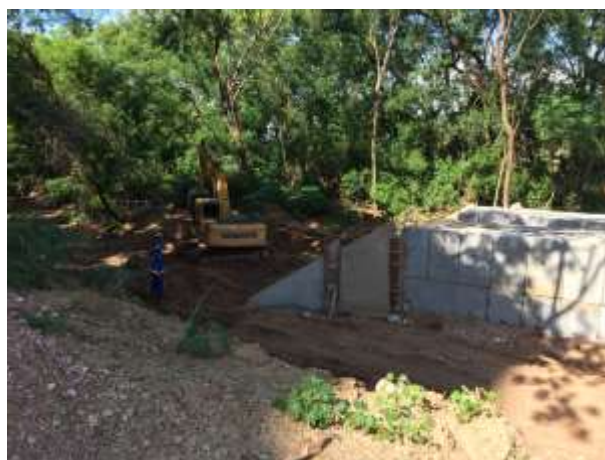
Fig. 02 – Montagem das Alas (Boca da Galeria).
