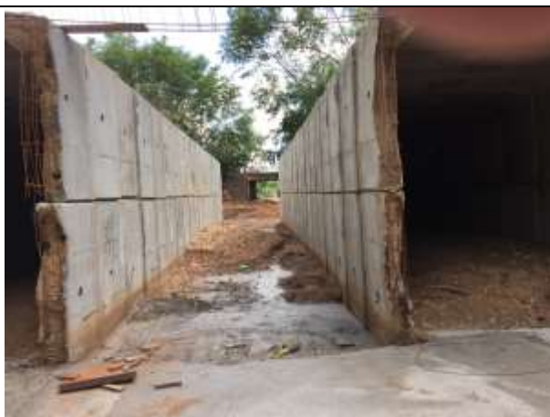
Fig. 04 – Concretagem de parte do berço da galeria.
