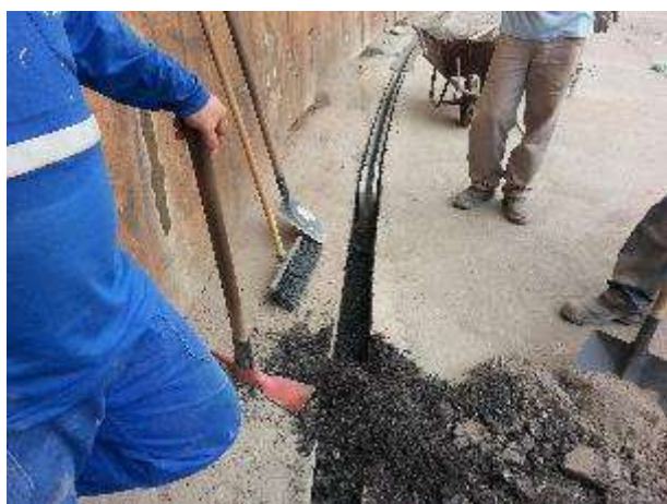
Figura 01. Construção da canaleta de concreto
