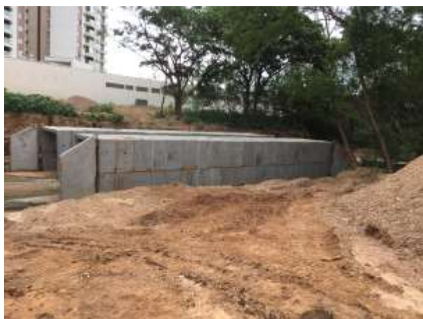
Fig. 01 – Montagem Galerias- Alça Rotatória Brasília.
