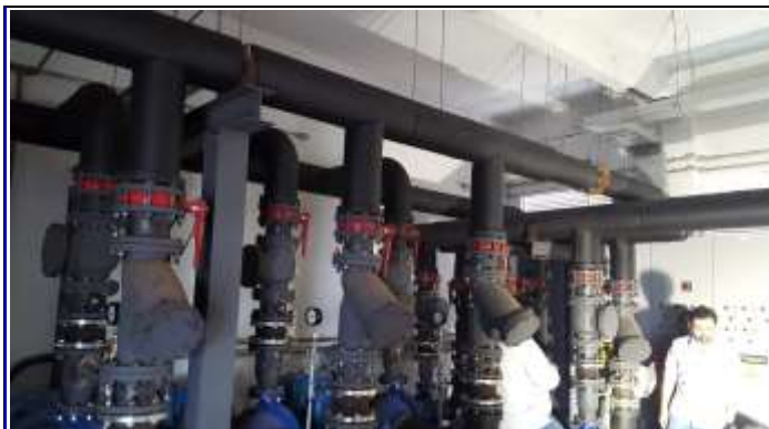
FOTO 03: Instalação do Isolamento térmico da tubulação de água gelada.
