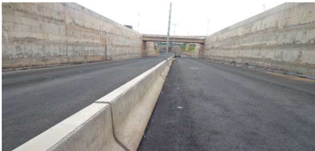
Foto 3.5 – Pavimentação asfáltica CBUQ.
