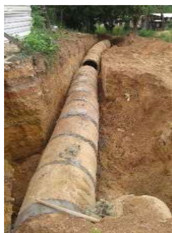
Fig. 04 – Tubo de concreto drenagem D = 1000 mm.
