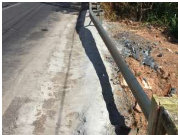
Figura 6 – Concretagem temporária da erosão.
