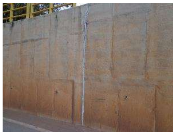
14. Reparo das juntas concluído
