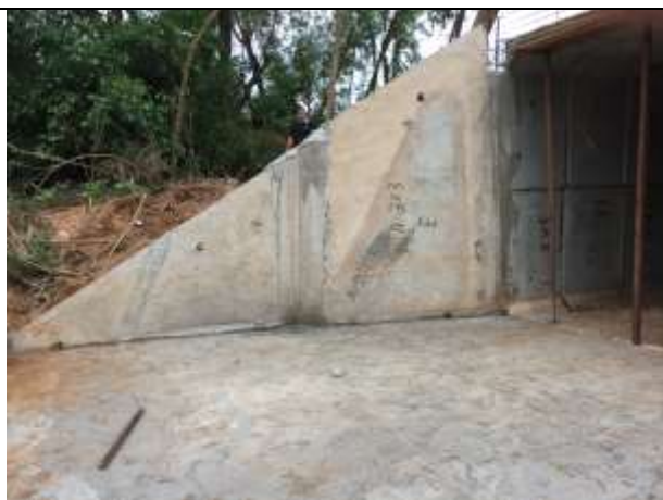
Fig. 01 – Boca da galeria executada.
