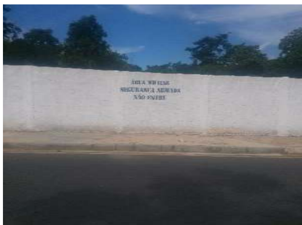
Fig. 13 – Muro limítrofe com a Vila Militar
