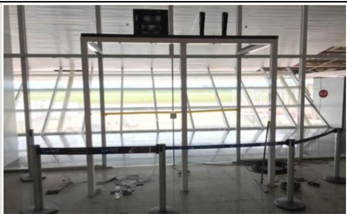
FOTO 08: Instalação do sistema SIV.
