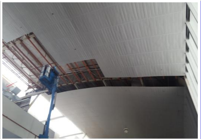
FOTO 02: Instalação de forro perfurado entre os eixos 13-14
