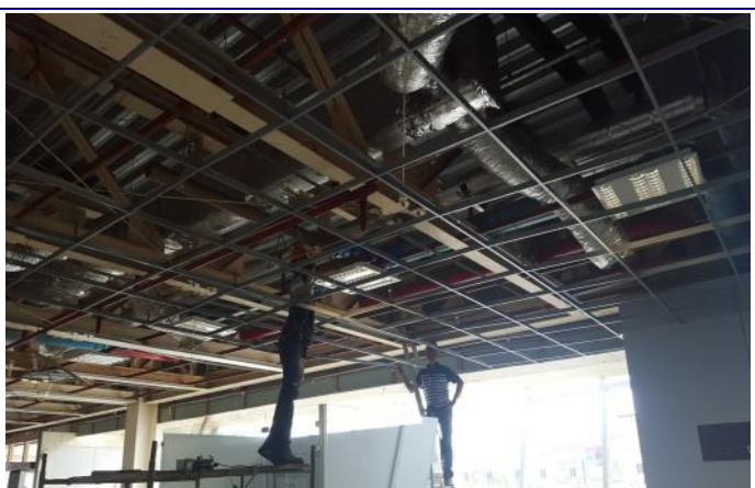
FOTO 10: Instalação de forro metálico tipo colméia.
