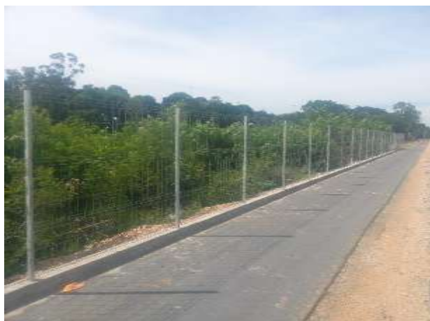
Fig. 07 – Cerca de fechamento com painéis galvanizados, h = 2,00 m.
