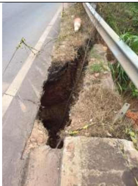
Figura 2 – Detalhe do acostamento.
