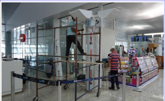
FOTO 06: Aplicação de Revestimentos em ACM
