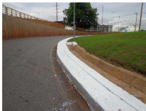
Figura 20. Pintura das canaletas concluída
