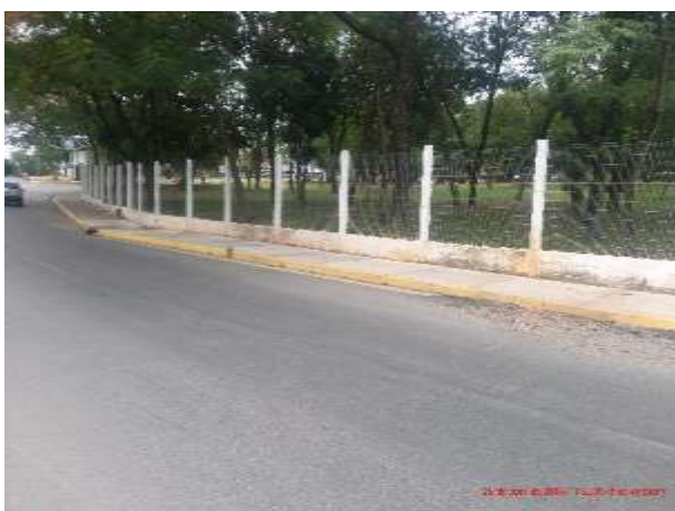
Fig. 08 – Muro limítrofe da Universidade Federal
