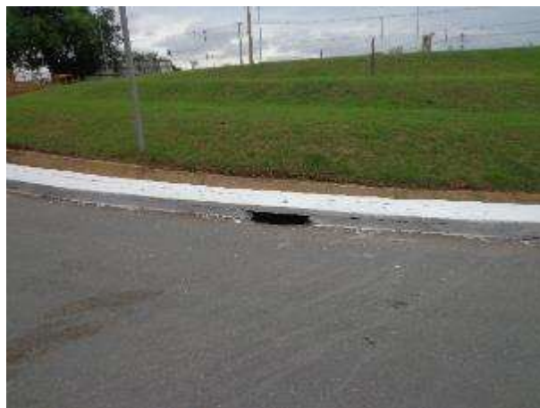
Figura 22. Pintura das canaletas concluída
