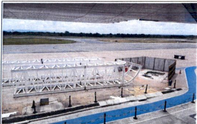
FOTO 13: Execução da ponte 04 - Túnel de embarque.
