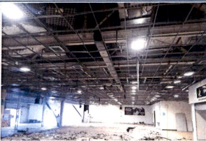
FOTO 06: Reforma Setor "C" Retirada dos forros colméia.
