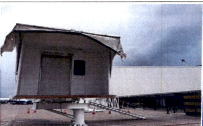
FOTO 12: Revitalização da parte móvel da ponte 03.
