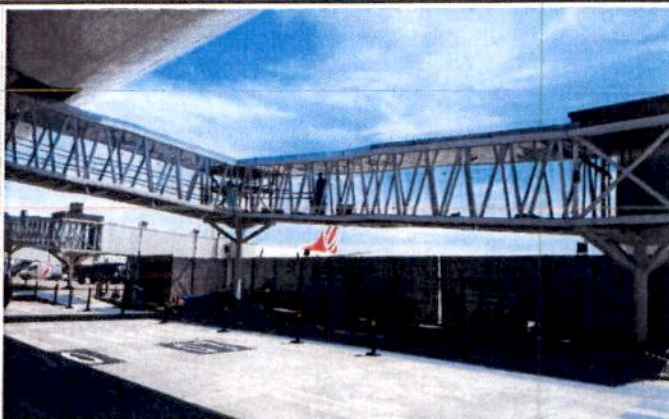
FOTO 08: Tinel da Ponte 03 em Fase de acabamento.
