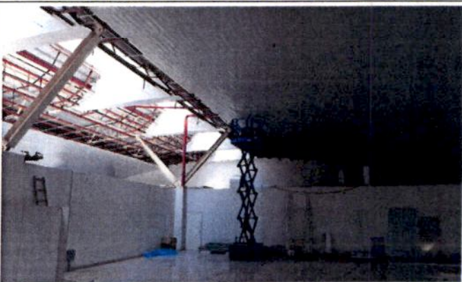
FOTO 10: Forro Pavimento superior em fase de conclusão.
