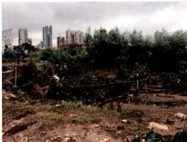
Figura 10- Canal obstru o pelos entulhos.
