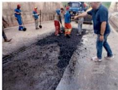
Reparo no pavimento asfáltico
