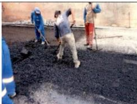
Reparo no pavimento asfáltico
