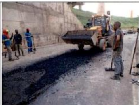
Reparo no pavimento asfáltico
