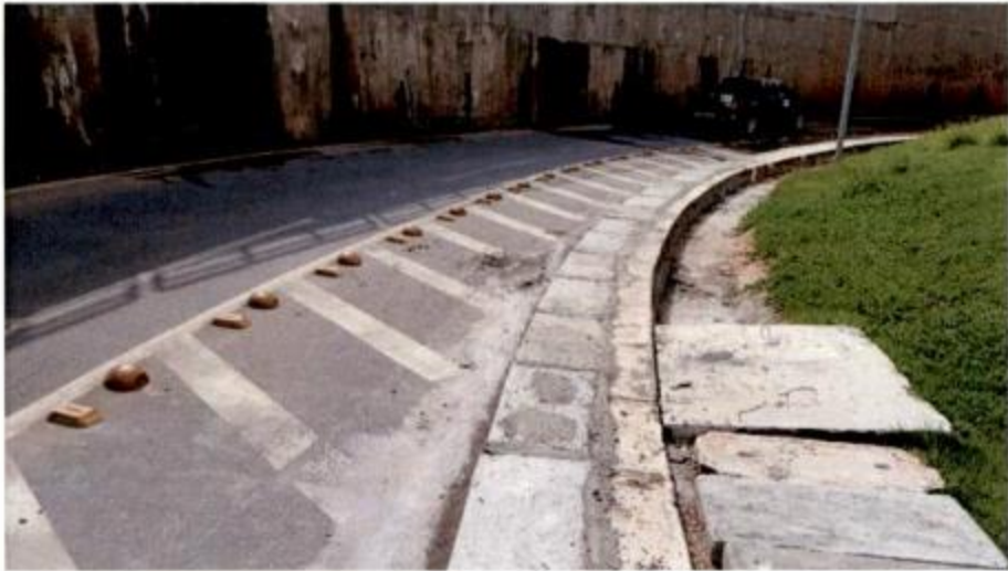
Fig. 06 – Estreitamento da pista e correção das tampas de drenagem
