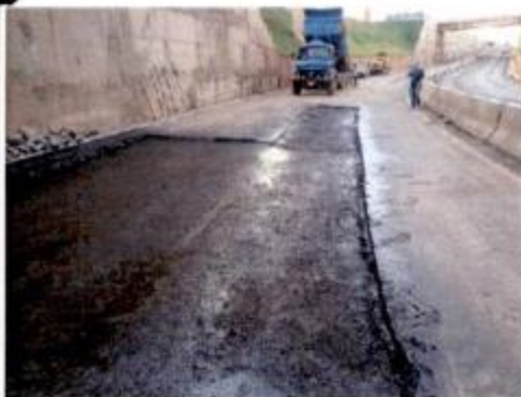
Reparo no pavimento asfáltico
