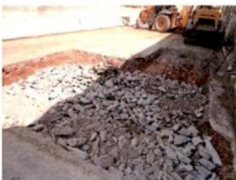
Reparo no pavimento asfáltico
