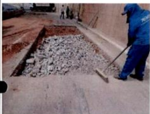
Reparo no pavimento asfáltico
