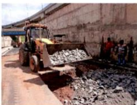
Reparo no pavimento asfáltico
