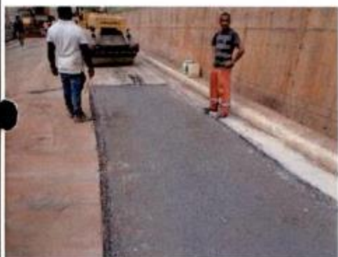
Reparo no pavimento asfáltico
