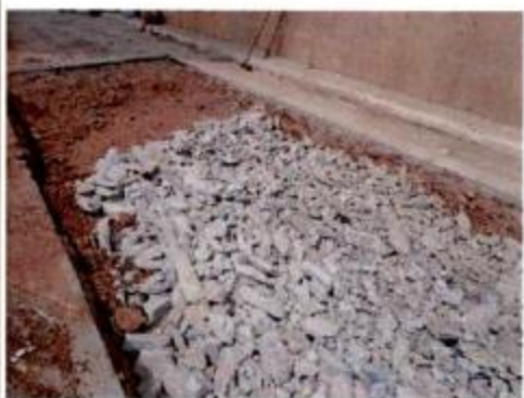
Reparo no pavimento asfáltico
