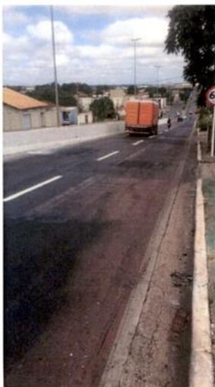
Fig. 14 – Pintura da sinalização horizontal
