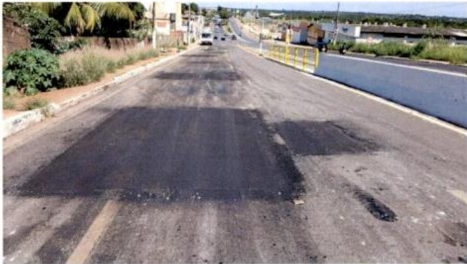
Fig. 09 – Fresagem do pavimento.
