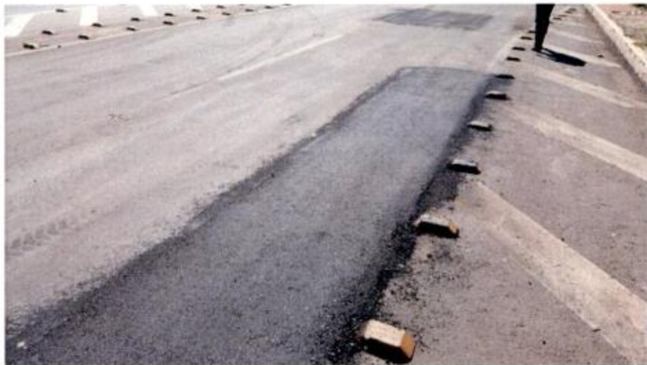
Fig. 10 – Fresagem do pavimento.
