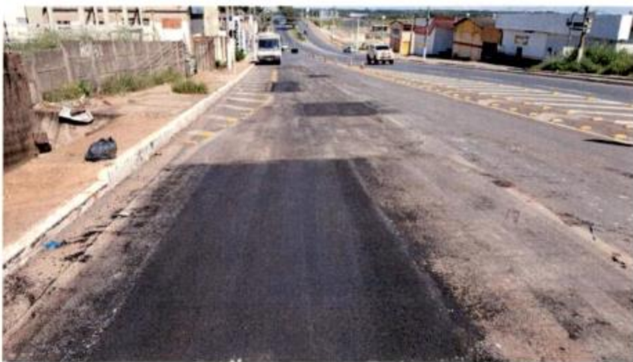
Fig. 08 – Fresagem do pavimento.
