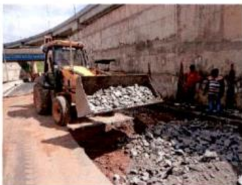
Reparo no pavimento asfáltico
