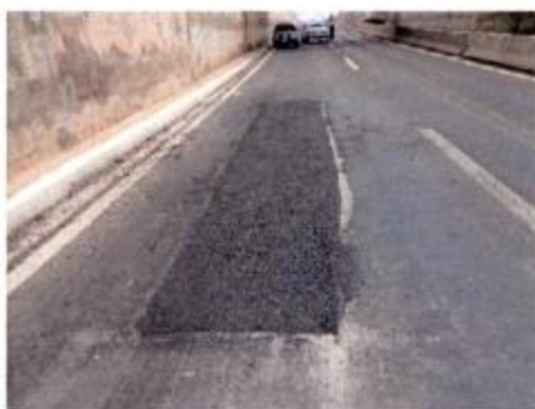
Reparo no pavimento asfáltico
