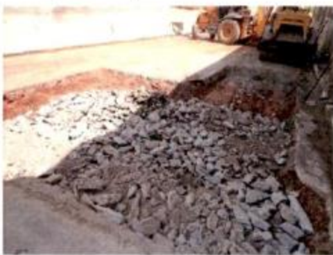
Reparo no pavimento asfáltico
