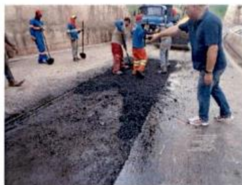
Reparo no pavimento asfáltico
