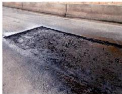
Reparo no pavimento asfáltico
