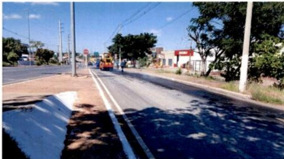
Fig. 11 – Fresagem do pavimento.
