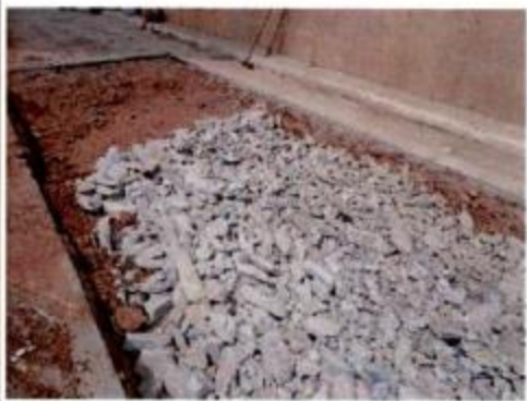
Reparo no pavimento asfáltico
