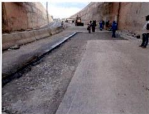
Reparo no pavimento asfáltico
