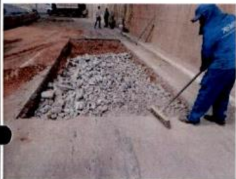
Reparo no pavimento asfáltico
