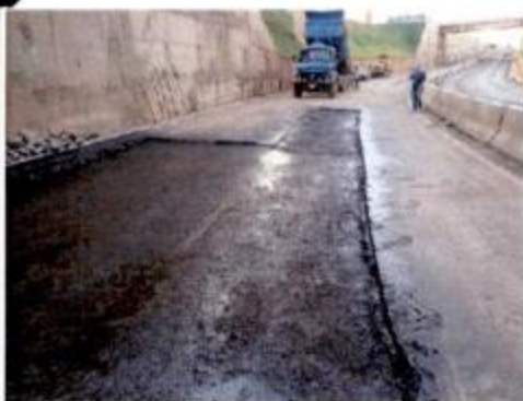
Reparo no pavimento asfáltico
