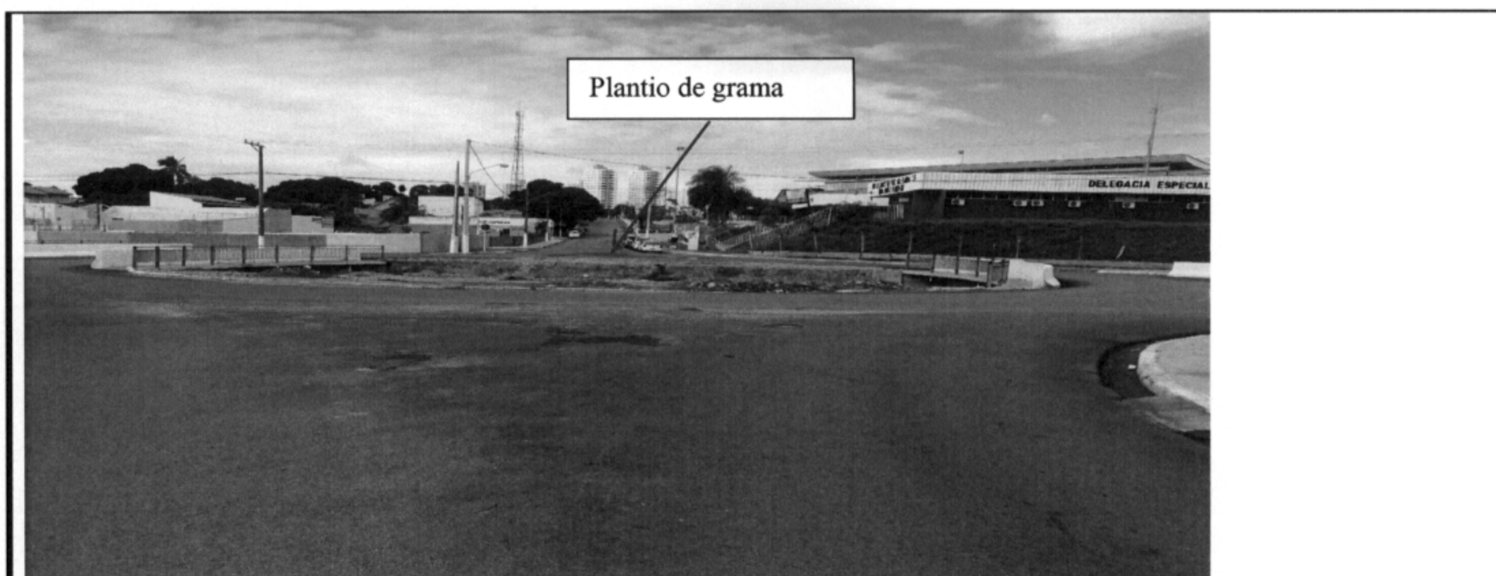
Figura 27: Concluir execução da rotatória de acordo com o projeto.
