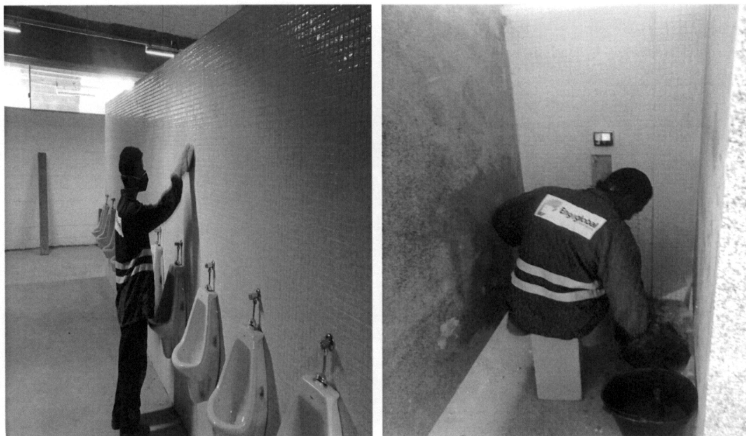
Figura 4 - execução dos serviços de louças e metais;
