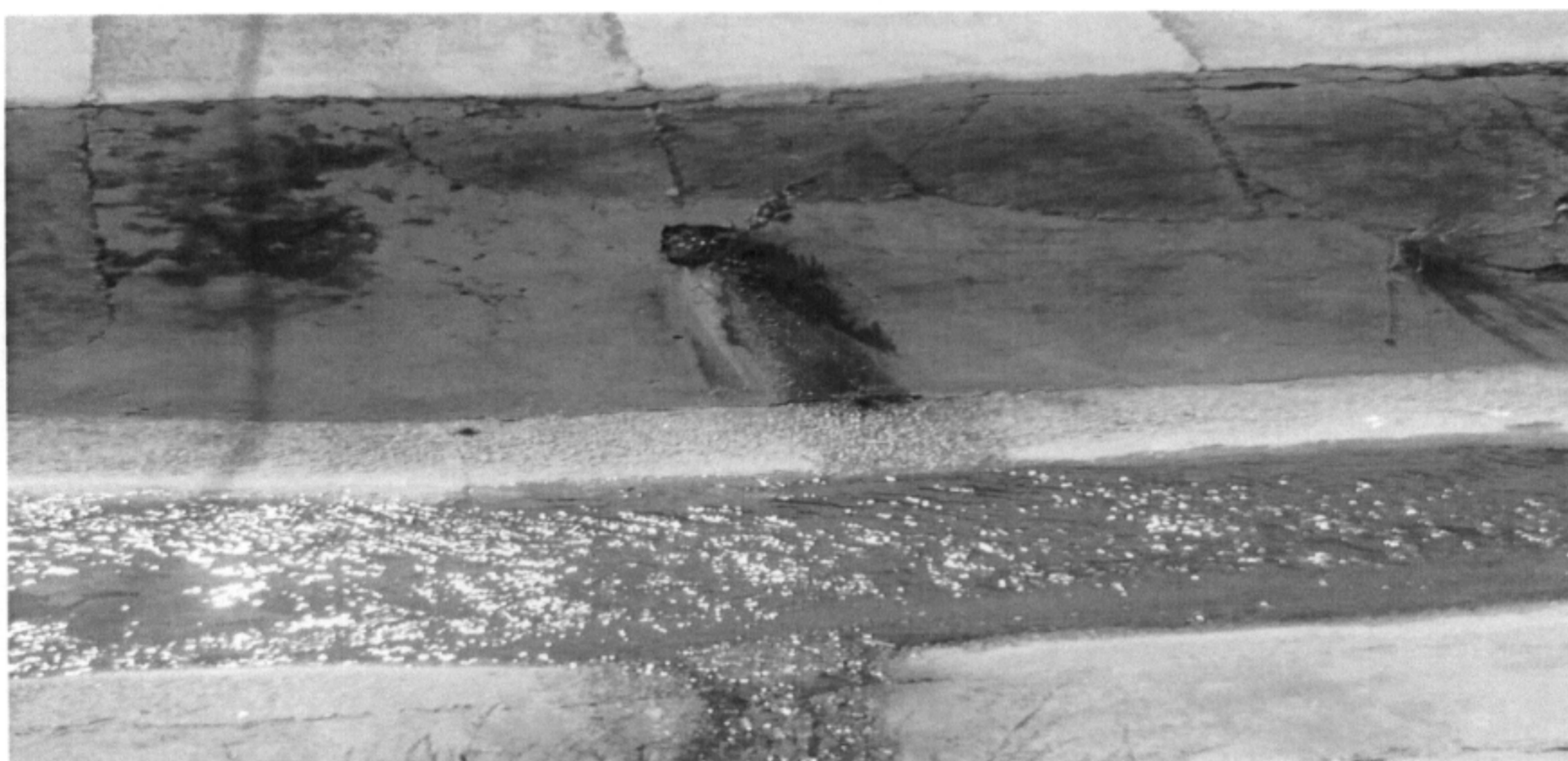
Figura 16: Serviço a ser executado de acordo com o projeto – Argamassa projetada.
