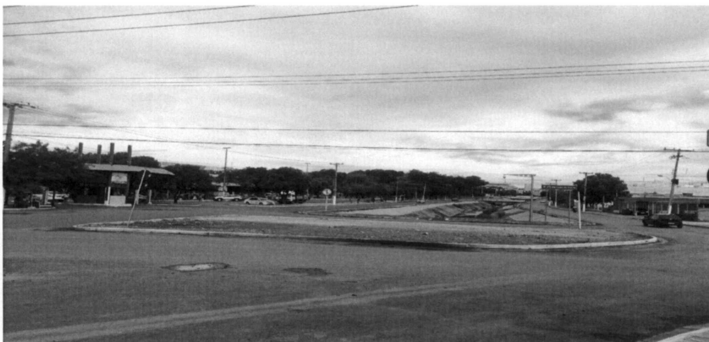
Figura 19: Não execução da Rotatória da Rua 13 de Junho
