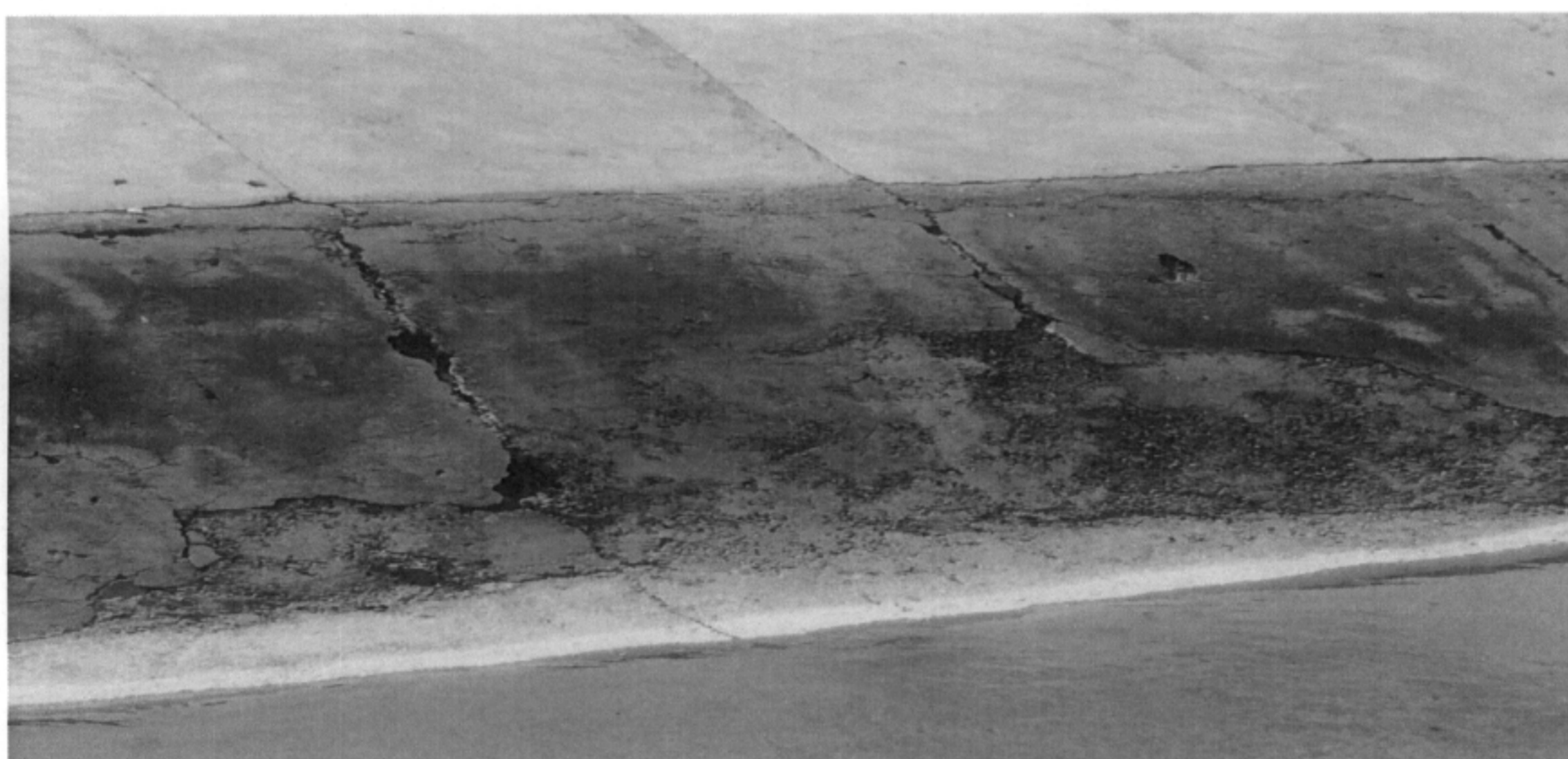
Figura 17: Serviço a ser executado de acordo com o projeto – Argamassa projetada.
