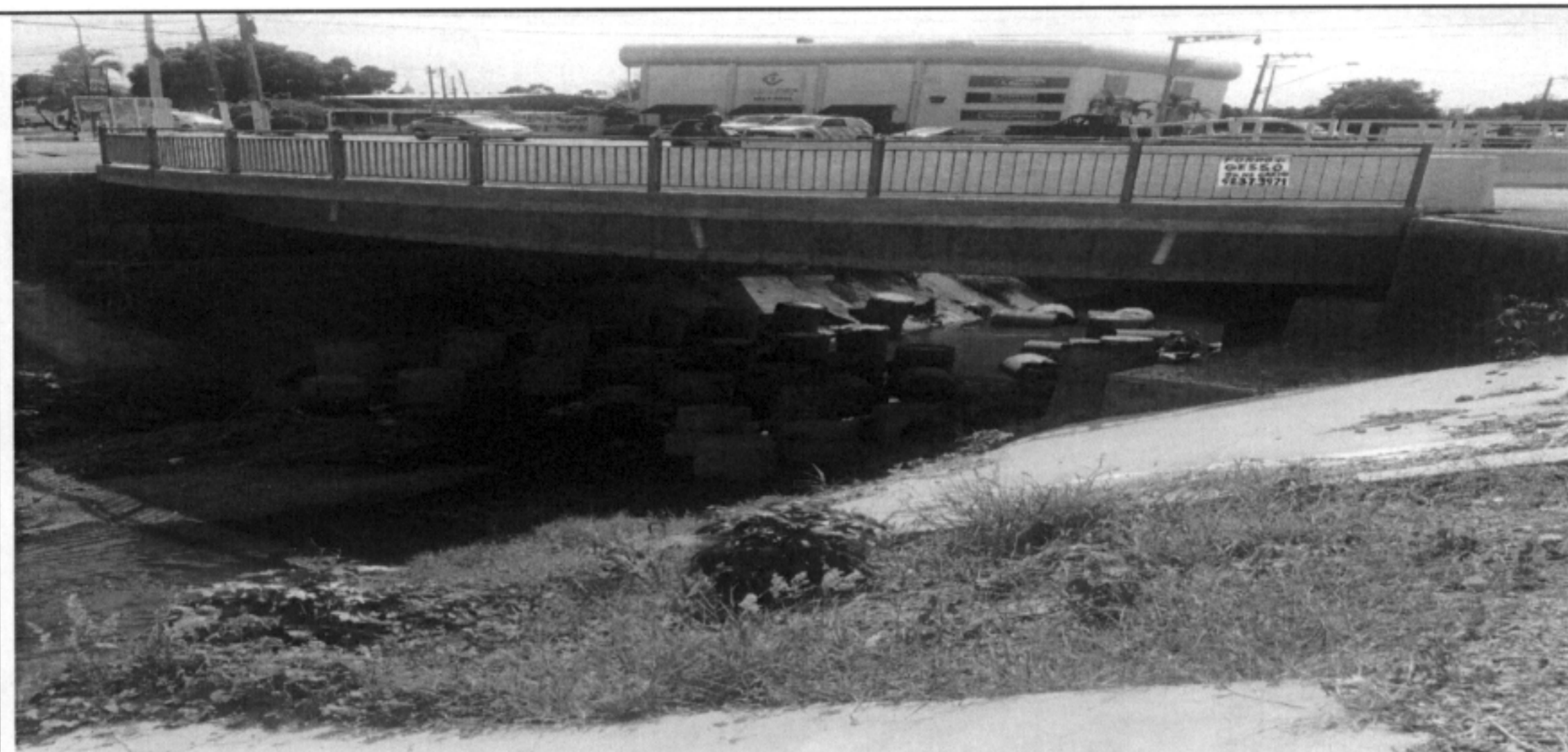
Figura 25: Remoção do resíduo de obra.
