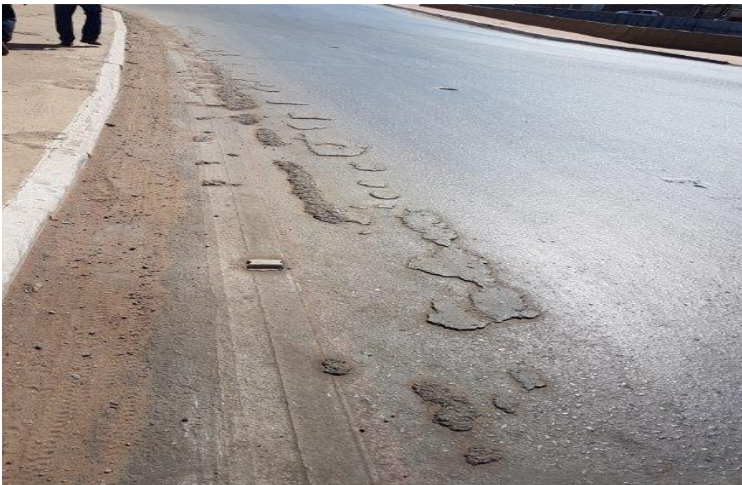
Concreto na pista superior direita (sentido Cba/Vg)
