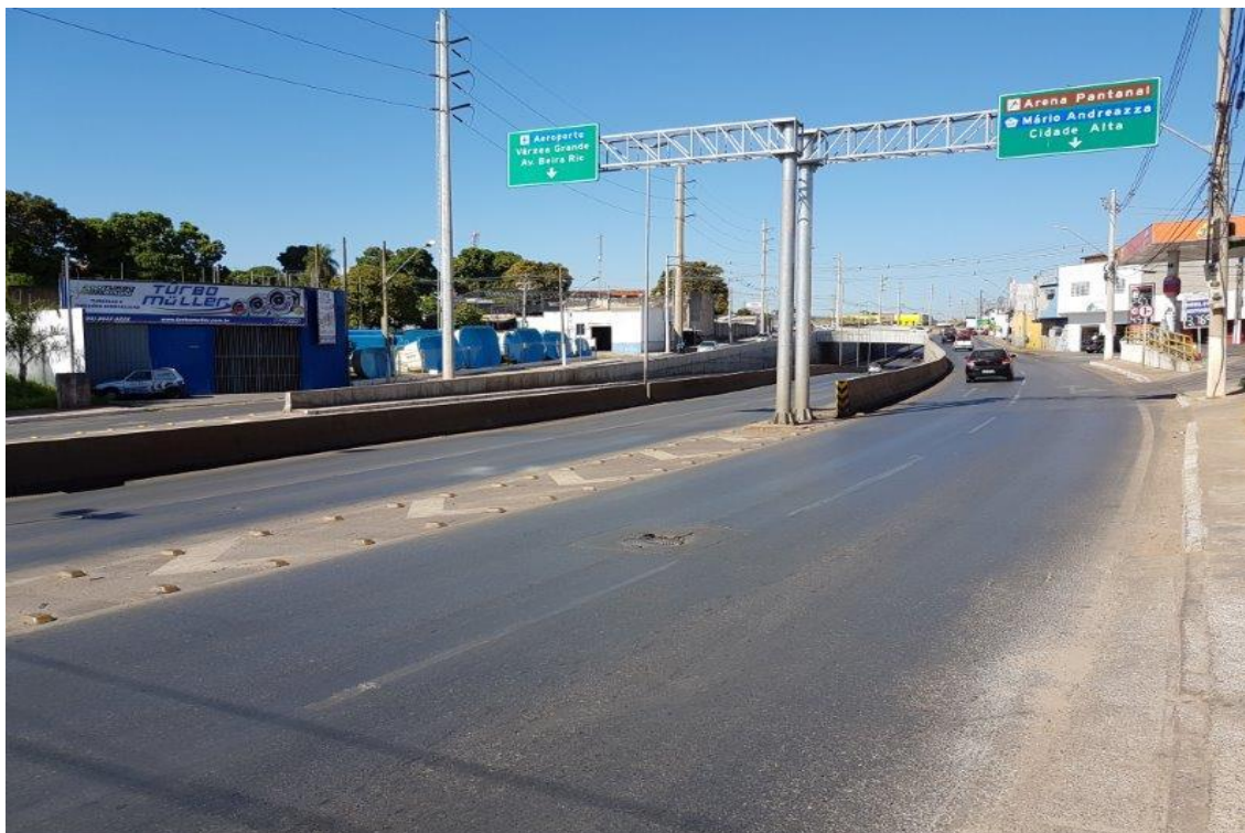
Sinalização vertical entrada da trincheira (sentido Cba/VG)
