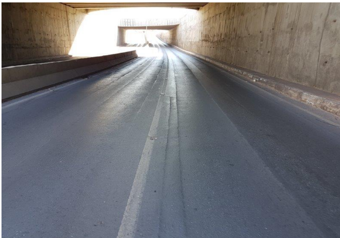
Fresagem com reposição da capa asfáltica na trilha da roda (pista esquerda sentido Cba/Vg) Ordem de Serviço nº 1.833/2018 – Sistema Conex-e TCE-MT
