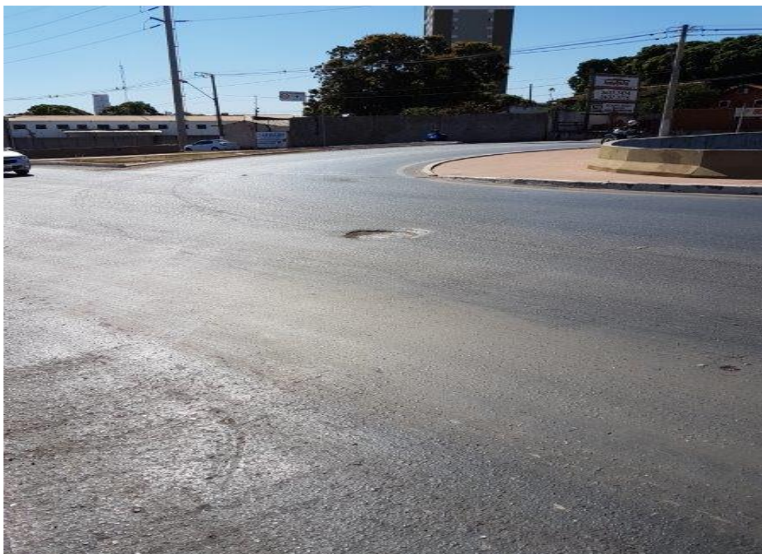
PV fora da norma
