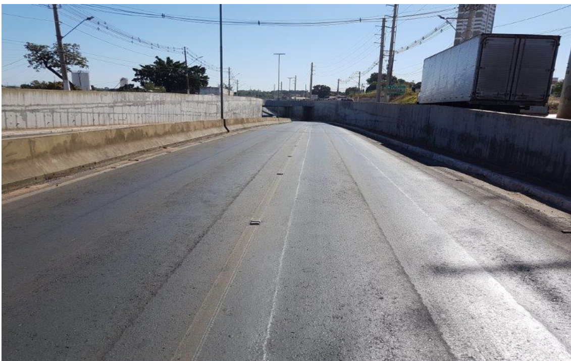
Fresagem com reposição da capa asfáltica na trilha da roda (pista esquerda sentido Cba/Vg)
