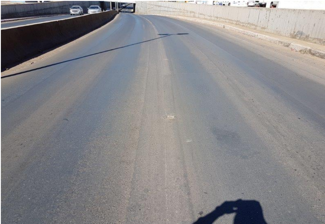
Fresagem com reposição da capa asfáltica na trilha da roda (pista direita sentido Cba/Vg)
