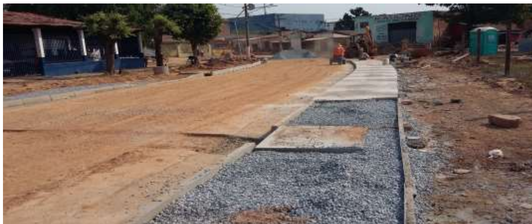
Foto 3.02 – Execução de Calçada na Av. Dom Orlando Chaves.
