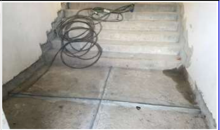
PREPARAÇÃO DO PISO KORODUR DA ESCADA ESCADA EIXO 14
