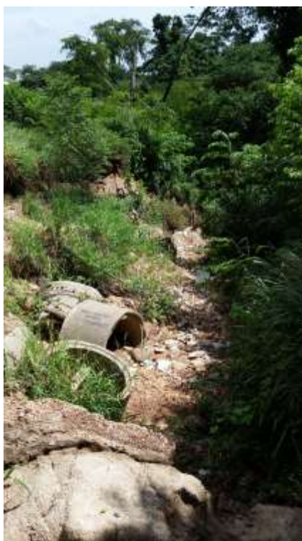
Figuras 7 e 8- Desbarrancamento da encosta da terraplanagem com deslocamento de manilhas para dentro da APP do Rio Coxipó e processo erosivo do solo.
