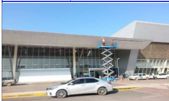
FOTO 05: Execução de pingadeira lado terra eixo 3-9.
