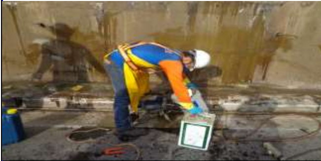
Fig. 5 - Colaborador da empresa El Condor com EPI para a injeção do PU
