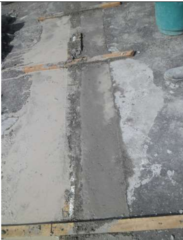
Foto 5.06 – Concretagem com graute.
