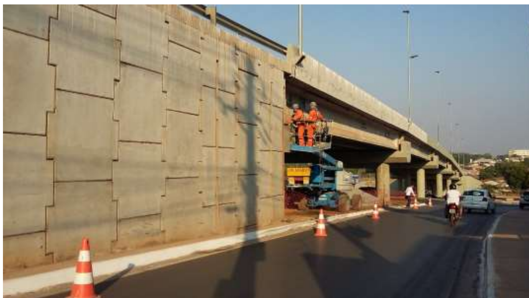
Foto 3.04 – Correção de patologias no Viaduto Dom Orlando Chaves.
