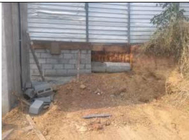
Fig. 05 – Boca de lobo 01.
