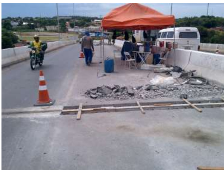
Foto 5.05 – Execução da forma e posicionamento de placa provisória de EPS para grauteamento.
