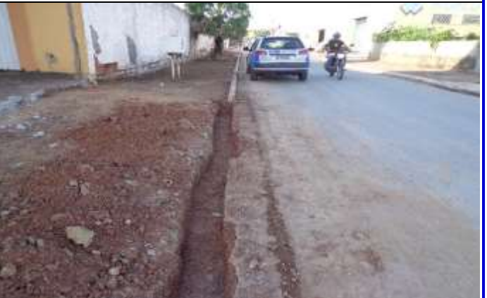
Fig. 4 - Retirada do meio-fio para realinhamento e troca dos que estão danificados na Joaquim Murтинho
