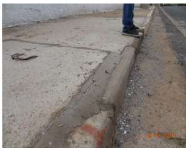
Fig. 14 - Acabamento da tampa da BL com papelão imerso no concreto; (ANTES)
