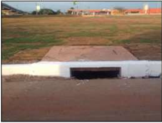
Figura 1: reposicionamento das bocas de lobo
