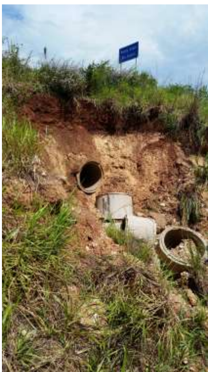
Figuras 7 e 8- Desbarrancamento da encosta da terraplanagem com deslocamento de manilhas para dentro da APP do Rio Coxipó e processo erosivo do solo.
