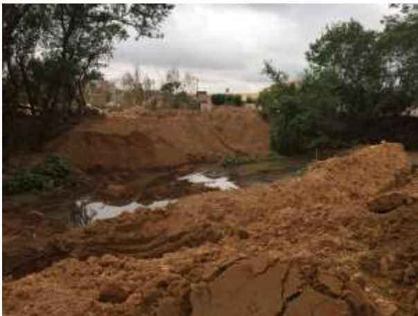
Fig. 3 Escavação do leito do córrego onde será implantada a alça da rotatória, material inservível.
