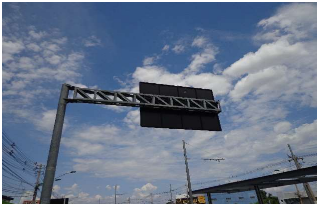
Foto 3.1 – Bandeira metálica e placa sinalizadora na Av. da FEB ( estaca 0 + 540 ).
