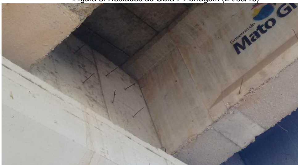
Figura 8: Resíduos de Obra . Ferragem (24/03/16)
