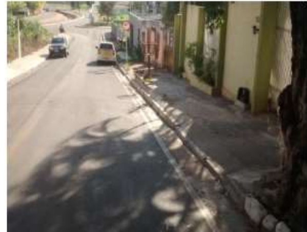
Fig. 31 - Meio fio e sarjeta danificados; (DEPOIS)
