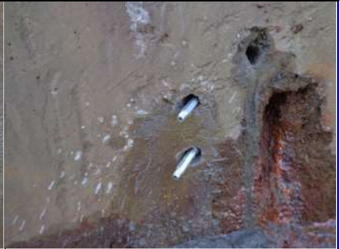
Fig. 4 - Bicos injetores já fixados, aguardando o PU para ser injetado
