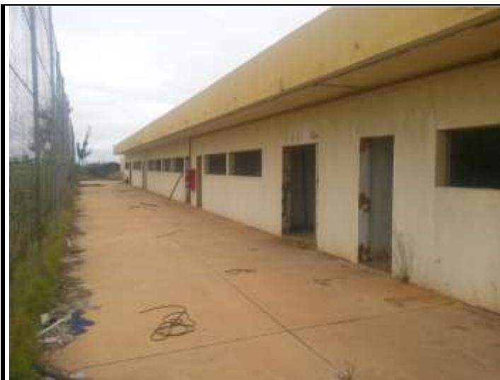
Prédio de apoio – Portas e janelas foram furtadas, instalações elétricas, louças e metais também foram furtadas;
