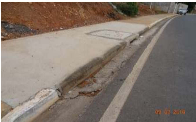
Fig. 11 - Restos de forma e armação da tampa da BL exposta;
