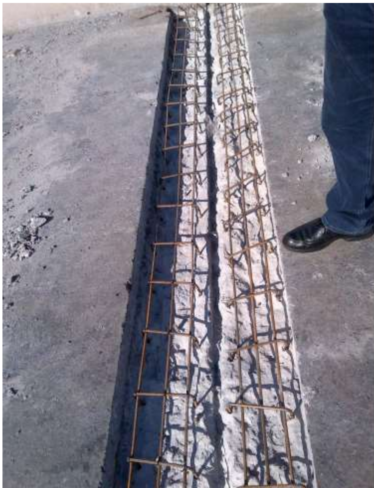
Foto 5.04 – Consolidação da armadura na peça de concreto com adesivo epóxi.
