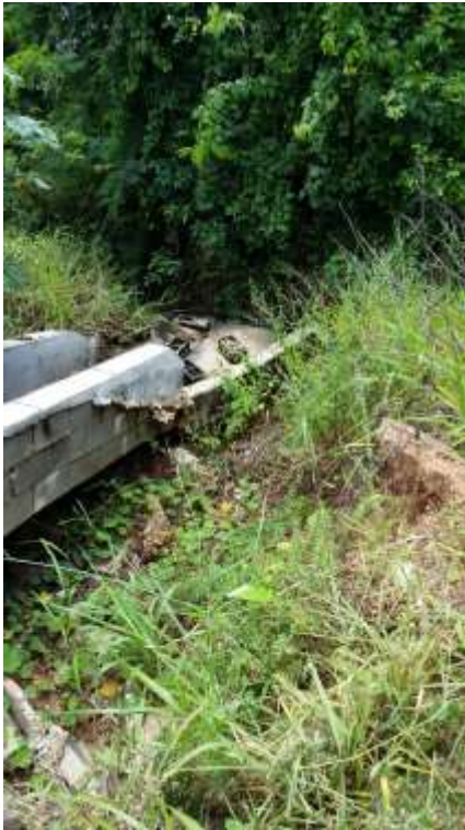
Figuras 11 e 12- Canal de captação de água da chuva do lado do córrego do Moinho sem base de solo, pois está sendo levado pela água da chuva de desce da encosta da via.
