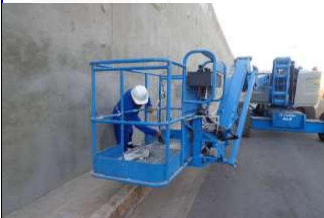
Fig. 13 - Bicos injetores já fixados e o PU foi injetado. A empresa deverá grautiar os furos e lixar a parede
