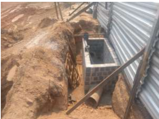
Fig. 03 – Boca de lobo 02.
