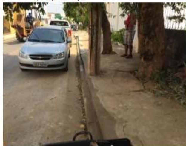
Fig. 4 - Meio fio executado; (DEPOIS)
