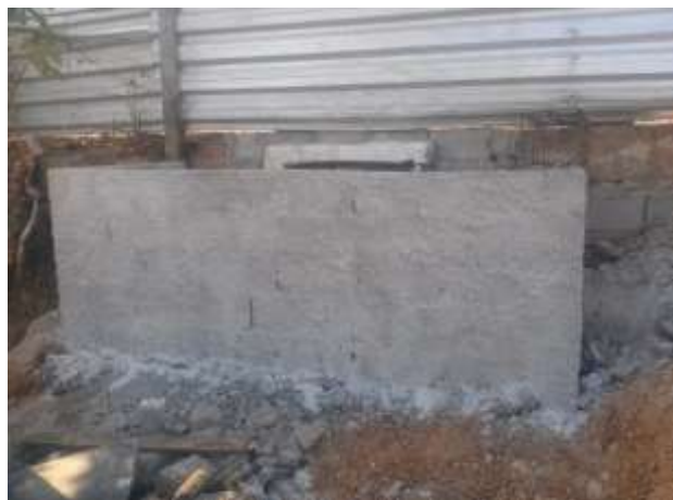
Fig. 04 – Boca de lobo 01.
