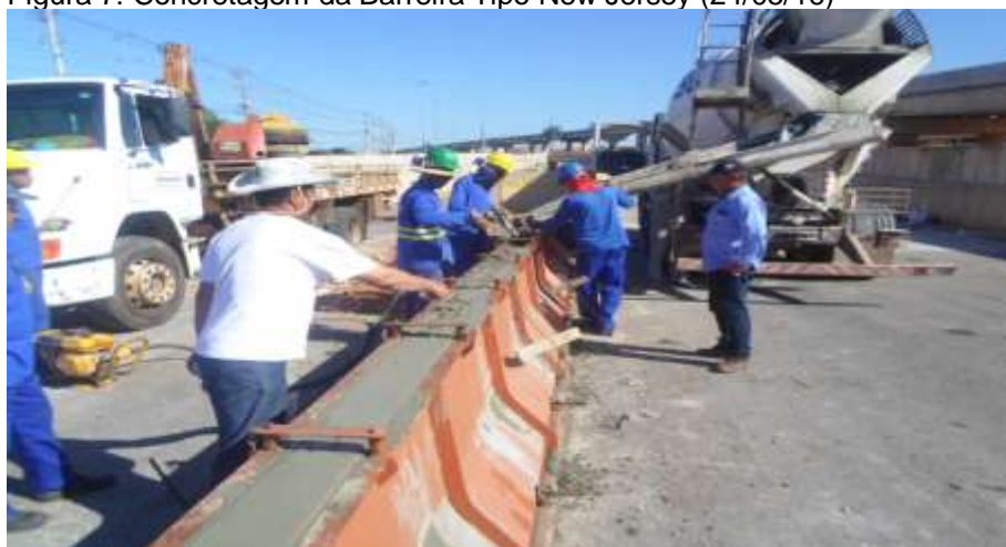
Figura 7: Concretagem da Barreira Tipo New Jersey (24/05/16)
