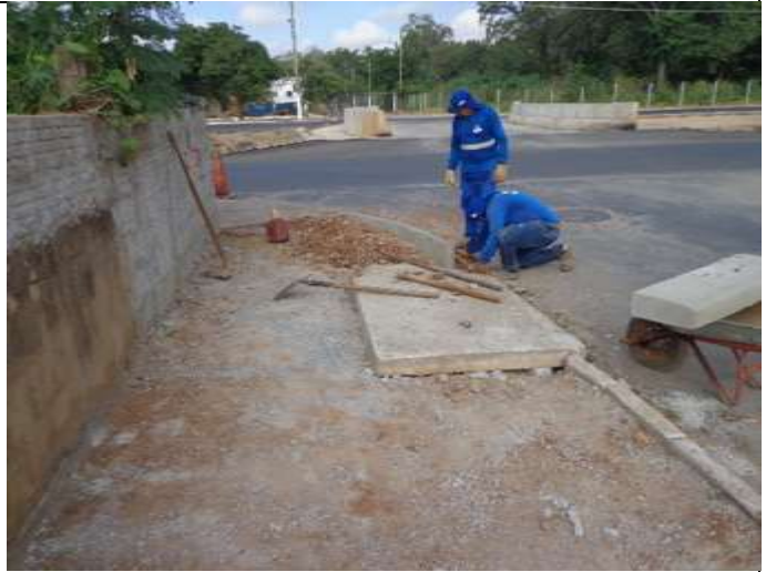
Fig. 10 - Retirada do meio-fio para realinhamento e troca dos que estão danificados na Joaquim Murтинho
