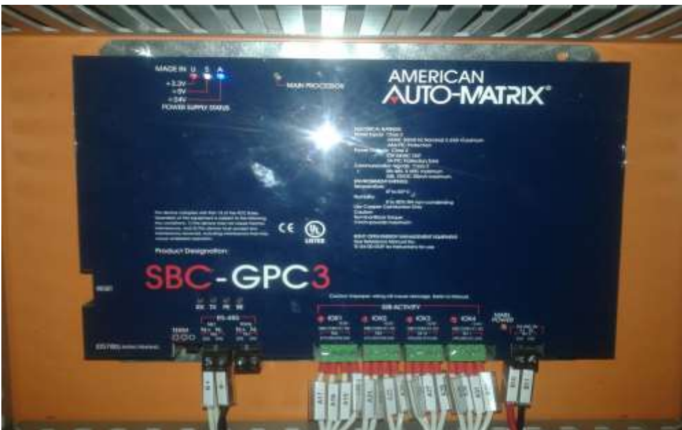
Figura 8.4.1 – Unidade Controladora Matrix Modelo SBC-GPC3
