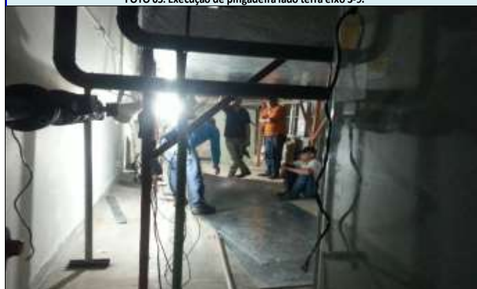
FOTO 07: Instalações de dutos de ar condicionado na sala de climatização 01.
