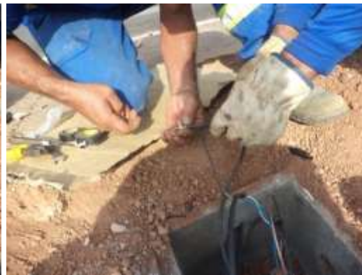
Figura 38- Colocação conector
