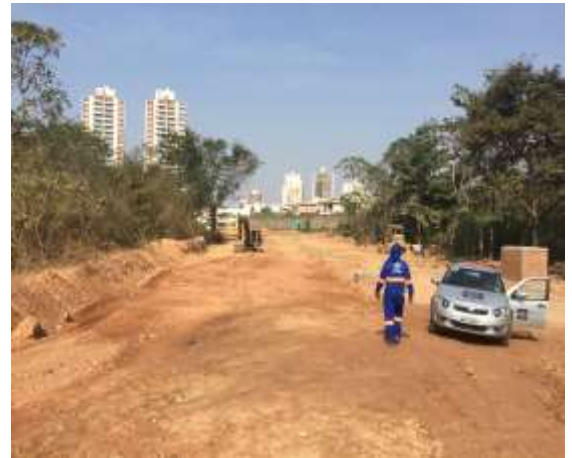
Fig. 2 Lado Direito - Início dos Serviços de terreaplenagem.
