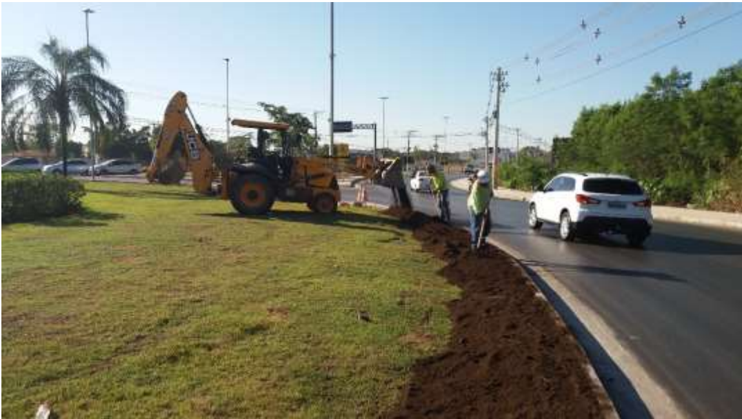
Foto 3.01 – Enleivamento na rotatória da Av. Barão de Melgaço.
