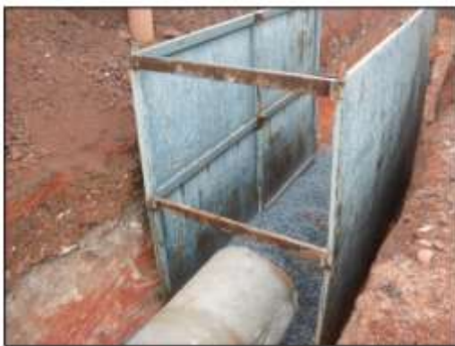
Figura 2: escalonamento da escavação e escoramento metálico
