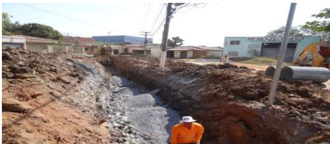
Foto 3.03 – Execução de drenagem na Av. Dom Orlando Chaves.
