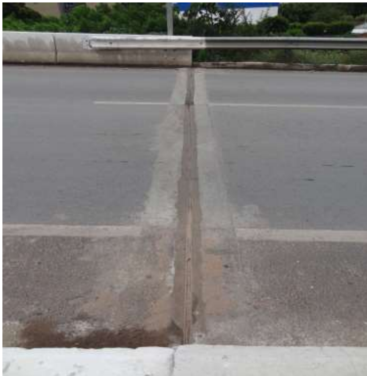
Foto 4.08 – Junta Jeene em boas condições de funcionamento (Foto atual).
