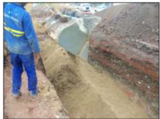
Figura 2: escalonamento da escavação e escoramento metálico
