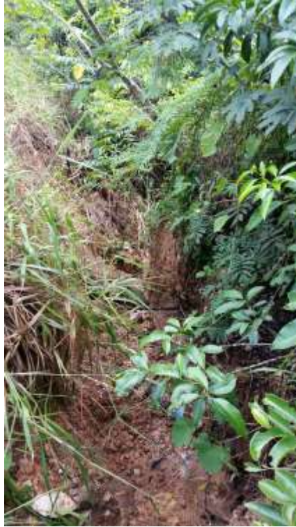
Figuras 9 e 10 – Desbarrancamento da encosta da pista pela ação de água da chuva ao lado do canal para captação de água pluvial
