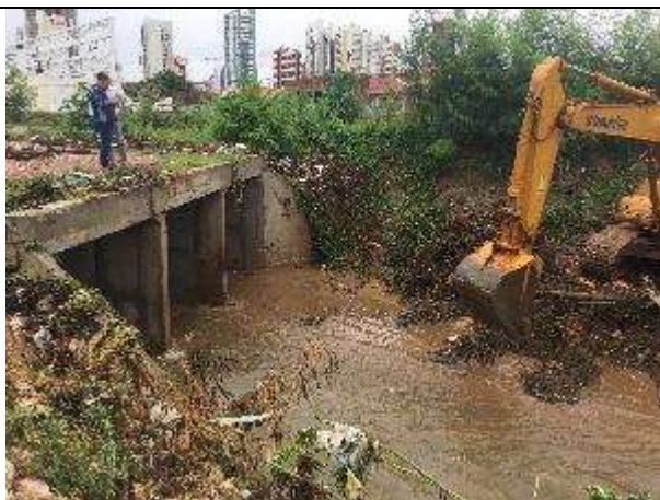
Fig. 03 – Limpeza do canal do córrego.
