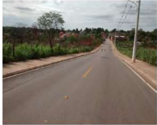
Fig. 24 - Trinca na capa asfáltica; (DEPOIS)
