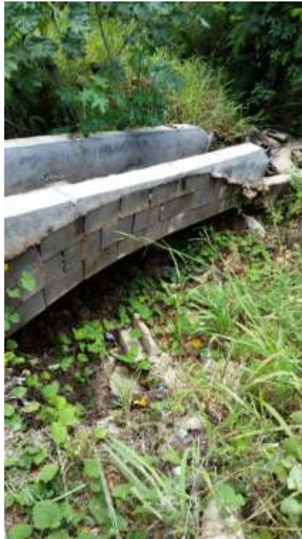
Figuras 11 e 12- Canal de captação de água da chuva do lado do córrego do Moinho sem base de solo, pois está sendo levado pela água da chuva de desce da encosta da via.
