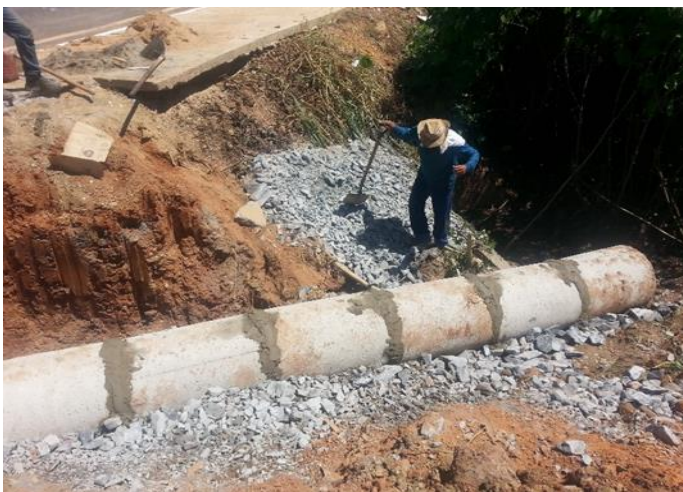
Fig. 5 - 23/03/2016 - Escavação da BLD estaca 20+10,00 Le;
