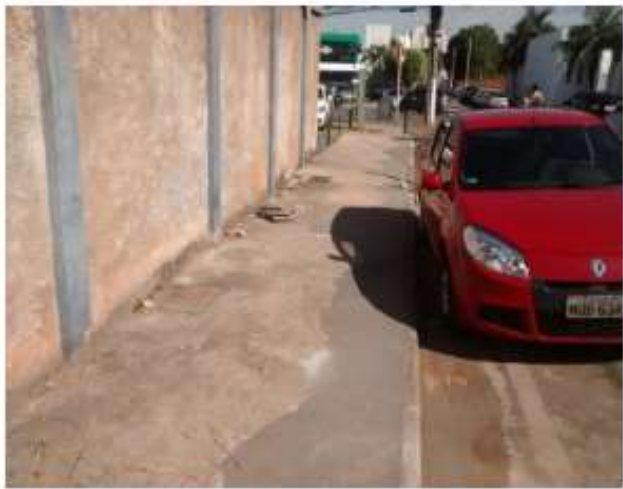
Fig. 5 - Meio fio executado; (DEPOIS)
