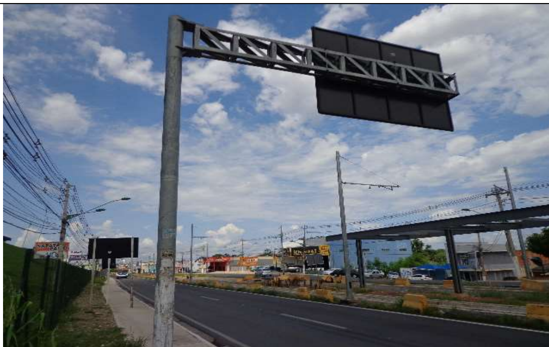
Foto 3.2 – Bandeira metálica e placa sinalizadora na Av. da FEB (estaca 0 + 540 ).
