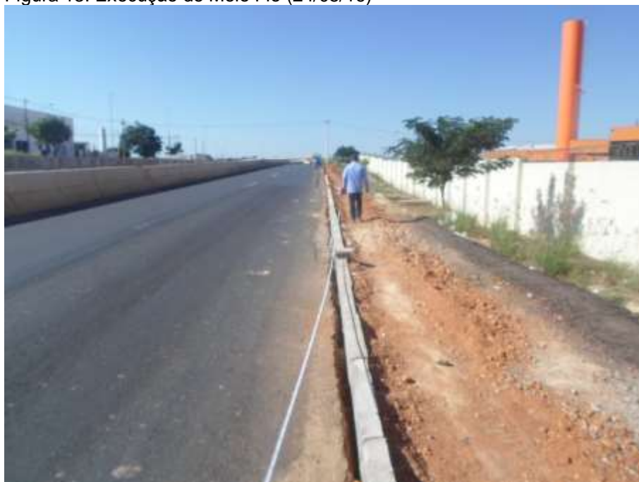
Figura 13: Execução de Meio Fio (24/05/16)
