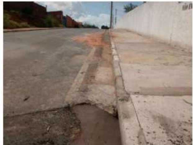
Fig. 16 - Sarjeta trincada; (DEPOIS)
