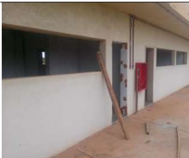
Prédio de apoio – Portas e janelas foram furtadas, instalações elétricas, louças e metais também foram furtadas;
