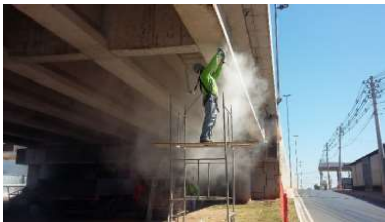
Foto 4.01 – Correção/Retificação da superfície das Vigas Longarinas.
