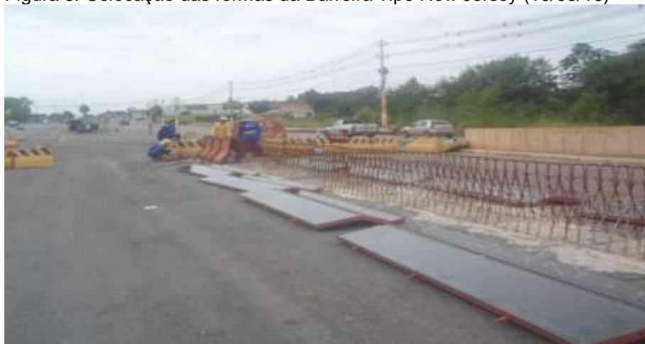
Figura 5: Colocação das formas da Barreira Tipo New Jersey (10/05/16)
