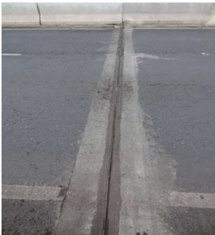
Foto 4.07 – Junta Jeene em boas condições de funcionamento (Foto atual).
