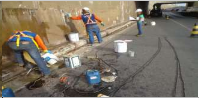
Fig. 4 - Colaborador da empresa El Condor com EPI para a injeção do PU
