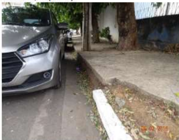
Fig. 4 - Meio fio não executado; (ANTES)
