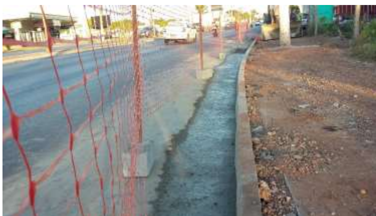
Foto 4.03 – Execução de Meio Fio/Sarjeta MFC-01.
