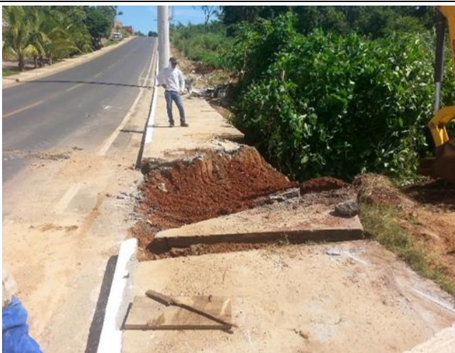
Fig. 3 - 22/03/2016 - Início da escavação para construção da BLD na estaca 29+10,00 Le;
