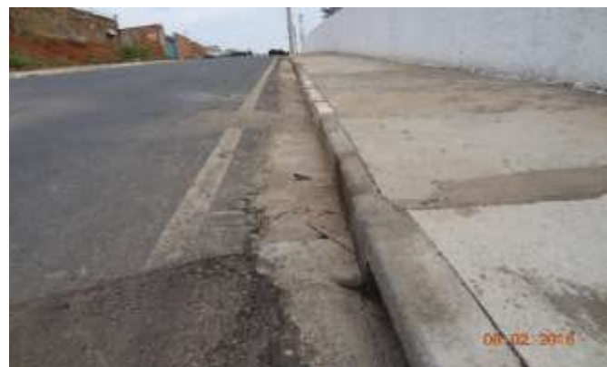
Fig. 16 - Sarjeta trincada;
