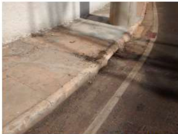
Fig. 11 - Restos de forma e armação da tampa da BL exposta; (DEPOIS)
