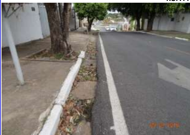
Fig. 29 - Sarjeta danificada;
