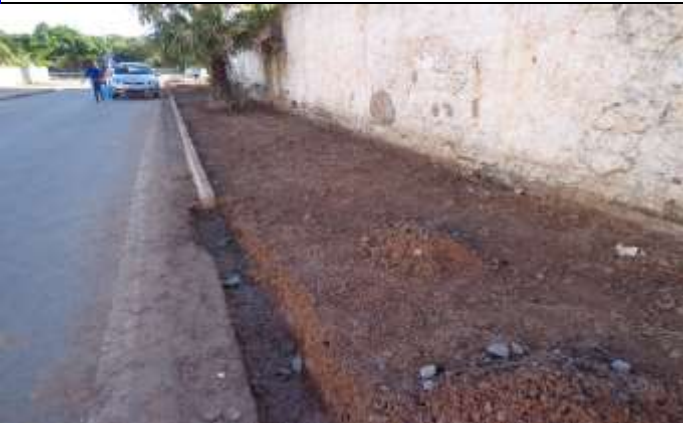
Fig. 3 - Retirada do meio-fio para realinhamento e troca dos que estão danificados na Joaquim Murтинho
