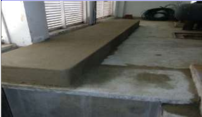
EDXECUÇÃO DE BASE DE CONCRETO EM CAG
