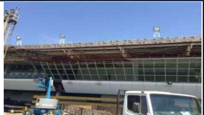
FOTO 02: Instalação de ACM da cobertura lado ar.
