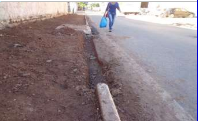
Fig. 2 - Retirada do meio-fio para realinhamento e troca dos que estão danificados na Joaquim Murтинho
