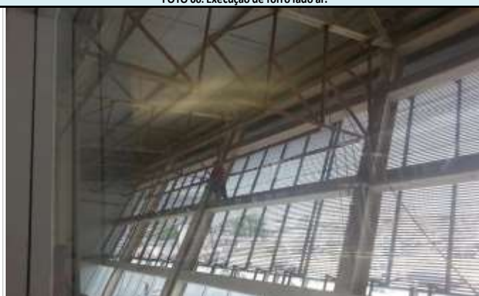
FOTO 08: Instalação de reforço no forro eixo 9-13.
