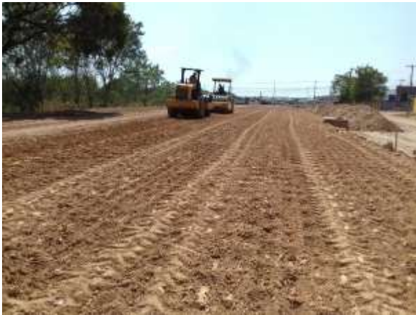
Fig. 1 Finalização dos Serviços Terreaplenagem do Lado Esquerdo
