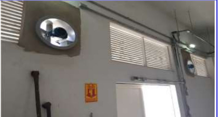
INSTALAÇÃO DE EXAUSTORES NA KF
