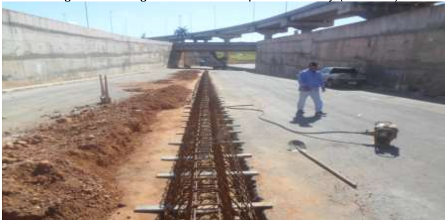
Figura 2: Ferragem da Barreira Tipo New Jersey (05/05/16)
