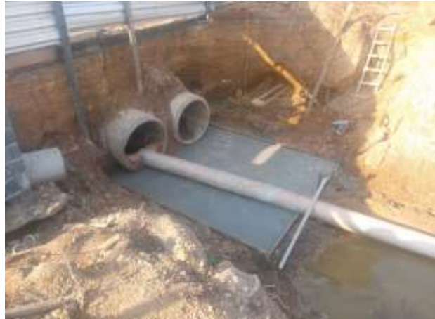
Fig. 02 – Lastro da caixa de inspeção.
