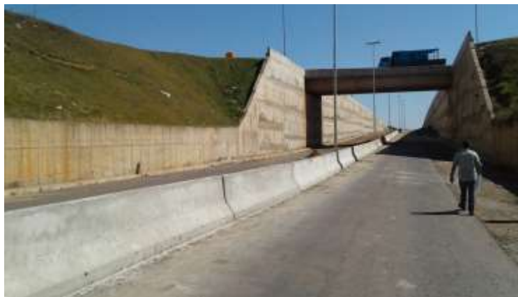
Figura 5: Barreira Dupla Tipo New Jersey no Ramo A.
