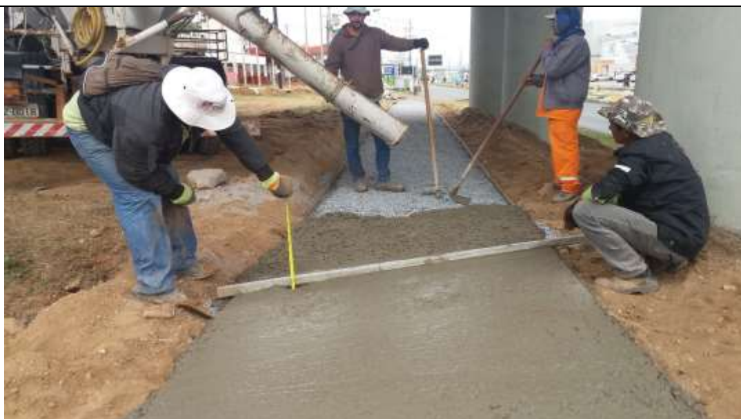
Foto 3.03 – Execução de Calçada na Av. da FEB.
