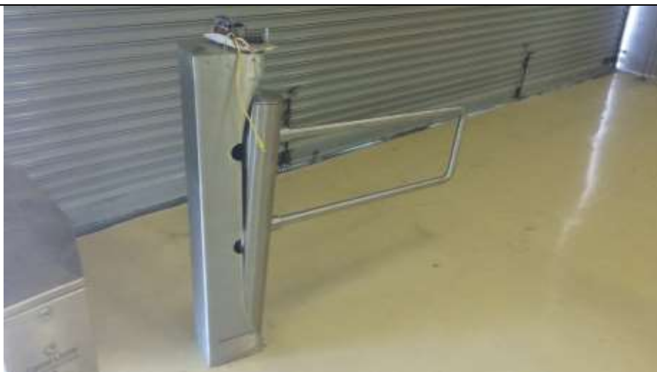
Registro 4. Catraca para portadores de necessidades especiais (PNE) com braço horizontal danificado e sem variogate, setor Sul.
