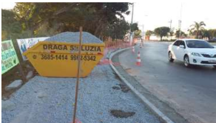
Foto 4.04 – Regularização para concretagem de calçada.
