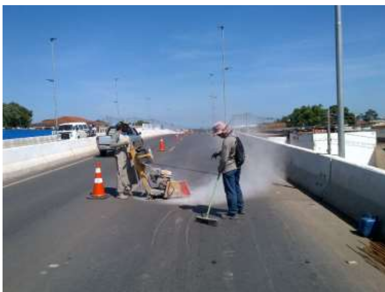
Foto 5.01 – Corte da capa asfáltica.
