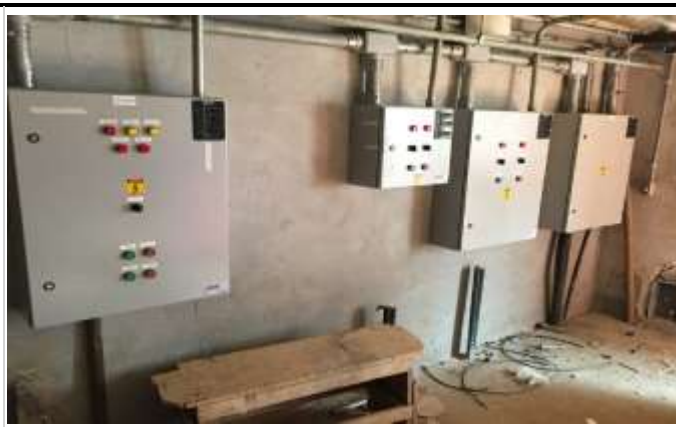
FOTO 04: Instalações Dos Paineis elétrico no reservatório 05.
