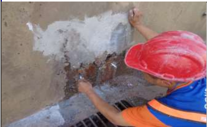
Fig. 13 - Colaborador da El Condor, fazendo o furo para fixação do bico injetor
