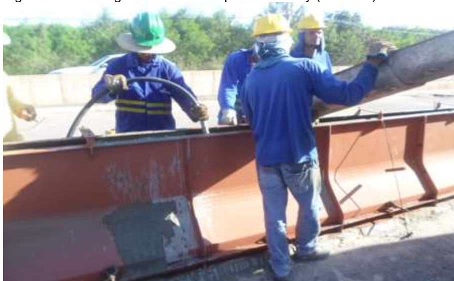
Figura 6: Concretagem da Barreira Tipo New Jersey (20/05/16)
