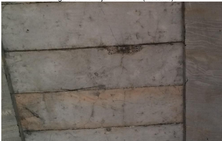
Figura 5: Pré-Laje Danificada (24/03/16)
