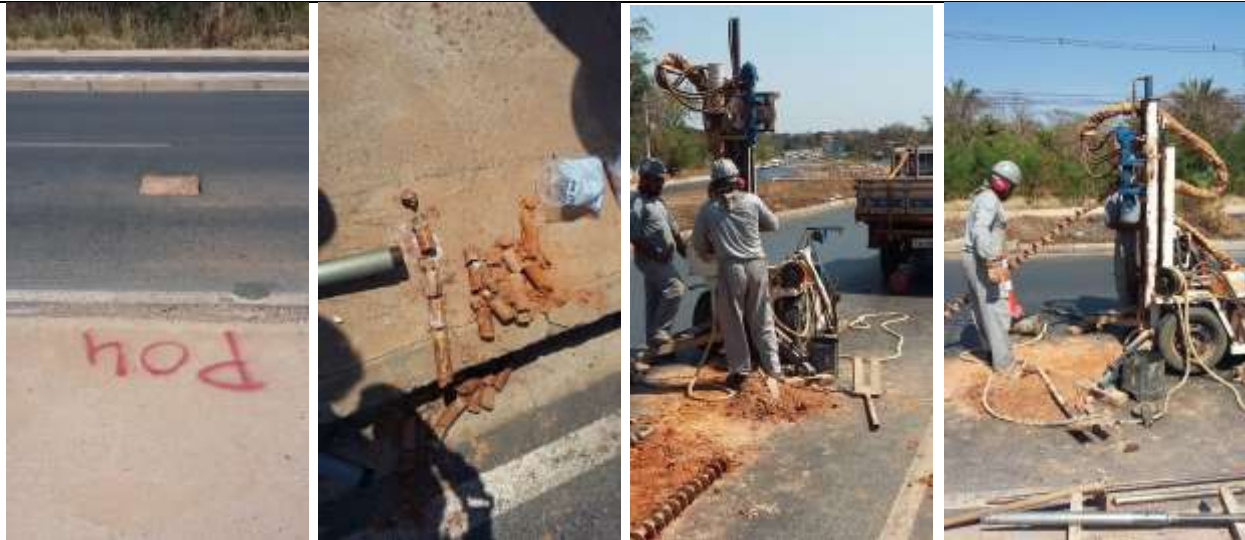
Quadro 01 – Execução do ensaio de SPT em campo.
