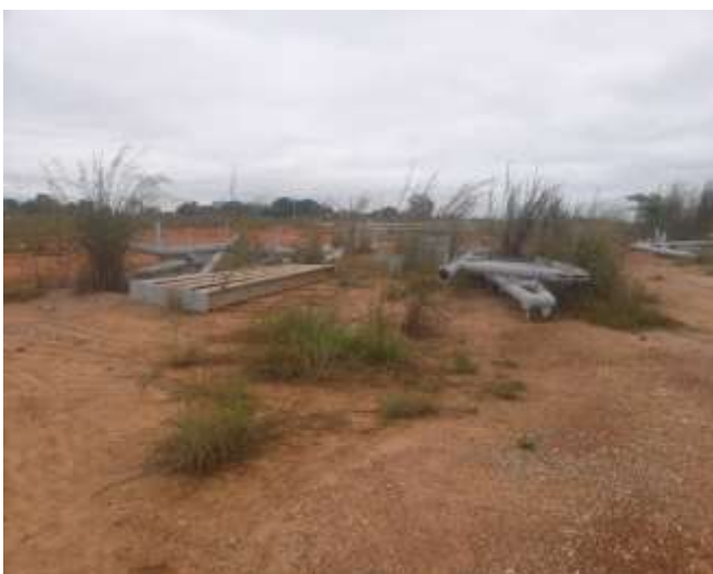
Estrutura metálica – estrutura da cobertura das arquibancadas esta armazenada nas imediações da obra, o que possibilita furtos;
