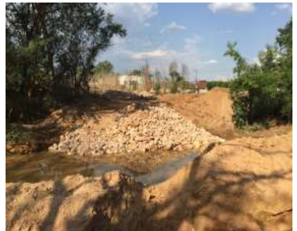
Fig. 4 Execução do enrocamento na fundação para posterior ex concreto.
