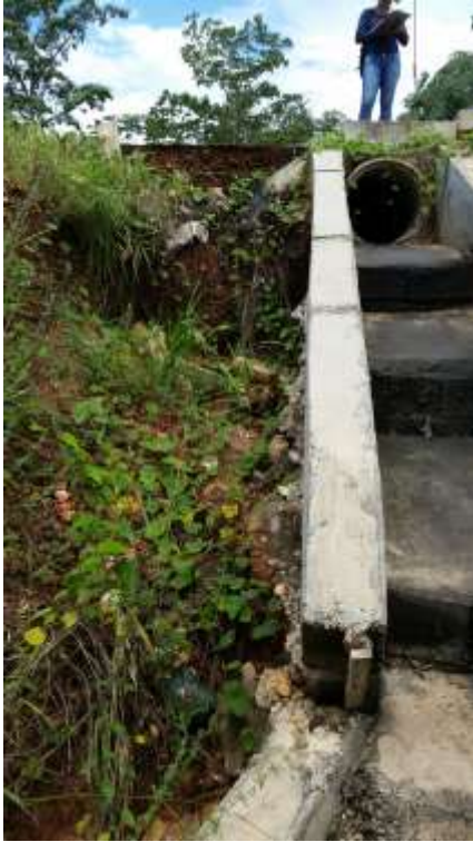
Figuras 9 e 10 – Desbarrancamento da encosta da pista pela ação de água da chuva ao lado do canal para captação de água pluvial
