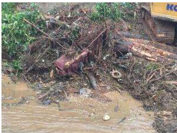
Fig. 04 – Obstrução do canal do córrego.
