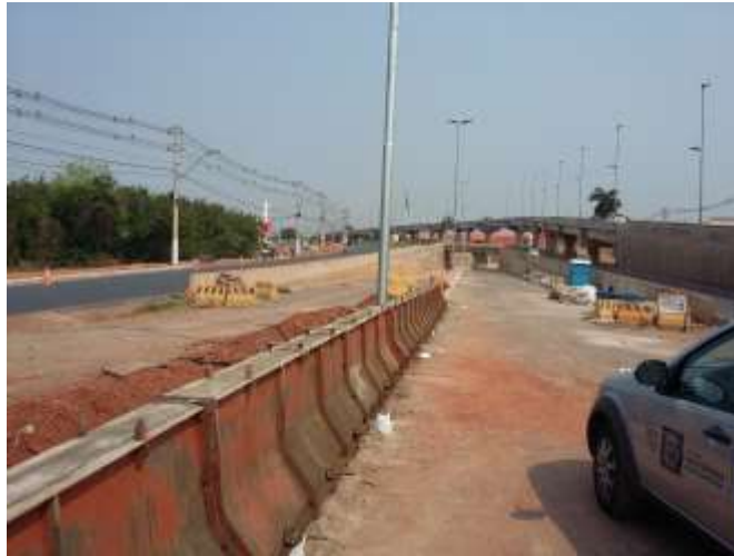
Figura 4: Figura 1 - Barreira Dupla Tipo New Jersey no Ramo A.
