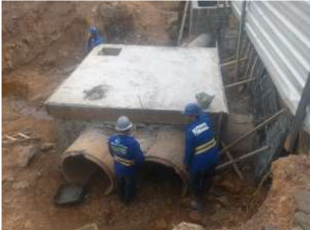
Fig. 01 – Caixa de inspeção.
