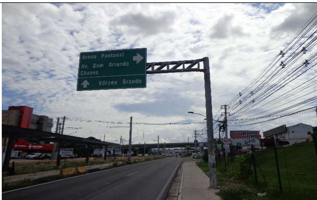
Foto 3.4 – Bandeira metálica e placa sinalizadora na Av. da FEB ( estaca 0 + 540 ).
