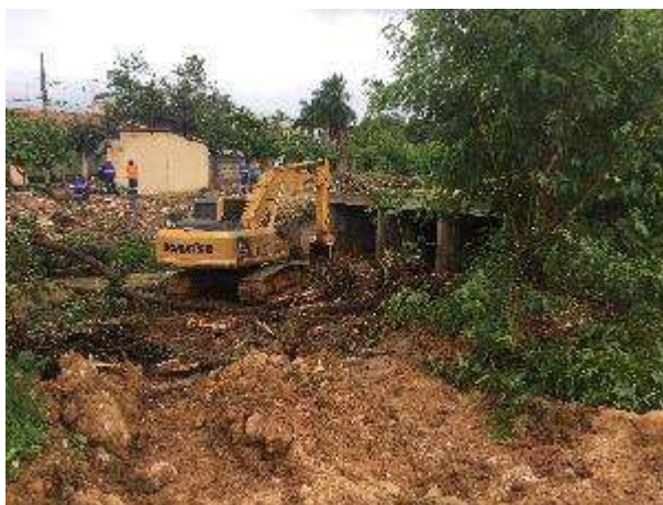
Fig. 05 – Limpeza do canal do córrego.
