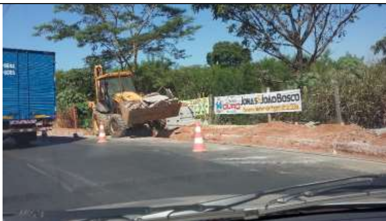
Foto 4.02 – Remoção de meios fios e sarjetas demolidos.
