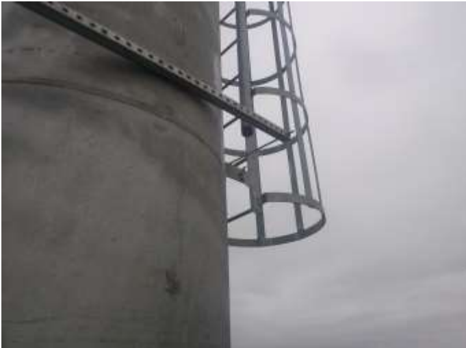
Instalações elétricas – Cabeamento para torres de iluminação furtado;
