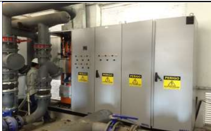
FOTO 03: Instalação do Painele elétrico na sala da CAG.
