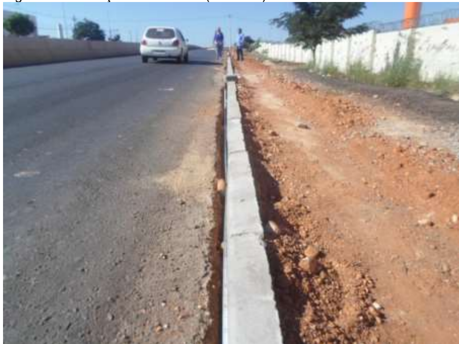
Figura 14: Execução de Meio Fio (24/05/16)
