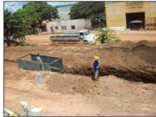
Figura 3: escavação e escoramento metálico
