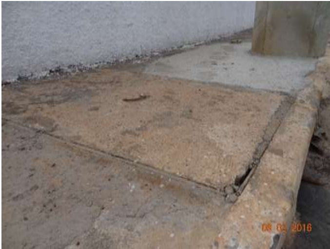
Fig. 11 - Restos de forma e armação da tampa da BL exposta;
