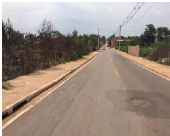
Fig. 23 - Boca de lobo; (DEPOIS)
