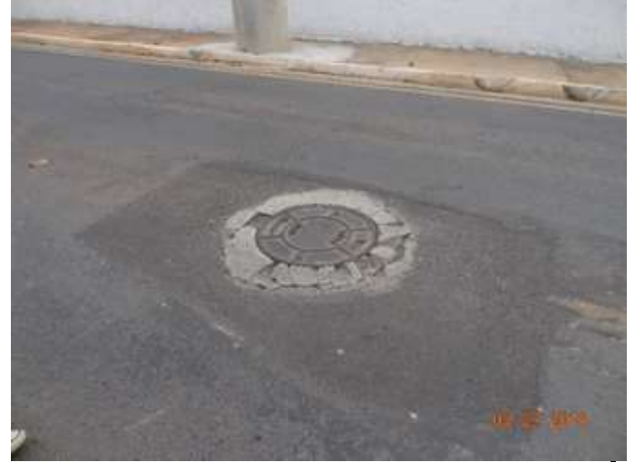
Fig. 12 - Acabamento do Poço de Visita com deterioração precoce;
