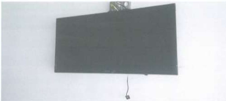
Dispositivo IR (Infravermelho) danificado – Televisor do Sistema Digital Signage – Nível 30, Setor Oeste, Circulação de público.
