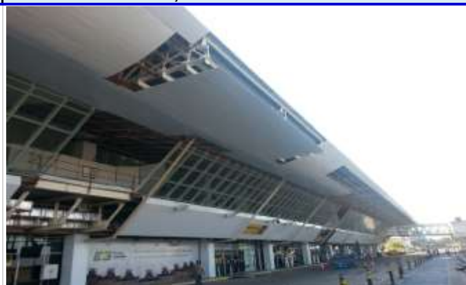
FOTO 06: Execução de forro lado ar.
