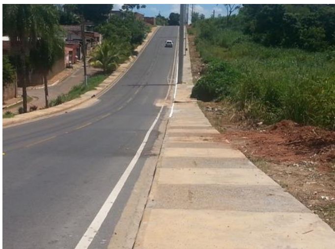
Fig. 1 -21/03/2016 - Os serviços realizados até esta data foram correção das calçadas e meio fios;
