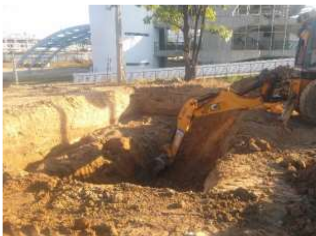
Fig. 07 – Escavação da cisterna.
