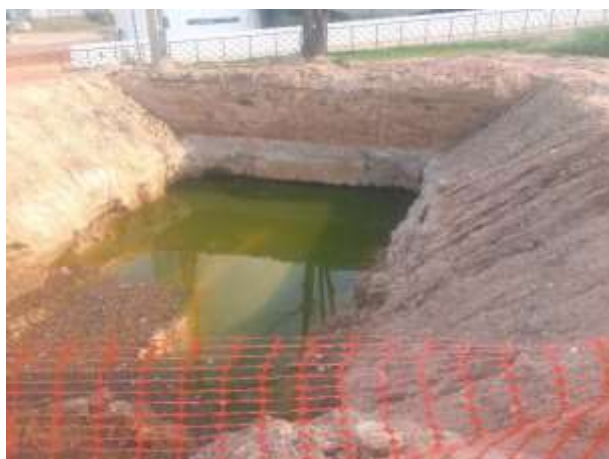
Fig. 08 – Escavação da cisterna.
