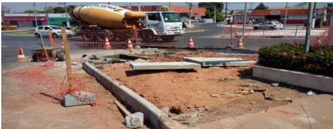
Foto 3.01 – Execução de Calçada, Meio Fio e Boca de Lobo na rotatória da Cidade Alta.
