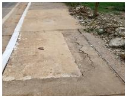
Afundamento da pista
