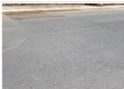
Afundamento da pista
