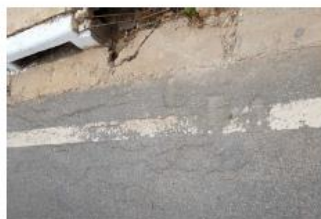
Afundamento da pista
