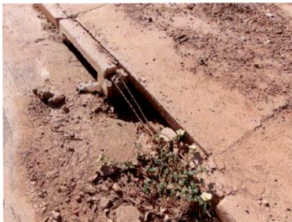
Fotografia 21 – Meio-fio quebrado
