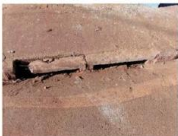
Fotografia 119 – Meio-fio quebrado
