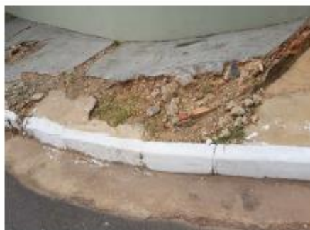
Afundamento da pista com acúmulo de sedimentos
