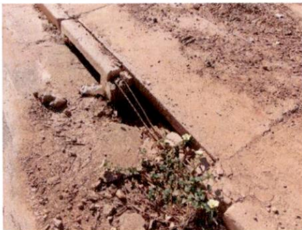
Fotografia 21 – Meio-fio quebrado
