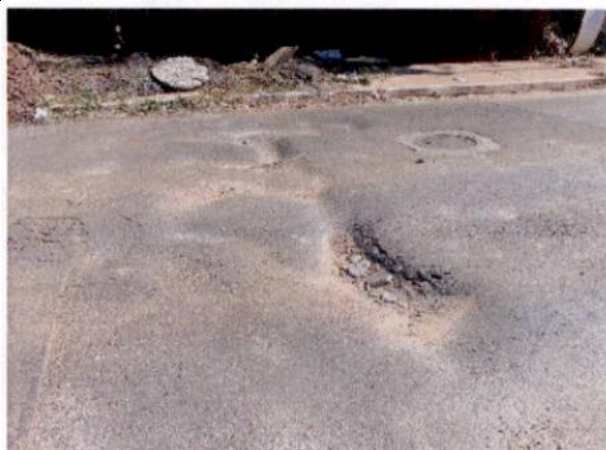
Fotografia 30 – Afundamento
