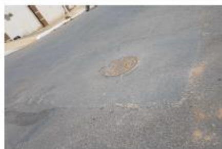
Afundamento da pista
