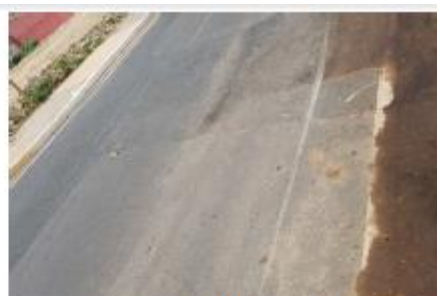
Afundamento da pista com acúmulo de sedimentos
