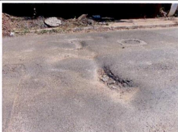
Fotografia 30 – Afundamento
