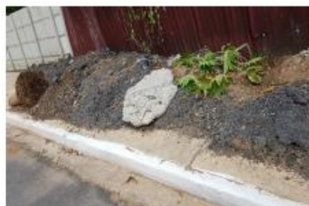
Restos de reparos de pavimentação obstruindo a passagem de pedestres na calçada
