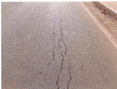
Fotografia 34 – Trinca longitudinal
