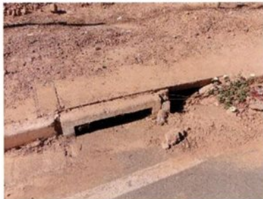
Fotografia 22 – Meio-fio quebrado
