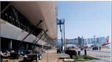
FOTO 08: FRENTE 4 - Acabamento do forro metálico liso e ACM branco sob a cobertura do lado AR.
