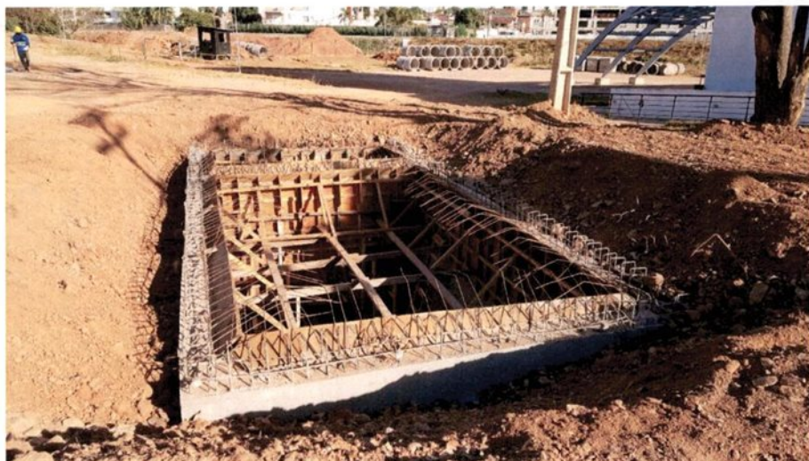
Fig. 09 – Laje do reservatório enterrado (cisterna).
