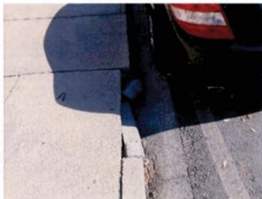
Fotografia 04 – Meio-fio quebrado
