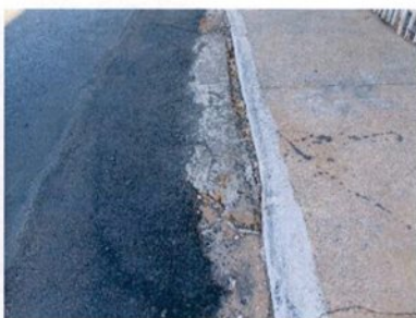
Fotografia 92 – Afundamento
