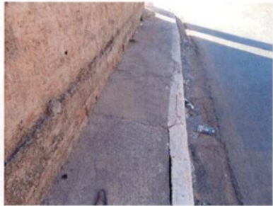
Fotografia 126 – Sarjeta quebrada
