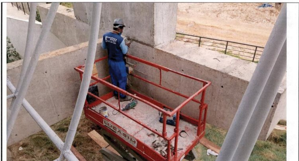
Fig. 07 – Lixamento da estrutura em concreto aparente.
