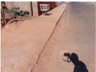
Fotografia 20 – Meio-fio danificado
