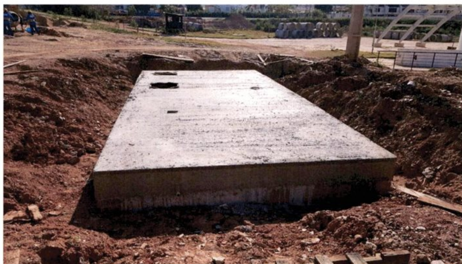
Fig. 10 – Laje do reservatório enterrado (cisterna).
