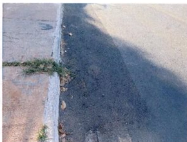
Fotografia 88 – Afundamento
