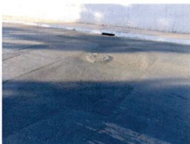
Fotografia 68 – Afundamento
