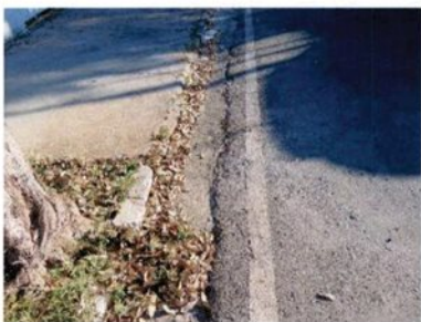
Fotografia 43 – Meio-fio quebrado
