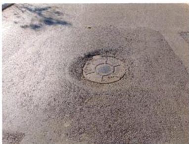
Fotografia 105 – Afundamento
