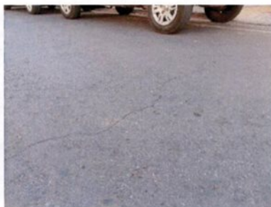
Fotografia 06 – Trinca transversal
