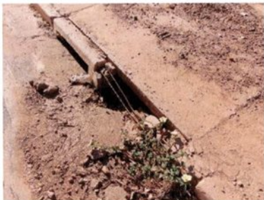
Fotografia 21 – Meio-fio quebrado
