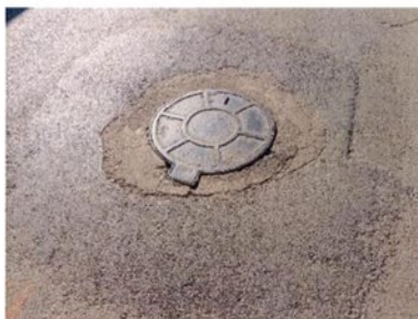
Fotografia 110 – Afundamento
