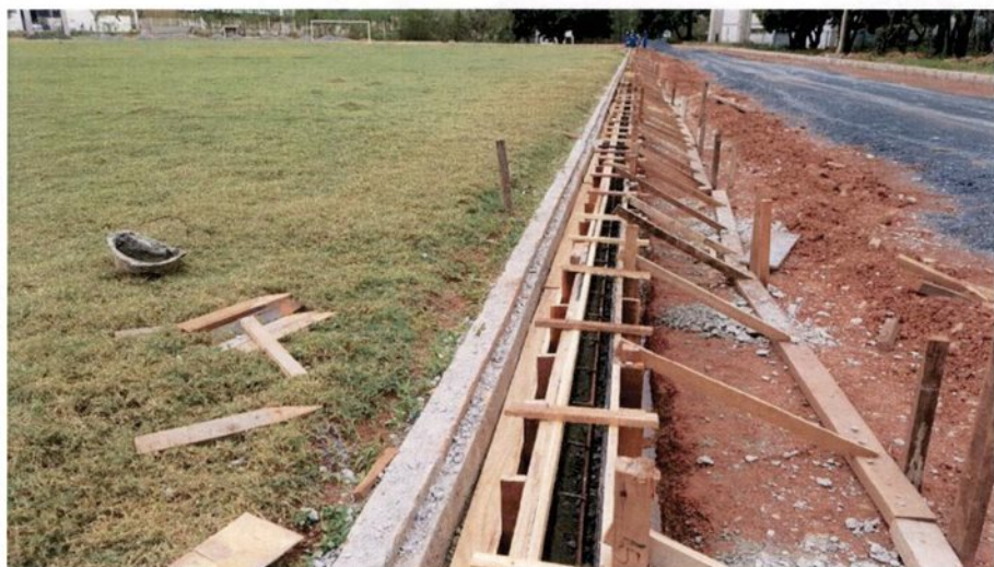
Fig. 04 – Execução das canaletas de concreto.
