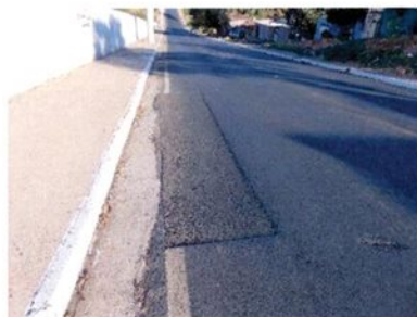
Fotografia 61 – Afundamento
