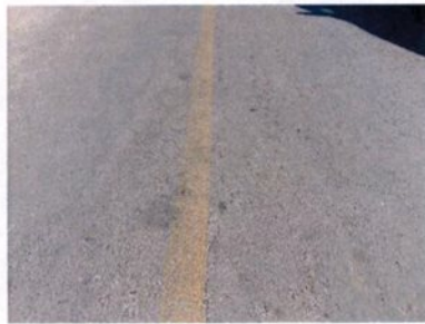
Fotografia 08 – Trinca longitudinal
