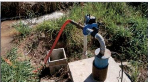
FOTO 04: Frente 2-Sistema de Abastecimento de Água (Bomba em teste)
