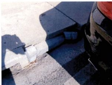
Fotografia 03 – Meio-fio quebrado
