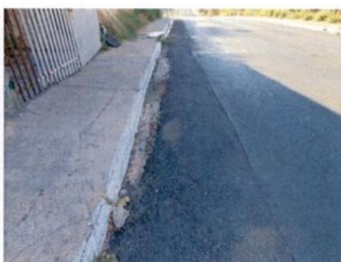
Fotografia 90 – Afundamento
