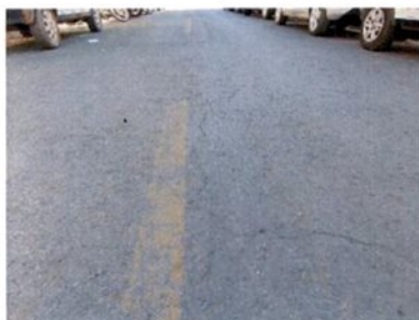
Fotografia 05 – Trinca longitudinal
