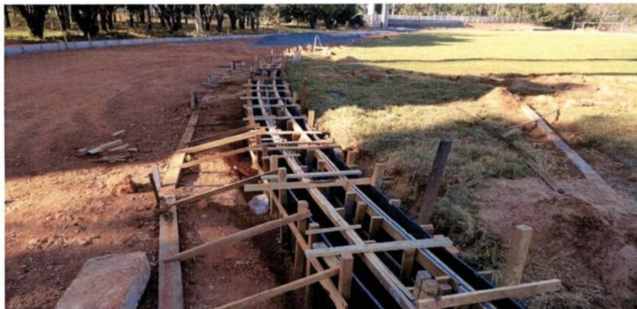
Fig. 01 – Forma para execução das canaletas de concreto (não previsto em planilha orçamentária).
