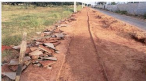
FOTO 05: FRENTE 3 - Aterro de vala para passagem dos dutos na via de acesso da ETE
