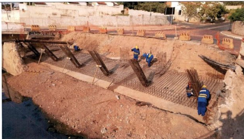
Fig. 03 – Execução da armadura da fundação da laje da rotatória da Av. Senador Metelo;
