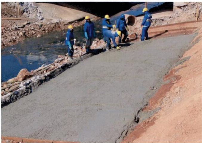
Fig. 02 – Execução do lastro de concreto para execução da fundação da laje da Av. Senador Metelo;
