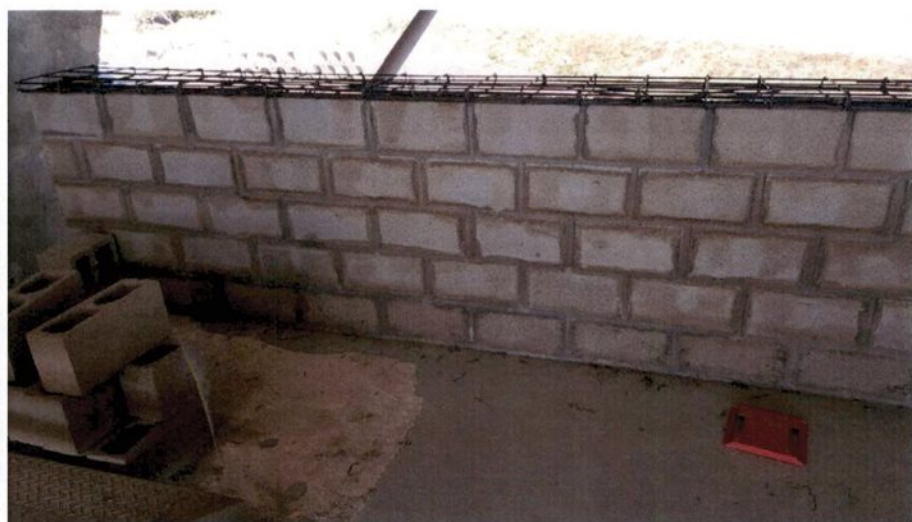
Fig. 08 – Guarda-corpo do 2º pavimento – utilização de blocos de concreto como forma.
