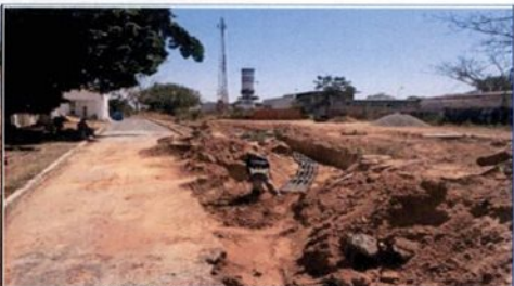
FOTO 06: FRENTE 3 - Instalação de dutos PEAD para rede telemática
