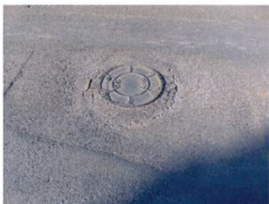
Fotografia 53 – Afundamento
