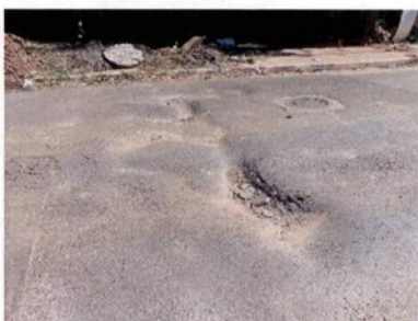
Fotografia 30 – Afundamento
