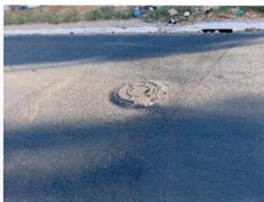
Fotografia 64 – Afundamento
