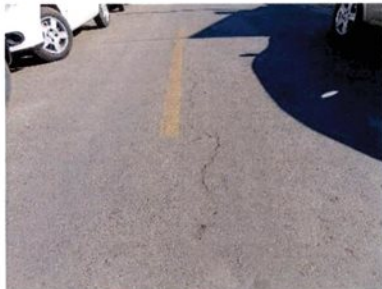
Fotografia 10 – Trinca longitudinal
