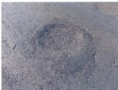
Fotografia 72 – Afundamento
