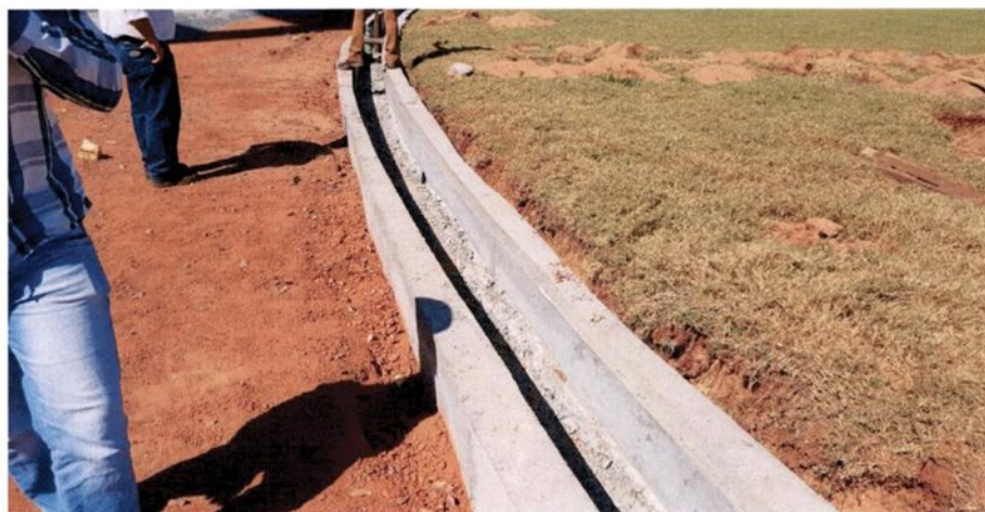
Fig. 02 – Execução das canaletas de concreto.
