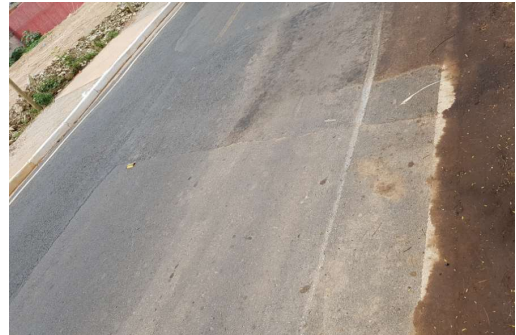
Afundamento da pista com acúmulo de sedimentos
