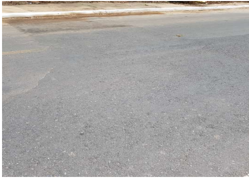
Afundamento da pista
