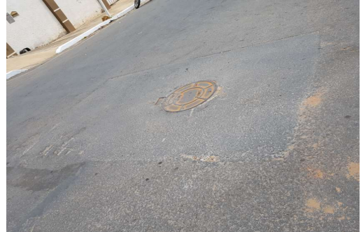
Afundamento da pista
