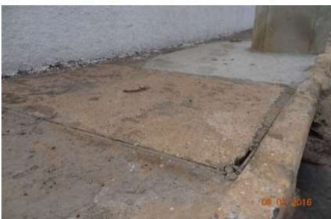
Fig. 11 - Restos de forma e armação da tampa da BL exposta;
