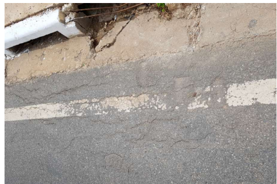
Afundamento da pista
