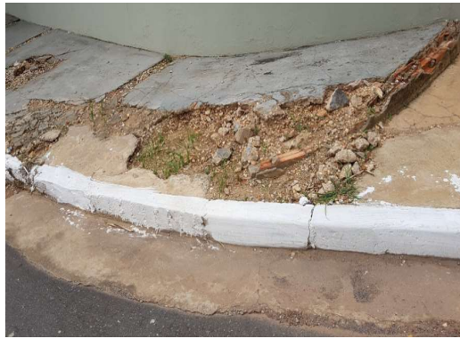
Afundamento da pista com acúmulo de sedimentos
