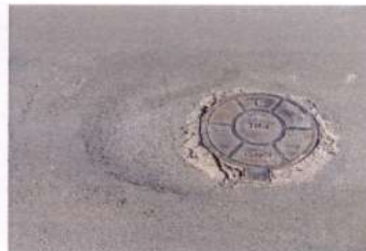
Fotografia 102 – Afundamento
