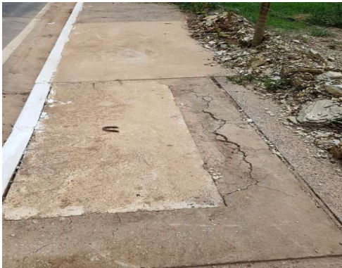
Afundamento da pista
