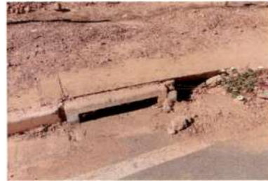
Fotografia 22 – Meio-fio quebrado
