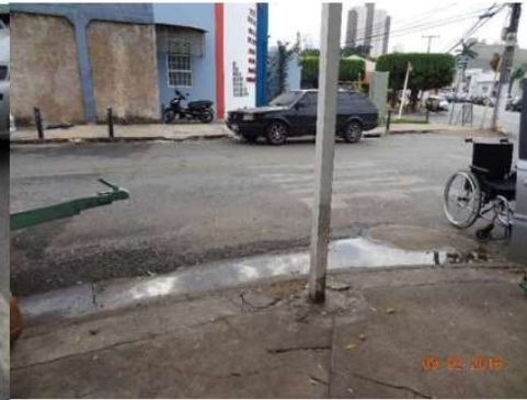
Fig. 6 - Boca de lobo e Poço de Visita não executados;
