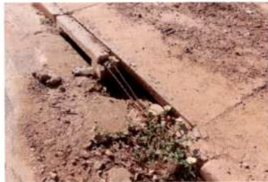
Fotografia 21 – Meio-fio quebrado
