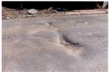
Fotografia 30 – Afundamento
