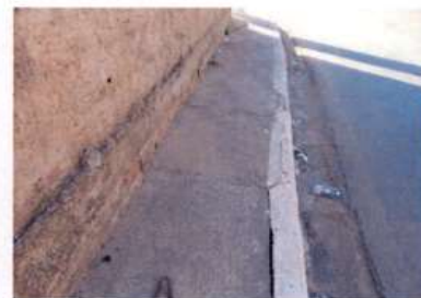
Fotografia 126 – Sarjeta quebrada
