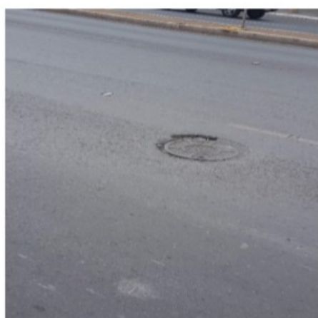
Poço de visita mal feito com afundamento 15° 37' 31" S e 56° 6' 56" W
