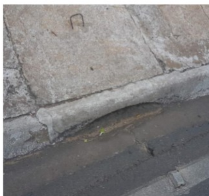
Boca de lobo obstruída 15° 36' 41" S e 56° 7' 42" W
