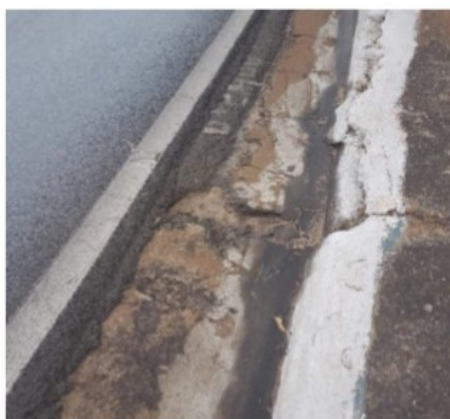
Sarjeta e meio-fio mal feitos 15° 36' 36" S e 56° 7' 44" W
