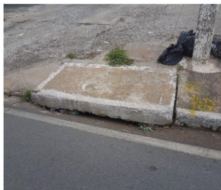
Boca de lobo obstruída e fora do padrão 15° 36' 38" S e 56° 7' 43" W
