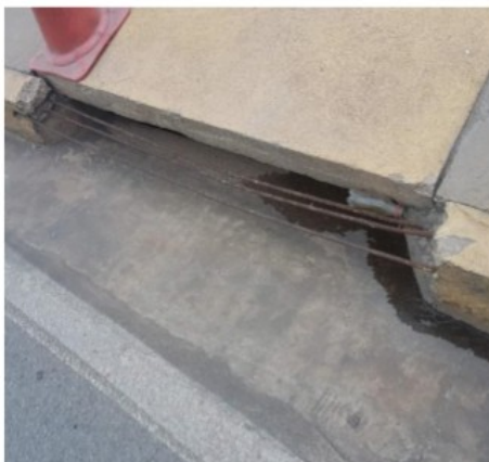
Meio-fio quebrado 15° 36' 48" S e 56° 7' 37" W
