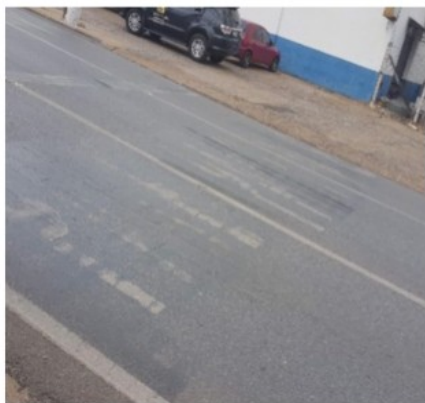
Sinalização horizontal desgastada 15° 36' 49" S e 56° 7' 35" W
