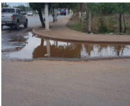
Ausência de drenagem 15° 37' 8" S e 56° 7' 18" W
