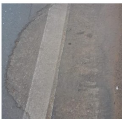
Sarjeta mal feita 15° 37' 11" S e 56° 7' 9" W
