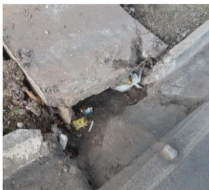
Boca de lobo mal feita 15° 37' 38" S e 56° 6' 49" W
