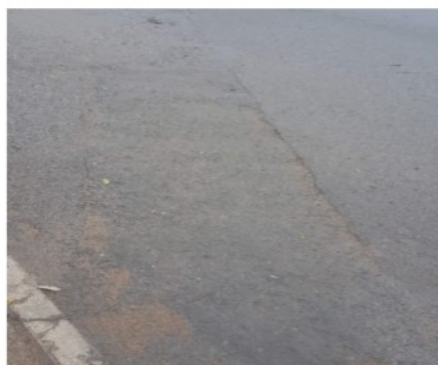
Remendo mal feito 15° 37' 10" S e 56° 7' 14" W
