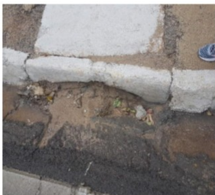
Boca de lobo obstruída 15° 36' 40" S e 56° 7' 43" W
