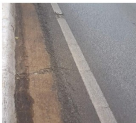
Trinca transversal 15° 36' 37" S e 56° 7' 44" W
