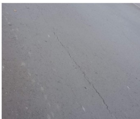
Trinca na pista 15° 37' 26" S e 56° 7' 2" W
