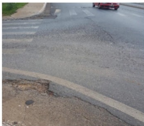
Remendo mal feito e buraco 15° 37' 30" S e 56° 6' 57" W
