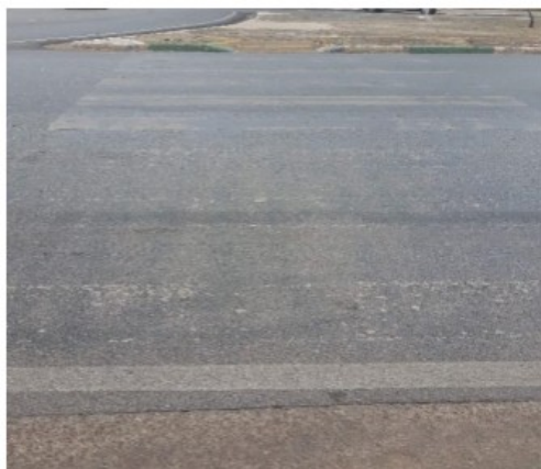
Sinalização horizontal desgastada 15° 36' 35" S e 56° 7' 44" W
