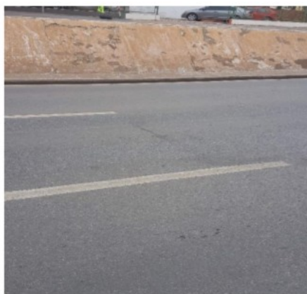
Trinca transversal 15° 36' 47" S e 56° 7' 38" W
