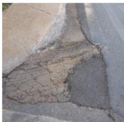
Remendo mal feito 15° 37' 30" S e 56° 6' 56" W
