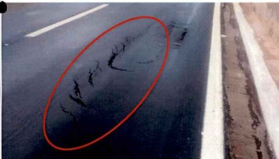
Deslizamento de massa asfáltica
