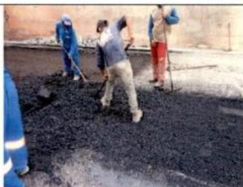
Reparo no pavimento asfáltico
