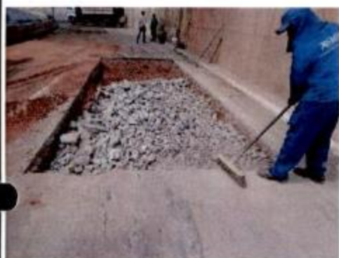
Reparo no pavimento asfáltico
