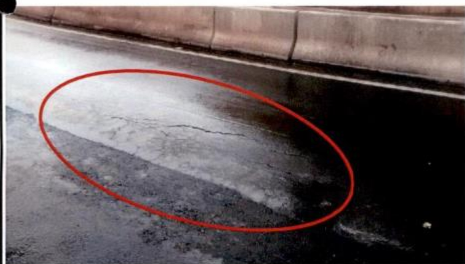
Trincas e afundamento de pavimento
