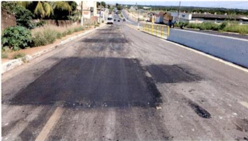
Fig. 09 – Fresagem do pavimento.
