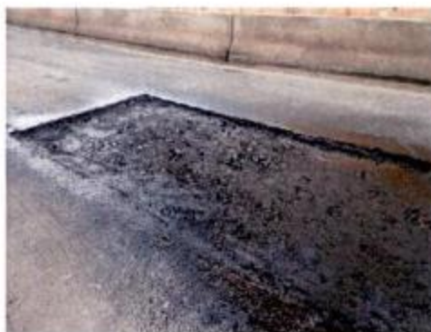
Reparo no pavimento asfáltico
