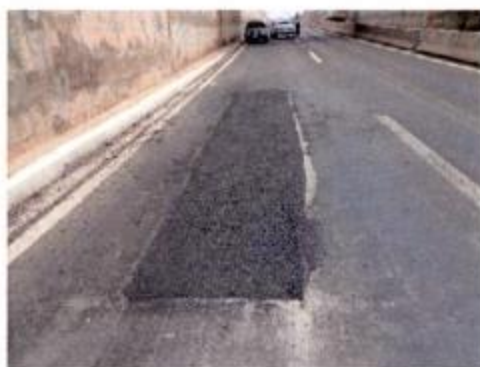
Reparo no pavimento asfáltico
