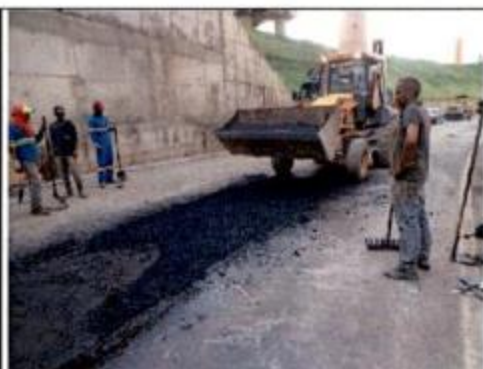
Reparo no pavimento asfáltico
