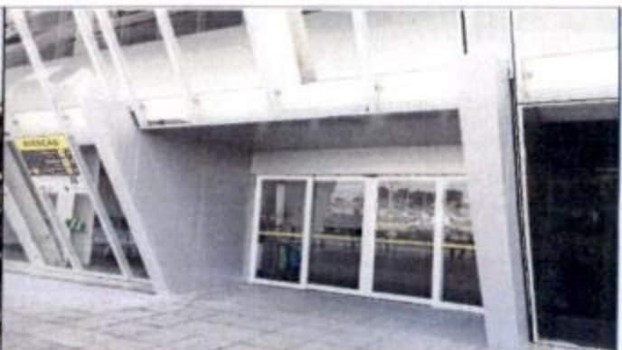
FOTO 12: Instalação de ACM nos Pórticos de Acesso (Fachada frontal) Início: 17/04/17-Término:05/05/17 (Atrasado)
