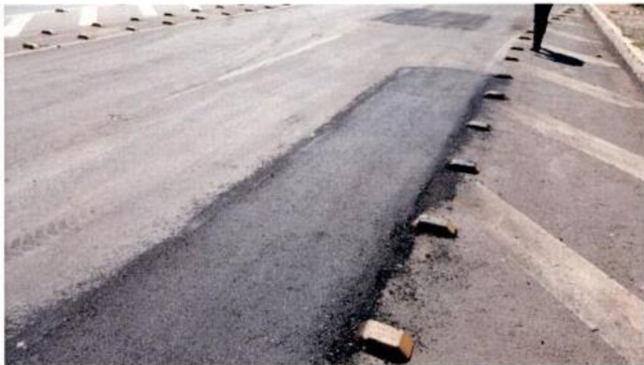
Fig. 10 – Fresagem do pavimento.
