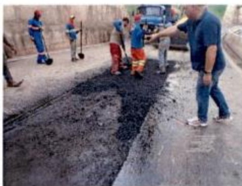
Reparo no pavimento asfáltico
