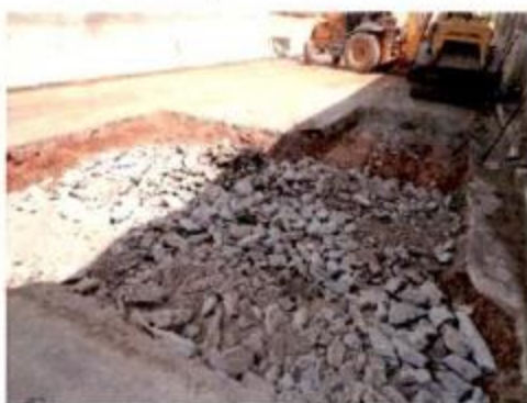
Reparo no pavimento asfáltico
