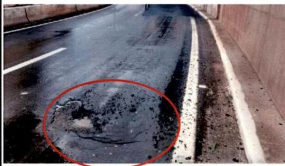
Afundamento do pavimento e buraco na pista
