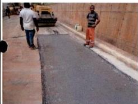
Reparo no pavimento asfáltico
