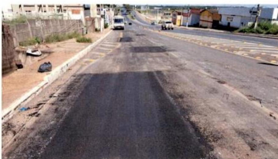
Fig. 08 – Fresagem do pavimento.
