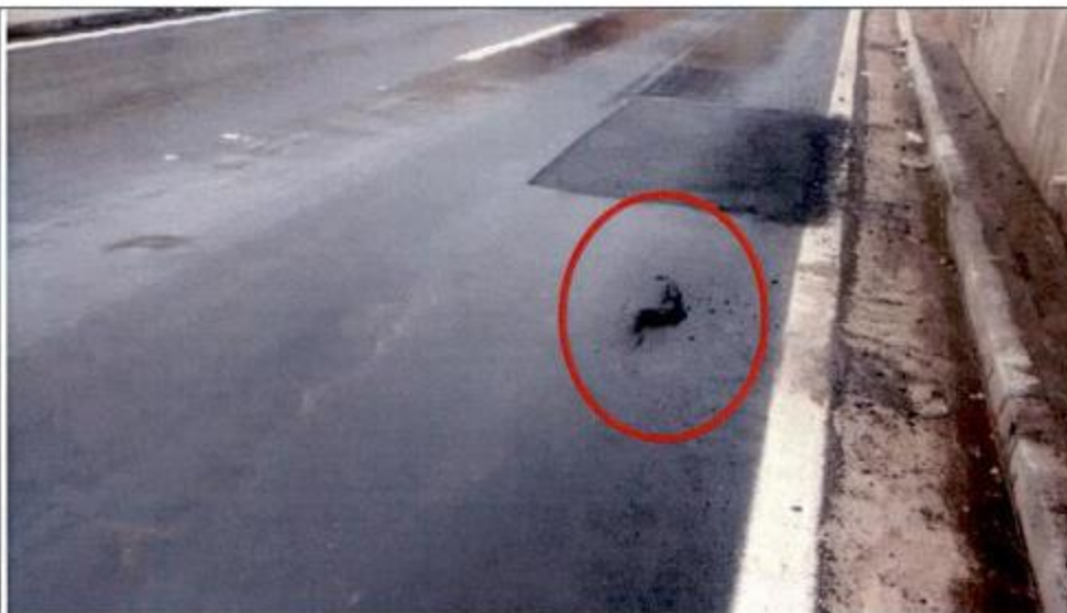
Deslizamento de massa asfáltica
