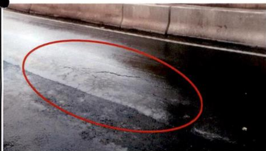
Trincas e afundamento de pavimento
