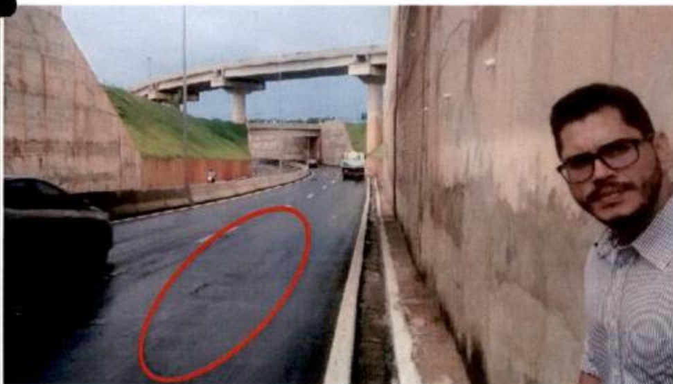
Afundamento do pavimento asfáltico
