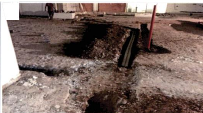
FOTO 07: Instalação das redes de água e esgoto - SETOR C - Reforma
