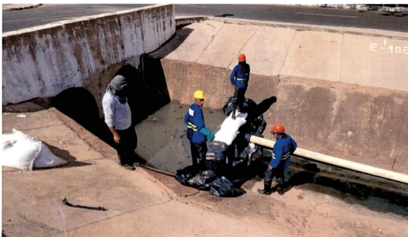
Fig. 06 – Ensecadeira para concretagem do fundo do canal;
