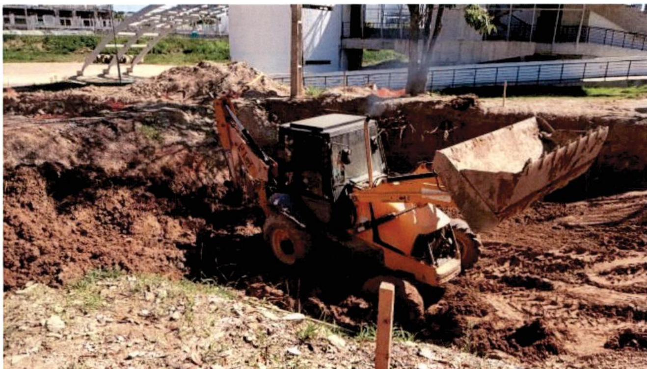
Fig. 07 – Escavação do reservatório de água potável/incêndio.
