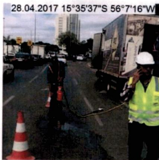
FOTO 2 – EXTRAÇÃO DO CORPO DE PROVA COM ROTATIVA.
