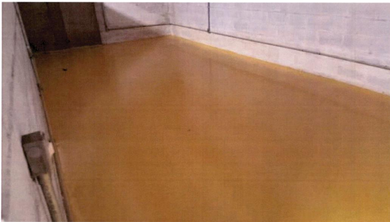
Fig. 04 – Execução do piso monolítico nos locais informados em projeto.
