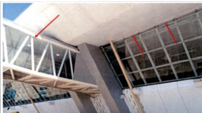
FOTO 02: Instalação de ACM na laterais da ponte
