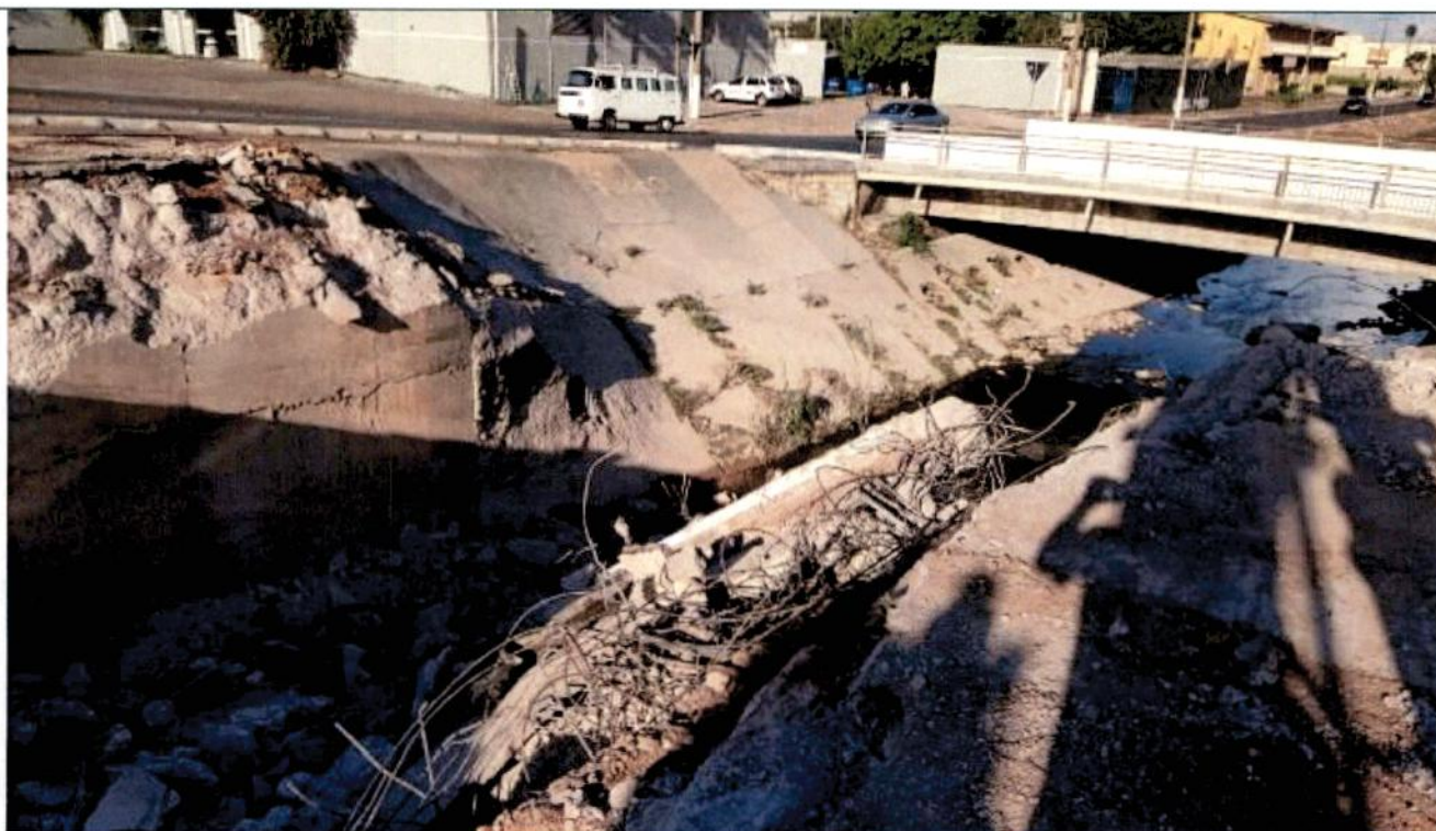
Fig. 07 – Demolição dos dispositivos de concreto armado – Rua Barão de Melgaço com Av. Oito de Abril;
