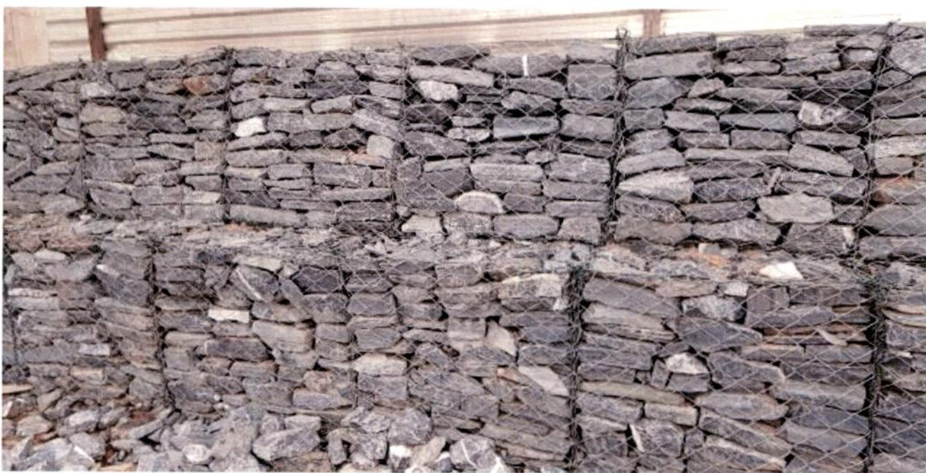
Fig. 02 – Execução do muro em gabião.
