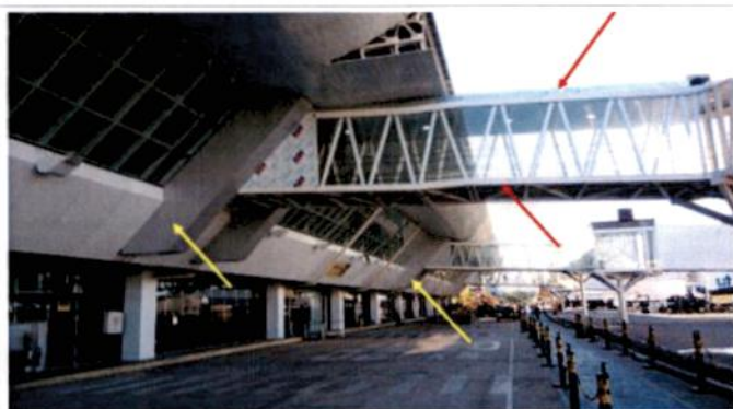
FOTO 01: Instalação de ACM na ponte de embarque
