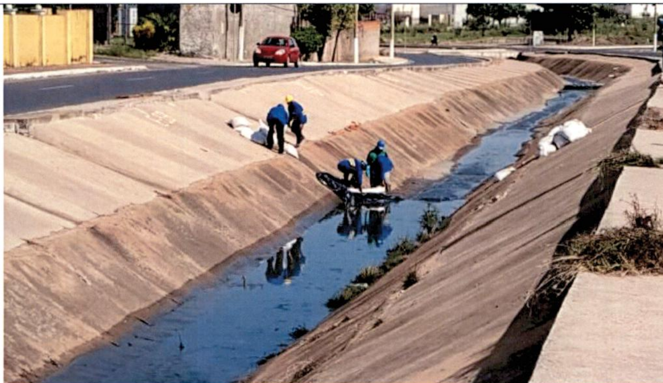
Fig. 05 – Ensecadeira para concretagem do fundo do canal;
