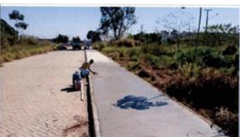
FOTO 04: Execução da calçada da via de ligação da ETE
