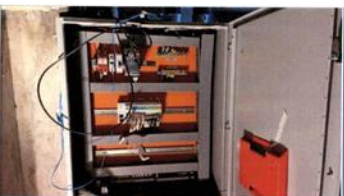
FOTO 12: Instalação de quadro do Sistema SIGUE
