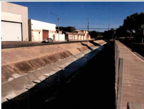
Figura 3- Fundo do canal concretado.
