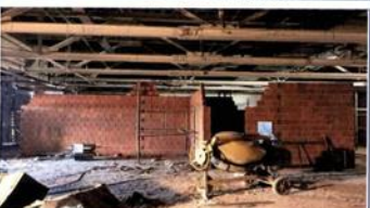
FOTO 06: Reforma Setor C- Execução da alvenaria das salas operacionais
