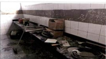
FOTO 07: Instalação das bancadas e cubas- Reforma Sanitários públicos Setor C (pra Terreno)
