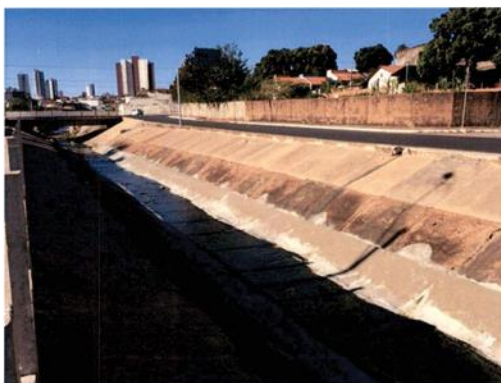
Figura 4- Fundo do canal concretado.
