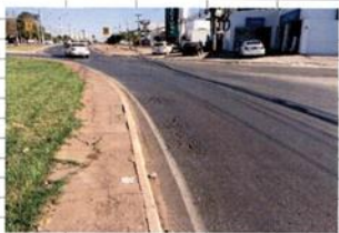
Detalhe 02 - Trecho com problemas no pavimento, aparecimento de trincas couro de jacaré e afundamento.
