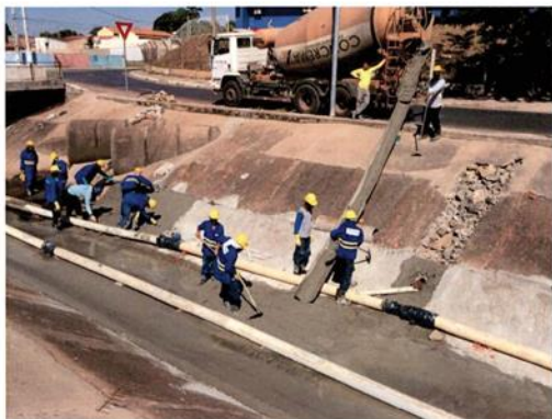
Figura 1- Concretagem do fundo do canal.
