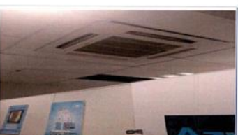
FOTO 08: Instalação de AR condicionado em áreas diversas da ampliação do TPS (água gelada)
