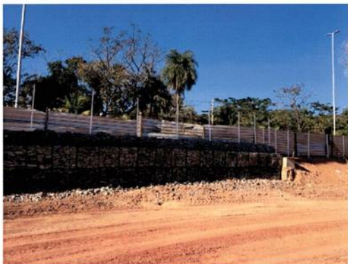
Figura 9-Gabião e limpeza da pista.
