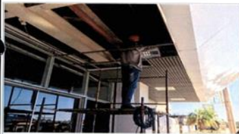
FOTO 11: Instalação do forro colméia no lado AR
