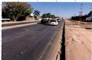
Detalhe 03 - Patologias no pavimento, afundamento e trilha de rodas, calçadas
