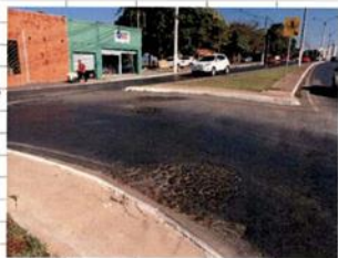
Detalhe 01 - Trecho com problemas no pavimento, aparecimento de trincas, covas de jacaré e afundamento.
