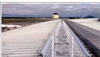
FOTO 02: Execução da passarela metálica na cobertura do TPS
