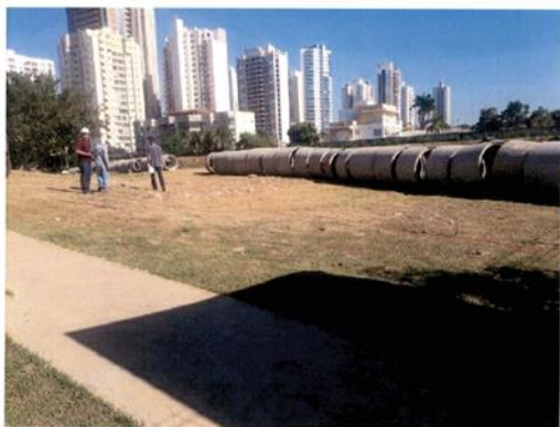
Figura 13- Detalhe Tubulação de 1200mm, drenagem do estacionamento.
