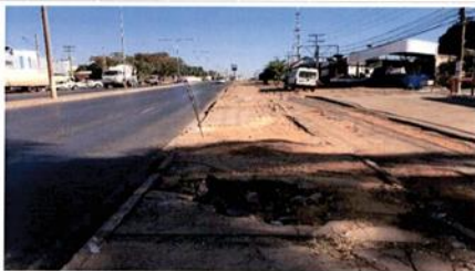
Detalhe 04 - Patologias no pavimento, afundamento e trilha de rodas, calçadas danificadas.
