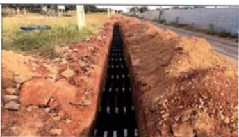
FOTO 10: Instalação dos dutos PEAD para SDA e Telemática
