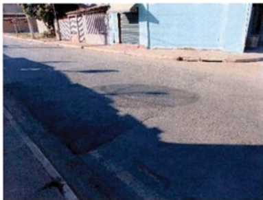
Fotografia 118 – Remendo mal feito
