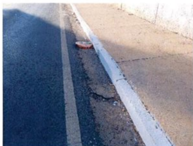
Fotografia 75 – Sarjeta quebrada
