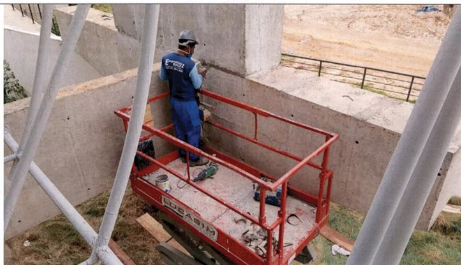
Fig. 07 – Lixamento da estrutura em concreto aparente.
