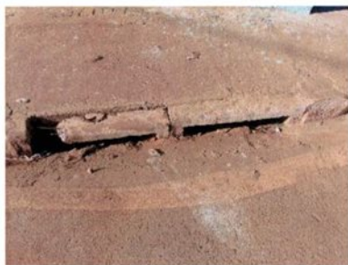
Fotografia 119 – Meio-fio quebrado
