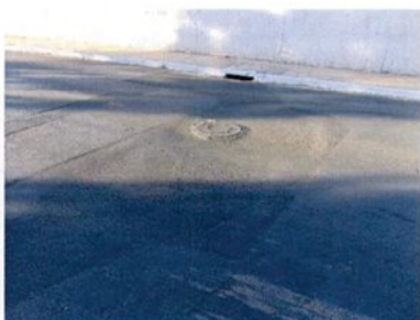
Fotografia 68 – Afundamento
