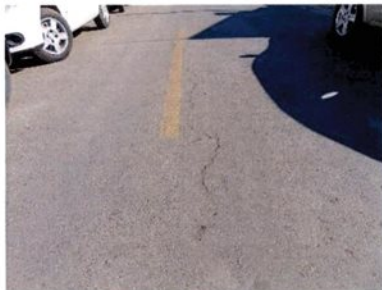
Fotografia 10 – Trinca longitudinal
