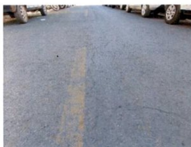
Fotografia 05 – Trinca longitudinal
