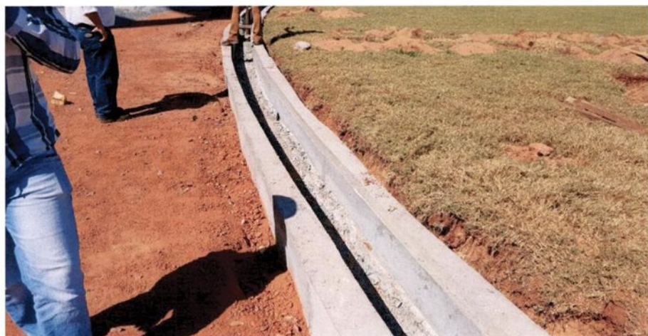
Fig. 02 – Execução das canaletas de concreto.
