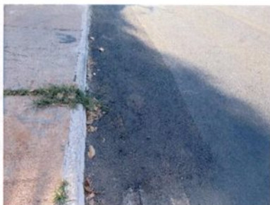
Fotografia 88 – Afundamento
