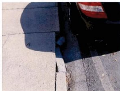
Fotografia 04 – Meio-fio quebrado
