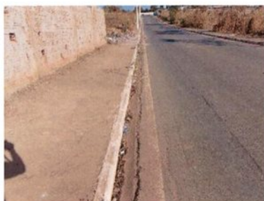
Fotografia 107 – Afundamento
