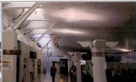
FOTO 10: FRETE 6 - Instalação dos Totens e luminárias.
