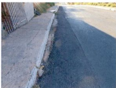
Fotografia 90 – Afundamento
