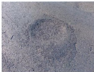
Fotografia 72 – Afundamento
