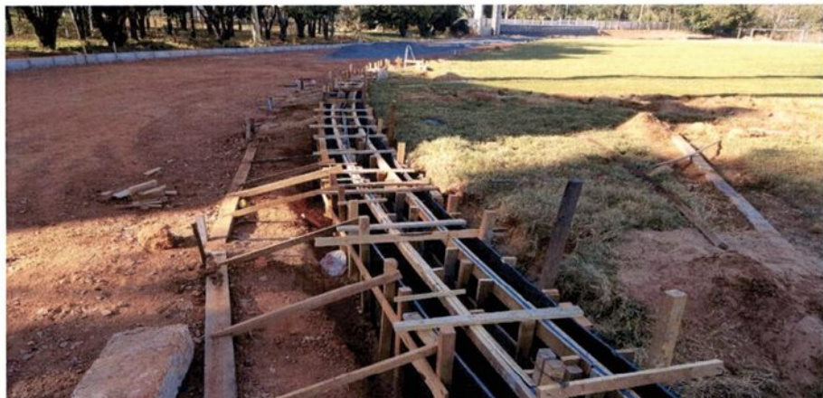
Fig. 01 – Forma para execução das canaletas de concreto (não previsto em planilha orçamentária).
