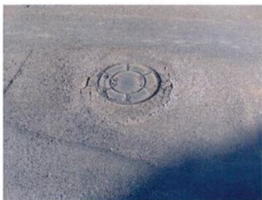
Fotografia 53 – Afundamento
