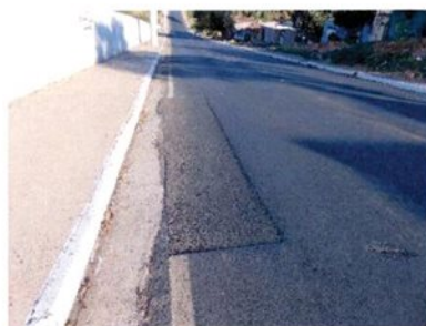
Fotografia 61 – Afundamento
