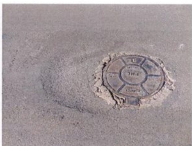
Fotografia 102 – Afundamento
