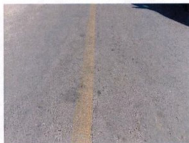
Fotografia 08 – Trinca longitudinal
