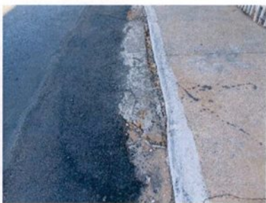
Fotografia 92 – Afundamento
