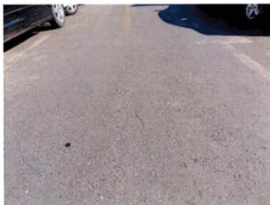
Fotografia 09 – Trinca longitudinal
