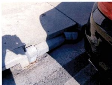
Fotografia 03 – Meio-fio quebrado
