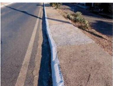
Fotografia 78 – Meio-fio desalinhado
