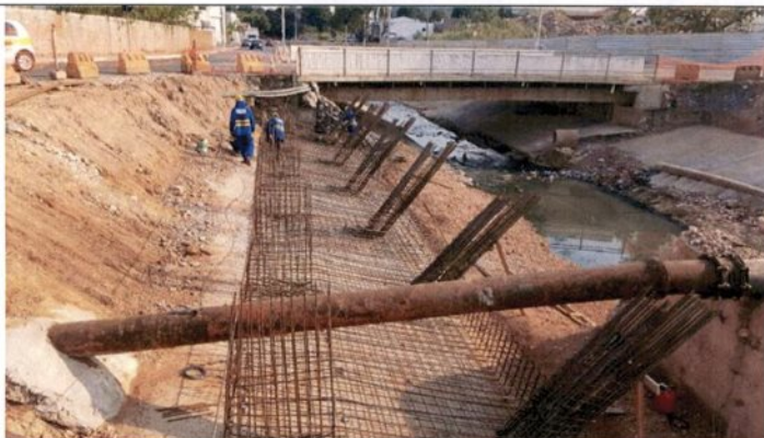
Fig. 05 – Execução da armadura da fundação da laje da rotatória da Av. Senador Metelo;
