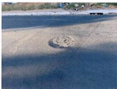
Fotografia 64 – Afundamento
