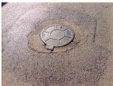
Fotografia 110 – Afundamento
