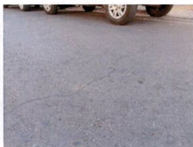
Fotografia 06 – Trinca transversal
