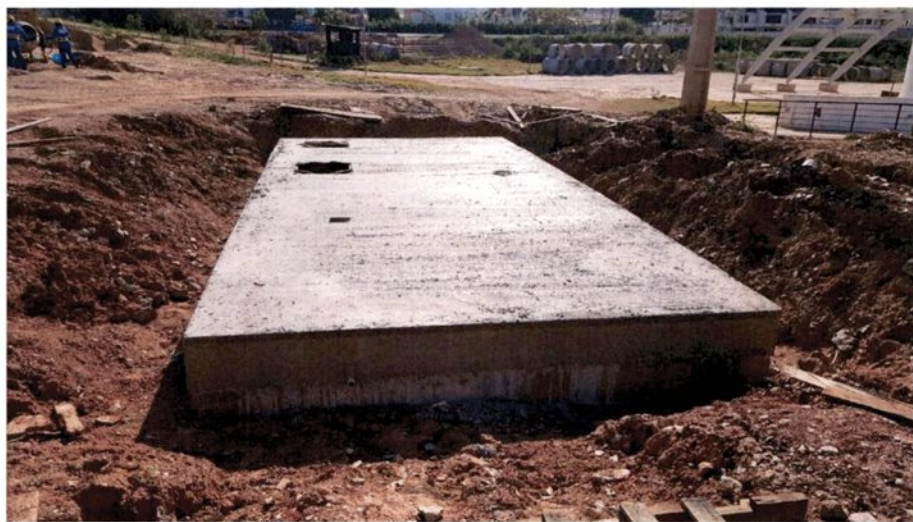
Fig. 10 – Laje do reservatório enterrado (cisterna).
