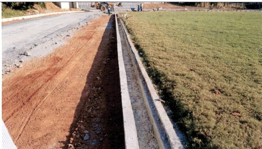
Fig. 03 – Execução das canaletas de concreto.
