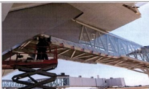
FOTO 09: FRETE 5 - Acabamento na estrutura metálica em ACM cinza-Pontes de Embarque 01,02 e
