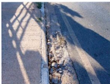
Fotografia 96 – Sarjeta quebrada
