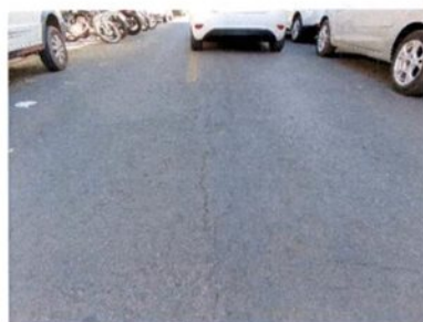
Fotografia 07 – Trinca longitudinal
