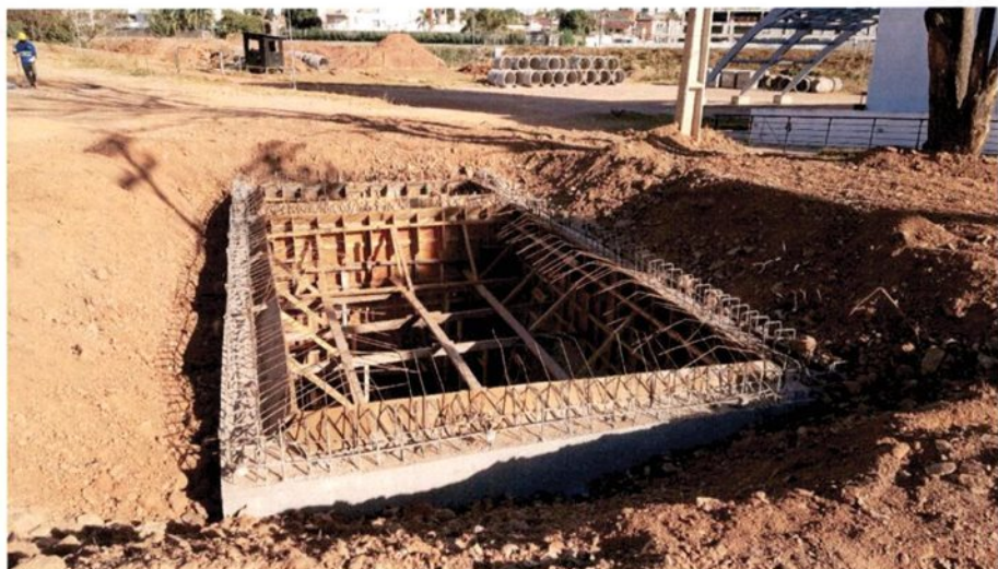
Fig. 09 – Laje do reservatório enterrado (cisterna).
