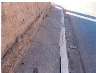
Fotografia 126 – Sarjeta quebrada
