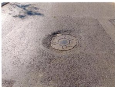
Fotografia 105 – Afundamento
