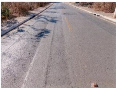
Fotografia 104 – Afundamento
