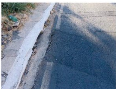
Fotografia 66 – Afundamento
