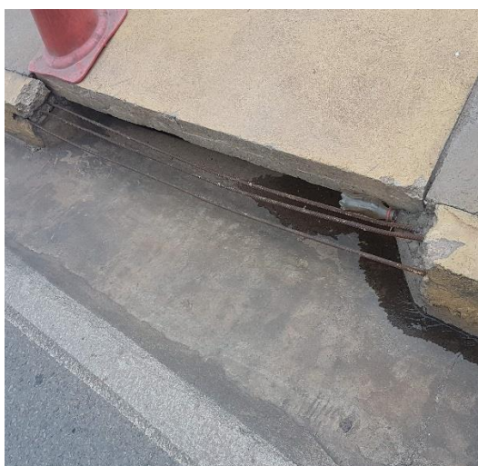
Meio-fio quebrado 15° 36' 48" S e 56° 7' 37" W
