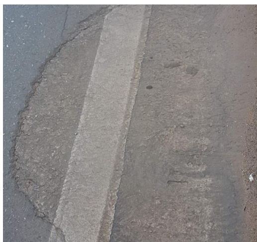
Sarjeta mal feita 15° 37' 11" S e 56° 7' 9" W
