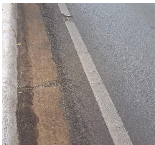
Trinca transversal 15° 36' 37" S e 56° 7' 44" W
