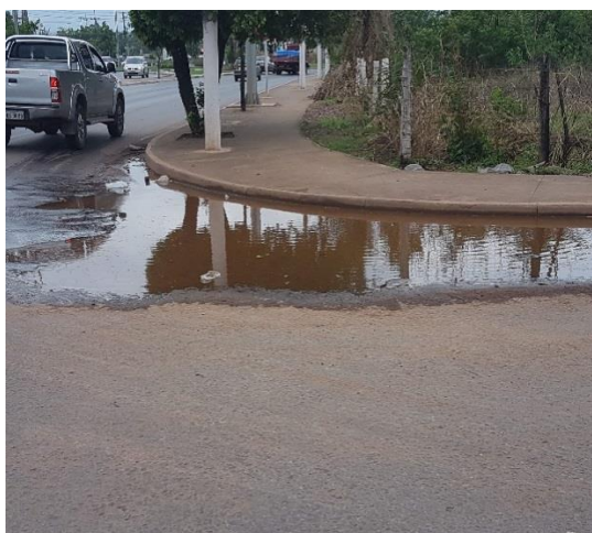
Ausência de drenagem 15° 37' 8" S e 56° 7' 18" W
