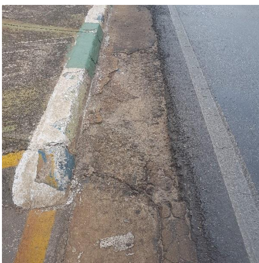
Sarjeta mal feita 15° 36' 36" S e 56° 7' 44" W
