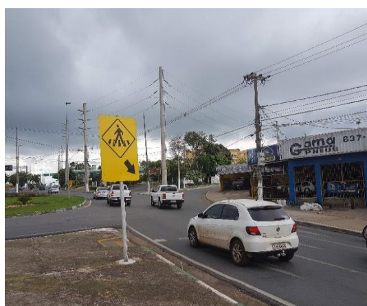
Sinalização vertical indicando faixa de pedestre sem pintura da faixa 15° 36' 35" S e 56° 7' 44" W
