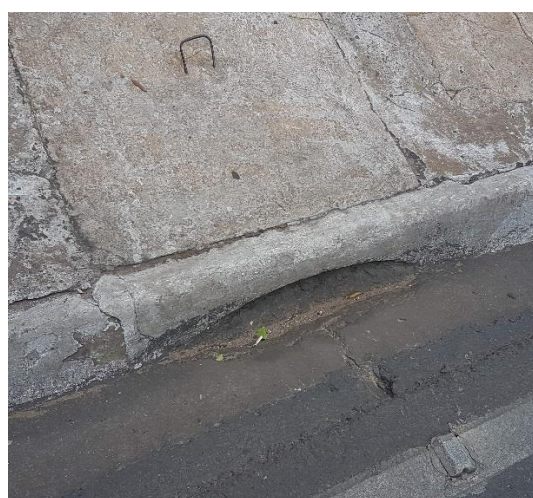
Boca de lobo obstruída 15° 36' 41" S e 56° 7' 42" W
