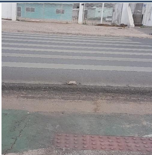
Acessibilidade sem continuidade 15° 36' 49" S e 56° 7' 35" W
