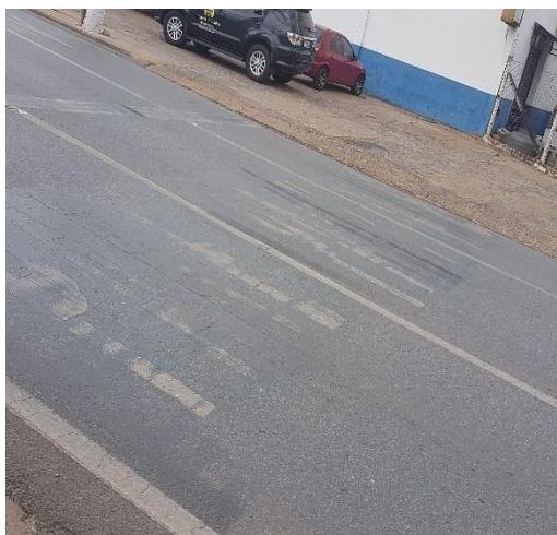
Sinalização horizontal desgastada 15° 36' 49" S e 56° 7' 35" W
