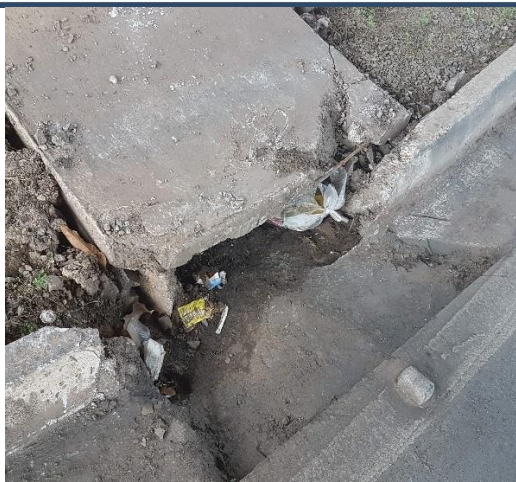
Boca de lobo mal feita 15° 37' 38" S e 56° 6' 49" W
