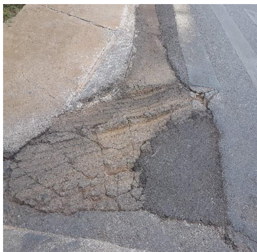
Remendo mal feito 15° 37' 30" S e 56° 6' 56" W
