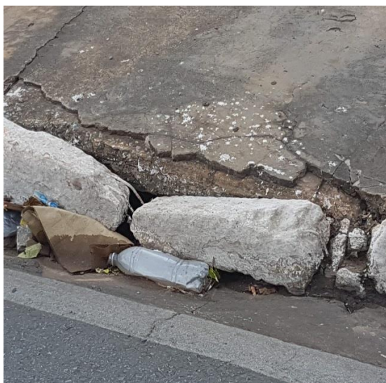
Meio-fio quebrado obstruindo boca de lobo 15° 36' 39" S e 56° 7' 43" W
