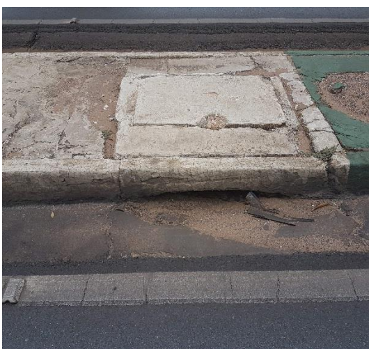
Boca de lobo obstruída e fora do padrão 15° 37' 18" S e 56° 7' 9" W
