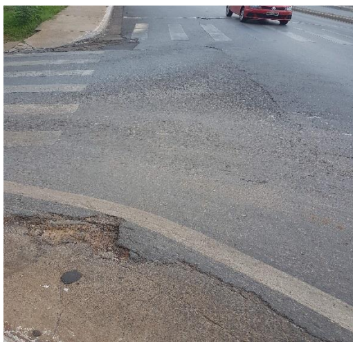
Remendo mal feito e buraco 15° 37' 30" S e 56° 6' 57" W
