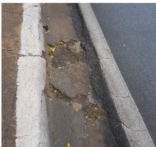
Sarjeta mal feita 15° 36' 49" S e 56° 7' 35" W
