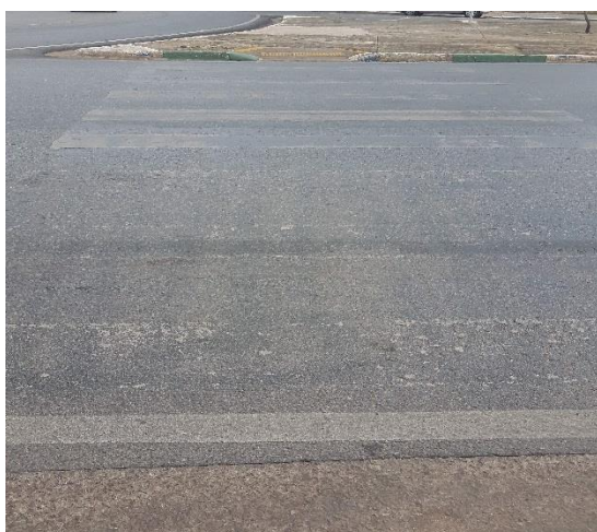
Sinalização horizontal desgastada 15° 36' 35" S e 56° 7' 44" W
