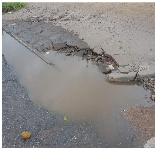
Buraco e ausência de drenagem 15° 36' 54" S e 56° 7' 30" W
