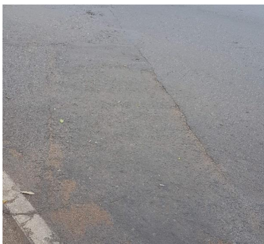
Remendo mal feito 15° 37' 10" S e 56° 7' 14" W
