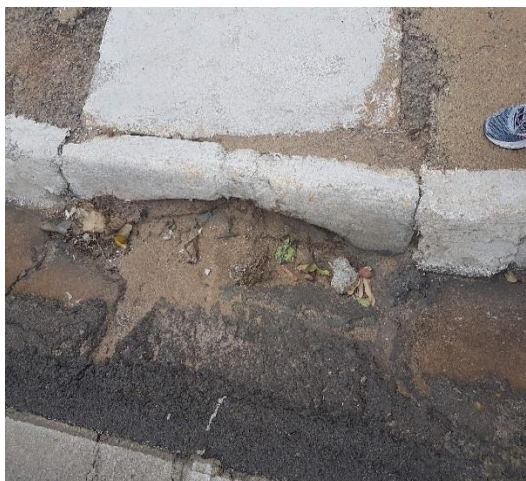
Boca de lobo obstruída 15° 36' 40" S e 56° 7' 43" W
