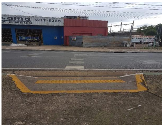
Acessibilidade sem continuação do outro lado da pista
