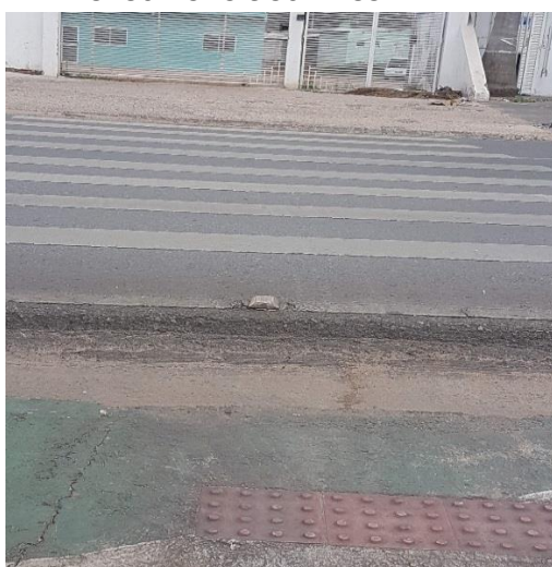
Acessibilidade sem continuidade 15° 36' 49" S e 56° 7' 35" W
