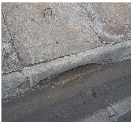
Boca de lobo obstruída 15° 36' 41" S e 56° 7' 42" W
