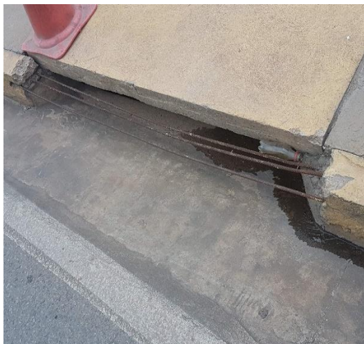
Meio-fio quebrado 15° 36' 48" S e 56° 7' 37" W
