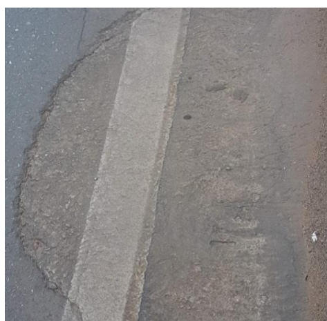
Sarjeta mal feita 15° 37' 11" S e 56° 7' 9" W
