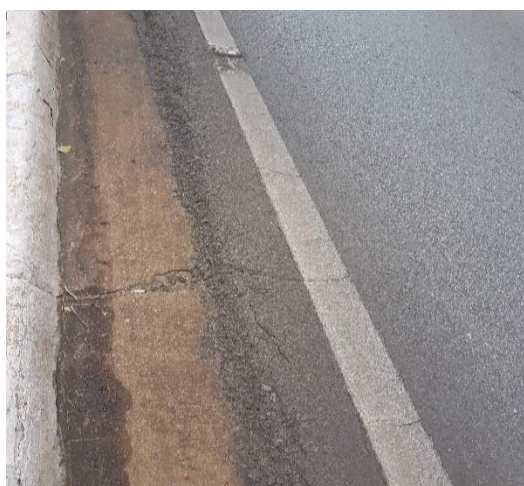
Trinca transversal
