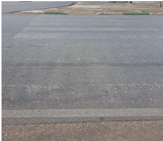
Sinalização horizontal desgastada 15° 36' 35" S e 56° 7' 44" W
