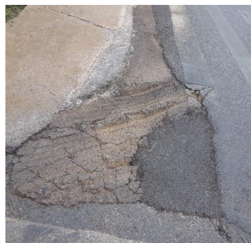
Remendo mal feito 15° 37' 30" S e 56° 6' 56" W
