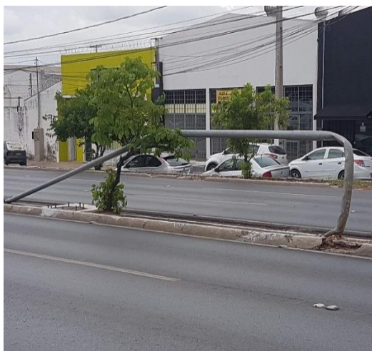
Sinalização vertical caída 15° 37' 3" S e 56° 7' 23" W
