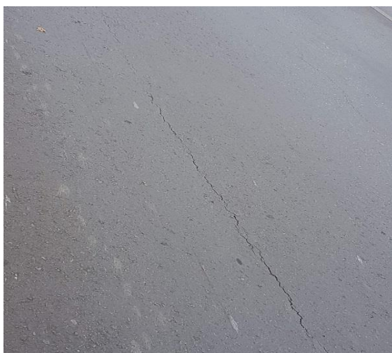
Trinca na pista 15° 37' 26" S e 56° 7' 2" W
