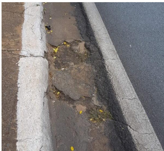
Sarjeta mal feita 15° 36' 49" S e 56° 7' 35" W
