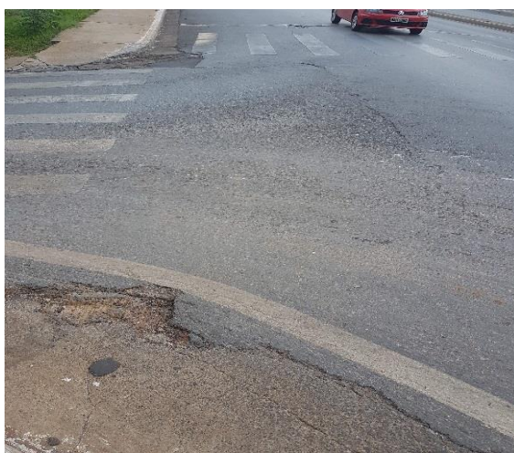
Remendo mal feito e buraco 15° 37' 30" S e 56° 6' 57" W
