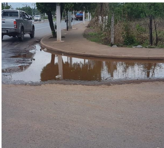
Ausência de drenagem 15° 37' 8" S e 56° 7' 18" W
