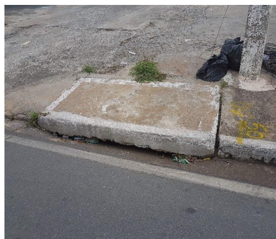
Boca de lobo obstruída e fora do padrão
