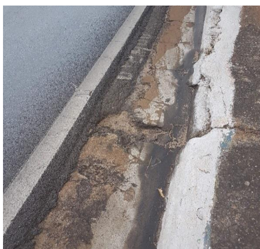
Sarjeta e meio-fio mal feitos
