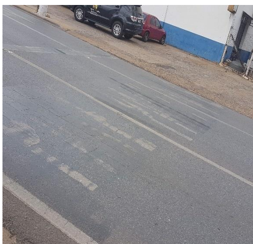
Sinalização horizontal desgastada 15° 36' 49" S e 56° 7' 35" W
