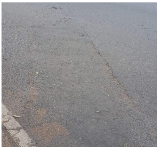
Remendo mal feito 15° 37' 10" S e 56° 7' 14" W
