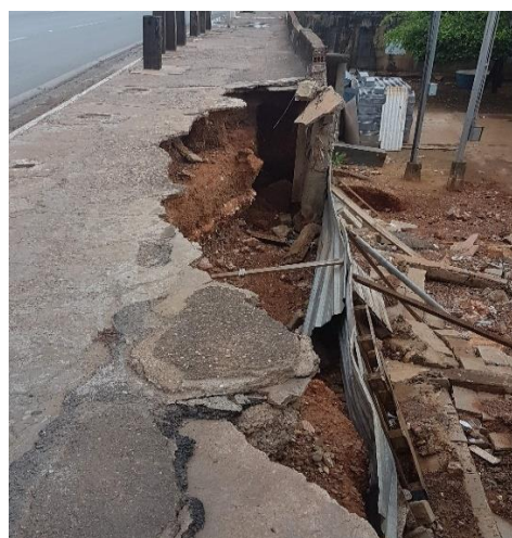
Calçada desmoronada 15° 36' 49" S e 56° 7' 35" W
