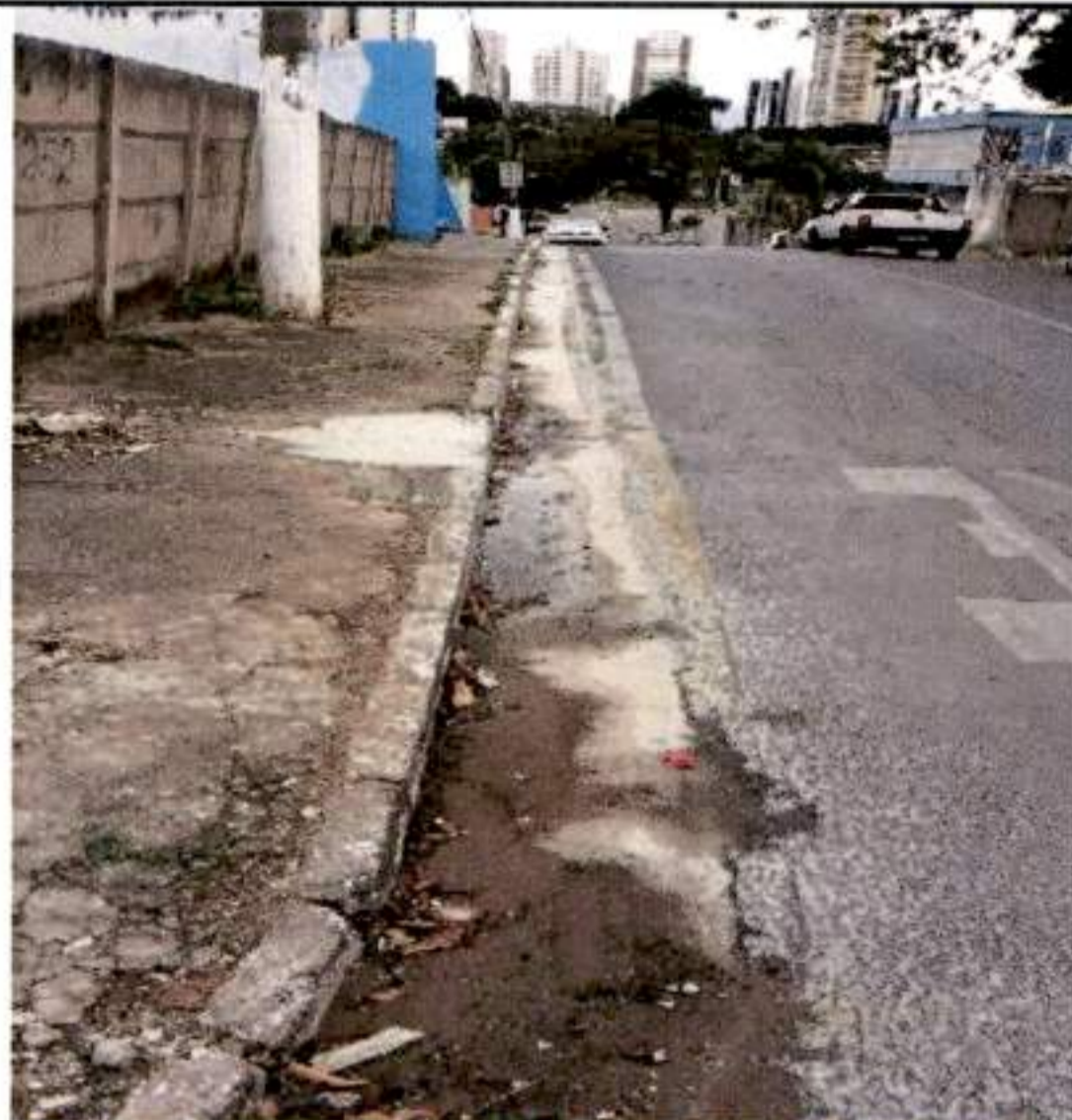
Figura 11 - Execução de sarjeta na rua Rui Barbosa
