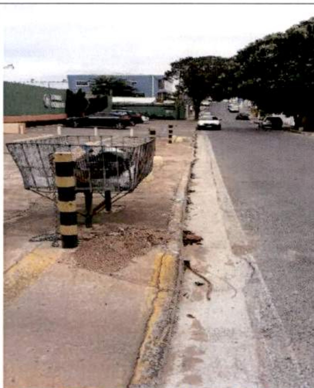
Figura 9 - Execução de sarjeta na rua Rui Barbosa
