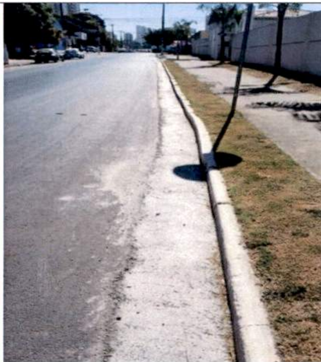
Figura 6 - Calçada executada na Joaquim Murtinho
