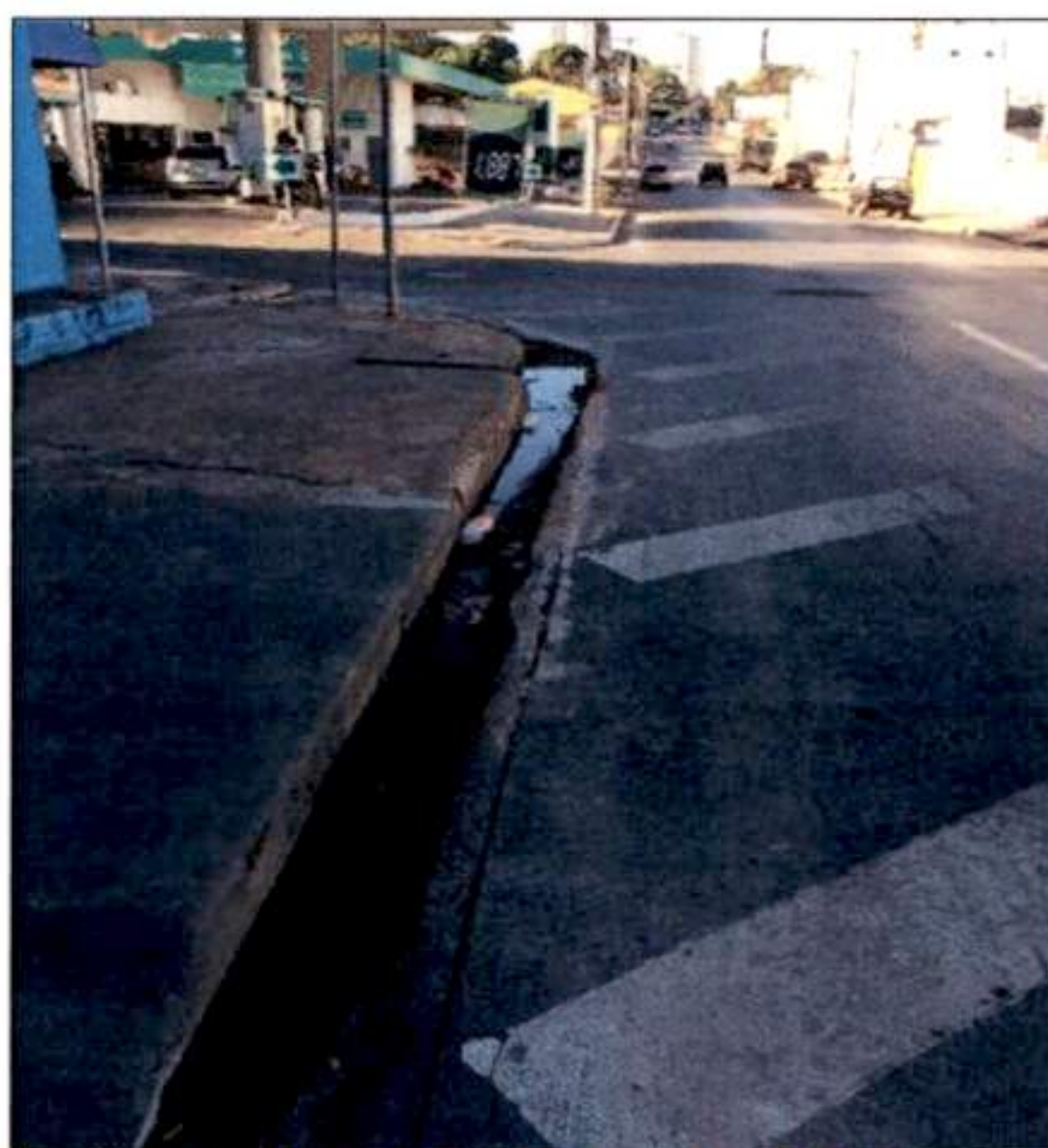
Figura 1 – Retirada e Concretagem de Sarjetas – Est. 78+10 o 80 LE;
