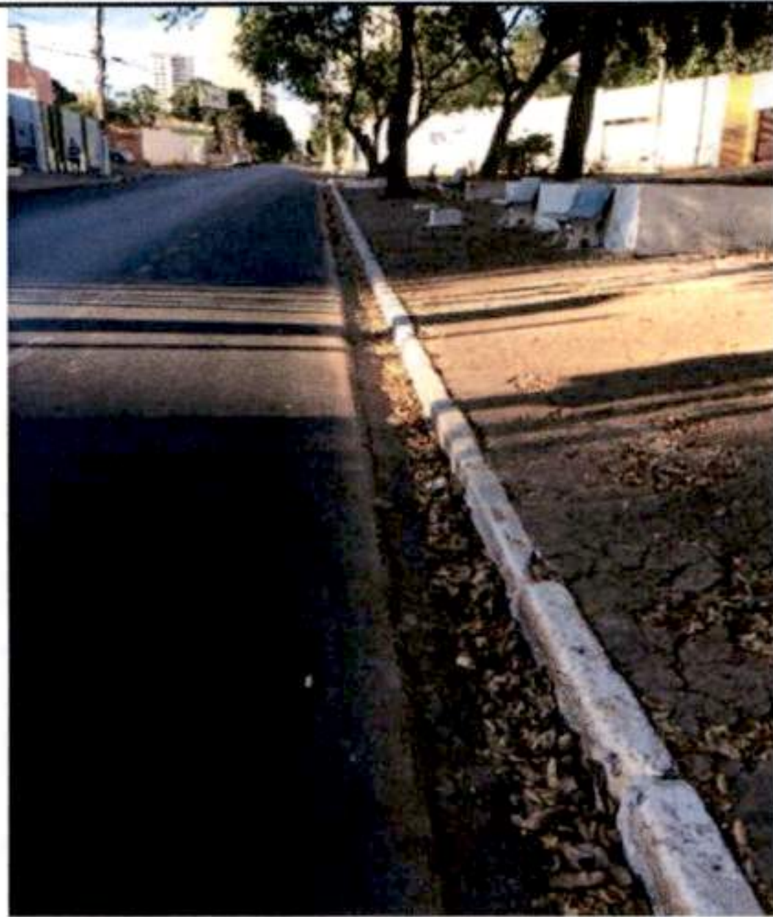
Figura 3 - Est. 94 - 98 LD - Retirada e concretagem de sarjetas - Avenida Ipiranga;
