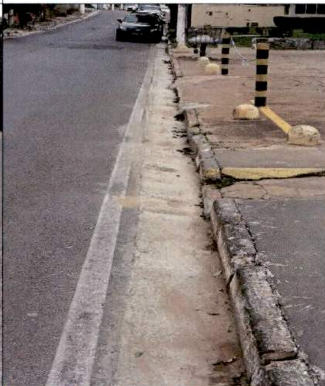
Figura 10 - Execução de sarjeta na rua Rui Barbosa
