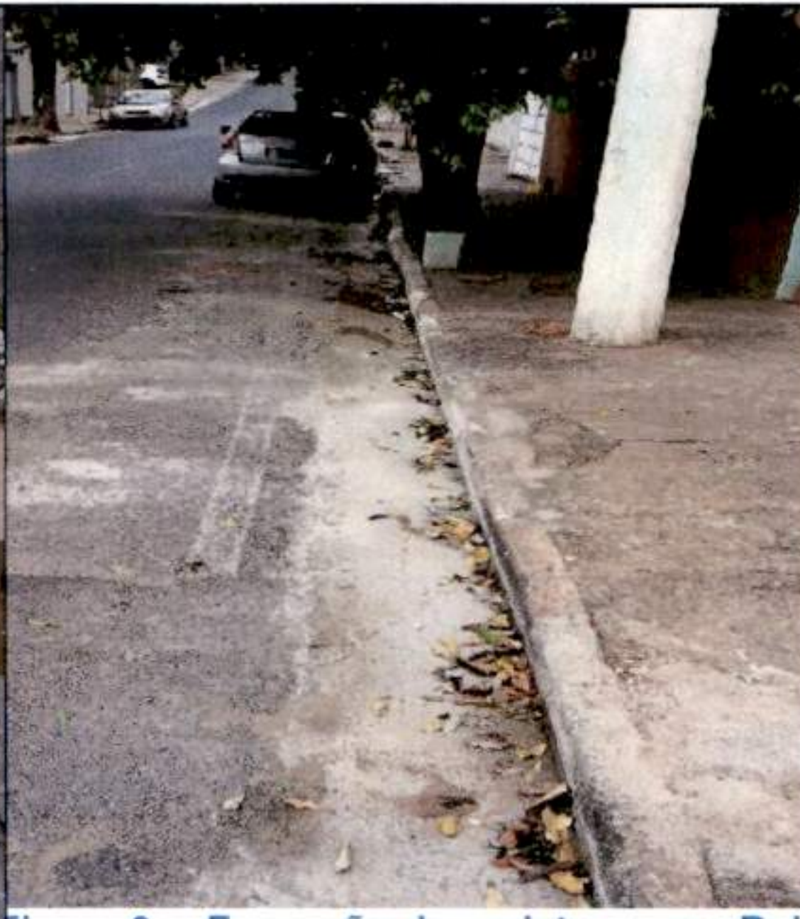
Figura 8 - Execução de sarjeta na rua Rui Barbosa
