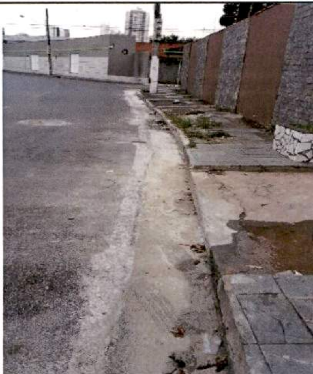
Figura 7 - Execução de sarjeta na rua Rui Barbosa
