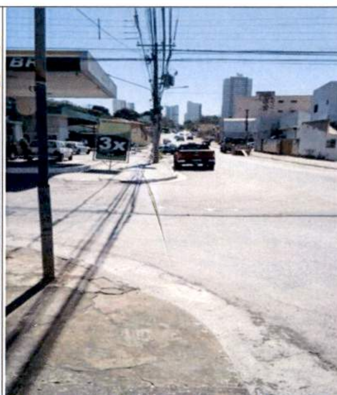
Figura 2 – Retirada e Concretagem de Sarjetas – Est. 78+10 o 80 LE;
