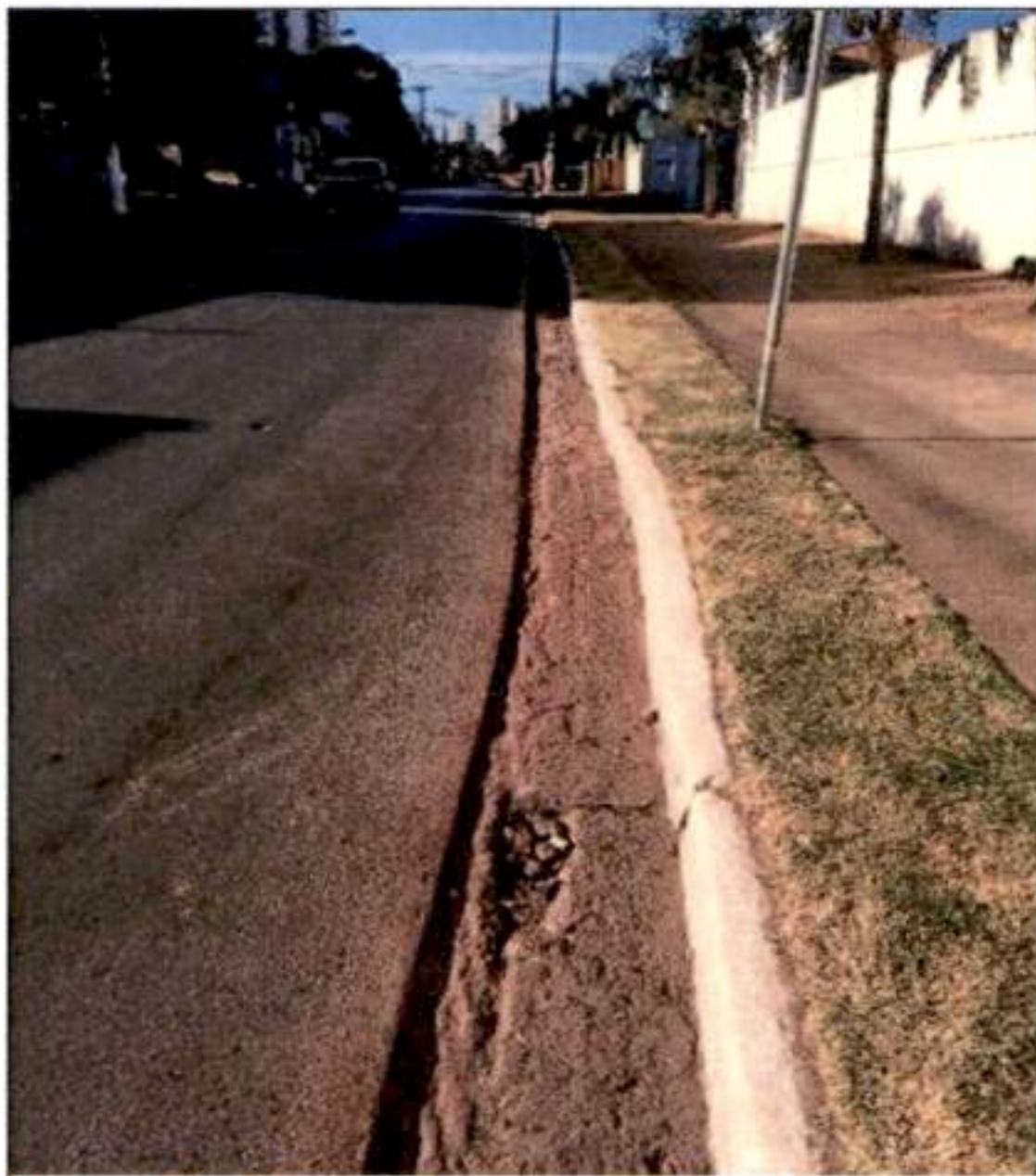
Figura 5 - Calçada executada na Joaquim Murtinho
