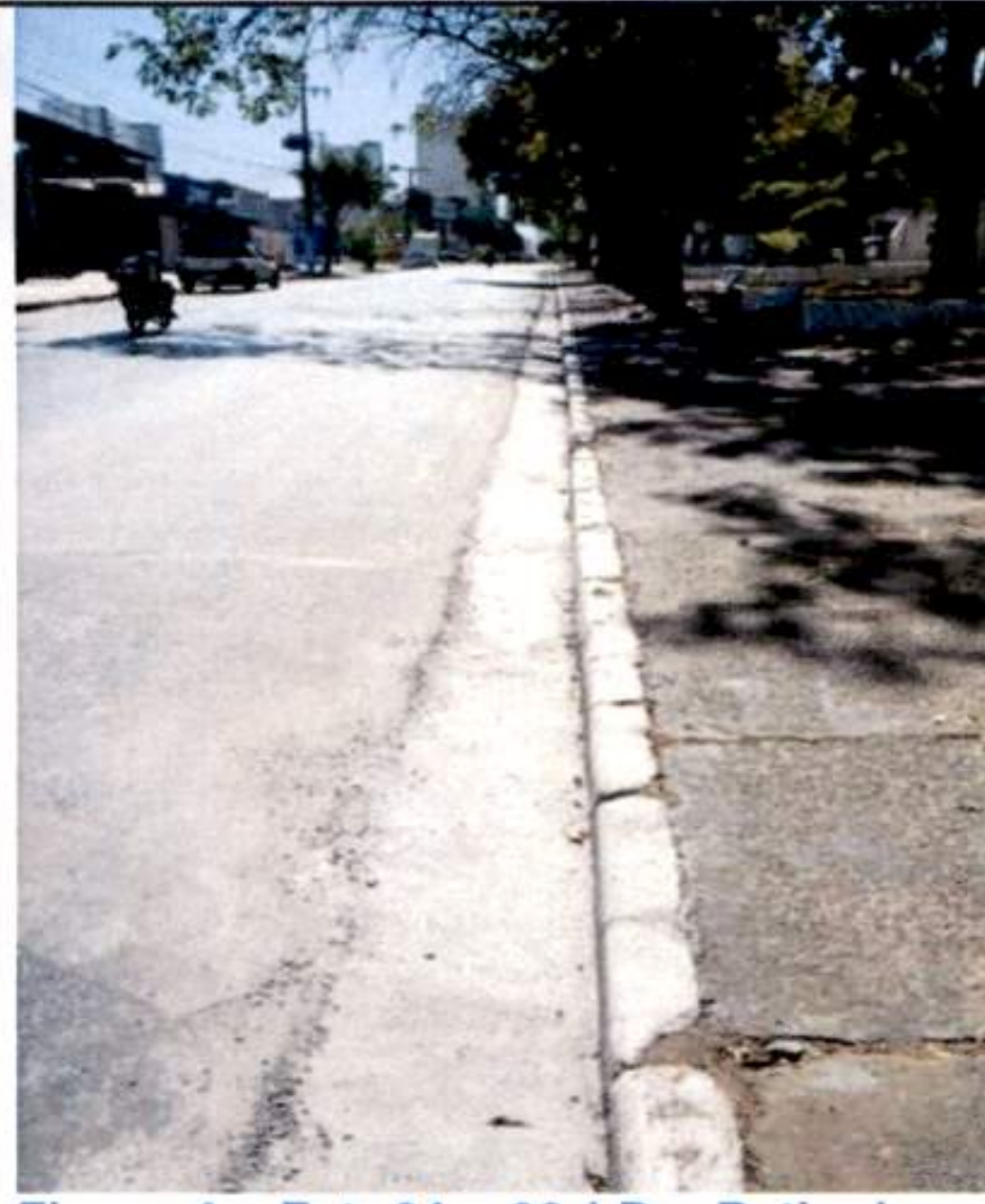
Figura 4 - Est. 94 - 98 LD - Retirada e concretagem de sarjetas - avenida Ipiranga;
