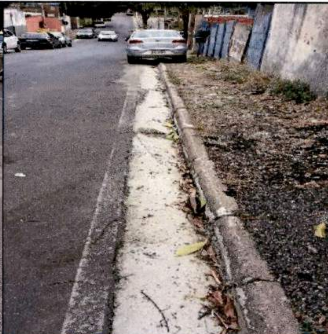
Figura 12 - Execução de sarjeta na rua Rui Barbosa
