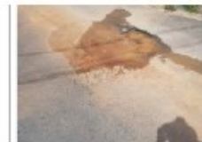
Panela ou buraco e trinca tipo "couro de jacaré" 15° 35' 47" S e 56° 6' 58" W
