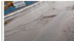
Acúmulo de massa asfáltica na pista e sarjeta 15° 38' 2,46" S e 58° 8' 22" W
