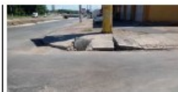
Azúmulo de material betuminoso na sarjeta e calçada 15° 38' 30" S e 58° 8' 24" W
