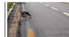
Trinças e panela ou buraco 15° 36' 13" S e 56° 6' 52" W
