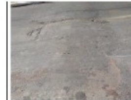
Trincas e escorregamento de massa 15° 36' 11" S e 50° 7' 26" W
