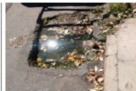
Afundamento e trinca tipo "couro de jacaré" 15° 35' 56" S e 56° 6' 29" W
