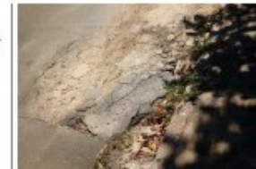
Afundamento e trinca tipo "couro de jacaré" 15° 35' 56" S e 56° 6' 29" W
