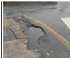
Panela ou buraco e trincas longitudinais 15° 38' 52" S e 58° 6' 21" W
