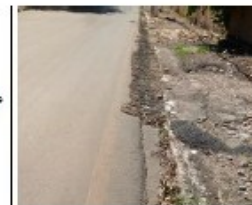
Azúmulo de material betuminoso na sarjeta e calçada 15° 38' 30" S e 58° 8' 24" W
