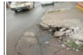
Tampa de bueiro danificada 15° 36' 37" S e 56° 7' 19" W
