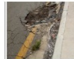
Panela ou buraco e trinca tipo "couro de jacaré" 15° 35' 41" S e 56° 7' 8" W
