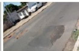
Afundamento e trinca tipo "couro de jacaré" 15° 36' 11" S e 50° 7' 3,93" W
