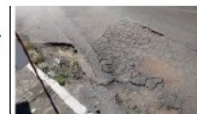
Afundamento e trinca tipo "couro de jacaré" 15° 36' 11" S e 50° 7' 3,93" W
