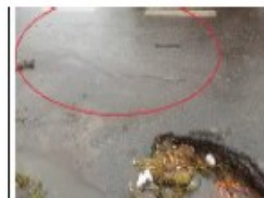
Panela ou buraco e trincas longitudinais 15° 38' 52" S e 58° 6' 21" W
