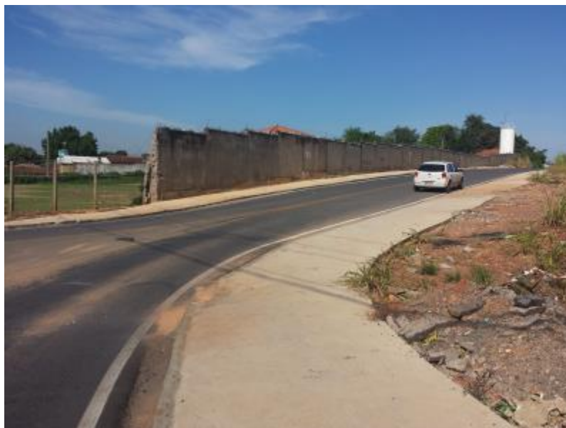
Serviços de pavimentação, calçada e sinalização horizontal – Fim Trecho Rua Onze de Maio
