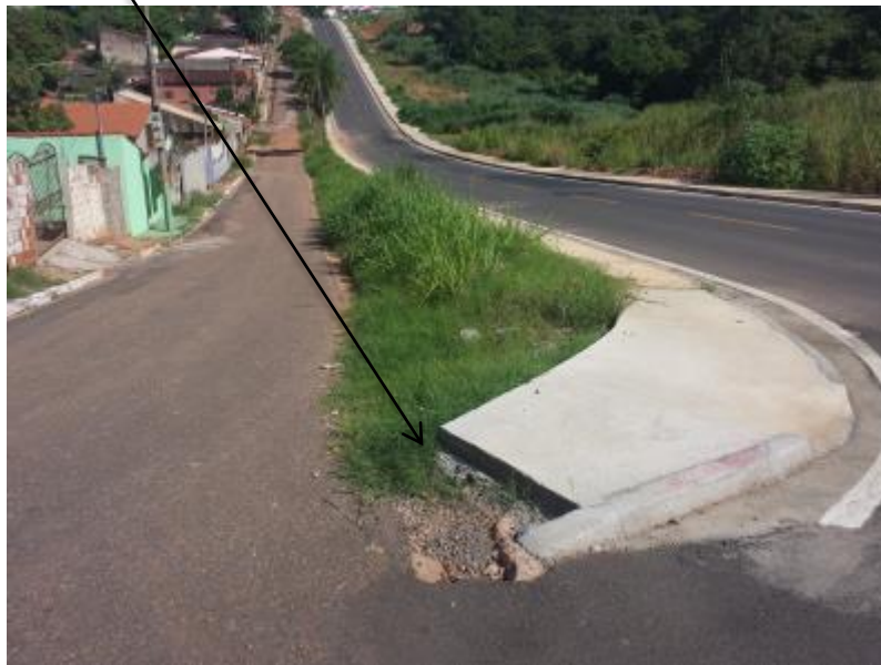
Calçada de concreto executada no passeio Rua Onze de Maio
