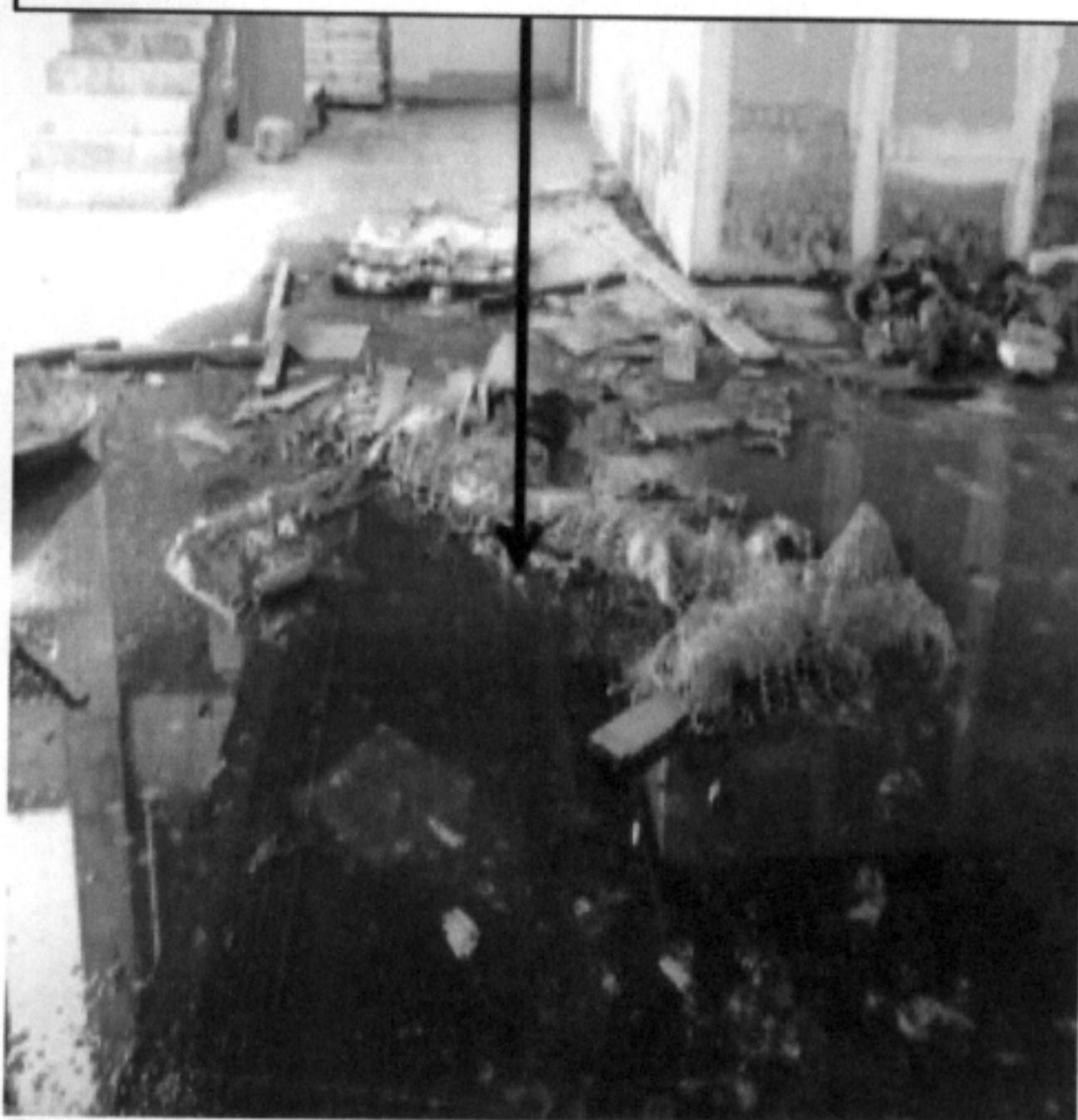
Figura 4 – Piso em cerâmica executado sofreu com a ação de sujeira, umidade, empoçamento de água, sem nenhuma precaução com relação a sua integridade e aparência:
