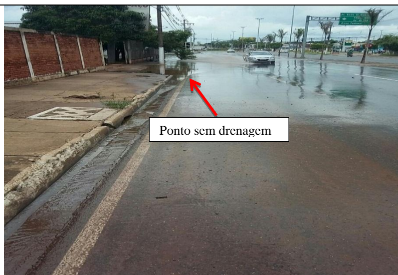
Drenagem - Alagamento Próximo a Rotatória da Av. Barão de Melgaço
