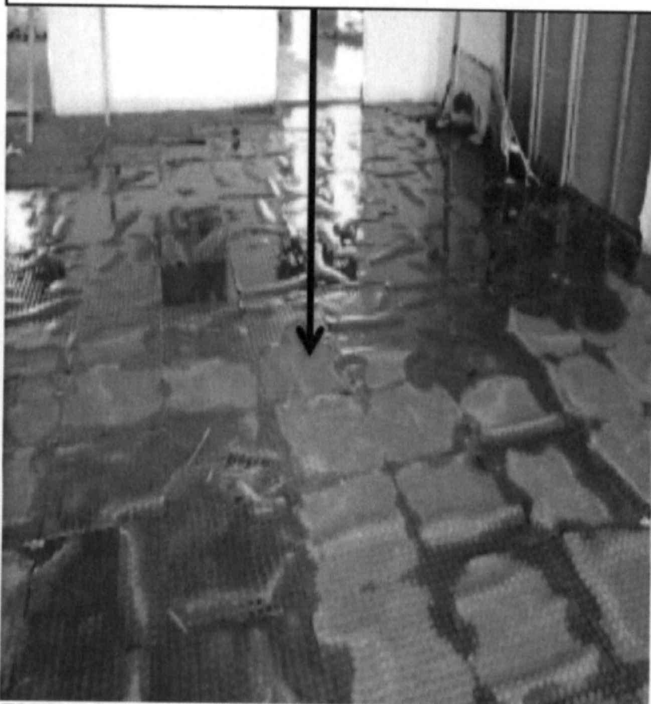
Figura 3 – Piso de borracha em inconformidade em decorrência da queda da parede e do forro de gesso e do acúmulo de água das intempéries;
