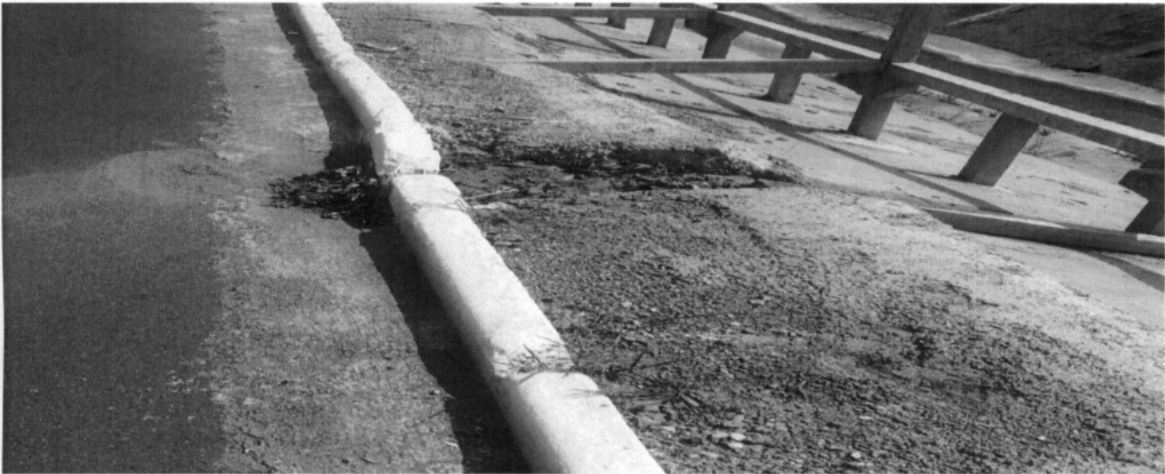
Figura 03: Conclusão da execução do passeio.
