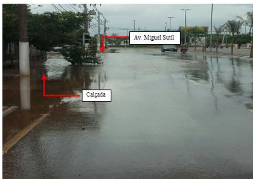
Figura 6 - Drenagem - Alagamento Próximo a Rotatória da Av. Barão
