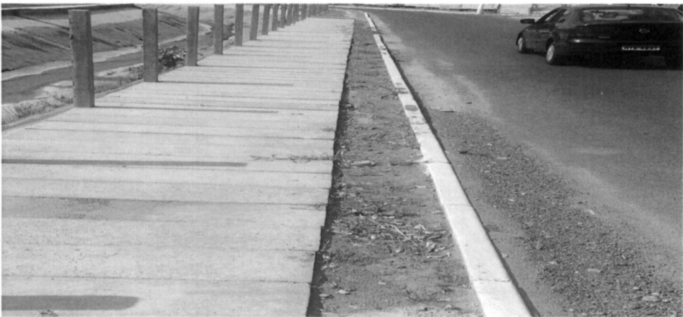
Figura 04 Conclusão da execução do passeio.
