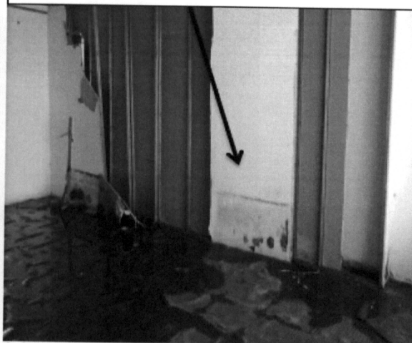
Figura 1 – Parede em Dry-wall danificadas devido à falta de manutenção sofrendo ação do vento e das intempéries, sendo assim, em inconformidade com os normativos técnicos:
