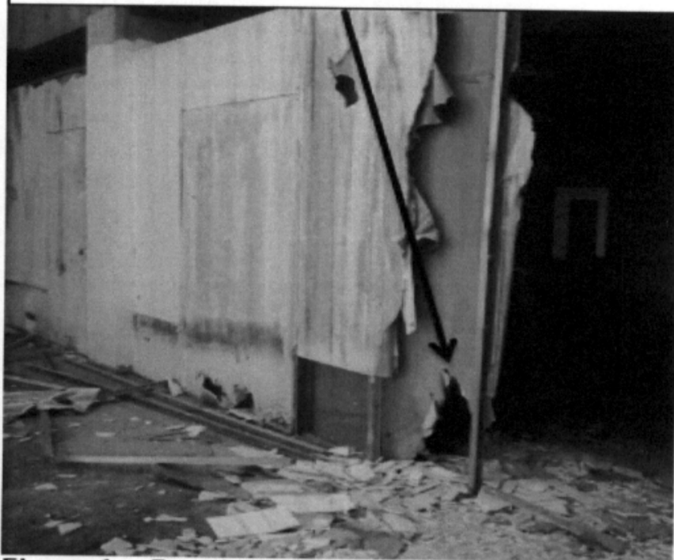
Figura 1 – Parede em Dry-wall danificadas devido à falta de manutenção sofrendo ação do vento e das intempéries, sendo assim, em inconformidade com os normativos técnicos:
