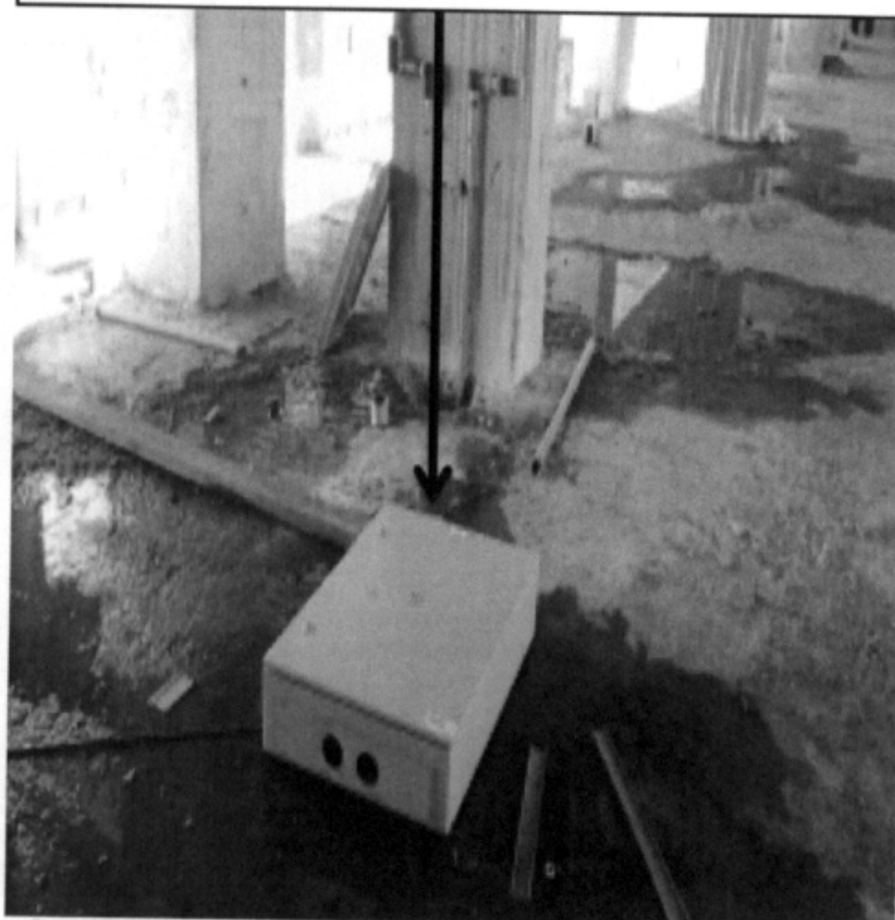
Figura 6 – serviços executados que se encontram danificados pela falta de manutenção e ação de vândalos, ocasionado, pela falta de uma equipe de manutenção no canteiro e de segurança na obra;
