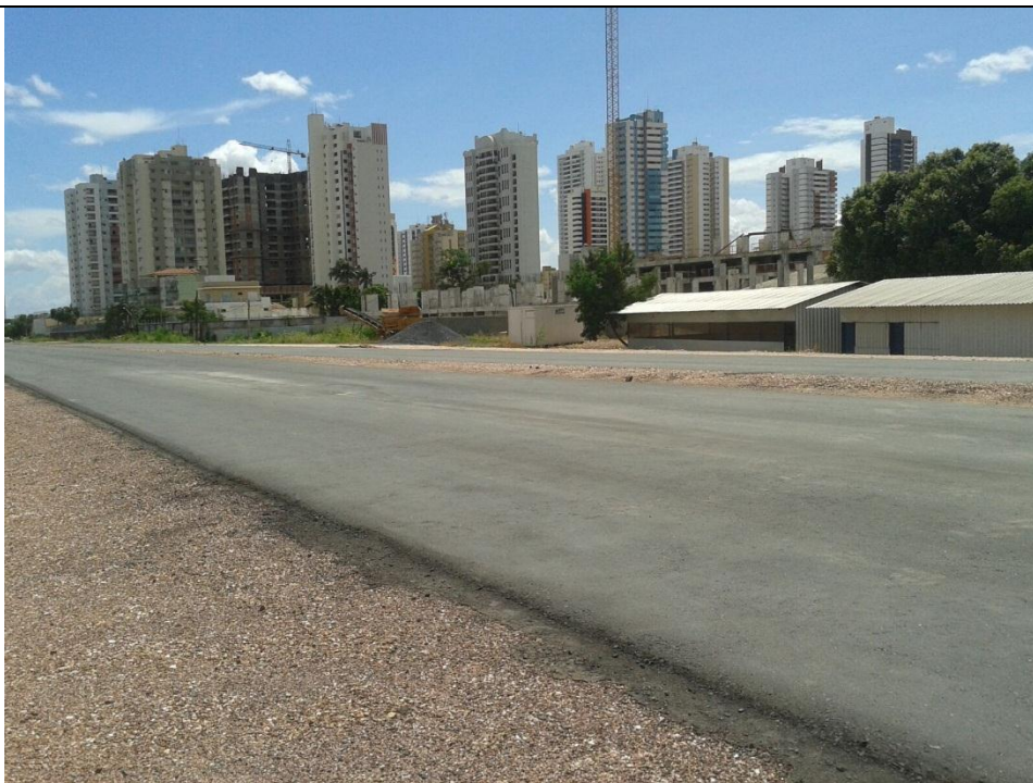
Ausência de funcionários e equipamentos na obra (Extraído CI Nº 15/2016/ASSESSORIA-SAOBC-SECID/MT)
