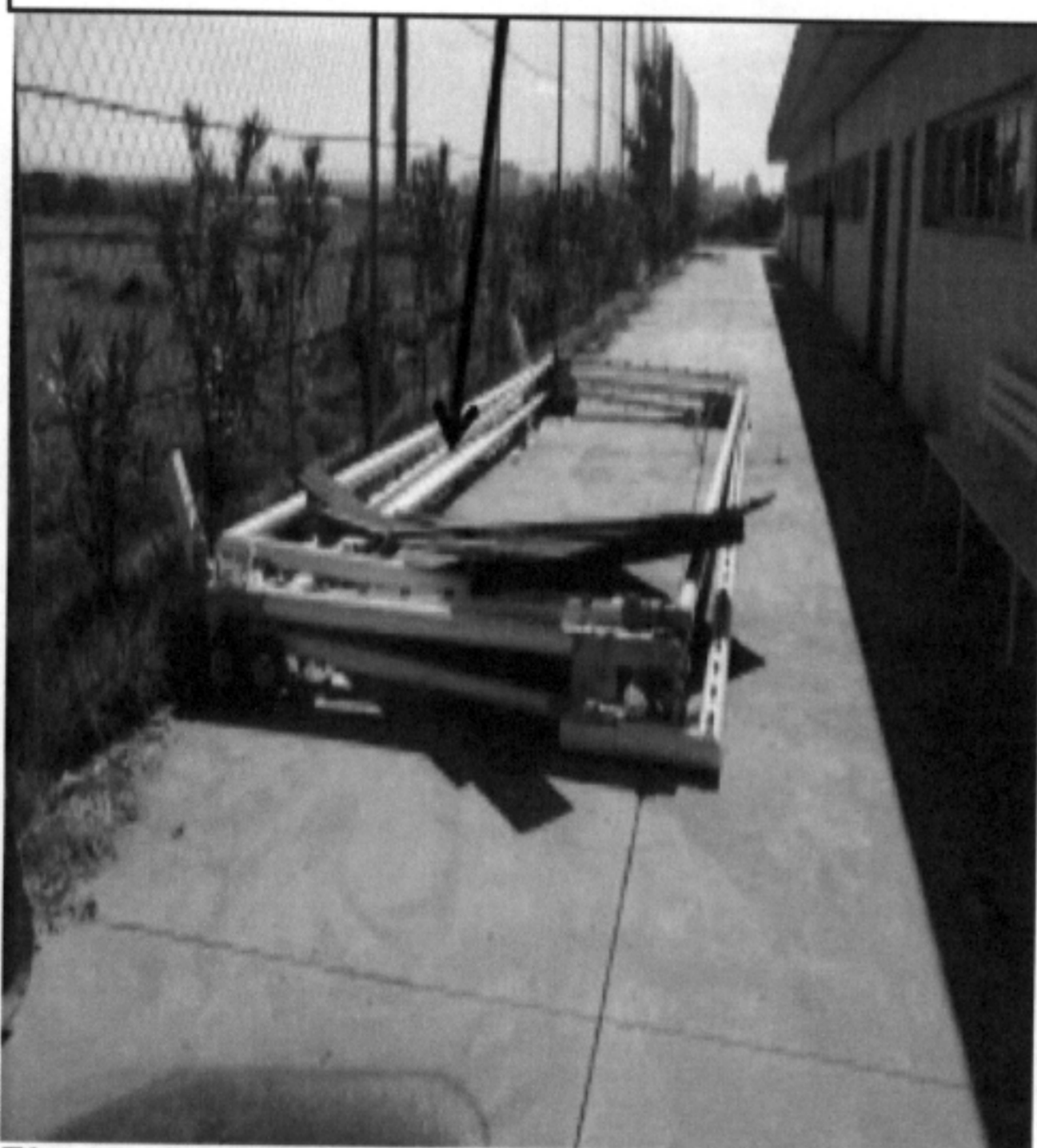
Figura 5 – materiais e equipamentos armazenados em local inadequado com os normativos técnicos.
