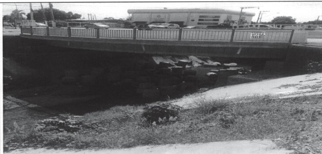
Figura 25: Remoção do resíduo de obra.
