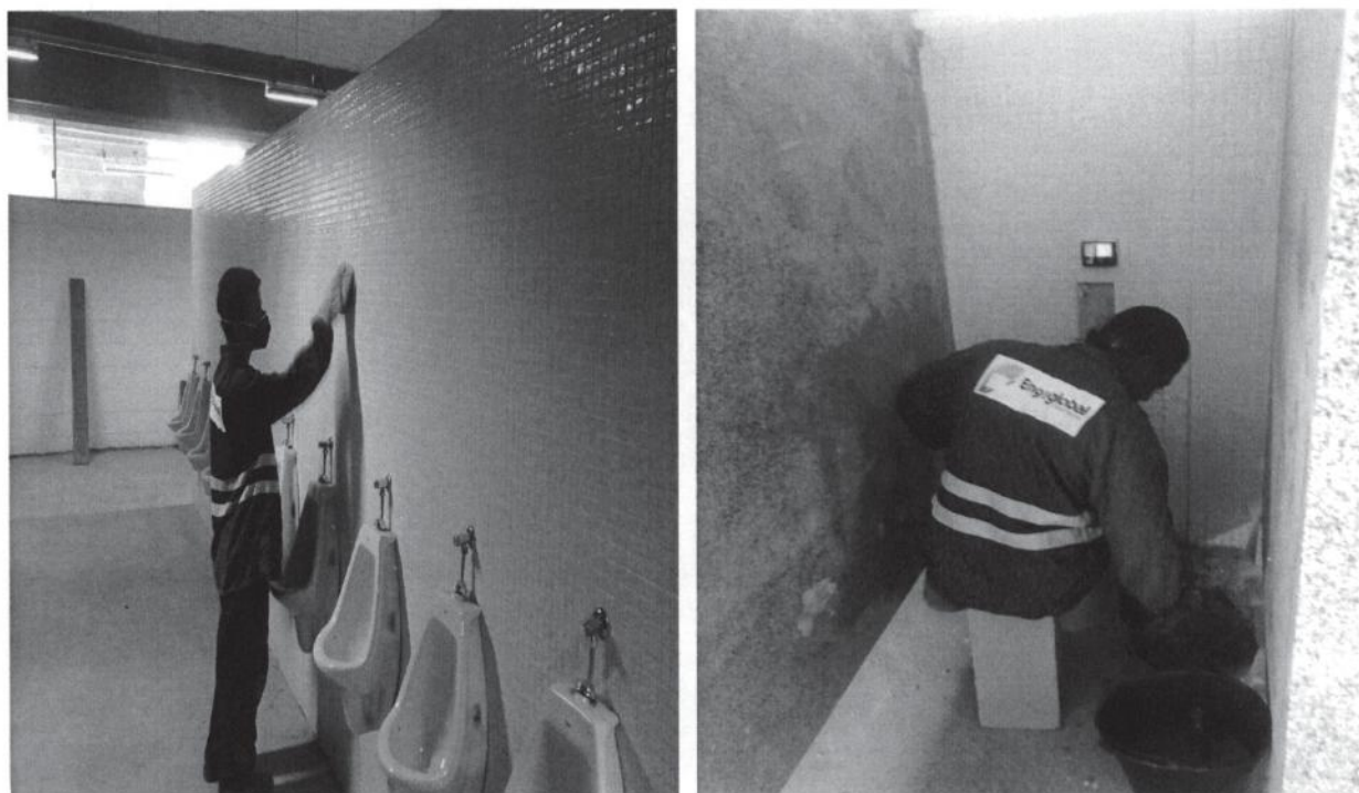
Figura 4 - execução dos serviços de louças e metais;
