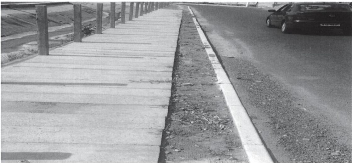
Figura 04 Conclusão da execução do passeio.
