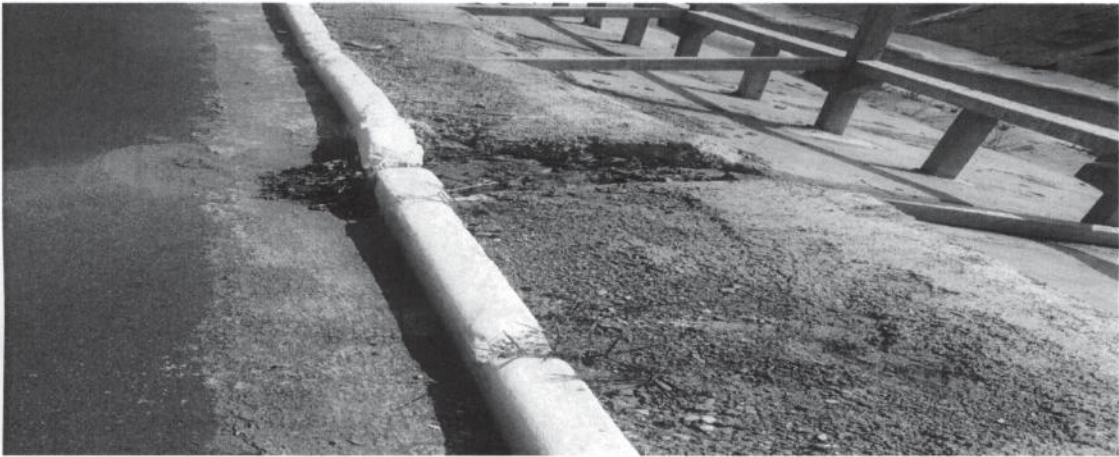
Figura 03: Conclusão da execução do passeio.
