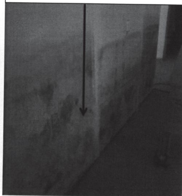
Figura 2 - Parede em Dry-wall danificadas devido à falta de manutenção sofrendo ação do vento e das intempéries, sendo assim, em inconformidade com os normativos técnicos:
