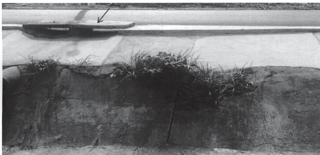
Figura 09: Tampa em desnível com o passeio.
