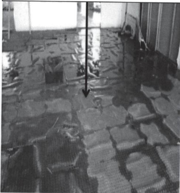
Figura 3 – Piso de borracha em inconformidade em decorrência da queda da parede e do forro de gesso e do acumulo de agua das intempéries;
