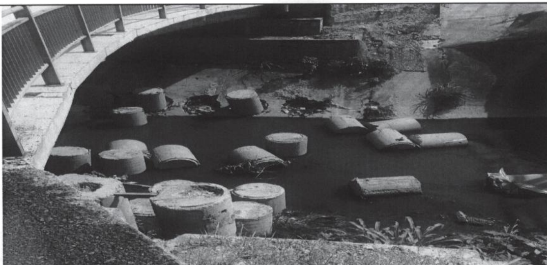
Figura 22: Remoção do resíduo de obra.
