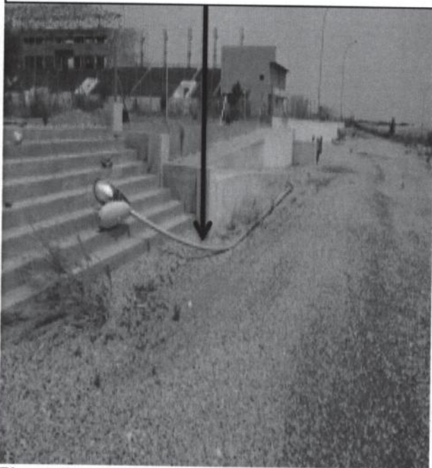
Figura 7 – serviços executados que se encontram danificados pela falta de manutenção e ação de vândalos, ocasionados pela falta de uma equipe de manutenção no canteiro e de segurança na obra;
