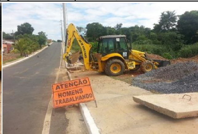
Fig. 10 - Escavação BLD finalizada, Tubulação pronta aguardando os blocos para construção da boca de lobo;
