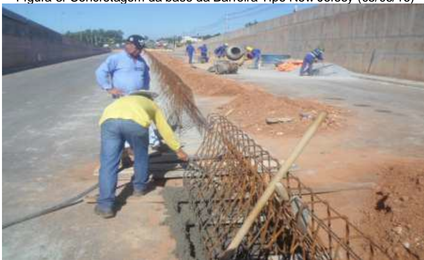
Figura 3: Concretagem da base da Barreira Tipo New Jersey (05/05/16)
