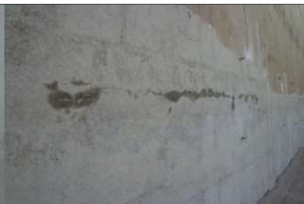
Fig. 12 - Bicos injetores já fixados e o PU foi injetado. A empresa deverá grautiar os furos e lixar a parede
