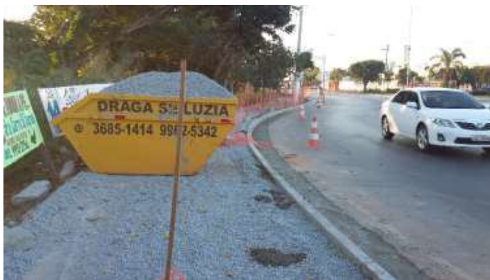
Foto 4.04 – Regularização para concretagem de calçada.
