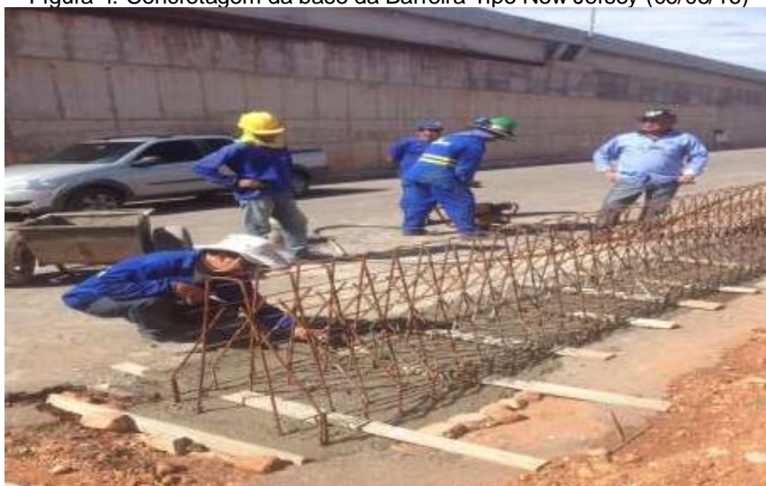
Figura 4: Concretagem da base da Barreira Tipo New Jersey (06/05/16)
