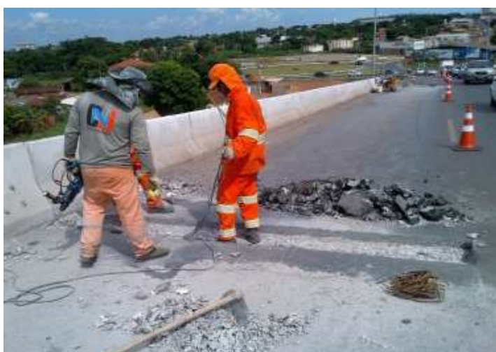
Foto 5.03 – Execução de furos nas peças de concreto para “colagem” da armadura.
