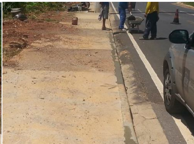
Fig. 2 -21/03/2016 - Os serviços realizados até esta data foram correção das calçadas e meio fios;
