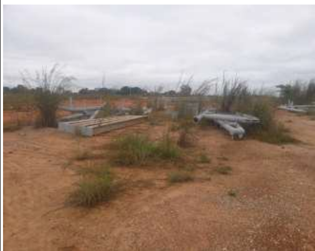
Estrutura metálica – estrutura da cobertura das arquibancadas esta armazenada nas imediações da obra, o que possibilita furtos;
