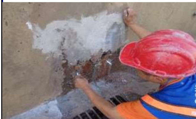
Fig. 13 - Colaborador da El Condor, fazendo o furo para fixação do bico injetor
