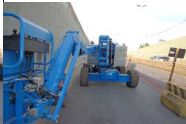
Fig. 14 - Parede da trincheira, onde irá fazer a injeção de PU para conter as infiltrações
