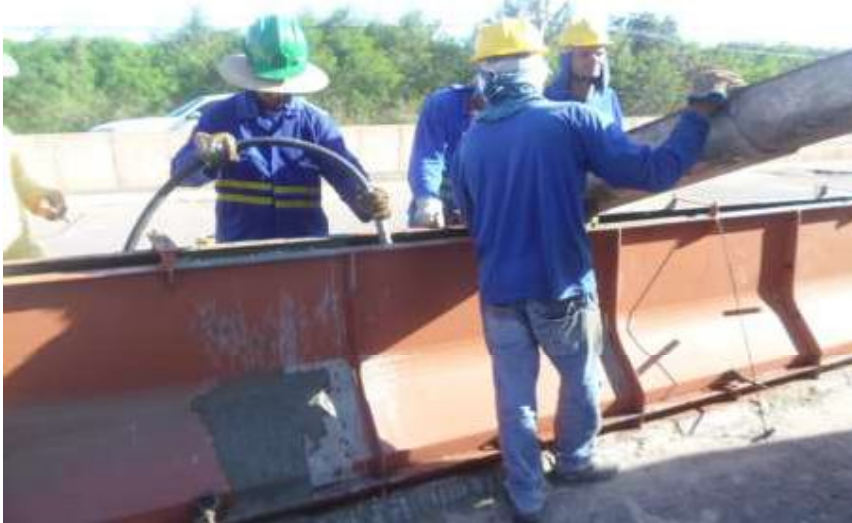
Figura 6: Concretagem da Barreira Tipo New Jersey (20/05/16)
