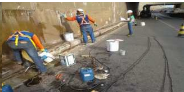
Fig. 4 - Colaborador da empresa El Condor com EPI para a injeção do PU
