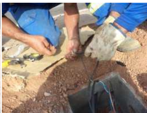
Figura 38- Colocação conector
