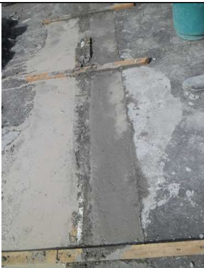
Foto 5.06 Concretagem com graute.
