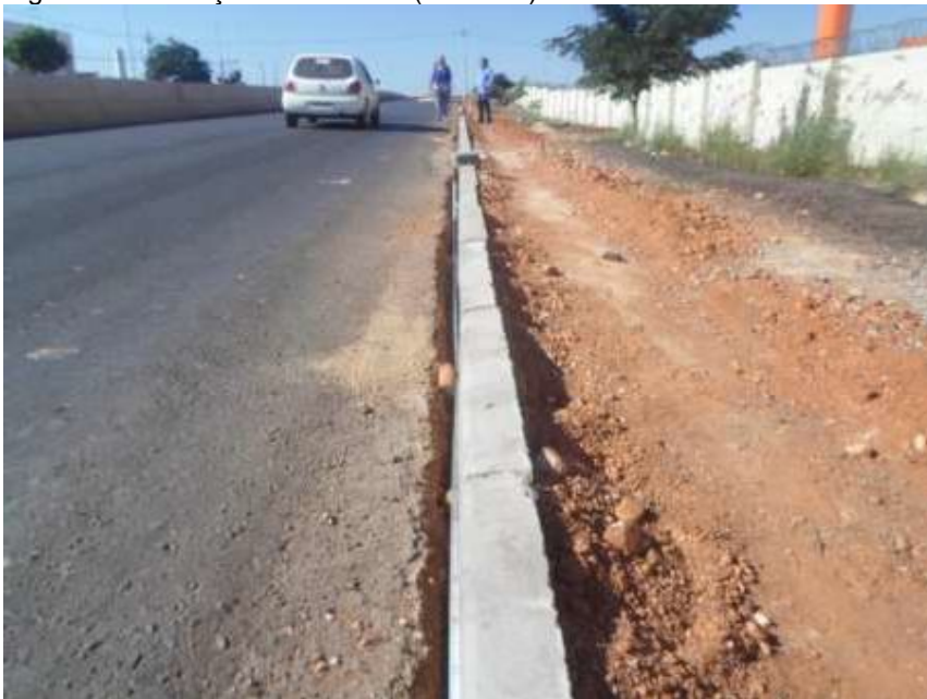
Figura 14: Execução de Meio Fio (24/05/16)
