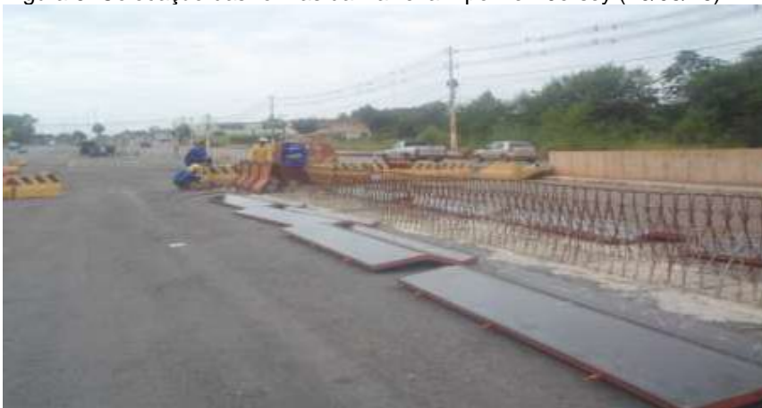
Figura 5: Colocação das formas da Barreira Tipo New Jersey (10/05/16)
