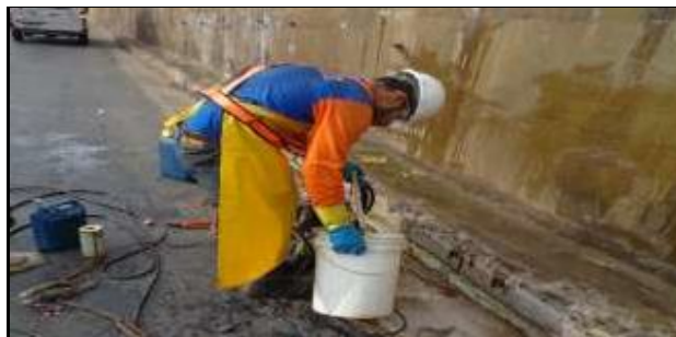
Fig. 3 - Colaborador da empresa El Condor com EPI para a injeção do PU
