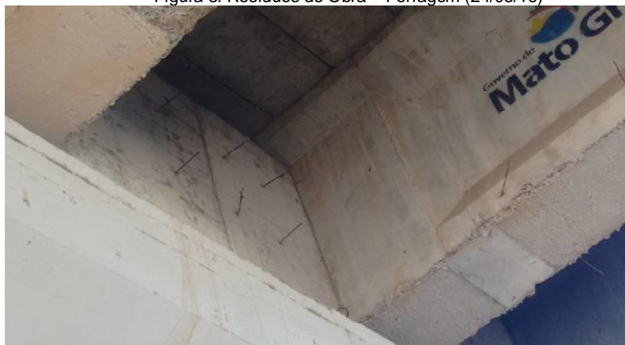
Figura 8: Resíduos de Obra – Ferragem (24/03/16)
