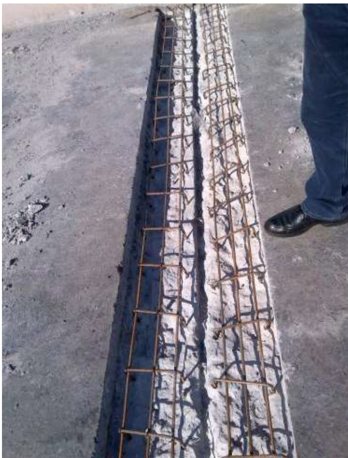
Foto 5.04 – Consolidação da armadura na peça de concreto com adesivo epóxi.
