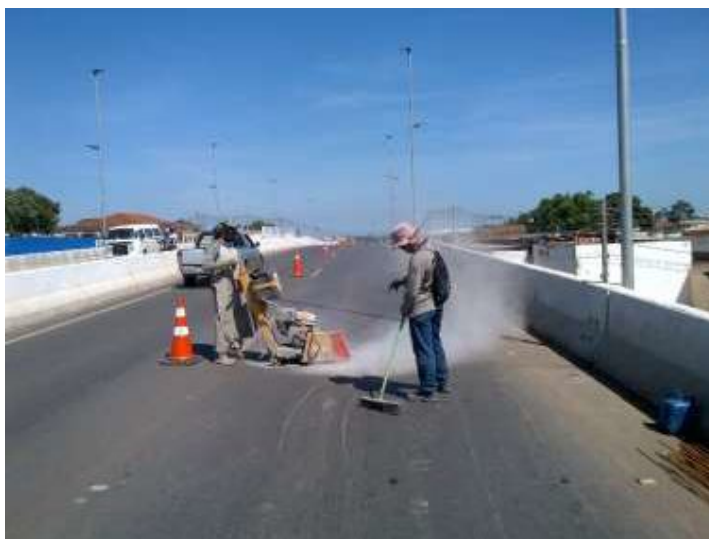
Foto 5.01 – Corte da capa asfáltica.
