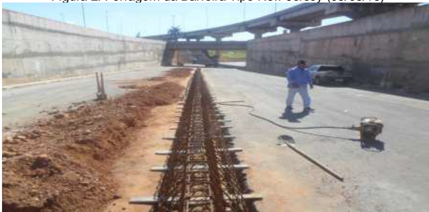
Figura 2: Ferragem da Barreira Tipo New Jersey (05/05/16)
