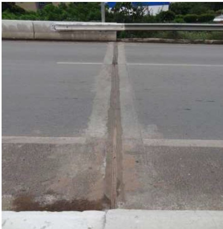
Foto 4.08 – Junta Jeene em boas condições de funcionamento (Foto atual).
