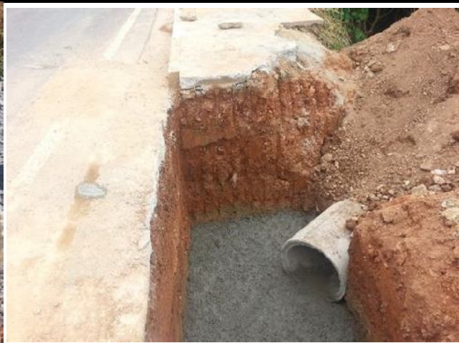
Fig. 10 - Escavação BLD finalizada, Tubulação pronta aguardando os blocos para construção da boca de lobo;
