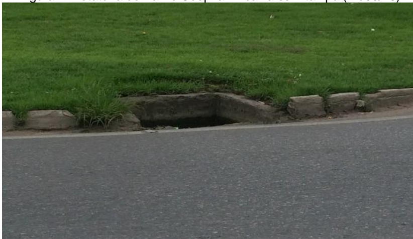
Figura 2: Rotatória do Bairro Coophamil caixa sem tampa (24/03/16)
