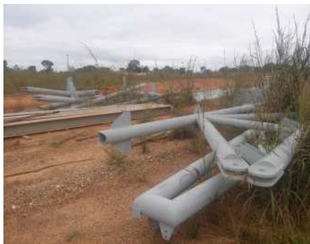
Estrutura metálica – estrutura da cobertura das arquibancadas esta armazenada nas imediações da obra, o que possibilita furtos;
