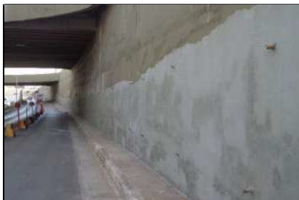
Fig. 11 - Bicos injetores já fixados e o PU foi injetado. A empresa deverá grautiar os furos e lixar a parede
