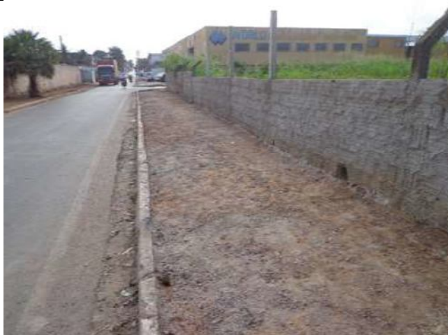
Fig. 11 - Local pronto para concretar a calçada na Rua Joaquim Murтинho
