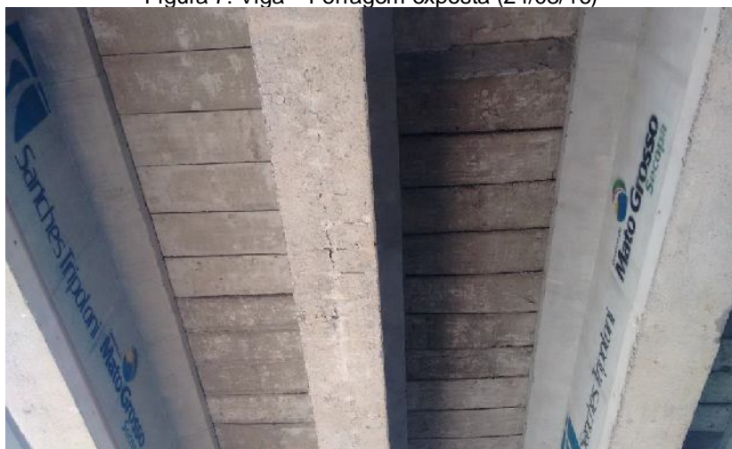
Figura 7: Viga – Ferragem exposta (24/03/16)
