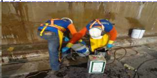
Fig. 6 - Colaborador da empresa El Condor com EPI para a injeção do PU
