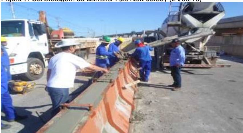
Figura 7: Concretagem da Barreira Tipo New Jersey (24/05/16)
