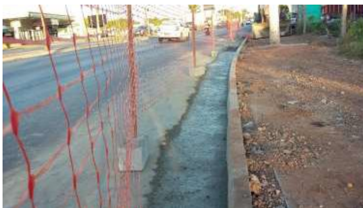
Foto 4.03 Execução de Meio Fio/Sarjeta MFC-01.
