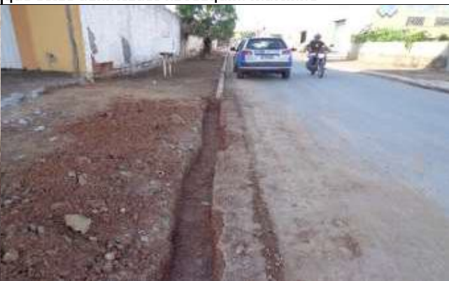
Fig. 4 - Retirada do meio-fio para realinhamento e troca dos que estão danificados na Joaquim Murтинho
