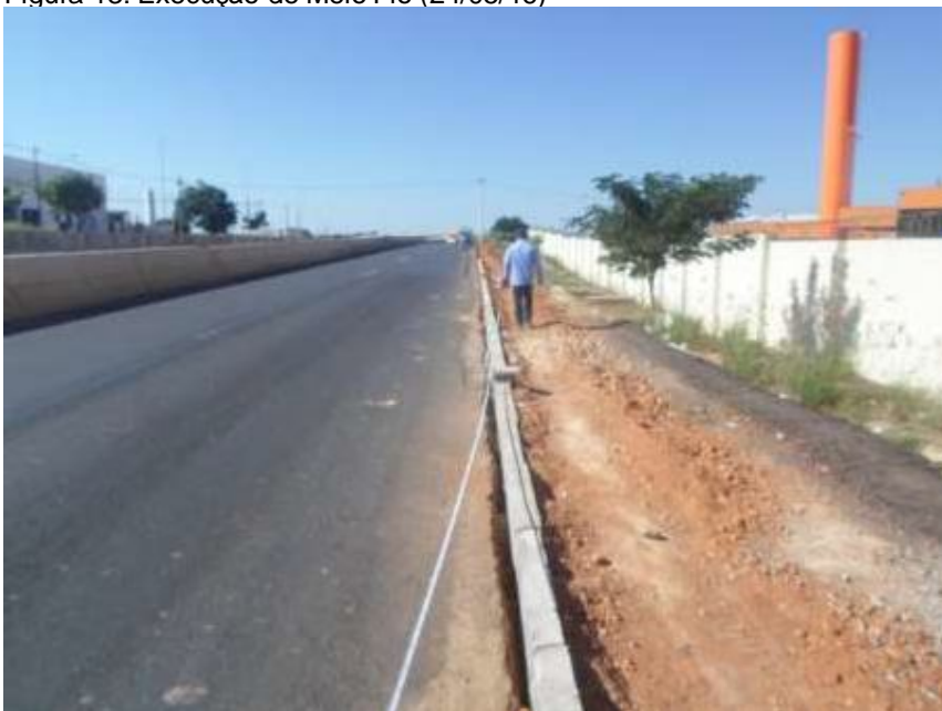
Figura 13: Execução de Meio Fio (24/05/16)
