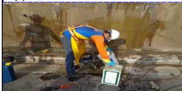
Fig. 5 - Colaborador da empresa El Condor com EPI para a injeção do PU
