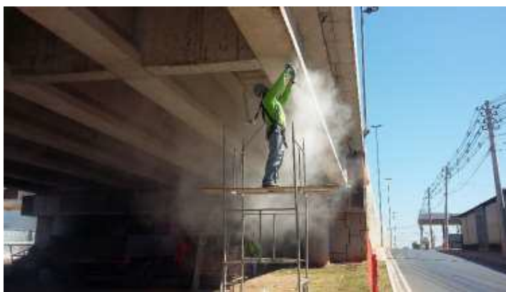
Foto 4.01 – Correção/Retificação da superfície das Vigas Longarinas.
