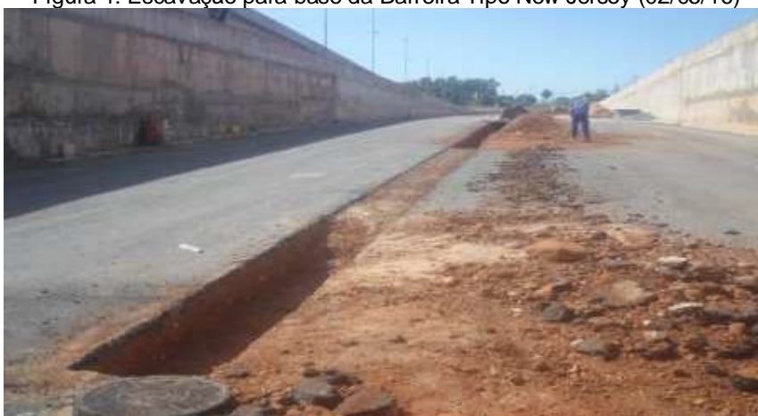
Figura 1: Escavação para base da Barreira Tipo New Jersey (02/05/16)
