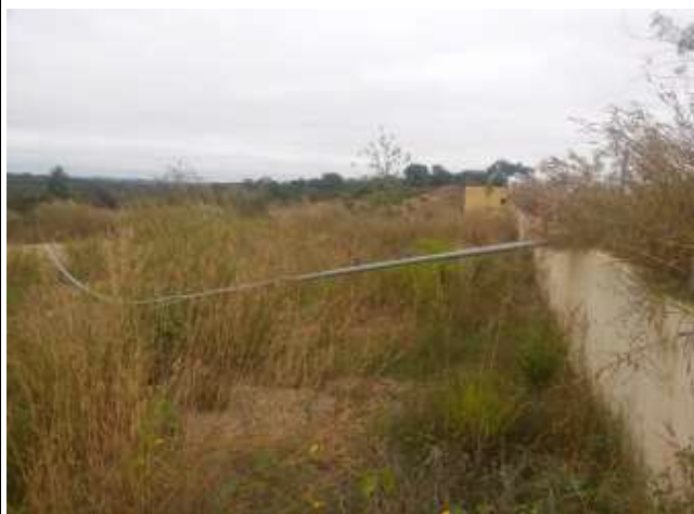
Instalações Elétricas · Postes de iluminação do estacionamento foram derrubados, sendo suas luminárias furtadas, quadros elétricos do prédio foram furtados;
