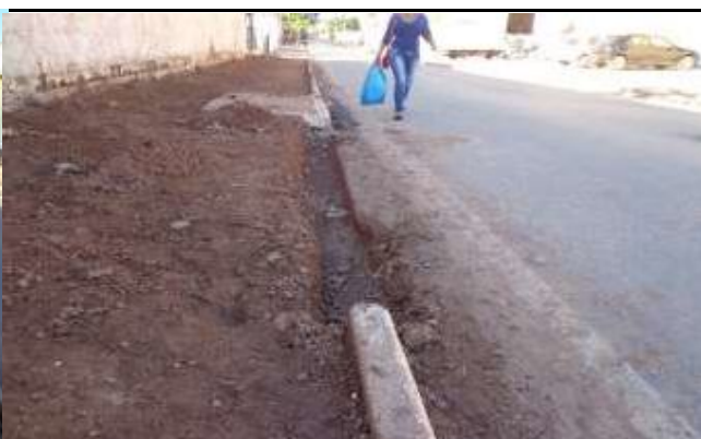
Fig. 2 - Retirada do meio-fio para realinhamento e troca dos que estão danificados na Joaquim Murтинho
