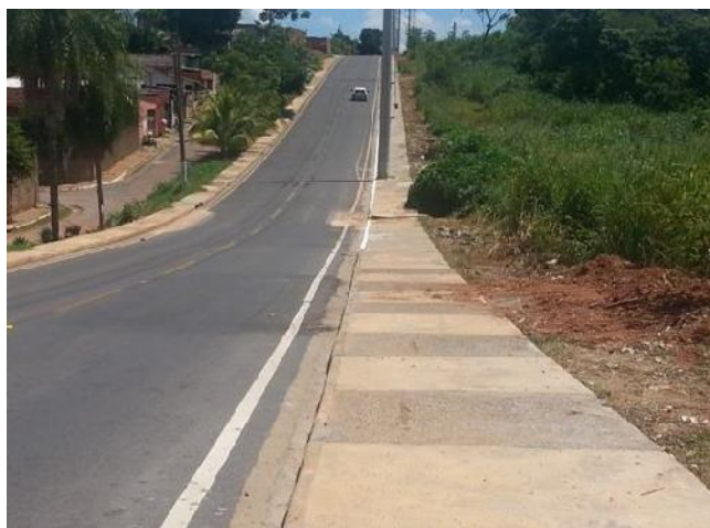
Fig. 1 -21/03/2016 - Os serviços realizados até esta data foram correção das calçadas e meio fios;
