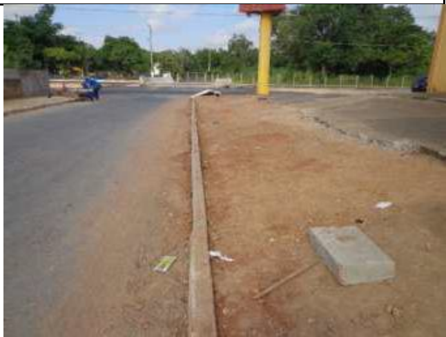
Fig. 2 - Local pronto para a calçada ser concretada na Rua Joaquim Murтинho
