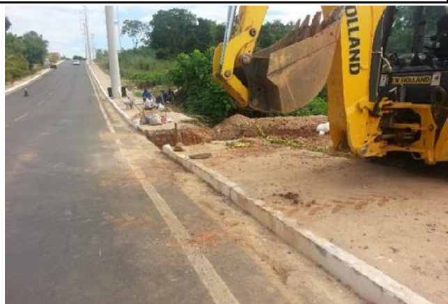
Fig. 9- 24/03/2016 - Tubulação de drenagem - ligação de BLD estaca 20+10,00 Le, finalizada;
