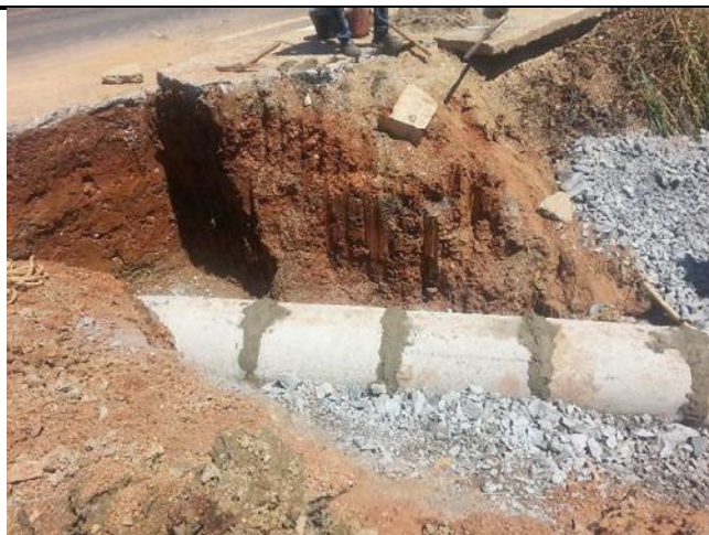
Fig. 9- 24/03/2016 - Tubulação de drenagem - ligação de BLD estaca 20+10,00 Le, finalizada;
