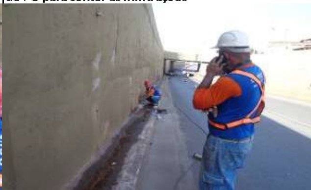
Fig. 14 - Colaborador da El Condor, fazendo o furo para fixação do bico injetor
