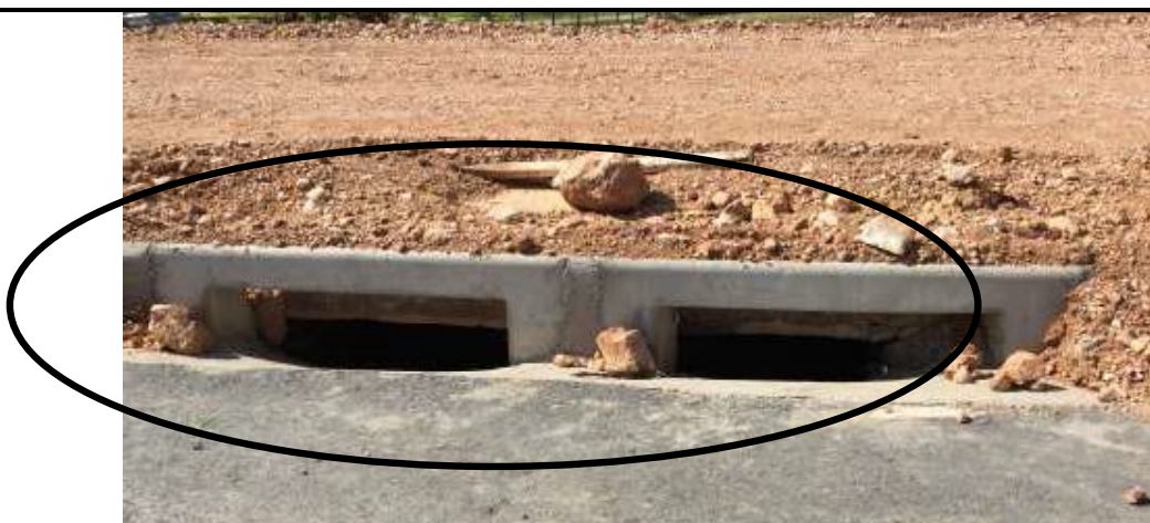
Figura 1- Detalhe da boca de lobo executada sem a grelha de concreto.
