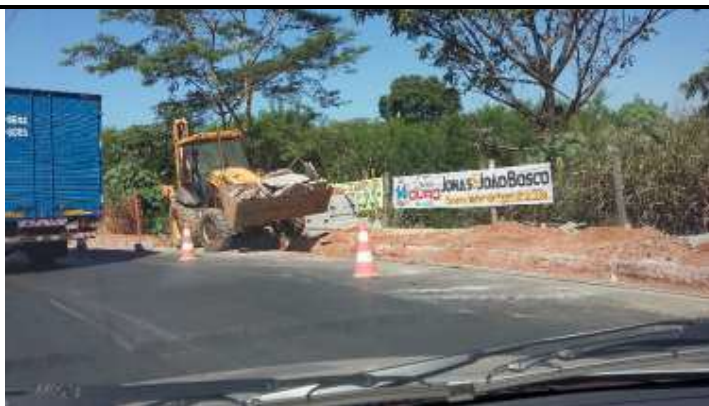
Foto 4.02 – Remoção de meios fios e sarjetas demolidos.
