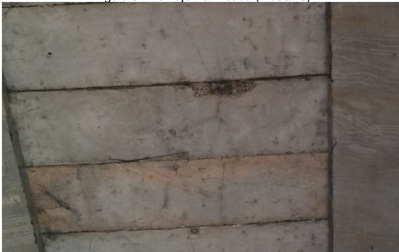
Figura 5: Pré-Laje Danificada (24/03/16)
