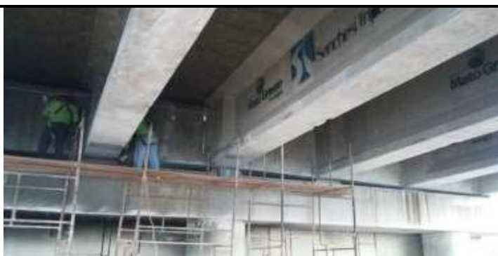
Foto 4.05 Correção de Patologias (nichos de concretagem) na Superestrutura do Viaduto Dom Orlando Chaves.
