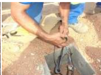
Figura 35-Fita isolante
