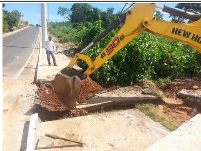
Fig. 4 - 22/03/2016 - Início da escavação para construção da BLD na estaca 29+10,00 Le;
