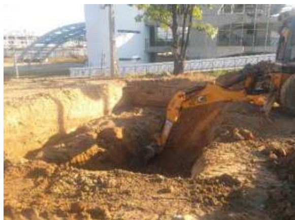
Fig. 07 – Escavação da cisterna.
