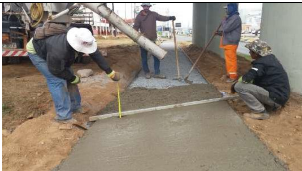
Foto 3.03 Execução de Calçada na Av. da FEB.
