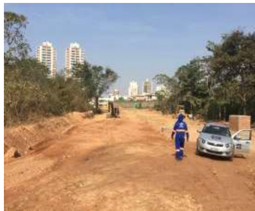
Fig.2 Lado Direito - Início dos Serviços de terreaplenagem.
