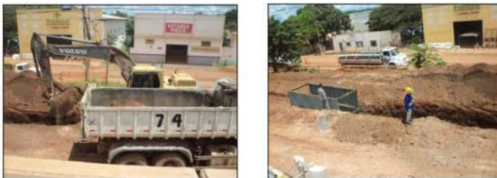
Figura 3: escavação e escoramento metálico
