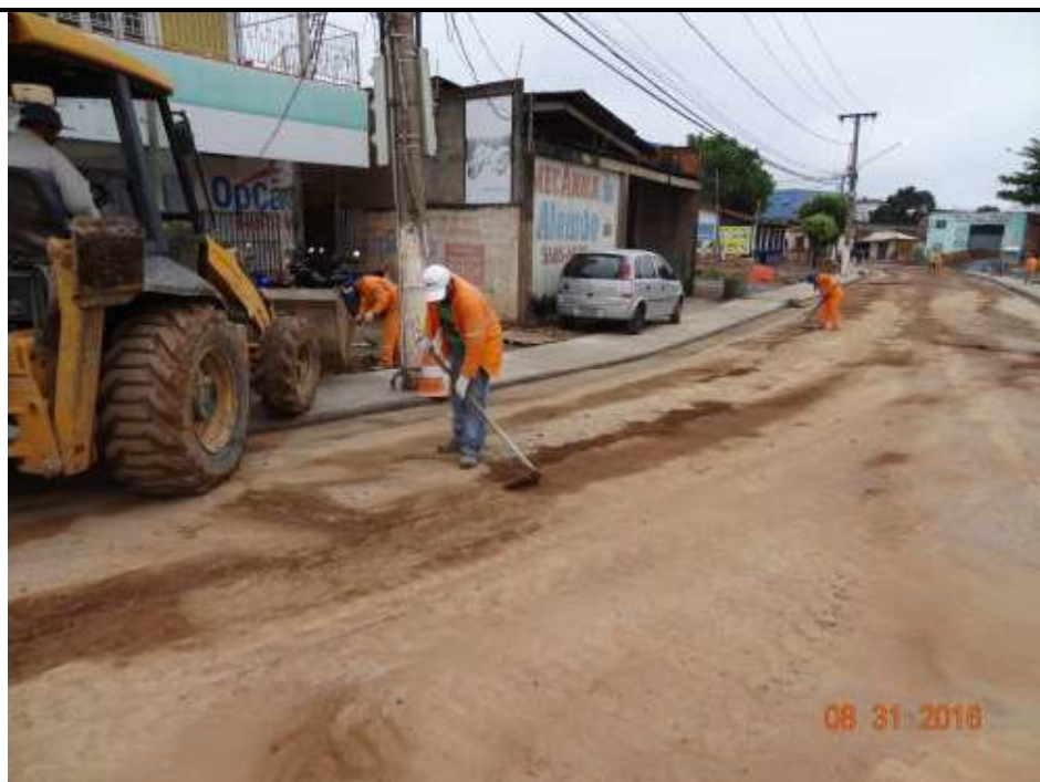
Foto 3.05 Limpeza e remoção de material do pavimento da Av. Dom Orlando Chaves.
