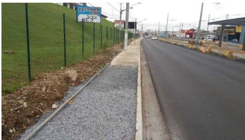
Foto 3.02 – Execução de Lastro de brita e Calçada na Av. da FEB.
