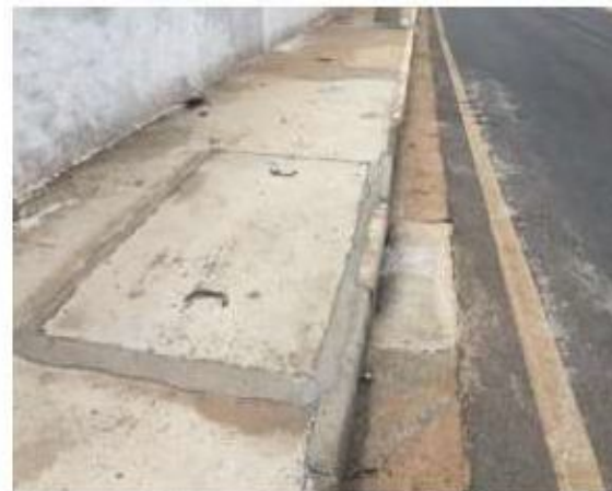
Fig. 14 - Acabamento da tampa da BL com papelão imerso no concreto; (DEPOIS)
