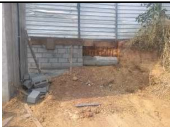
Fig. 05 – Boca de lobo 01.
