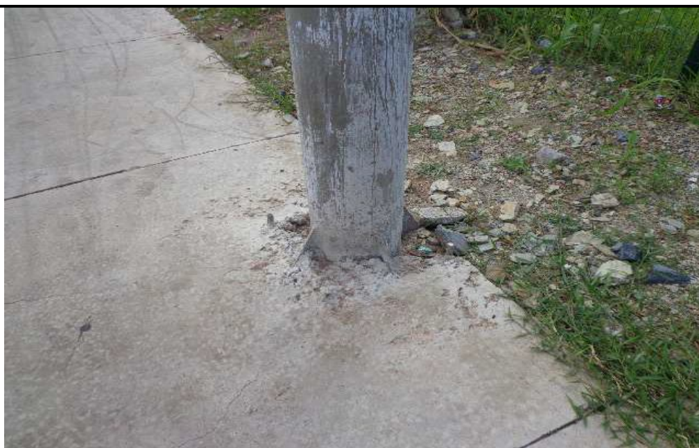
Foto 3.6 Fundação da bandeira metálica na Av. da FEB ( estaca 0 + 540 ).
