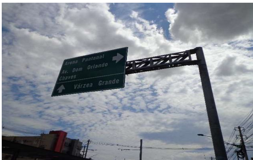
Foto 3.3 Bandeira metálica e placa sinalizadora na Av. da FEB ( estaca 0 + 540 ).
