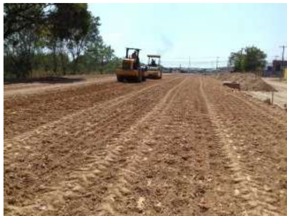
Fig.1 Finalização dos Serviços Terreaplenagem do Lado Esquerdo
