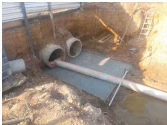
Fig. 02 – Lastro da caixa de inspeção.
