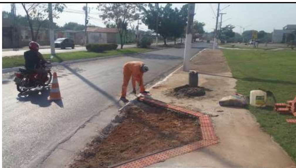
Foto 3.05 – Execução de piso tátil para sinalização das rampas de acessibilidade.
