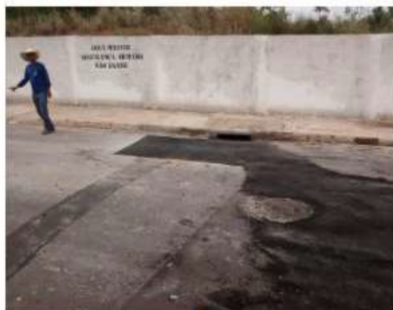
Fig. 18 - Trinca na capa asfáltica; (DEPOIS)
