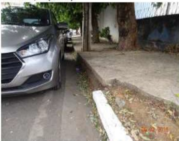
Fig. 4 - Meio fio não executado; (ANTES)
