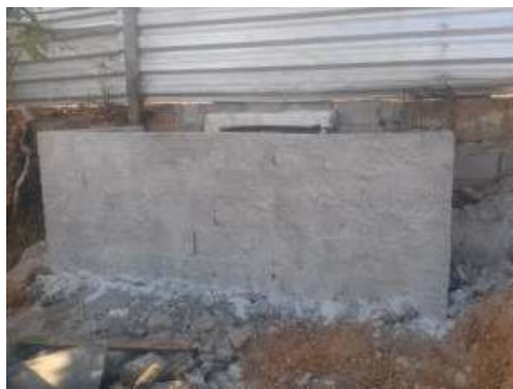
Fig. 04 – Boca de lobo 01.
