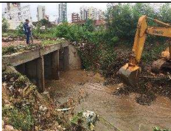
Fig. 03 – Limpeza do canal do córrego.
