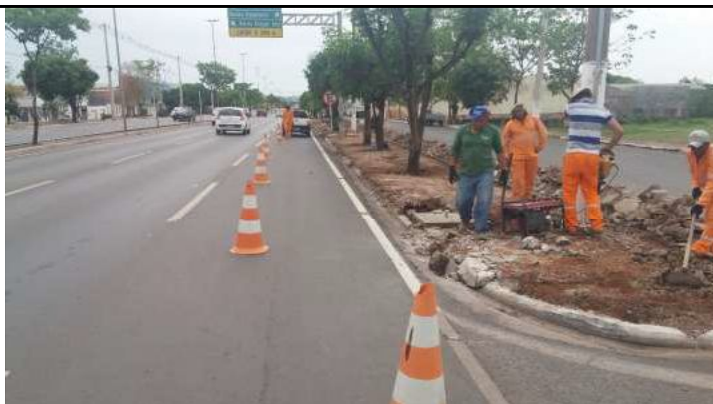
Foto 3.07 Arrancamento e remoção de meio fio e calçada deteriorados na Av. Miguel Sutil.
