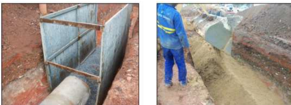
Figura 2: escalonamento da escavação e escoramento metálico
