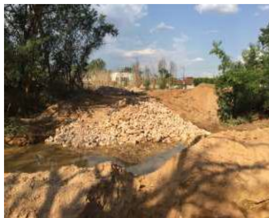
Fig. 4 Execução do enrocamento na fundação para posterior ex concreto.
