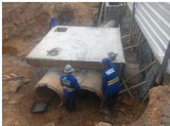
Fig. 01 – Caixa de inspeção.
