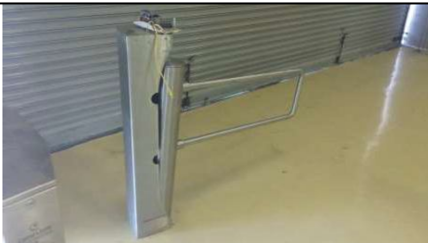
Registro 4. Catraca para portadores de necessidades especiais (PNE) com braço horizontal danificado e sem variogate, setor Sul.
