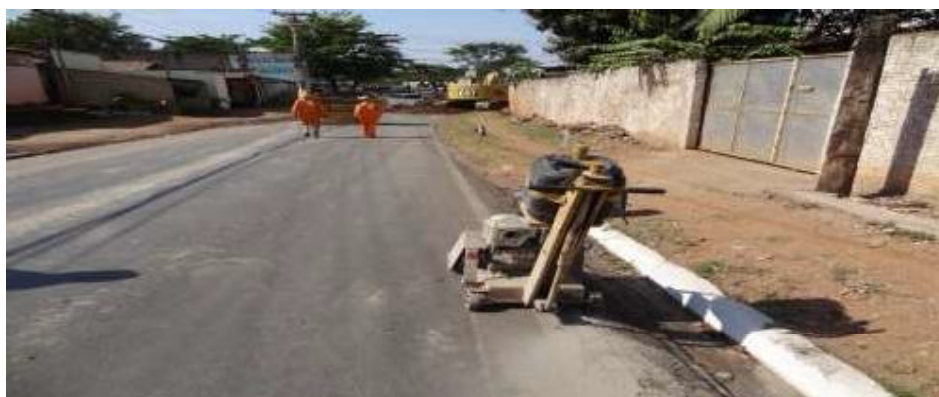
Foto 3.04 – Corte no pavimento para remoção de sarjeta na Av. Dom Orlando Chaves.
