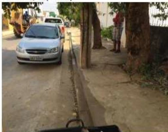
Fig. 4 - Meio fio executado; (DEPOIS)
