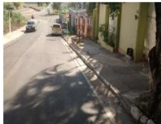
Fig. 31 - Meio fio e sarjeta danificados; (DEPOIS)
