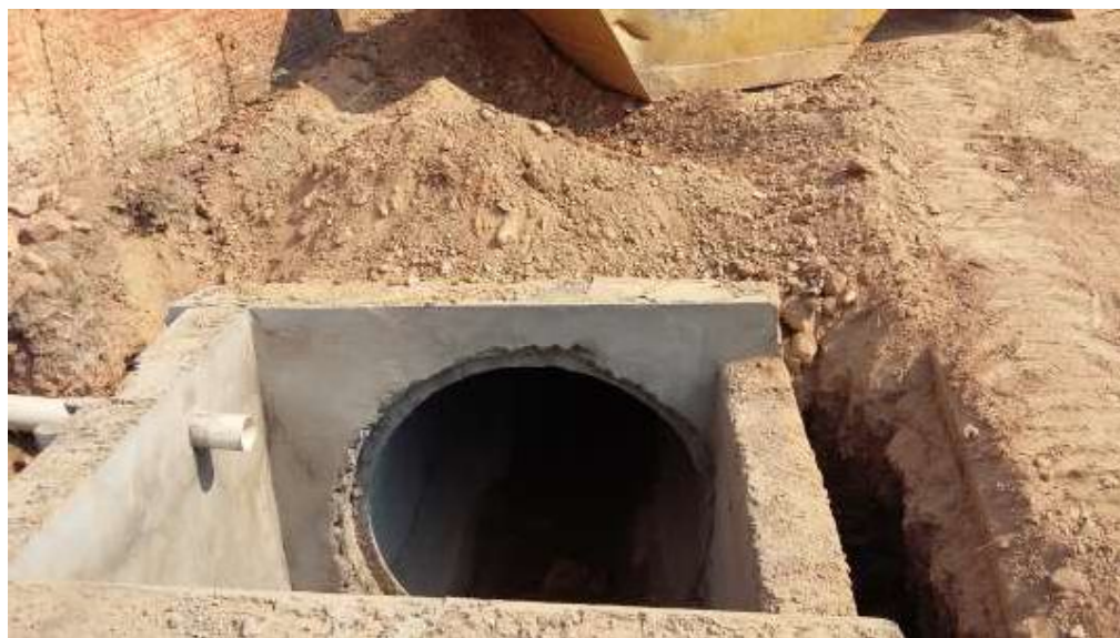
Foto 3.05 · Execução de Caixa de ligação e passagem na Av. Dom Orlando Chaves.
