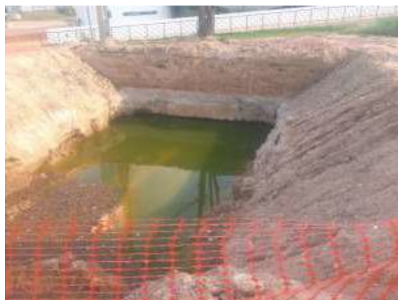
Fig. 08 – Escavação da cisterna.
