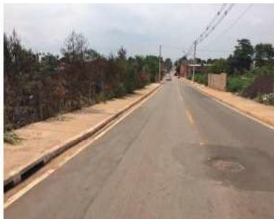
Fig. 23 - Boca de lobo; (DEPOIS)
