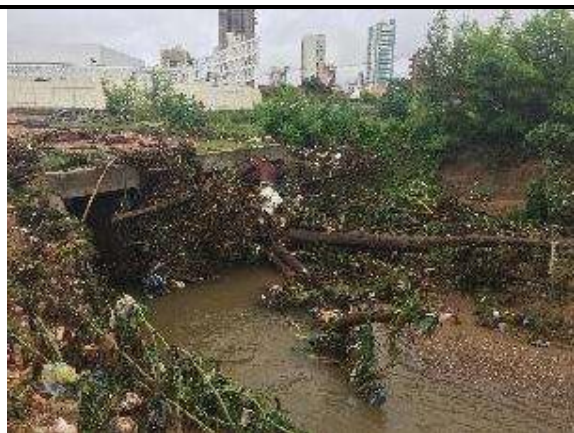
Fig. 02 Obstrução do canal do córrego.
