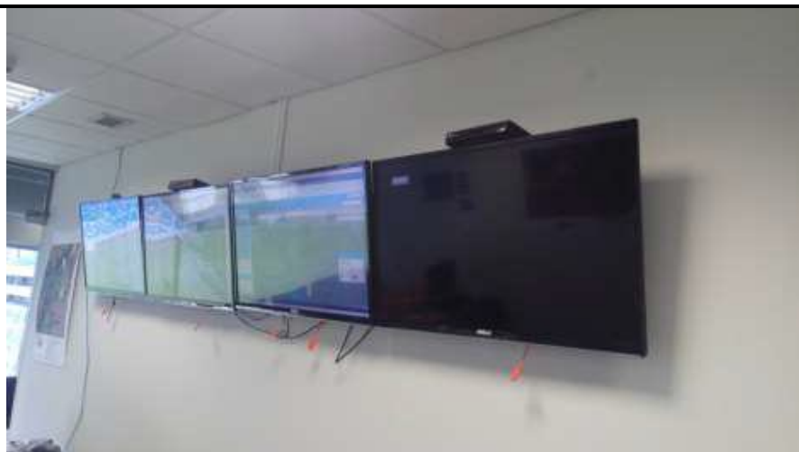
Registro 3. Camarote 320 do Setor Sul, Nível 30, com televisores instalados a mais. Relocados de outros ambientes.
