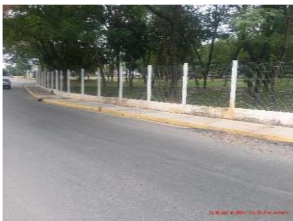
Fig. 08 Muro limitrofe da Universidade Federal
