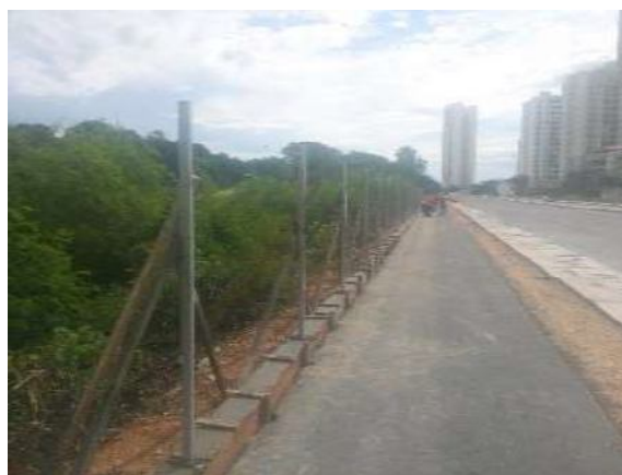
Fig. 06 – Cerca de fechamento com painéis galvanizados, h = 2,00 m.
