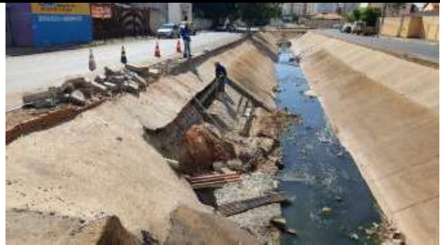
Fig. 02 Serviço de recuperação do canal
