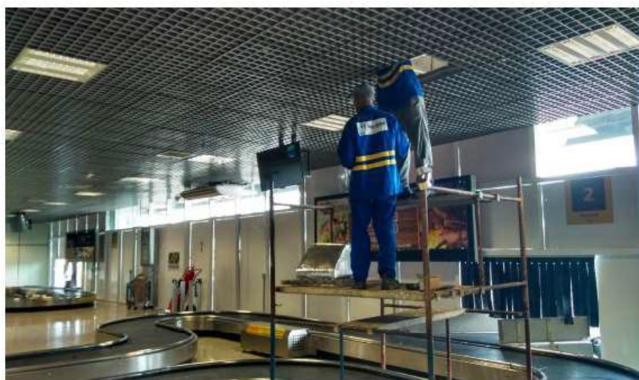
Foto 05: Instalação das grelhas e dampers do sistema de ar condicionado na sala de Embarque Remoto e Desembarque Domestico.
