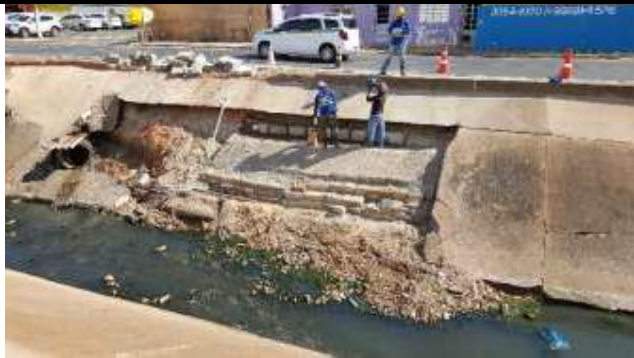
Fig. 01 Serviço de recuperação do canal
