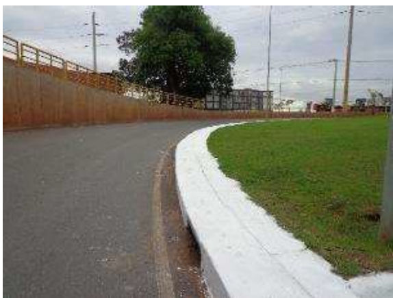
Figura 19. Pintura das canaletas concluída
