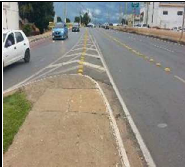
Figura 1 - Tachão colocado no centro do Zebrado;
