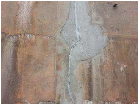
Figura 09. Reparo das juntas de dilatação
