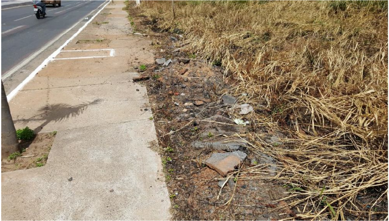
Fig. 10 – Resíduos de CBUQ, provenientes dos reparos realizados no pavimento.
