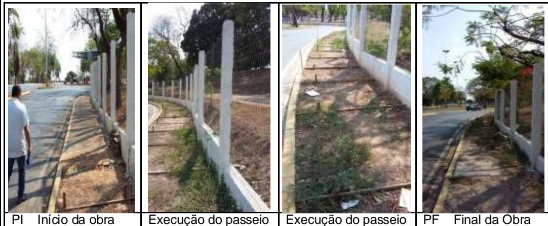
Figura 01 Relatório fotográfico da vistoria realizada em 27/10/2015.
