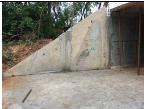
Fig. 03 Concretagem da Boca da Galeria.
