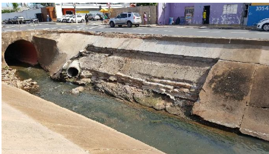
Fig. 01 – Conclusão do serviço de recuperação do canal
