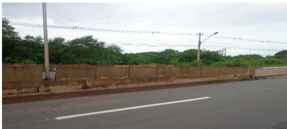
Foto 3.1 – Guarda-corpo tipo New Jersey.
