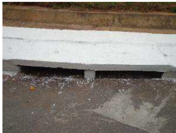
Figura 16. Pintura das canaletas concluída
