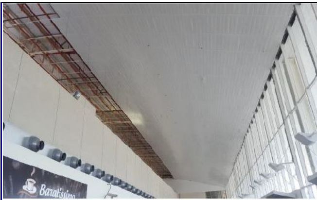
FOTO 03: Instalação de Forro Perfurado no sagão de Desembarque
