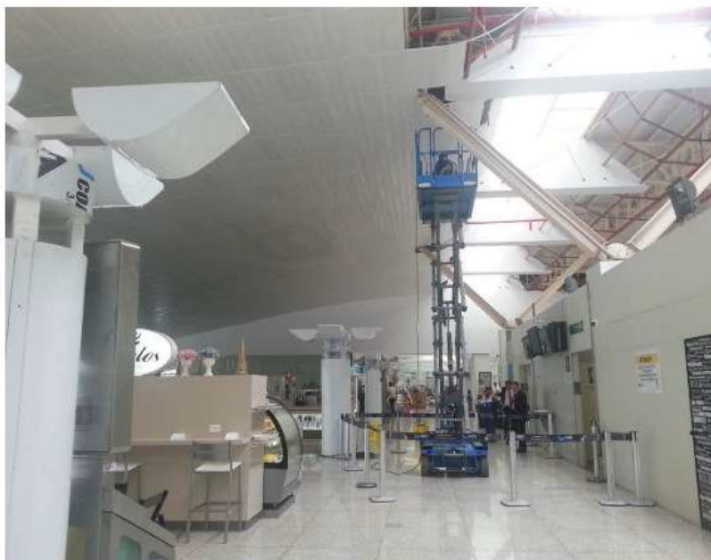
Foto 01: Instalação de forro metálico chapa perfurada (eixo 03 a 09 pavimento superior).
