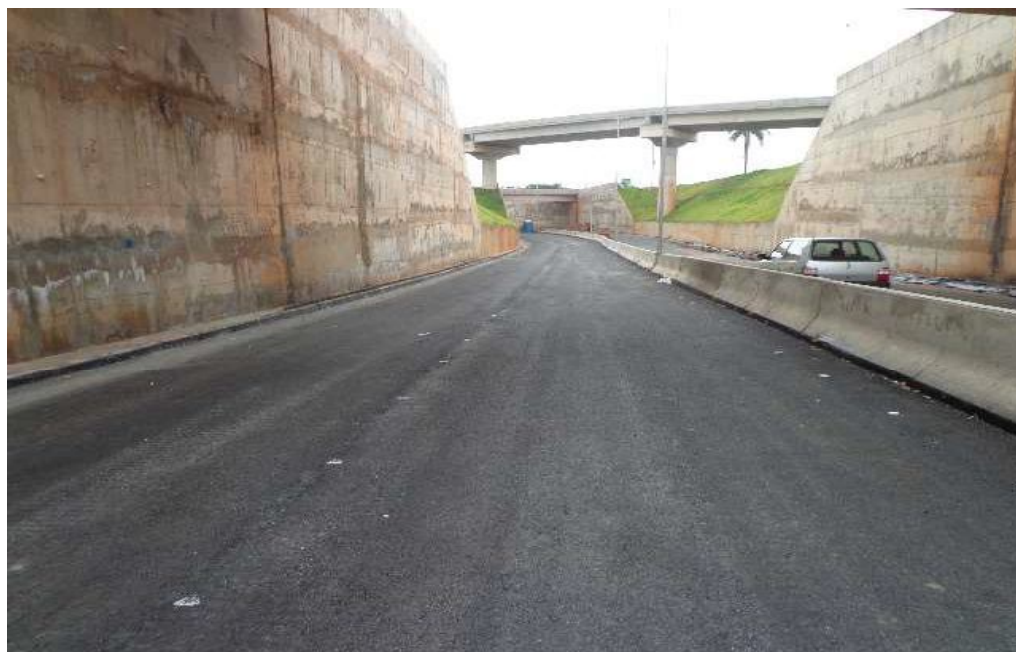
Foto 3.4 – Pavimentação asfáltica CBUQ.
