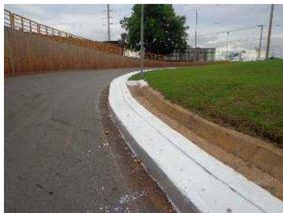
Figura 20. Pintura das canaletas concluída
