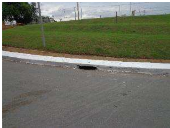
Figura 22. Pintura das canaletas concluída
