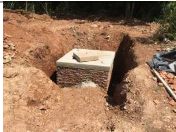
Fig. 06 – Recuperação caixa de ligação esgoto
