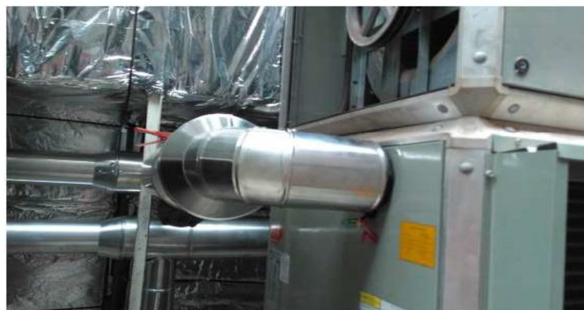
Foto 04: Execução do isolamento da rede de água gelada (Sala de climatização 03)
