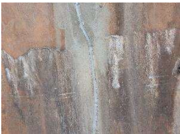
Figura 07. Reparo das juntas de dilatação
