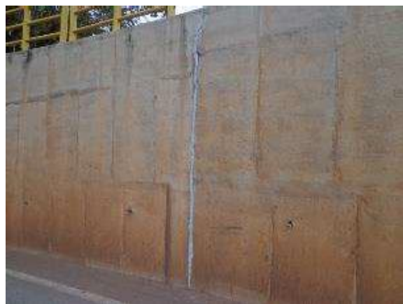
14. Reparo das juntas concluído
