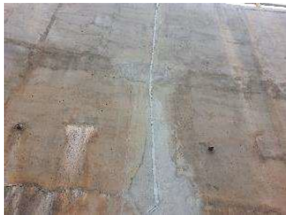
Figura 10. Reparo das juntas de dilatação
