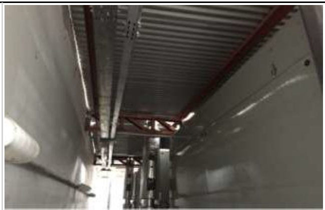
FOTO 08: Instalação de cobertura na Sala Térmica de Climatização.
