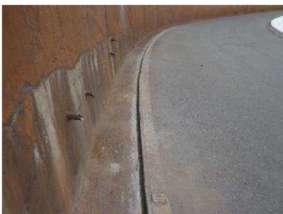
Figura 23. Construção da canaleta concluída
