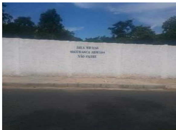
Fig. 13 Muro limítrofe com a Vila Militar
