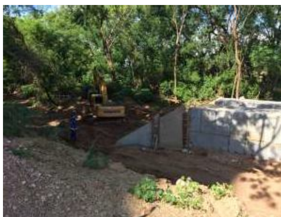
Fig. 01 Montagem Galerias- Alça Rotatória Brasília. Fig. 02 – Montagem das Alas (Boca da Galeria).
