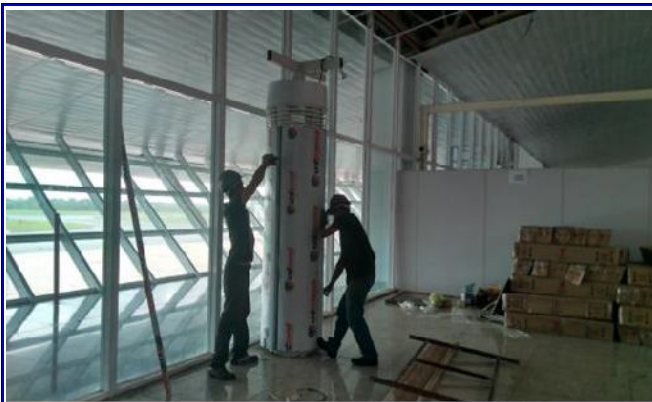
FOTO 05: Aplicação de Revestimentos nos Totens e Instalação de Luminárias
