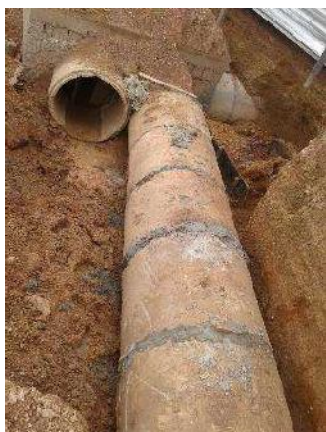
Fig. 03 Tubo de concreto drenagem D = 1000 mm.
