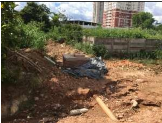
Fig. 05 Recuperação caixa de ligação esgoto e tubulação
