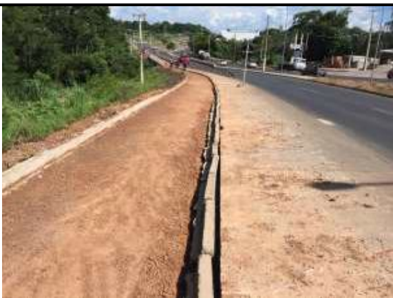
Figura 7 Recuperação da ciclovia.
