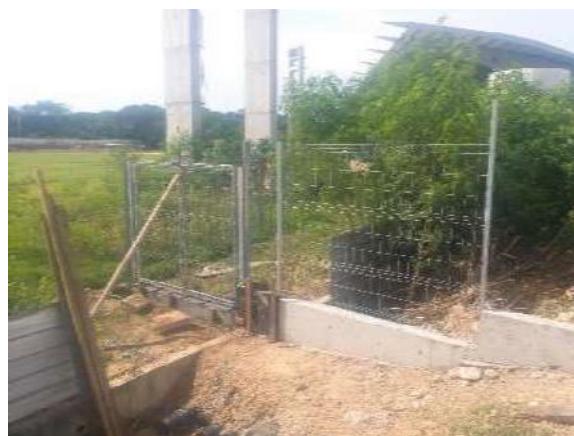
Fig. 08 - Cerca de fechamento com painéis galvanizados, h = 2,00 m.
