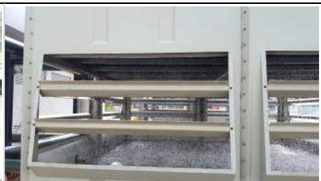
FOTO 04: Teste Hidráulico das Torres de Resfriamento.
