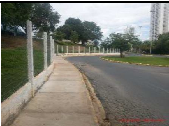
Fig. 05 Muro limitrofe da Universidade Federal
