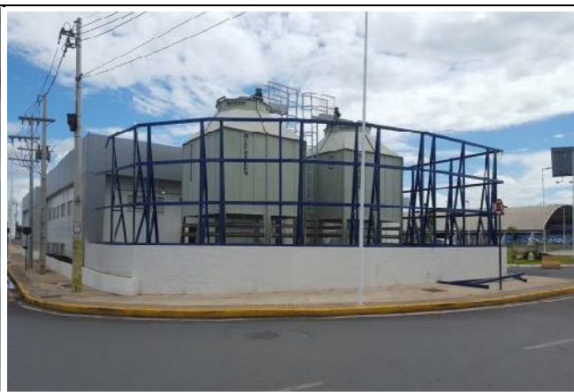
FOTO 12: Instalação do Brise da CAG - Central de água Gelada.
