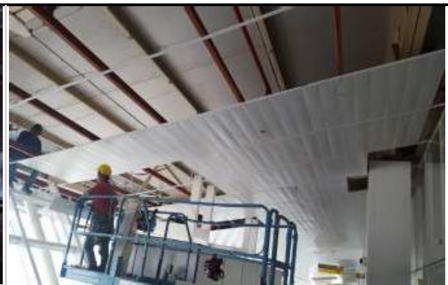
FOTO 02: Instalação de forro do Corredor de embarque e Desembarque, Pav Superior.
