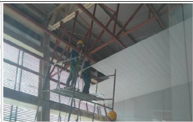
FOTO 04: Instalação de Forro Metálico Perfurado na área dos brises
