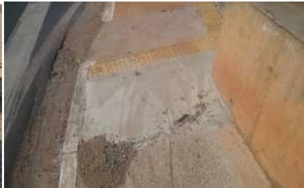
13. Tapa de boca-de-lobo dupla desnivelada - E486 LE (Imagens nº 87 a 89)
