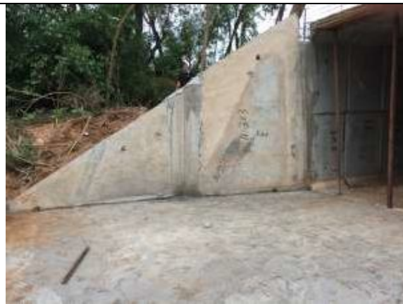
Fig. 01 Boca da galeria executada.
