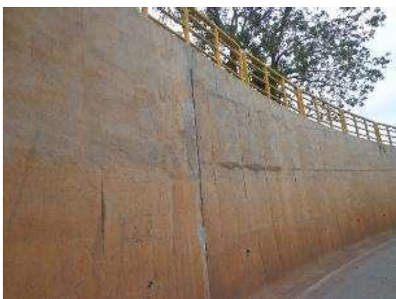
Figura 17. Reparo das juntas concluído
