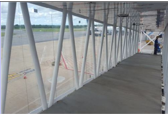
FOTO 11: Instalação do Túnel de Embarque 03
