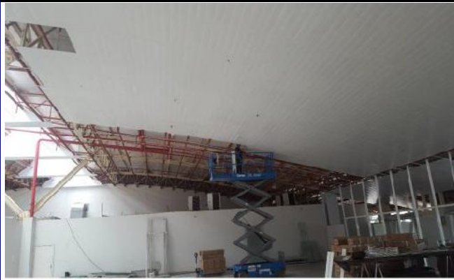
FOTO 07: Instalação de Forro no Pavimento Superior área do Embarque.
