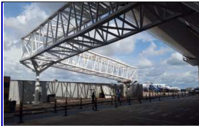
FOTO 01: Montagem da Estrutura metálica do conector do portão 03.
