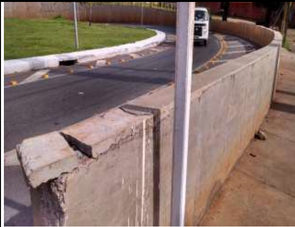
Figura 5 Reparo de concretagem não realizado – Estaca 22 +10,00;
