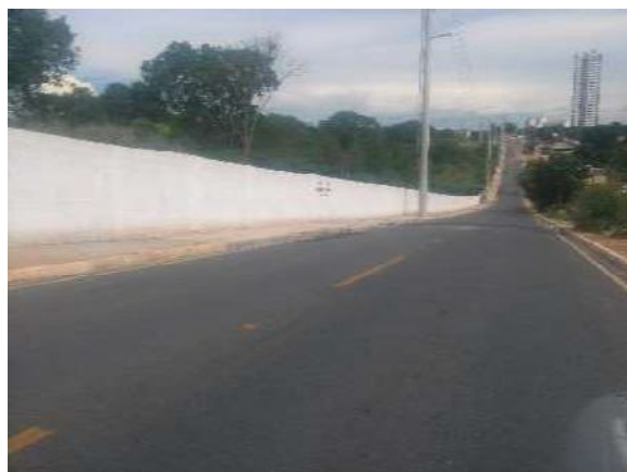
Fig. 12 – Muro limítrofe com a Vila Militar
