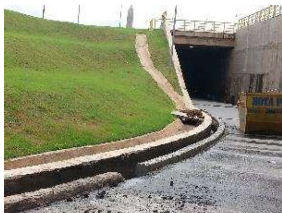
Figura 06. Recuperação da canaleta de drenagem
