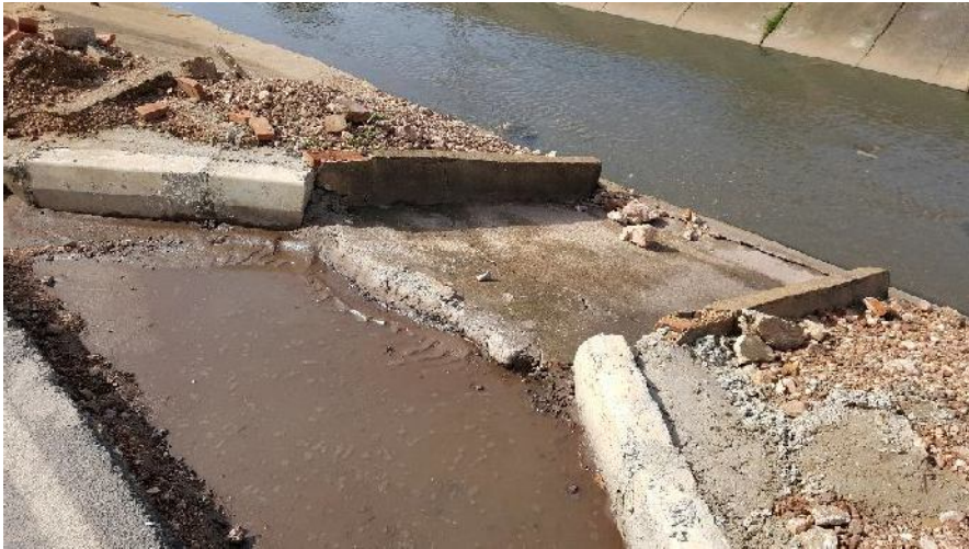
Fig. 03 – Execução dos serviços de entrada para as descidas d'águas – EDA
