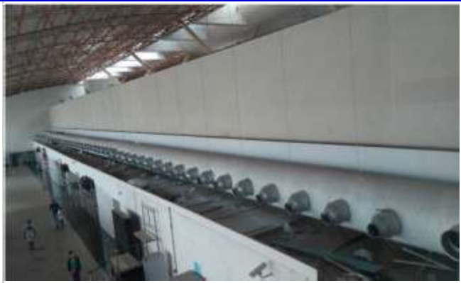
FOTO 06: Instalação dos Jet-noses no giroval no salão de desembarque.
