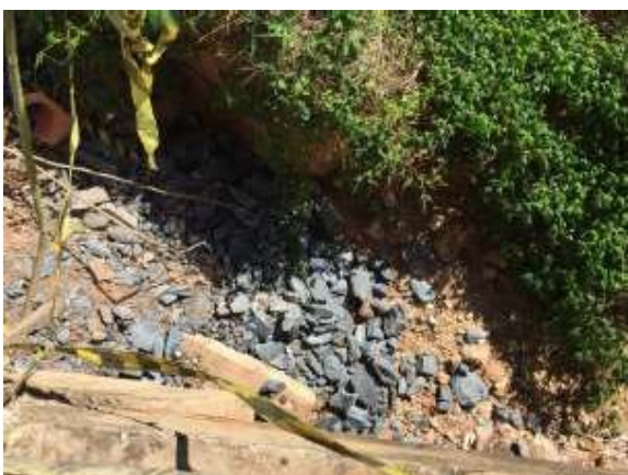
Figura 5 - Reposição Do Enrocamento Da Cabeceira Da Ponte.
