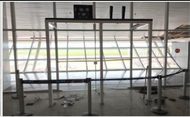
FOTO 08: Instalação do sistema SIV.
