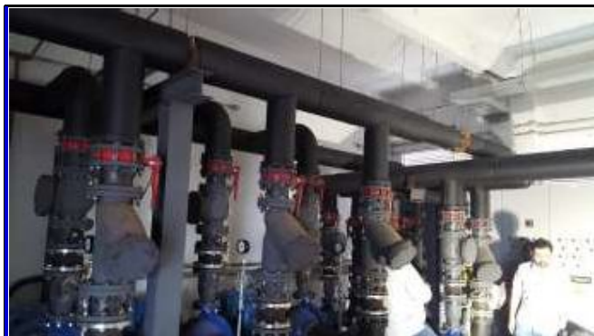
FOTO 03: Instalação do Isolamento térmico da tubulação de água gelada.
