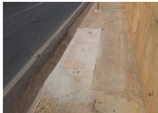
14. Excesso de concreto na base do poste - E490 LE (Imagem nº 102)
