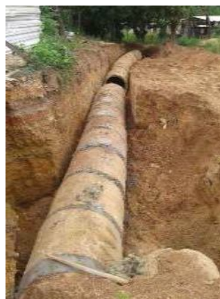
Fig. 04 – Tubo de concreto drenagem D = 1000 mm.
