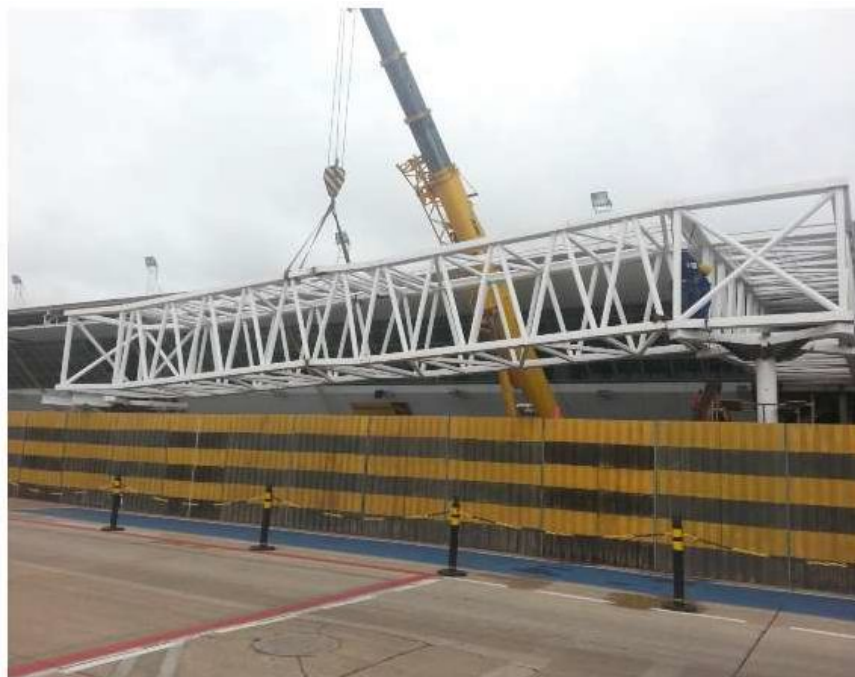
Foto 02: Instalação da Estrutura da Ponte de Embarque 03.
