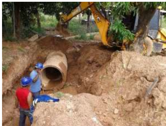
Fig. 02 – Tubo de concreto drenagem D = 1000 mm.
