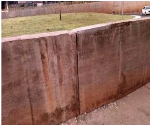
Figura 6 Reparo de concretagem corrigido Estaca 22 +10,00;
