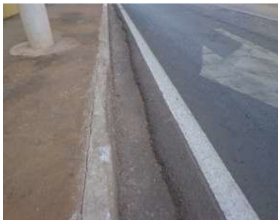
17. Peça de guia para boca-de-lobo não instalada – E 497 LE (Imagem n° 121)
