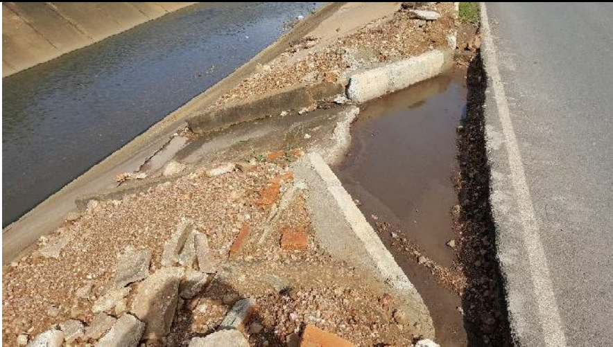
Fig. 02 – Execução dos serviços de entrada para as descidas d'águas – EDA
