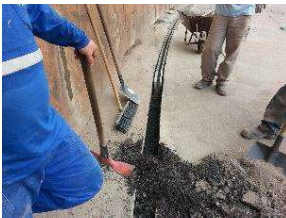
Figura 01. Construção da canaleta de concreto
