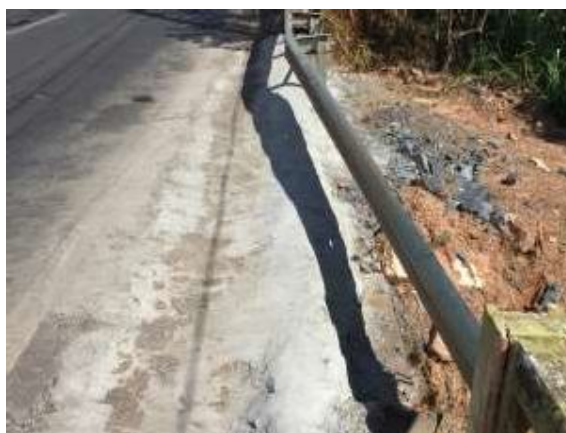
Figura 6 – Concretagem temporária da erosão.
