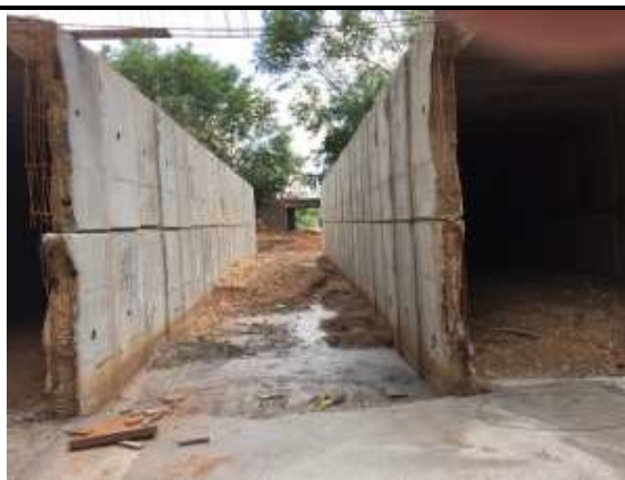
Fig. 04 - Concretagem de parte do berço da galeria.
