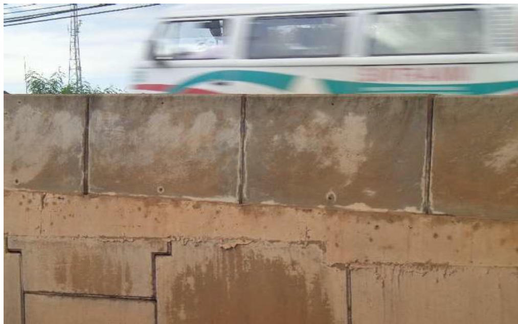
Foto 3.2 Guarda-corpo tipo New Jersey.
