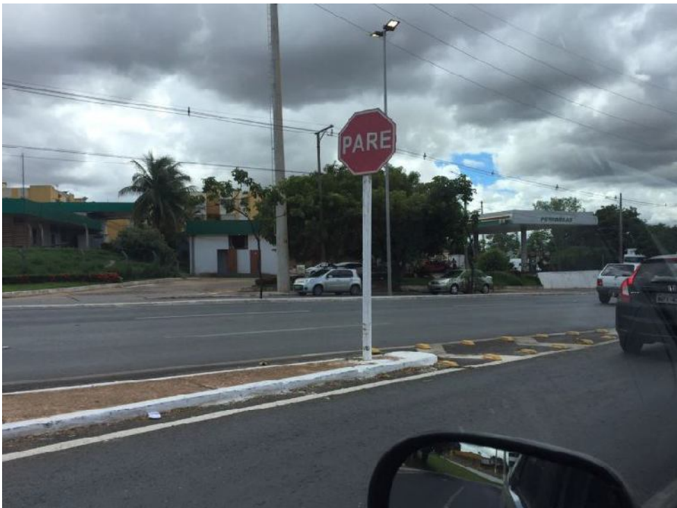
Fig. 09 – Constatada a instalação das duas placas de parada obrigatória.
