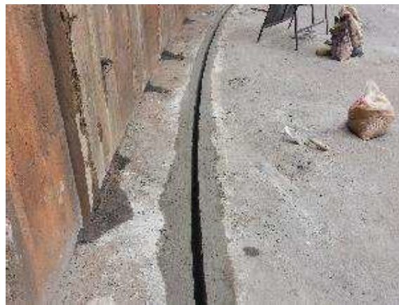
Figura 02. Finalização do serviço de construção da canaleta
