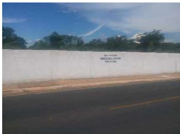
Fig. 11 Muro limítrofe com a Vila Militar
