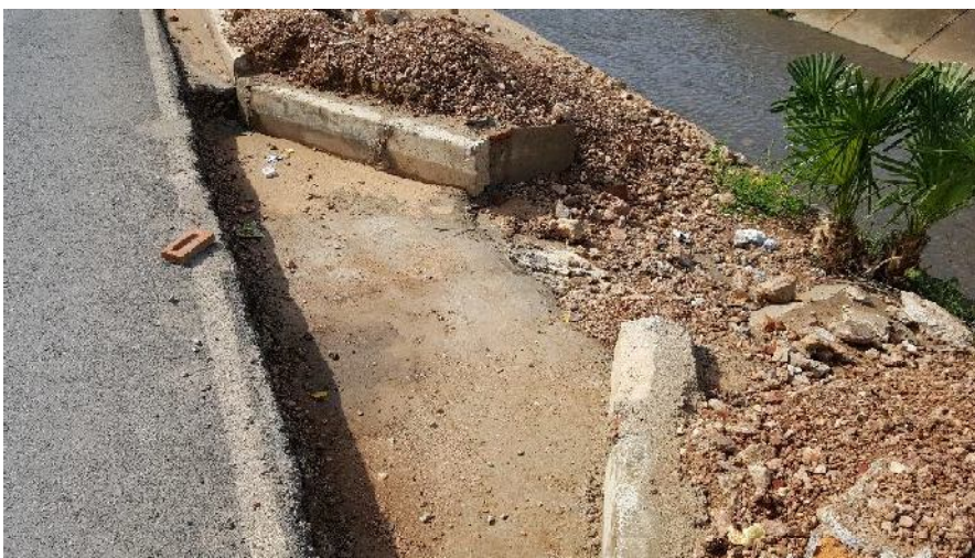
Fig. 04 – Execução dos serviços de entrada para as descidas d'águas – EDA
