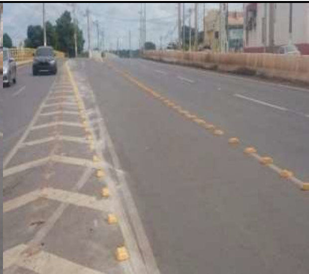
Figura 2 – Serviço corrigido, executado conforme projeto;
