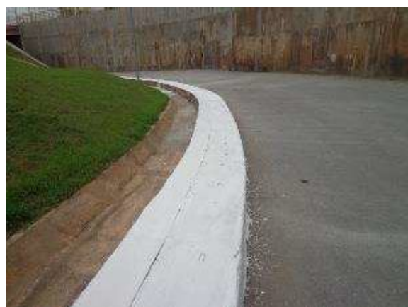
Figura 24. Pintura das canaletas concluída
