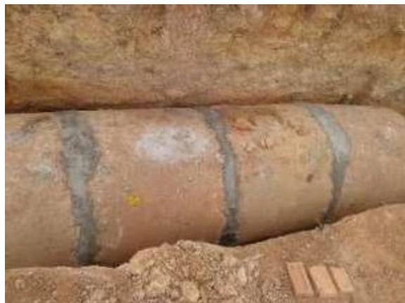
Fig. 01 Tubo de concreto drenagem D = 1000 mm.
