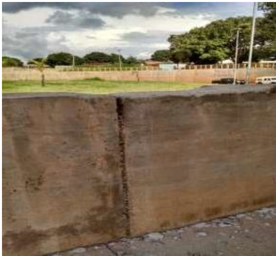
Figura 5 Reparo de concretagem não realizado – Estaca 22 +10,00;
