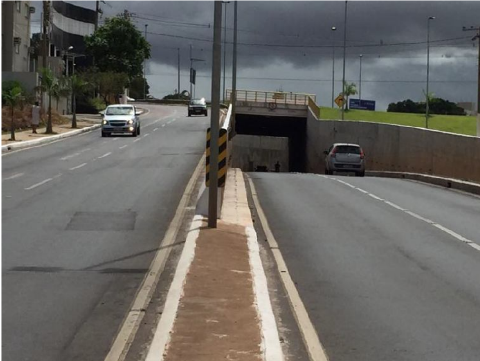
Fig. 08 – Constatada apenas uma placa de marcador de perigo;
