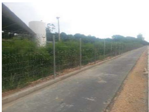
Fig. 05 Cerca de fechamento com painéis galvanizados, h = 2,00 m.
