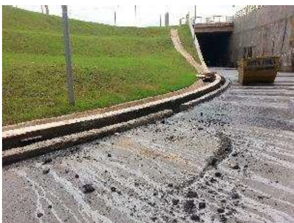
Figura 05. Recuperação da canaleta de drenagem
