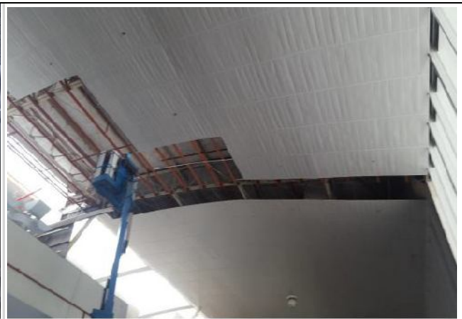
FOTO 02: Instalação de forro perfurado entre os eixos 13-14
