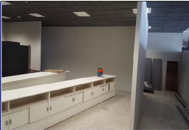
FOTO 01: Execução de Dry Wall na Sala da Alfandega
