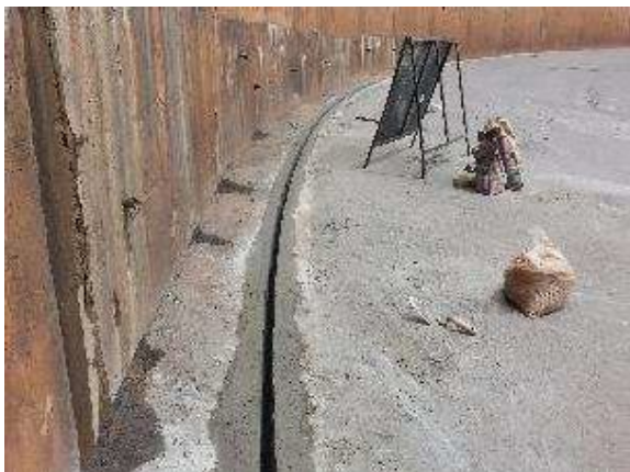
Figura 03. Finalização do serviço de construção da canaleta
