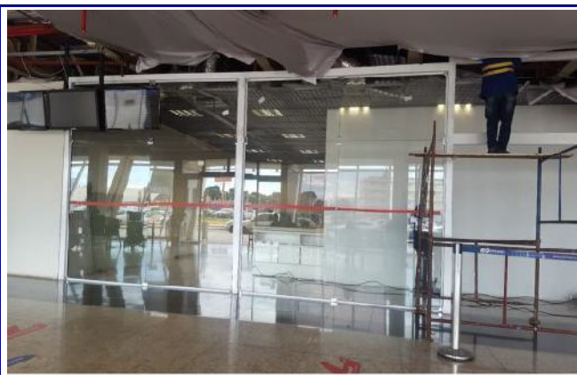
FOTO 09: Instalação de Divisória de Vidro na saída da Alfândega.
