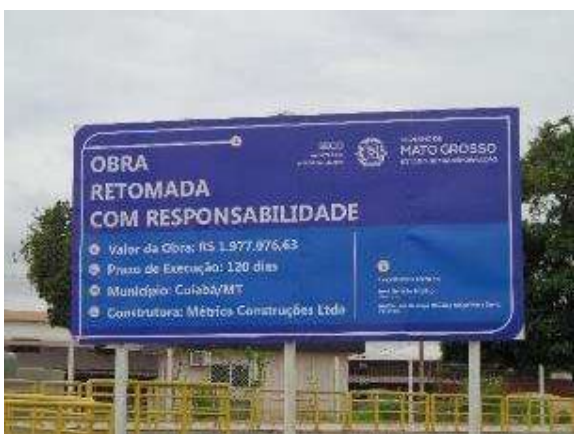
Figura 11. Instalação de placas de obra
