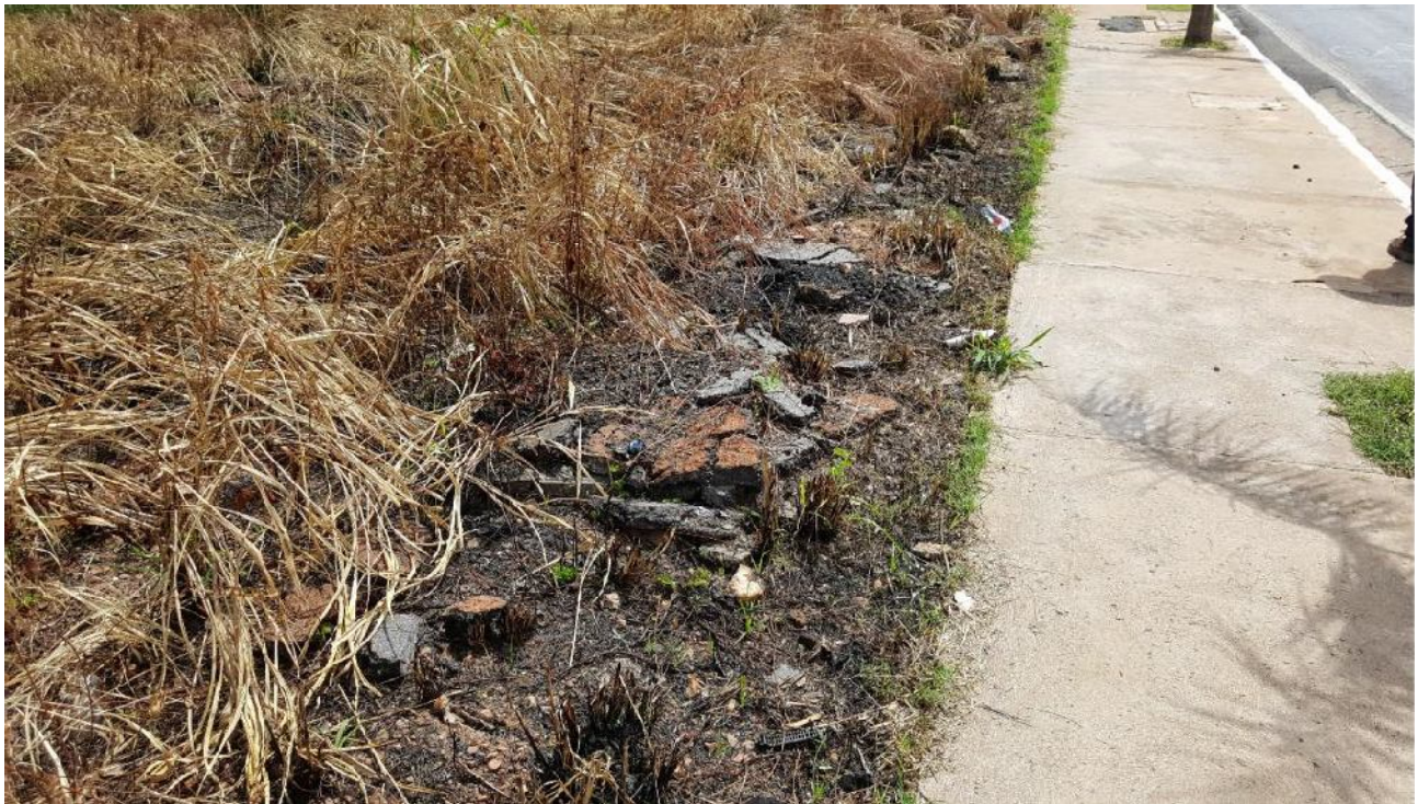
Fig. 11 – Resíduos de CBUQ, provenientes dos reparos realizados no pavimento.
