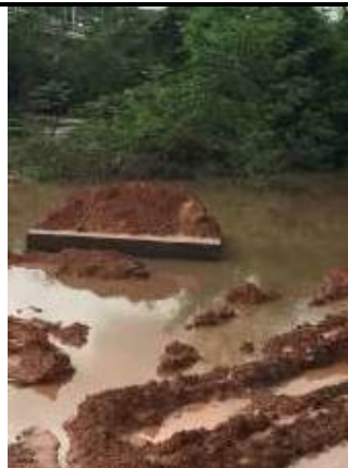
Figura 6 – CLP (caixa de ligação e passagem).
