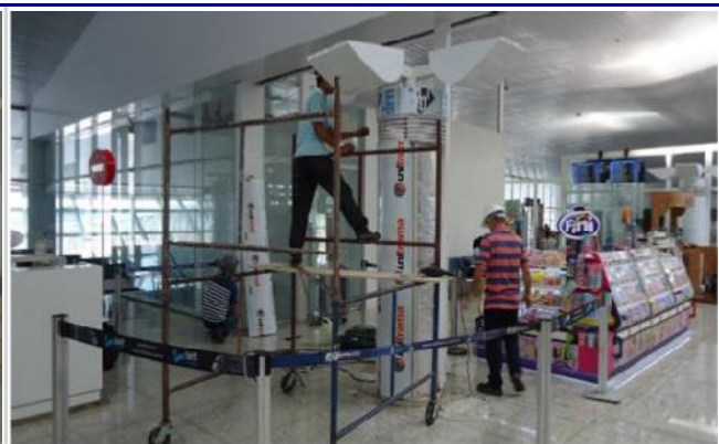
FOTO 06: Aplicação de Revestimentos e ACM
