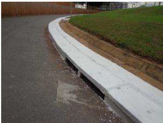
Figura 21. Pintura das canaletas concluída
