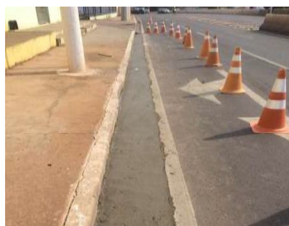
17. Peça de guia para boca-de-lobo não instalada – E 497 LE (Imagem n° 121)
