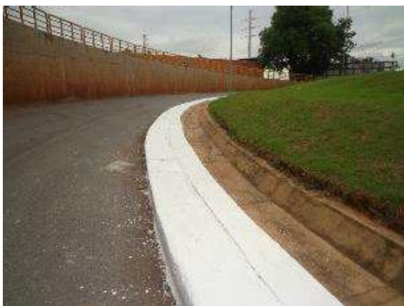
Figura 13. Pintura das canaletas concluída
