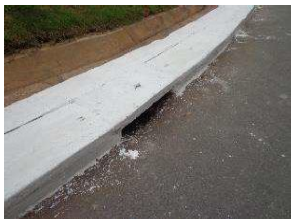
Figura 12. Pintura das canaletas concluída
