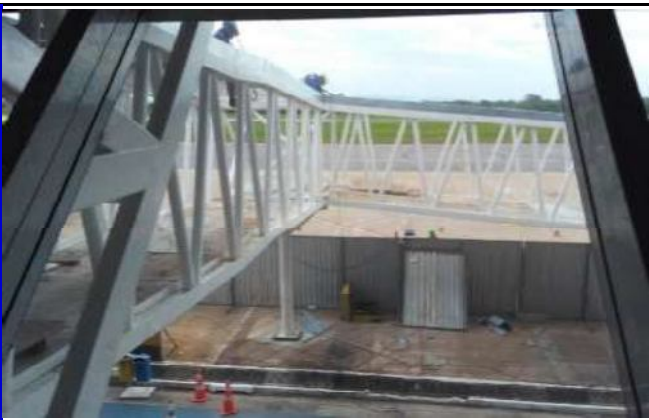
FOTO 07: Instalação da calha na cobertura da ponte de embarque 03.
