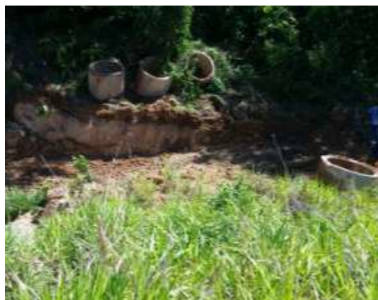
Figura 3 Início dos Trabalhos.
