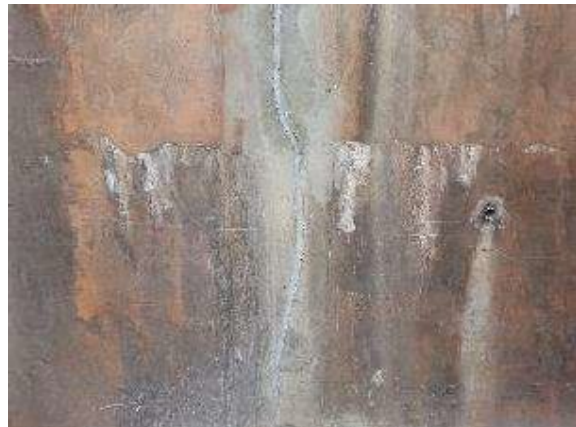
Figura 08. Reparo das juntas de dilatação
