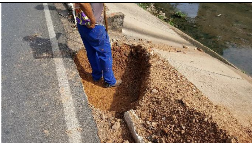
Fig. 05 – Execução dos serviços de entrada para as descidas d'águas – EDA
