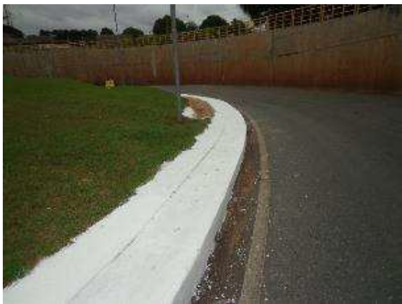
Figura 15. Pintura das canaletas concluída
