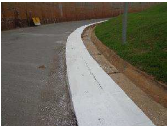
Figura 25. Pintura das canaletas concluída
