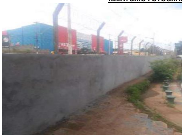
Fig. 01 Muro limítrofe com o Aeroporto
