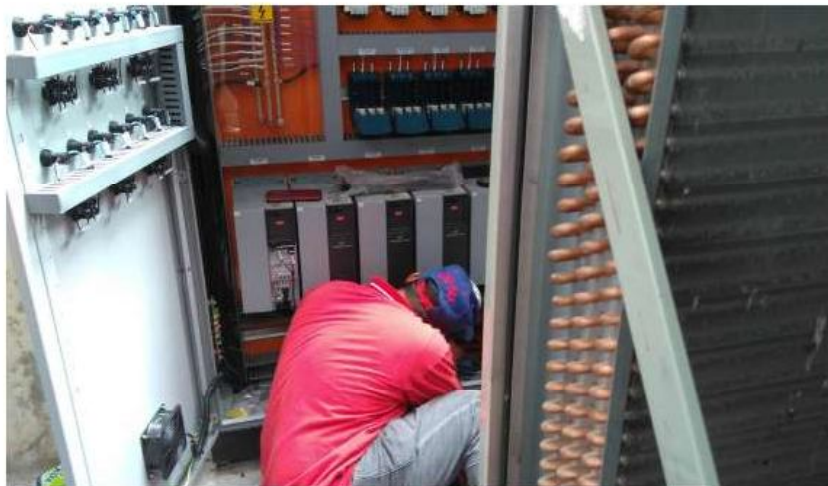
Foto 03: Instalação da infraestrutura da rede elétrica e automação Sala de Climatização 1 (TPS EIXO 3-4 Pavimento Superior)
