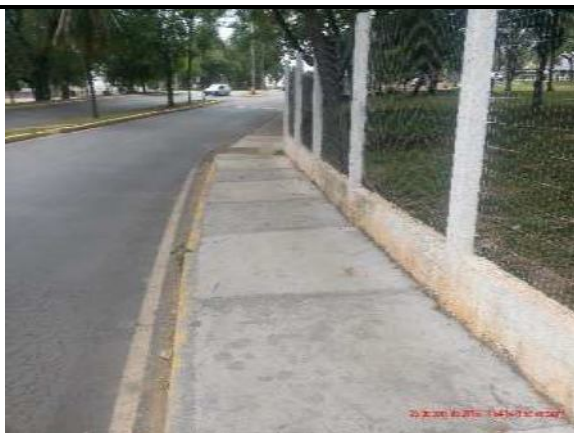
Fig. 06 – Muro limitrofe da Universidade Federal
