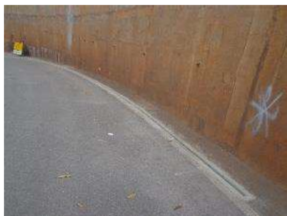
Figura 18. Construção da canaleta concluída
