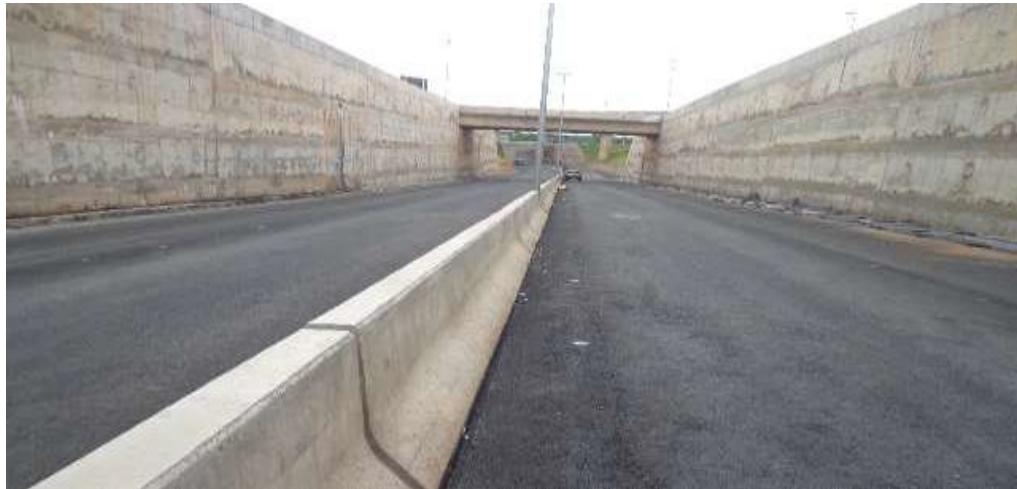
Foto 3.5 – Pavimentação asfáltica CBUQ.
