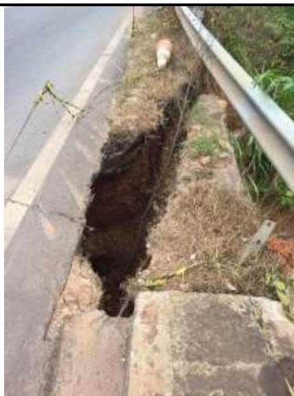
Figura 2 – Detalhe do acostamento.
