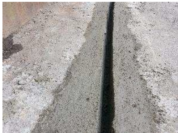
Figura 04. Finalização do serviço de construção da canaleta
