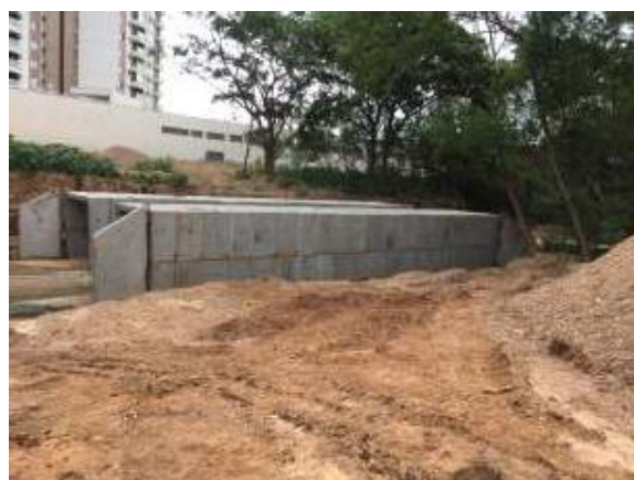
Fig. 01 Montagem Galerias- Alça Rotatória Brasília. Fig. 02 – Montagem das Alas (Boca da Galeria).
