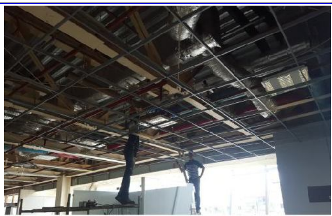
FOTO 10: Instalação de forro metálico tipo colméia.
