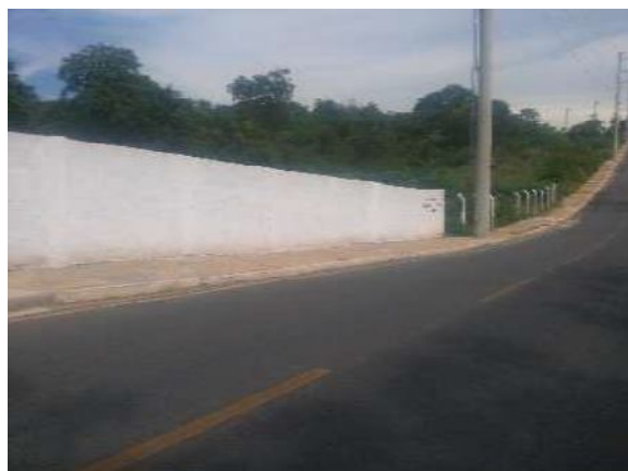
Fig. 14 – Muro limítrofe com a Vila Militar
