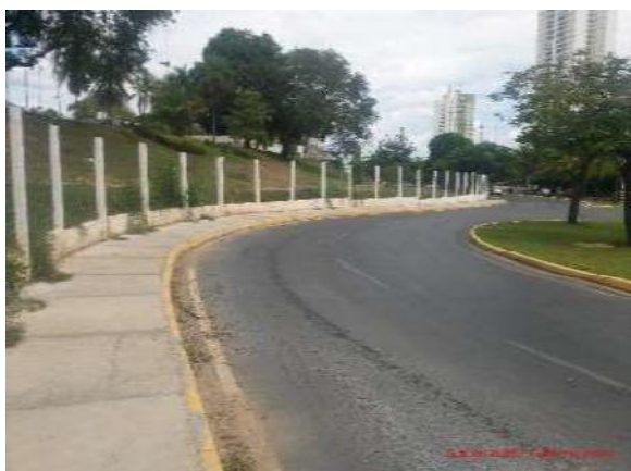
Fig. 07 Muro limitrofe da Universidade Federal
