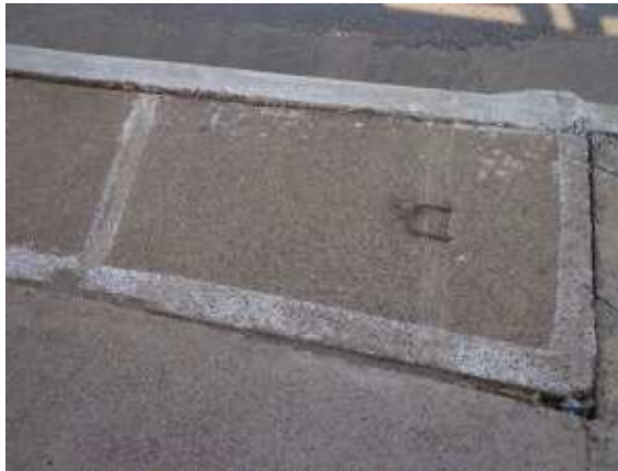
14. Excesso de concreto na base do poste - E490 LE (Imagem nº 102)
