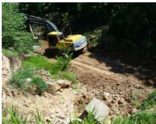
Figura 4 Início dos Trabalhos, escavação.
