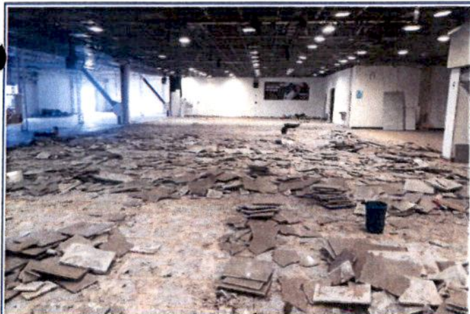
FOTO 05: Reforma do setor "C" Retirada de piso.
