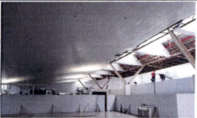
FOTO 09: Forro tipo perfurado no pavimento superior em fase final de conclusão.
