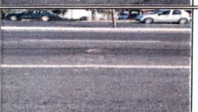
Trincas do tipo couro de jacaré próximo ao pv
