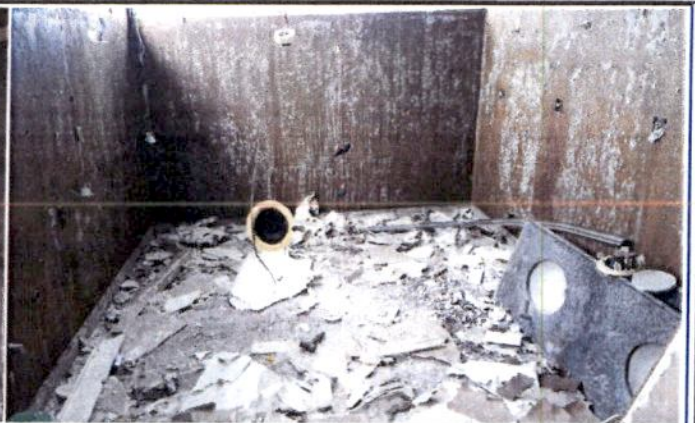
FOTO 16: Reforma setor "C" Retirada do revestimento - banheiros superior
