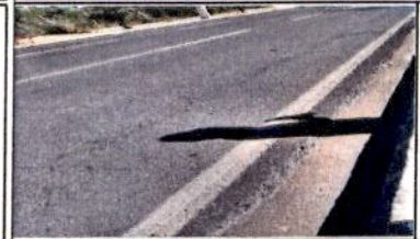
Escorregamento de massa e trinca
