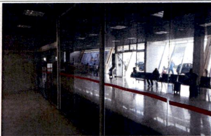
FOTO 04: Conclusão da instalação de divisória de vidro na saída do Desembarque Internacional.
