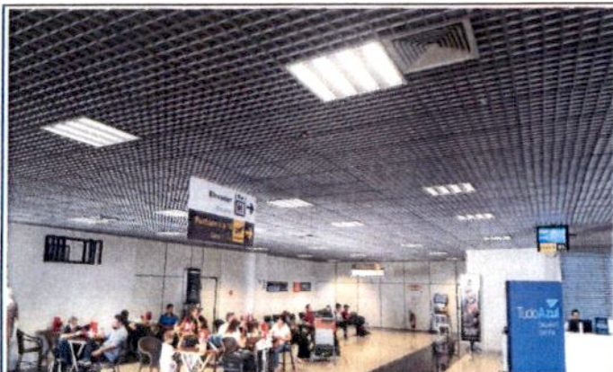
FOTO 01: Finalização do forro Colméia no pavimento térreo.
