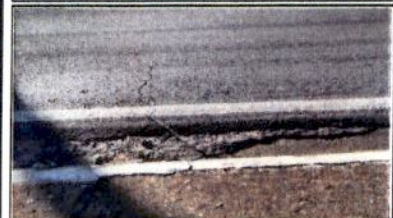
Escorregamento de massa e trinca
