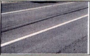
Trincas de retração
