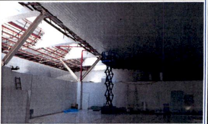
FOTO 10: Forro Pavimento superior em fase de conclusão.
