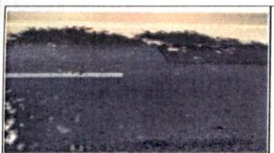
Trincas entre os remendos
