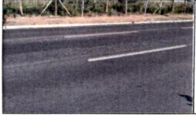
Trincas no remendo
