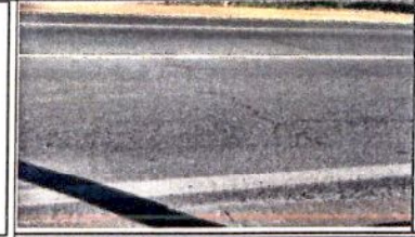
Trinca no pavimento
