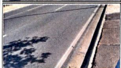
Trinca no pavimento
