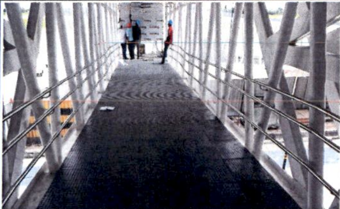
FOTO 07: Tunel da Ponte 03 em fase de acabamento - Instalação de guarda corpo e forro em ACM.
