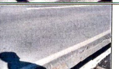
Trincas entre remendos
