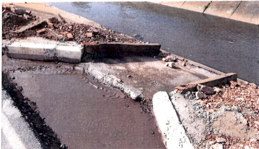
Fig. 01 – Execução dos serviços de entrada para as descidas d'águas – EDA
