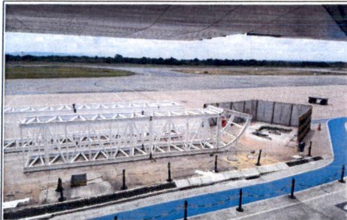
FOTO 13: Execução da ponte 04 - Túnel de embarque.
