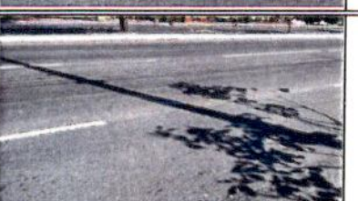
Trincas entre remendos
