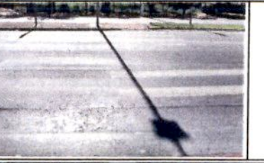
Trinca longitudinal no pavimento
