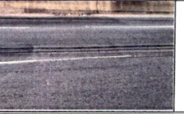
Trincas do tipo ouro de jacaré
