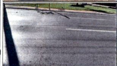
Afundamento e trinca
