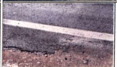
Trinca no pavimento
