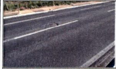
Afundamento da tampa do PV e trincas no pavimento
