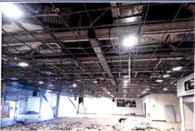
FOTO 06: Reforma Setor "C" Retirada dos forros colméia.
