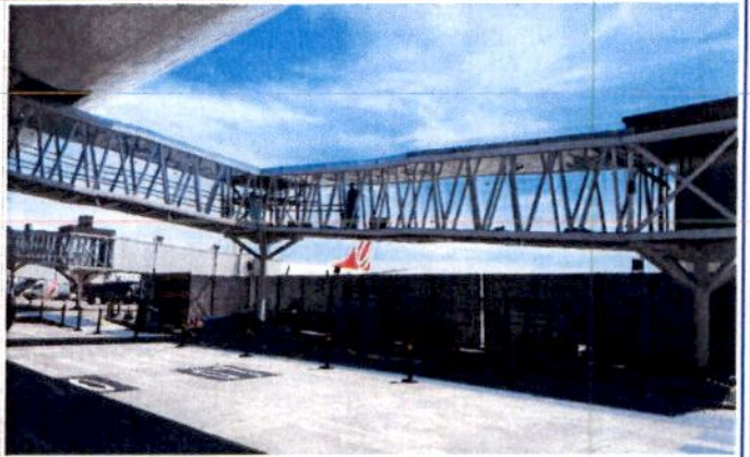
FOTO 08: Tinel da Ponte 03 em Fase de acabamento.
