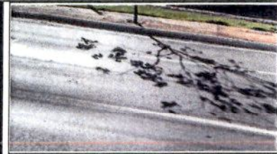
Trinca no pavimento
