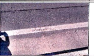
Trincas do tipo ouro de jacaré
