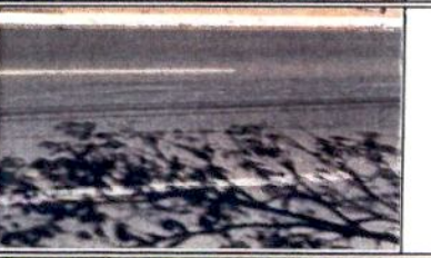
Trinca longitudinal no pavimento
