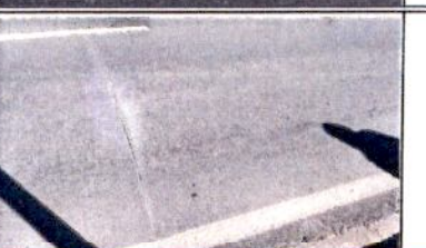
Trincas do tipo couro de jacaré próximo ao pv
