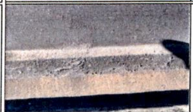
Afundamento e trinca
