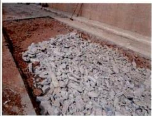
Reparo no pavimento asfáltico
