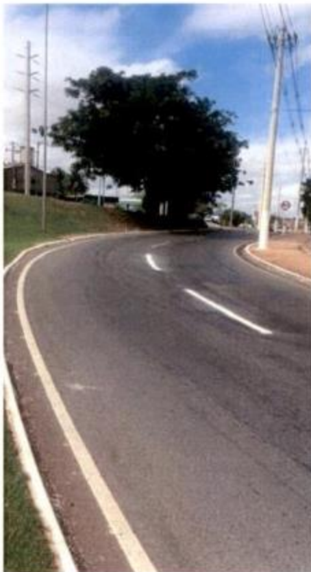
Fig. 13 – Pintura da sinalização horizontal
