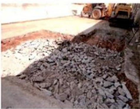
Reparo no pavimento asfáltico
