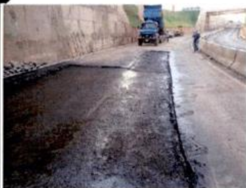
Reparo no pavimento asfáltico
