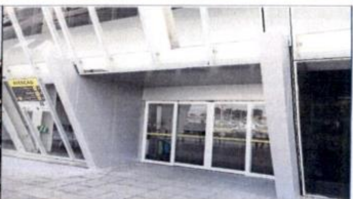
FOTO 12: Instalação de ACM nos Pórticos de Acesso(Fachada frontal) Início: 17/04/17-Término:05/05/17 (Atrasado)
