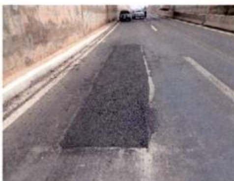
Reparo no pavimento asfáltico
