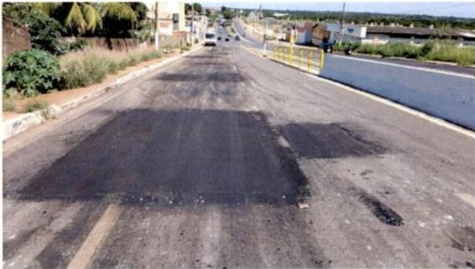
Fig. 09 – Fresagem do pavimento.
