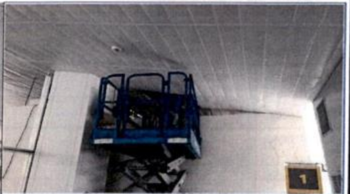
FOTO 06: Arremate do Forro do Setor Embarque.Início: 20/01/17-Previsão de término: 05/05/17(Atrasado)
