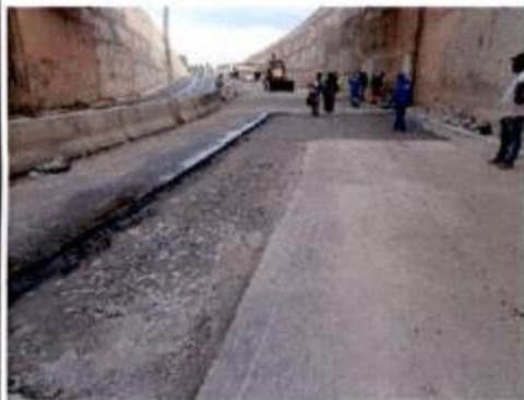
Reparo no pavimento asfáltico
