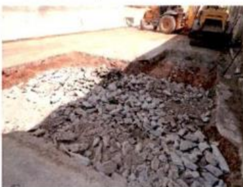
Reparo no pavimento asfáltico
