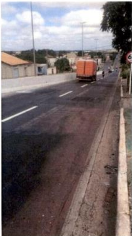
Fig. 14 – Pintura da sinalização horizontal
