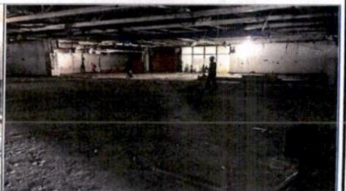
FOTO 08: Execução Reforma do Setor C(demolição).Início:06/02/17-Previsão Término: 05/05/17 (Atrasado)
