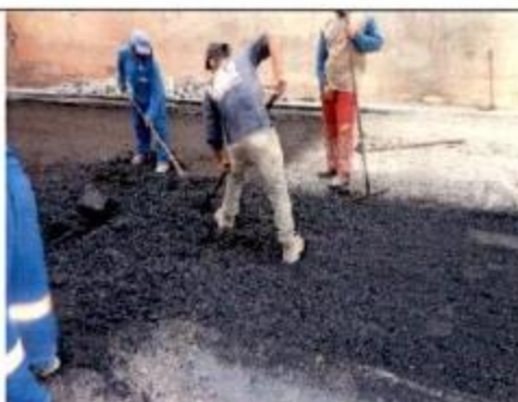
Reparo no pavimento asfáltico
