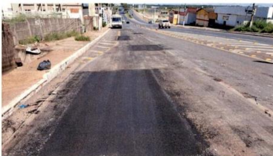
Fig. 08 – Fresagem do pavimento.
