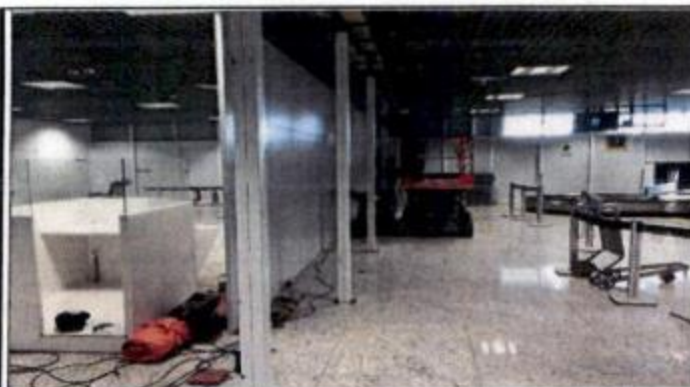
FOTO 09: Instalação da Estrutura p/Divisória em Vidro. Início:24/04/17-Previsão de término: 19/05/17
