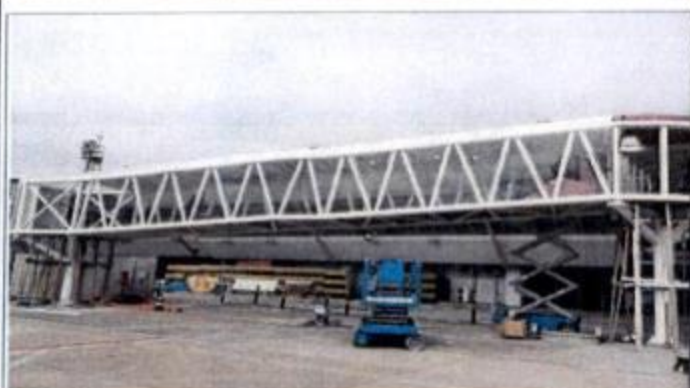
FOTO 11: Ponte de Embarque nº 4-Internacional (Montagem Parte Fixa) Início: 14/02/17- Término(Previsão): 30/05/17 (Atrasado)
