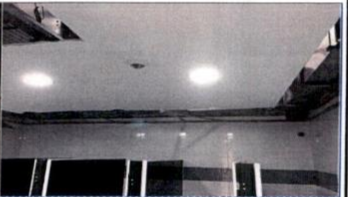
FOTO 04:Instalação/interlig. dos Dutos Sistema de Exaustão.Início:20/02/17-Término: 03/05/17 (Atrasado)
