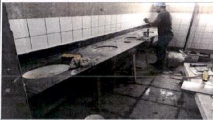
FOTO 07: Reforma dos Banheiros Setor "C" Início:31/01/17-Término(Prev): 05/05/17 (Atrasado).
