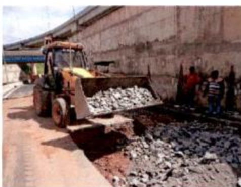
Reparo no pavimento asfáltico
