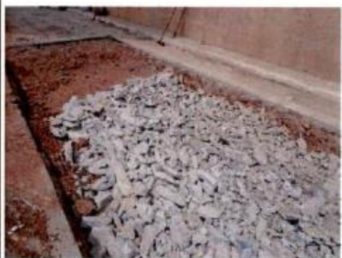
Reparo no pavimento asfáltico
