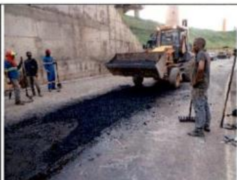
Reparo no pavimento asfáltico
