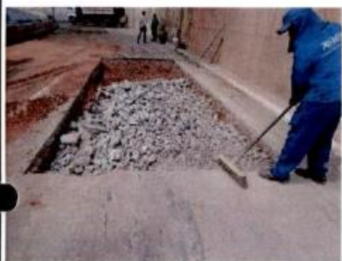
Reparo no pavimento asfáltico
