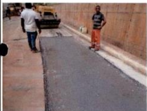
Reparo no pavimento asfáltico
