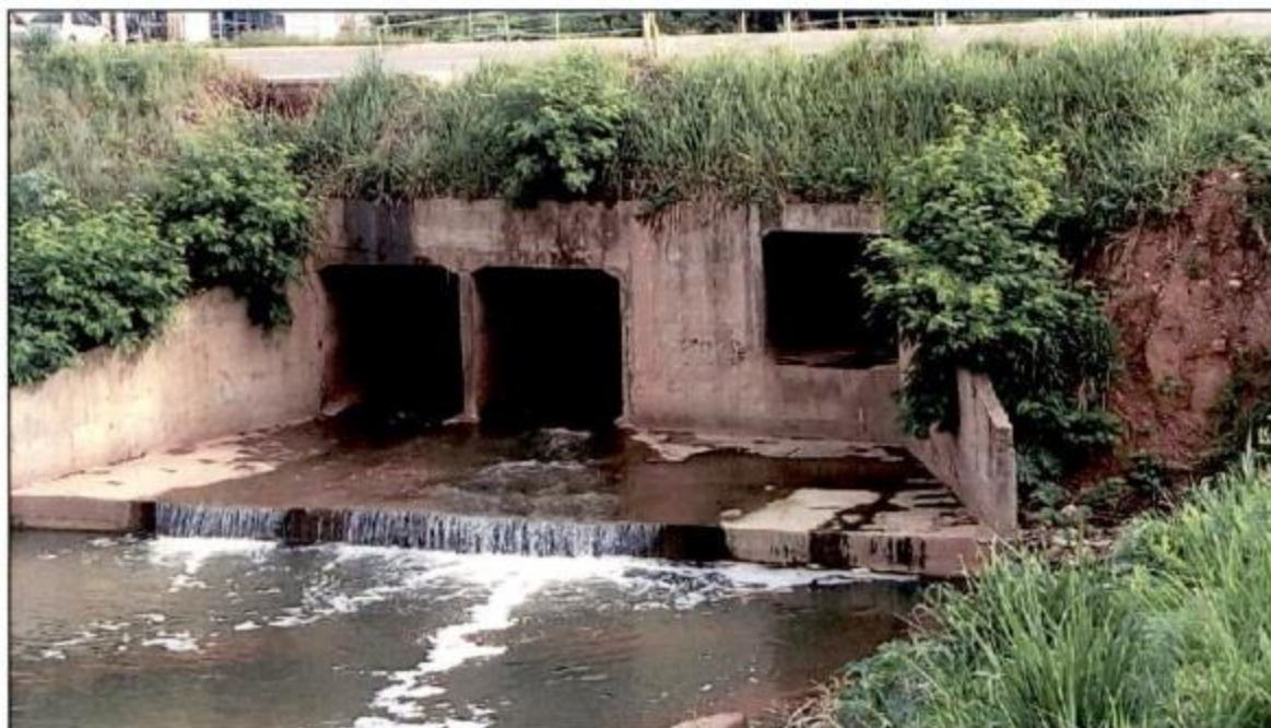
Figura 3- Detalhe da Galeria sob a pista da Estrada do Moinho.
