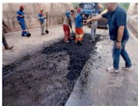
Reparo no pavimento asfáltico
