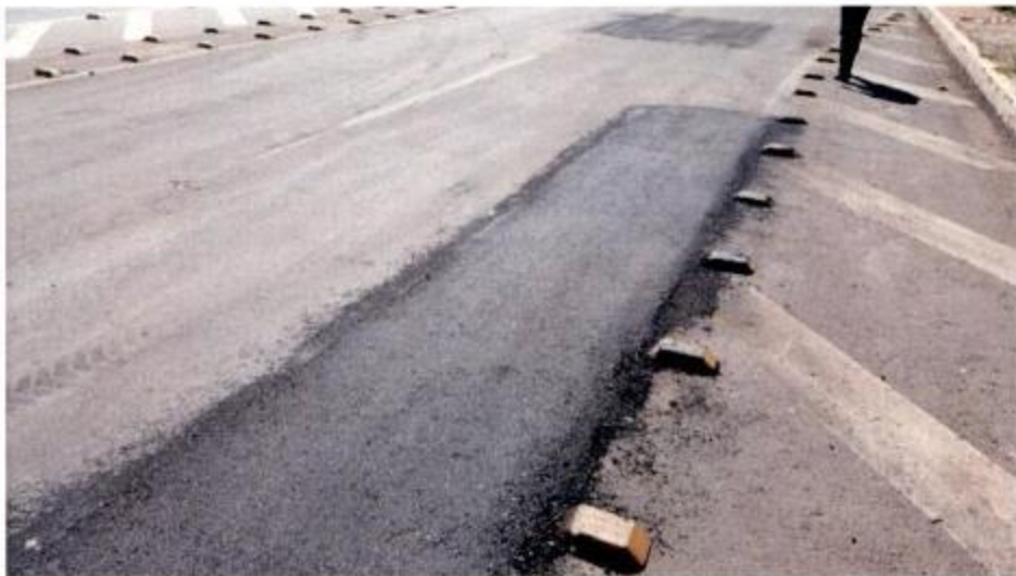
Fig. 10 – Fresagem do pavimento.
