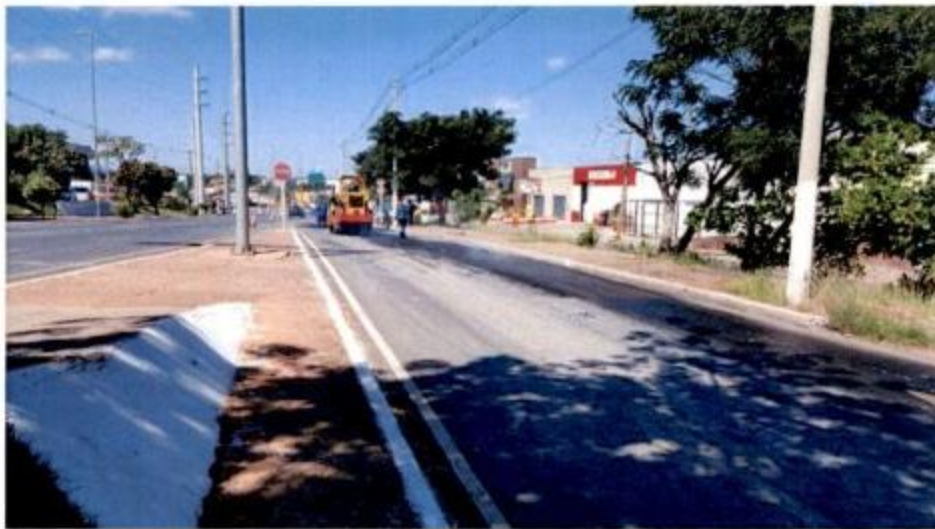
Fig. 11 – Fresagem do pavimento.
