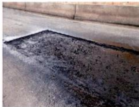
Reparo no pavimento asfáltico
