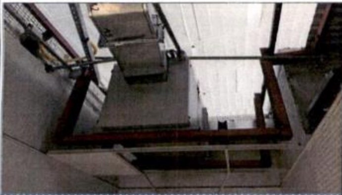
FOTO 03:Instalação das Máquinas do Sist. Exaustão/Ventilação.Início:20/02/17-Término:10/05/17(Atrasado)
