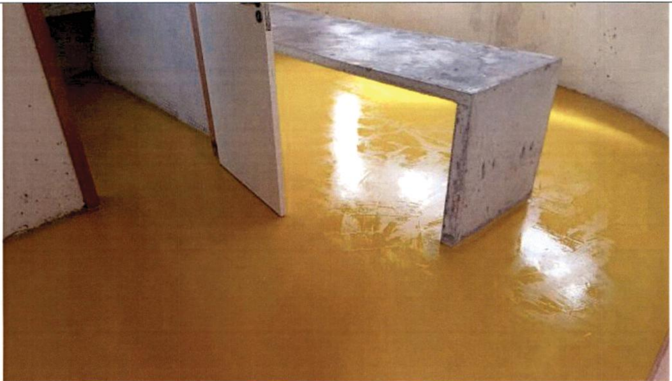
Fig. 05 - Execução do piso monolítico nos locais informados em projeto.
