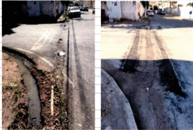
Est. 31 - 37 LD - Execução de meios fios, sarjeta de concreto e sarjeta triangular para escoamento da água no cruzamento
