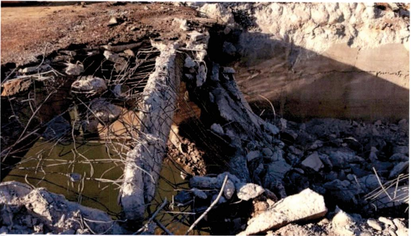
Fig. 08 – Demolição dos dispositivos de concreto armado – Rua Barão de Melgaço com Av. Oito de Abril;
