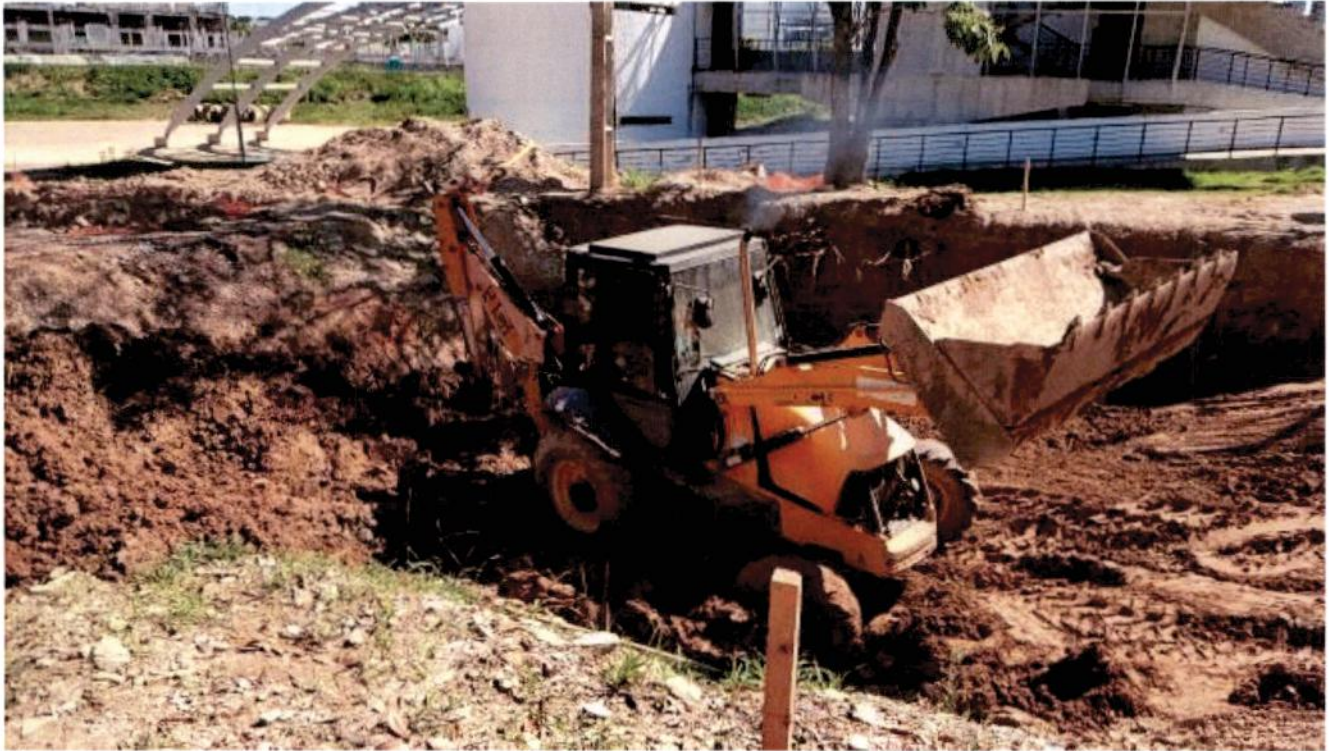
Fig. 07 – Escavação do reservatório de água potável/incêndio.
