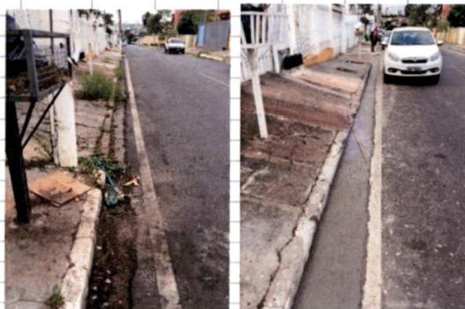
Est. 38 - 42 LD - Execução de sarjeta de concreto
