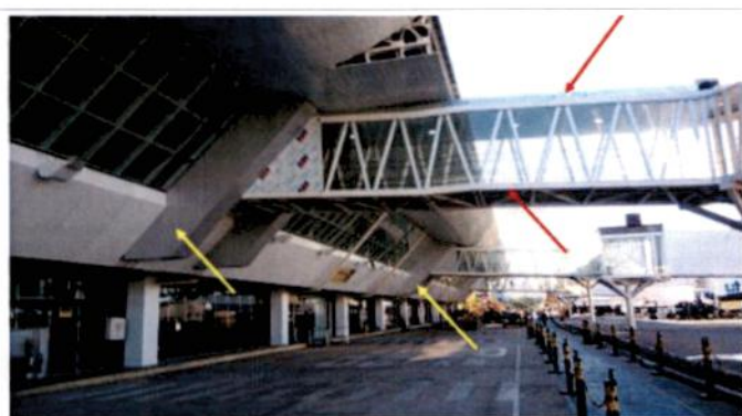
FOTO 01: Instalação de ACM na ponte de embarque
