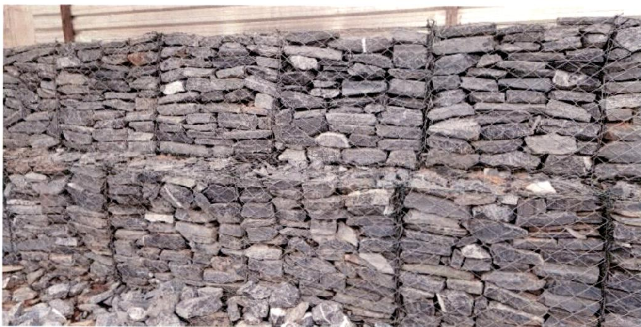
Fig. 02 – Execução do muro em gabião.
