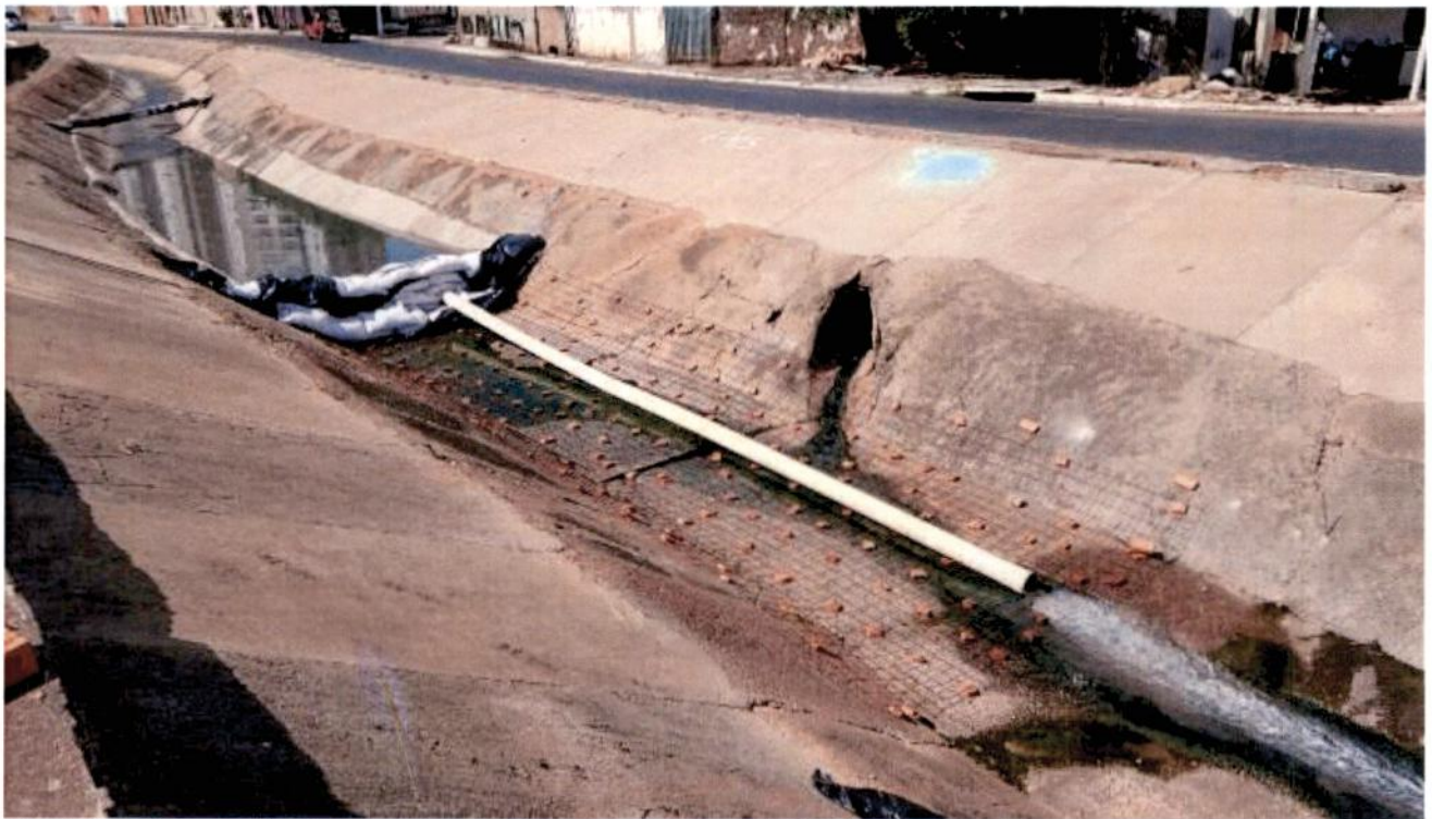
Fig. 04 – Colocação da armadura para concretagem do fundo do canal;
