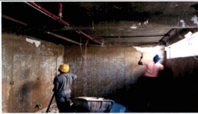
FOTO 09: Desmontagem e retirada do revestimento laminado das paredes
