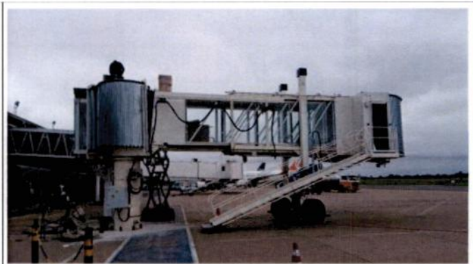
FOTO 12: Ponte de Embarque 04, montagem e testes da parte móvel
