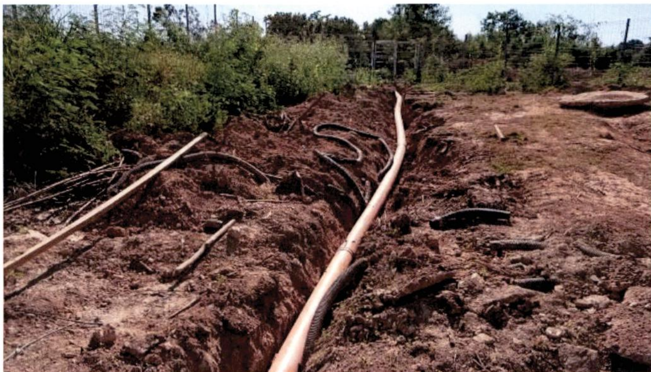
Fig. 09 – Tubulação para interligação da estação elevatório de esgoto.
