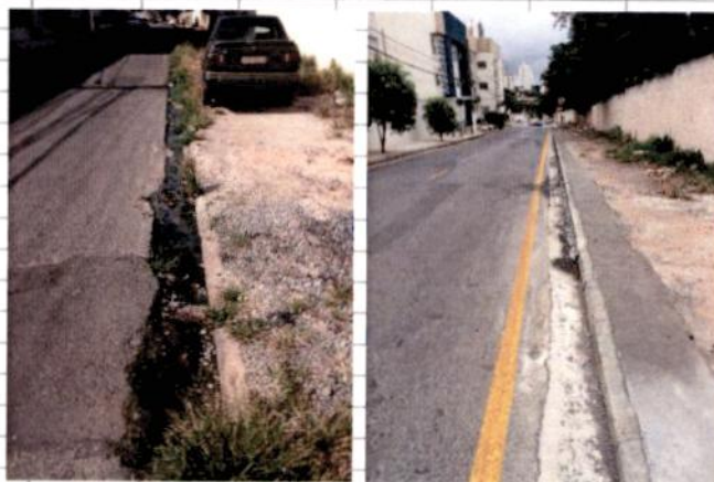
Est. 6 - 11 LD - Execução de meios fios, sarjeta de concreto e calçada
