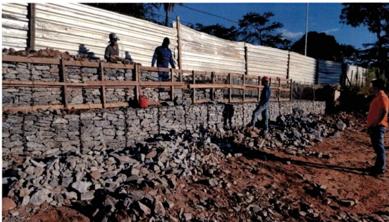
Fig. 03 – Execução do muro em gabião.
