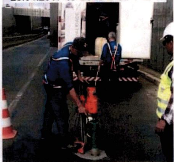
FOTO 3 – EXTRAÇÃO DO CORPO DE PROVA NO INÍCIO DA TRINCHEIRA SANTA ISABEL.
