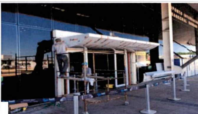
FOTO 03: Instalação de ACM na estrutura da porta automática
