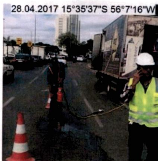
FOTO 2 – EXTRAÇÃO DO CORPO DE PROVA COM ROTATIVA.
