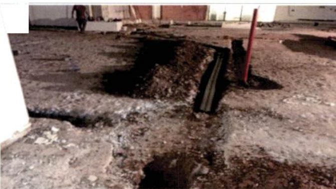
FOTO 07: Instalação das redes de água e esgoto - SETOR C - Reforma
