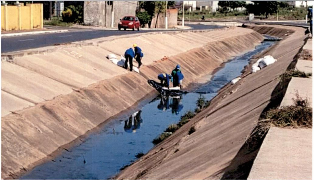
Fig. 05 – Ensecadeira para concretagem do fundo do canal;
