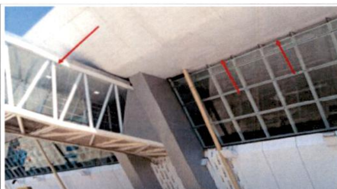
FOTO 02: Instalação de ACM na laterais da ponte
