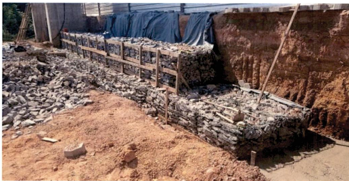
Fig. 01 – Execução do muro em gabião com aplicação da manta geotêxtil.
