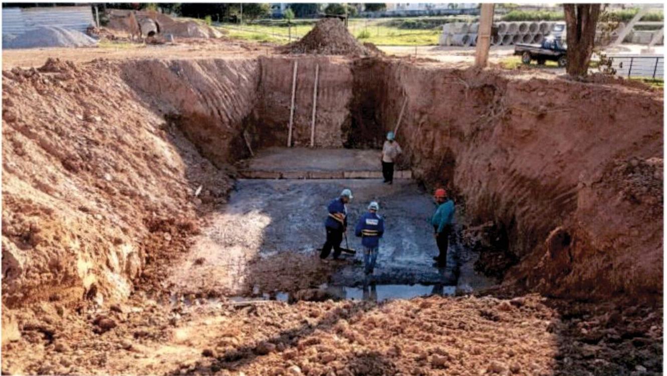
Fig. 08 – Lastro de concreto no fundo do reservatório de água potável/incêndio.
