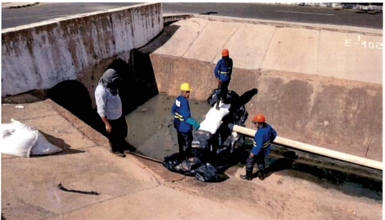
Fig. 06 – Ensecadeira para concretagem do fundo do canal;
