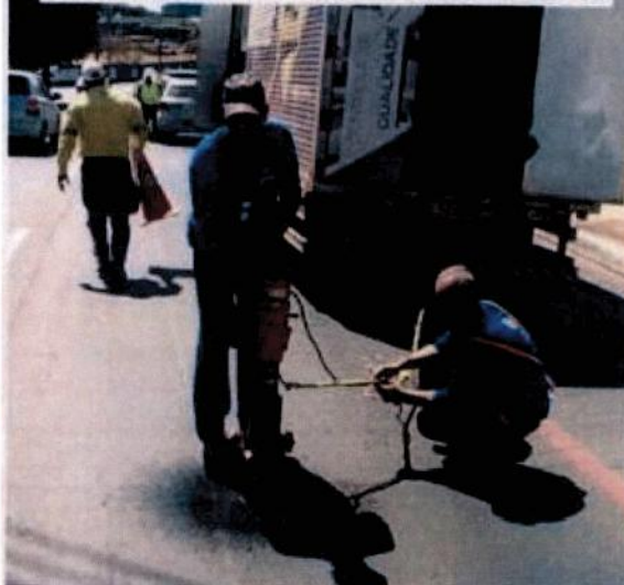
FOTO 6 – EXTRAÇÃO DO CORPO DE PROVA.
