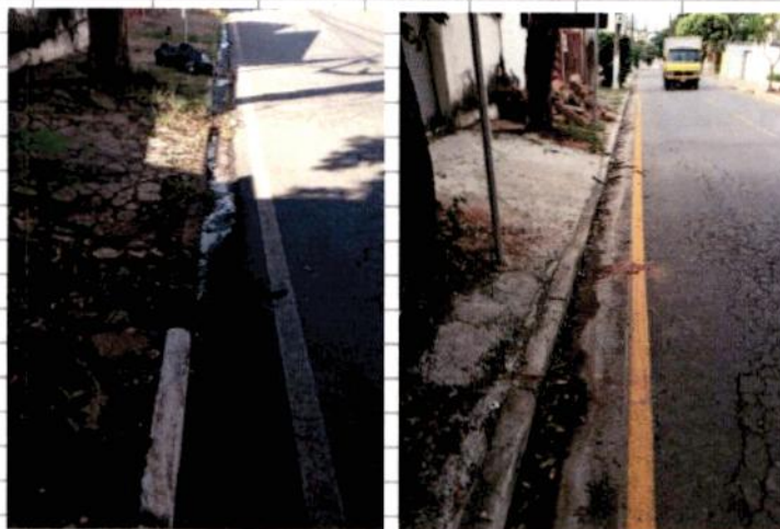
Est. 0 - 3 LE - Execução de meios fios, sarjeta de concreto e calçada
