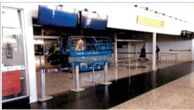
FOTO 06: Estrutura metálica e vidros da esquadria fixa localizada na saída do desembarque doméstico
