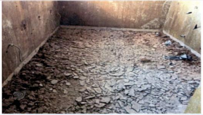
FOTO 10: Demolição do piso do sanitário público (Setor C).
