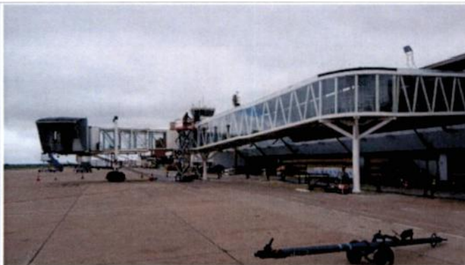
FOTO 11: Ponte de Embarque nº 4-Internacional, montagem da parte móvel
