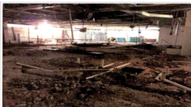
FOTO 08: Instalação das redes de água e esgoto - SETOR C - Reforma
