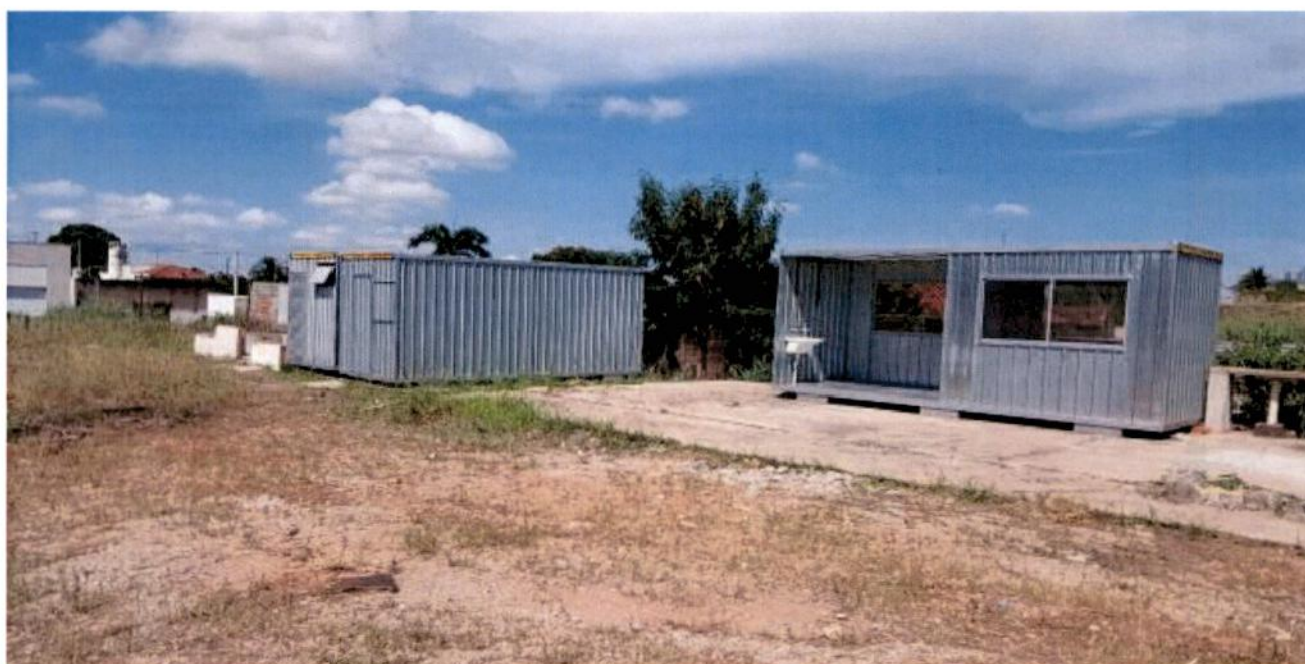
Fig. 01 – Mobilização do canteiro de obras;
