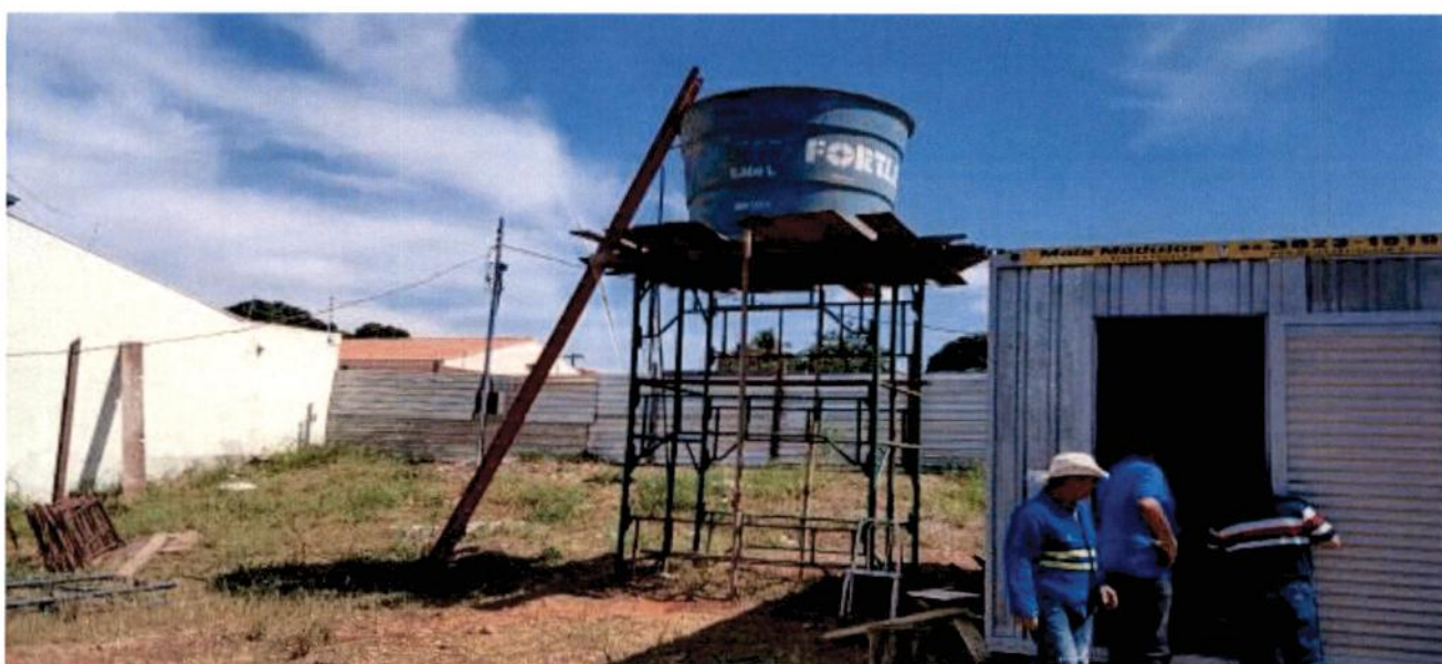
Fig. 02 – Mobilização do canteiro de obras;
