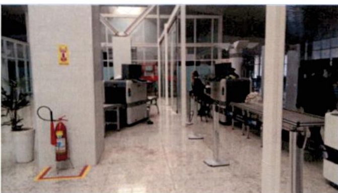
FOTO 05: Estrutura metálica, trilhos e vidros da esquadria reversível do canal de inspeção.
