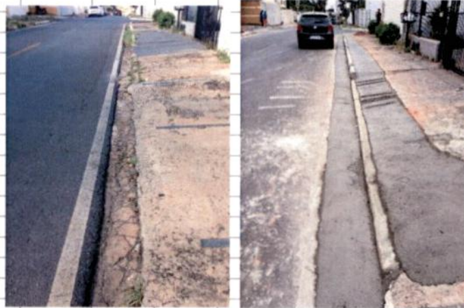
Est. 37 - 39 LE - Execução de meios fios, sarjeta de concreto e calçada
