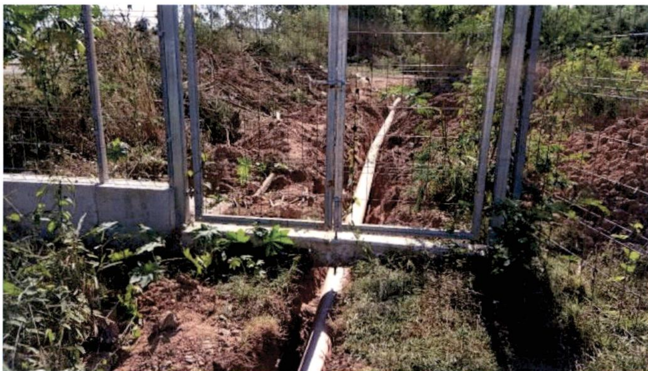
Fig. 10 – Tubulação para interligação da estação elevatório de esgoto.
