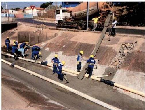
Figura 1- Concretagem do fundo do canal.
