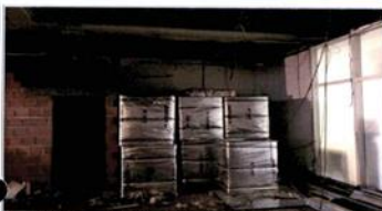
FOTO 05: Reforma Setor C. Instalação da rede de dutos de ar condicionado (refrigeração)
