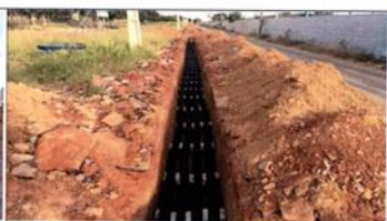
FOTO 10: Instalação dos dutos PEAD para SDAI e Telemática
