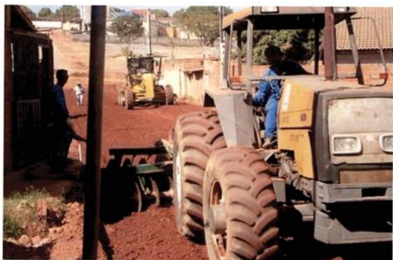
Execução do greide de pavimentação na rua Dom Carlos Luiz D'Amour.
