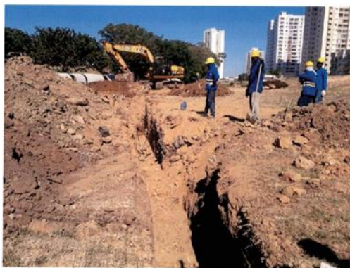
Figura 14- Detalhe Escavação para implantação da drenagem.
