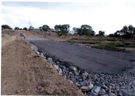
Execução do greide de terraplanagem na rua Dom Carlos Luiz D'Amour.
