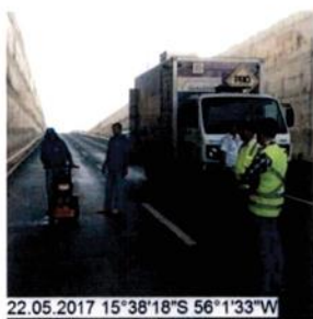
FOTO 5 – SONDAGEM REALIZADA NA ESTACA 24.
