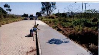
FOTO 04: Execução da calçada de via da lotação do ITE
