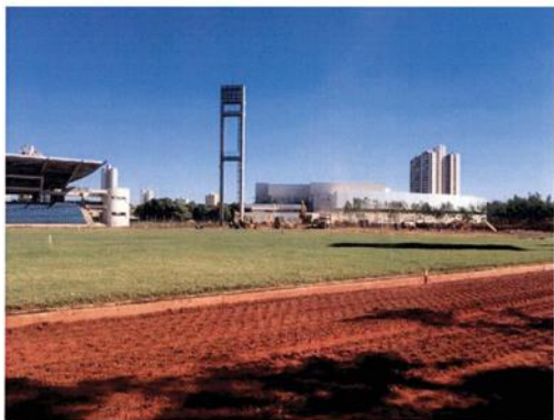
Figura 10- Início dos serviços de nivelamento da pista.
