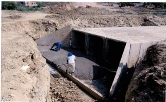
Execução da drenagem – galeria tripla - na rua Dom Carlos Luiz D'Amour.
