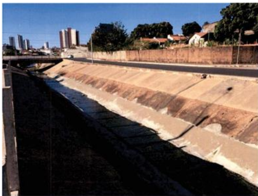
Figura 4- Fundo do canal concretado.
