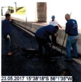
FOTO 2 – SONDAGEM REALIZADA NA ESTACA 12.
