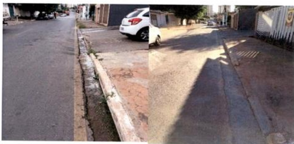
Figura 4a /4b – Execução de sarjeta na Rua General Rabelo;
