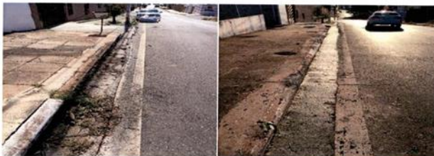
Figura 1a /1b – Execução de sarjeta na rua das Orquídeas;
