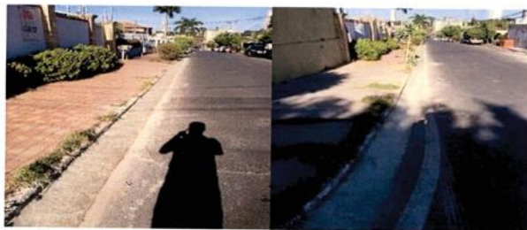
Figura 5a/5b – execução de sarjeta na Rua das Dálias;
