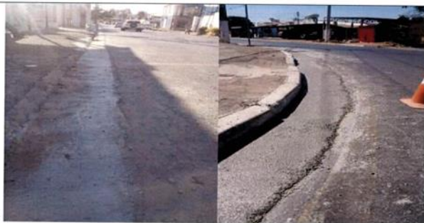
Figura 6a/6b – execução de sarjeta na Avenida Ipiranga;
