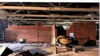
FOTO 06: Reforma Setor C. Execução da alvenaria das salas operacionais
