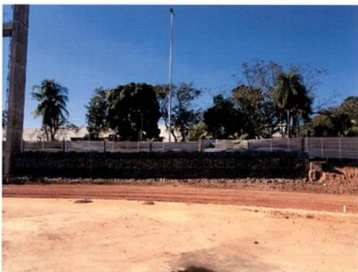
Figura 8- Gabião finalizado, instalação dos pilares das cercas.
