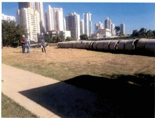
Figura 13- Detalhe Tubulação de 1200mm, drenagem do estacionamento.
