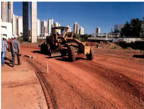
Figura 12- Nivelamento da pista.
