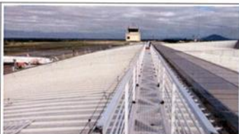
FOTO 02: Execução da passarela metálica na cobertura do TPS
