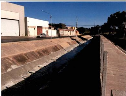
Figura 3- Fundo do canal concretado.
