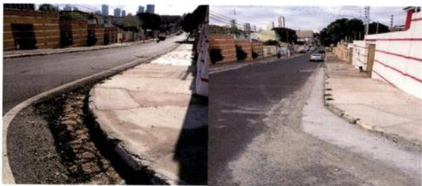
Figura 2a /2b – Execução de sarjeta na rua das Orquídeas;
