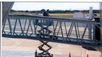
FOTO 03: Instalação de ACM na Ponte de Embarque na parte superior
