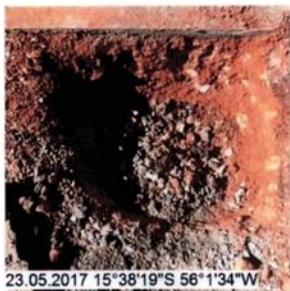
FOTO 6 – SONDAGEM REALIZADA NA ESTACA 24.
