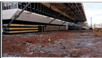
FOTO 09: Demolição do embarque provisório (Setor C)
