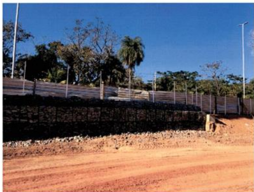
Figura 9-Gabião e limpeza da pista.
