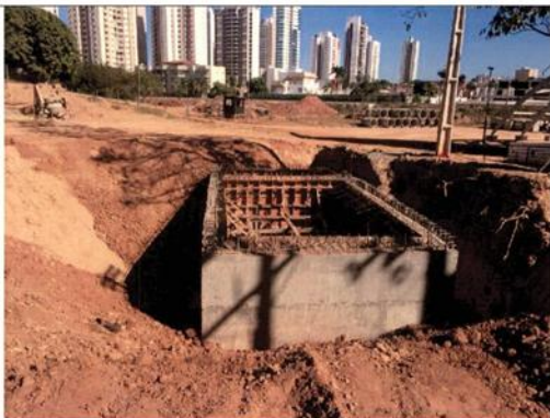
Figura 7-Paredes do reservatório concretadas.
