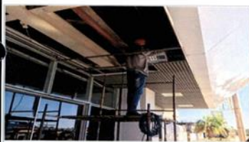
FOTO 11: Instalação do forro colméia no lado AN
