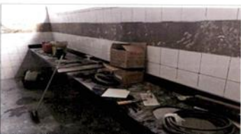
FOTO 07: Instalação das bancadas e cubas. Reforma Sanitários públicos Setor C (pav. Terceiro)
