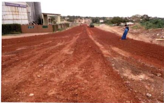
Execução do greide de pavimentação na rua Dom Carlos Luiz D'Amour.
