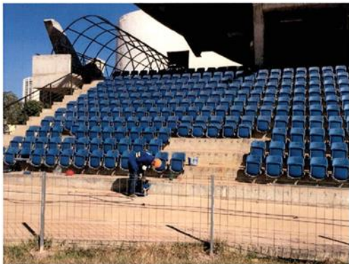
Figura 11- Retrabalhos, realinhamento das cadeiras da arquibancada.
