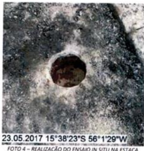
FOTO 4 – REALIZAÇÃO DO ENSAIO IN SITU NA ESTACA 14.
