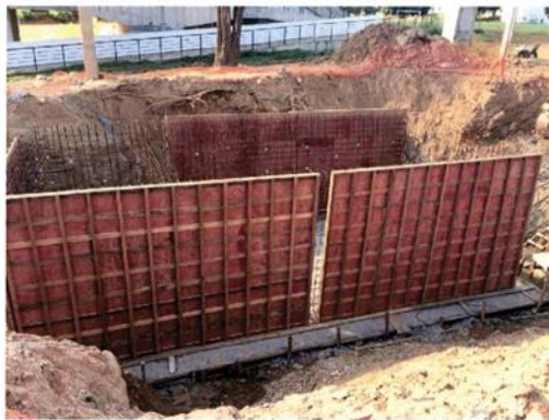
Figura 6- Continuidade dos serviços do Reservatório de água/incêndio.
