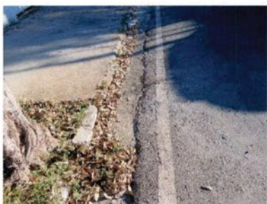
Fotografia 43 – Meio-fio quebrado
