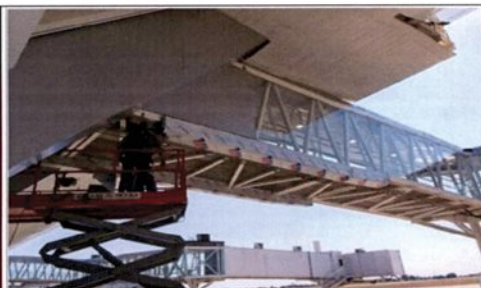
FOTO 09: FRENTE 5 - Acabamento na estrutura metálica em ACM cinza-Pontes de Embarque 01,02 e
