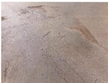
Fotografia 28 – Afundamento
