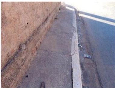
Fotografia 126 – Sarjeta quebrada
