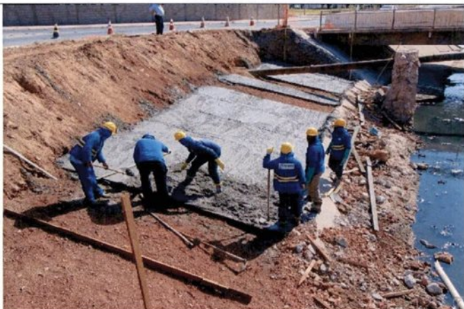
Fig. 01 – Execução do lastro de concreto para execução fundação da laje da Av. Senador Metelo;
