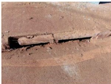
Fotografia 119 – Meio-fio quebrado
