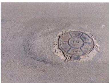
Fotografia 102 – Afundamento
