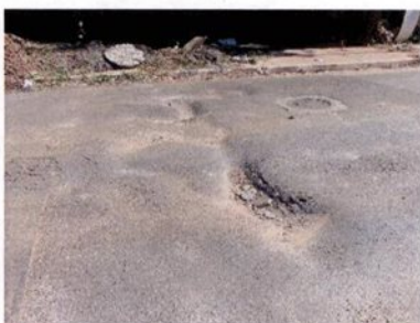
Fotografia 30 – Afundamento
