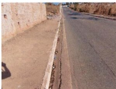
Fotografia 107 – Afundamento
