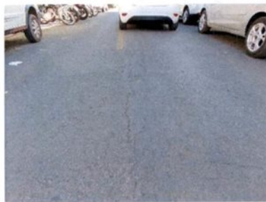
Fotografia 07 – Trinca longitudinal
