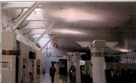
FOTO 10: FRENTE 6 - Instalação dos Totens e luminárias.
