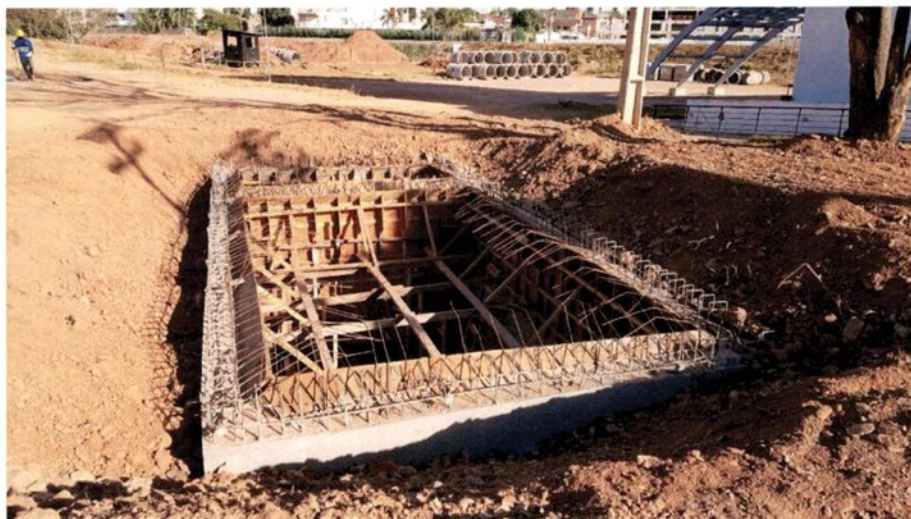
Fig. 09 – Laje do reservatório enterrado (cisterna).
