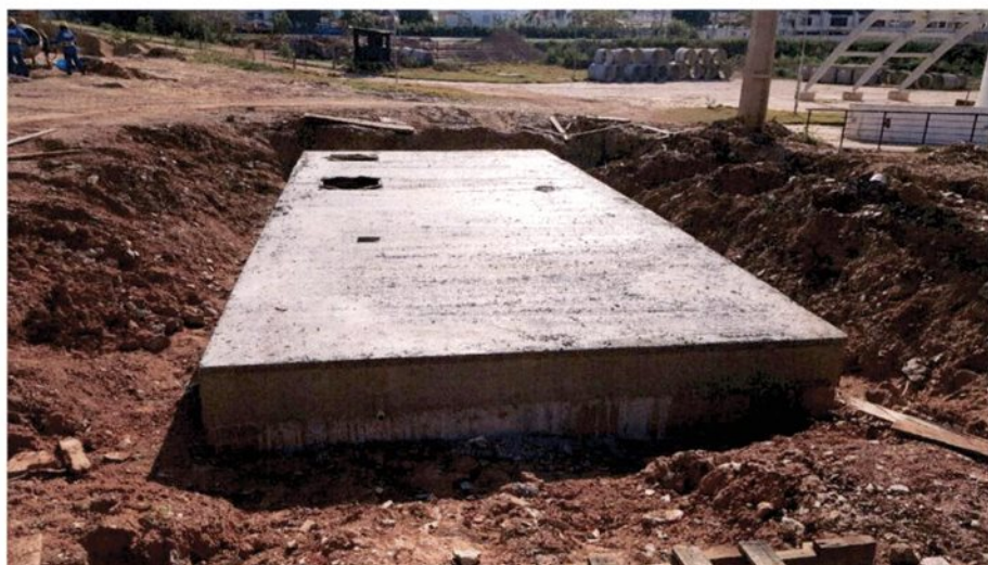
Fig. 10 – Laje do reservatório enterrado (cisterna).
