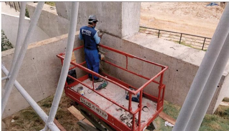
Fig. 07 – Lixamento da estrutura em concreto aparente.
