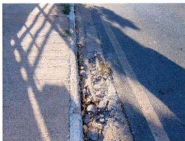
Fotografia 96 – Sarjeta quebrada
