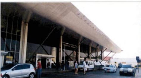
FOTO 07: FRENTE 4 - Acabamento do forro metálico e ACM branco sob a cobertura do lado TERRA.
