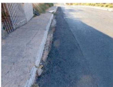
Fotografia 90 – Afundamento
