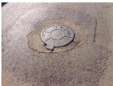
Fotografia 110 – Afundamento
