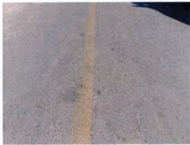
Fotografia 08 – Trinca longitudinal
