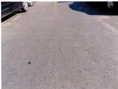
Fotografia 09 – Trinca longitudinal
