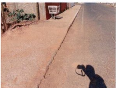
Fotografia 20 – Meio-fio danificado
