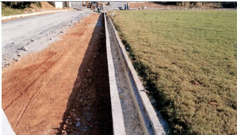
Fig. 03 – Execução das canaletas de concreto.
