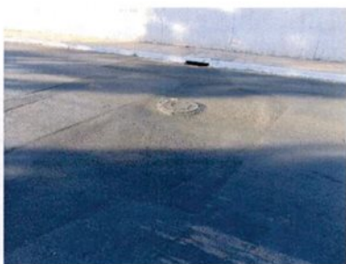
Fotografia 68 – Afundamento
