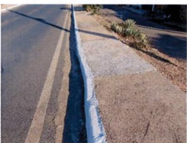
Fotografia 78 – Meio-fio desalinhado
