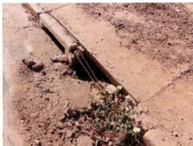
Fotografia 21 – Meio-fio quebrado
