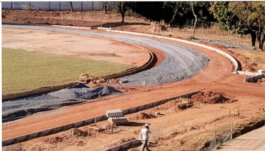
Fig. 05 – Fornecimento do lastro de brita para base da pista de atletismo.
