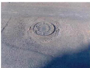
Fotografia 53 – Afundamento
