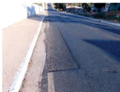
Fotografia 61 – Afundamento
