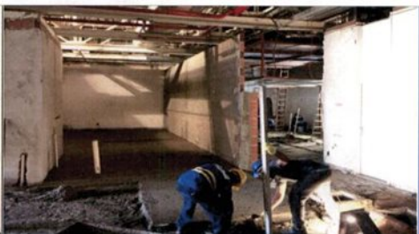
FOTO 02: Frente 1: Reforma do Setor C-AR(Pav terreo)- Alvenaria, reboco, contrapiso (Em andamento)
