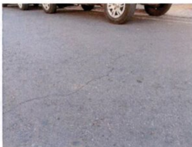
Fotografia 06 – Trinca transversal
