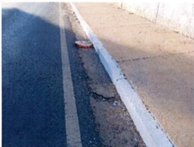
Fotografia 75 – Sarjeta quebrada
