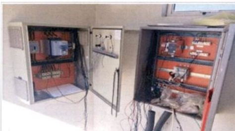
FOTO 03: Frente 2 - Instalação de quadros elétricos e automação do Novo sistema de abastecimento
