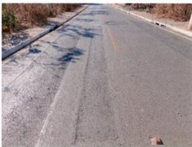
Fotografia 104 – Afundamento
