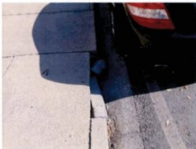
Fotografia 04 – Meio-fio quebrado
