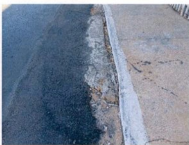
Fotografia 92 – Afundamento
