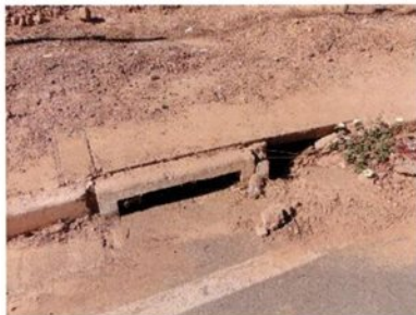
Fotografia 22 – Meio-fio quebrado
