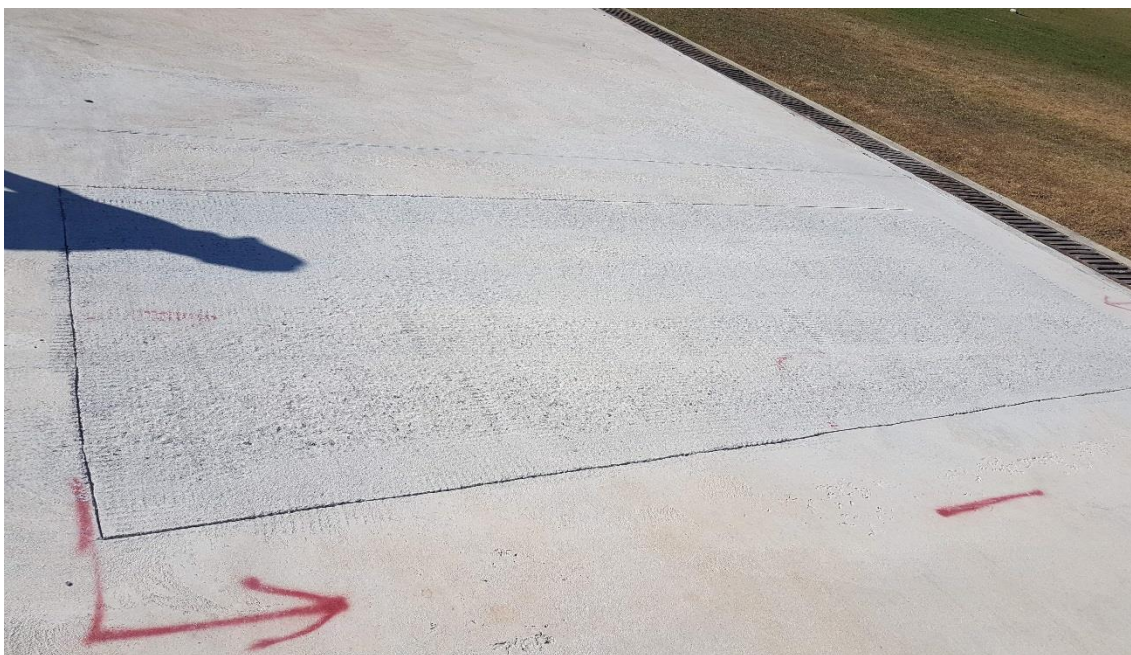
Reparos na pista de atletismo
