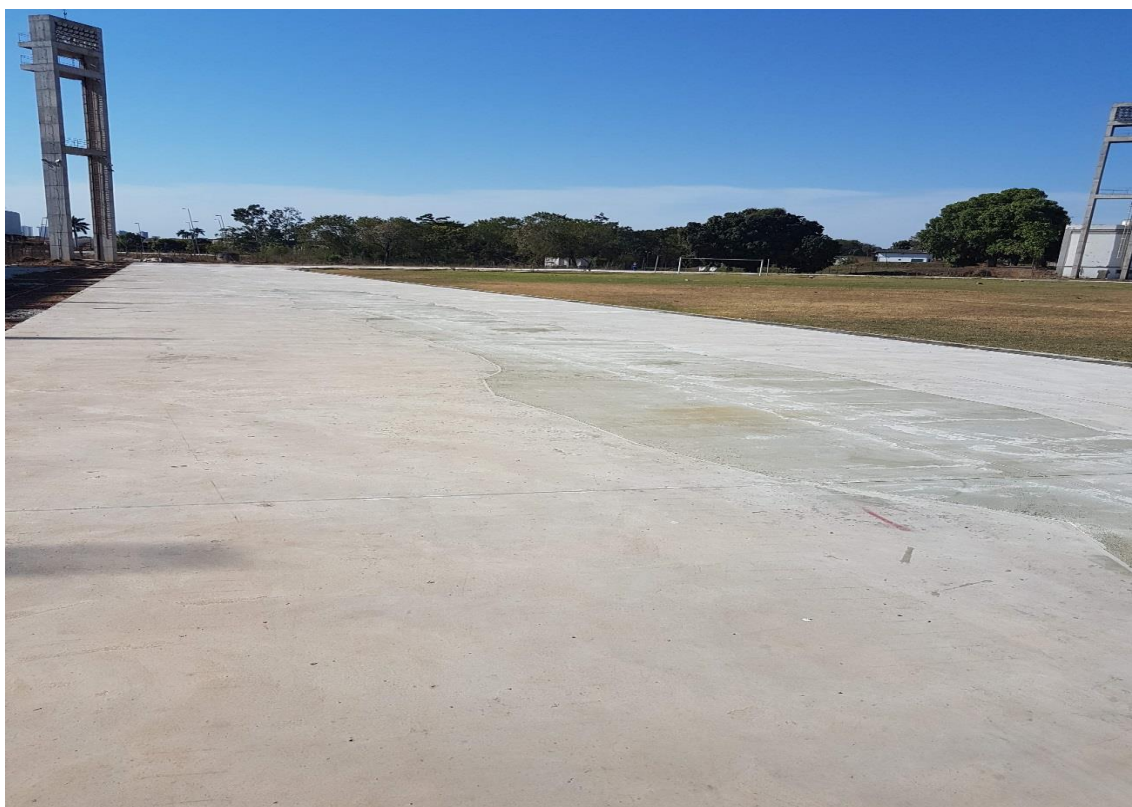
Reparos na pista de atletismo
