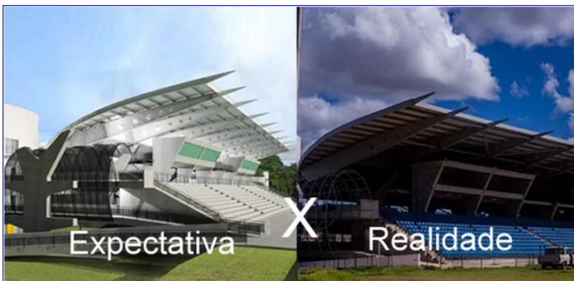
À esquerda, imagem do foto do COT da UFMT e, à direita, como estão as obras atualmente — Foto: Reprodução/ Rafaella Zanol/ Gcom-MT
