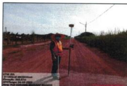
Localização Serviço RUAMENTOS PRIMITIVO (TN)
