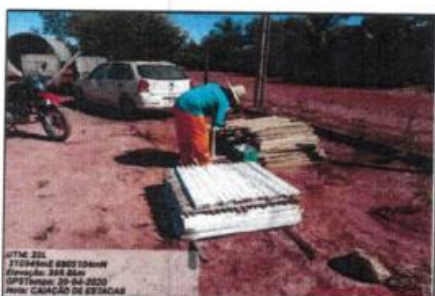
Localização Serviço SECRETARIA OBRAS CAIAÇÃO
