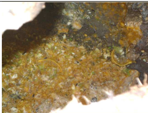
Fig. 4 – Tampa de caixa danificada expondo à contaminação os usuários do equipamento público
