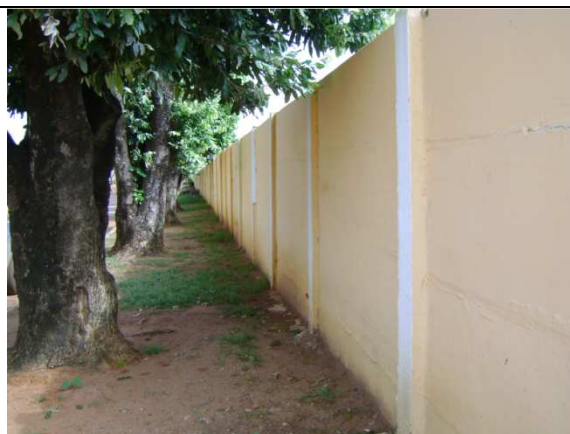
Fig. 2 – Pintura muro concreto
