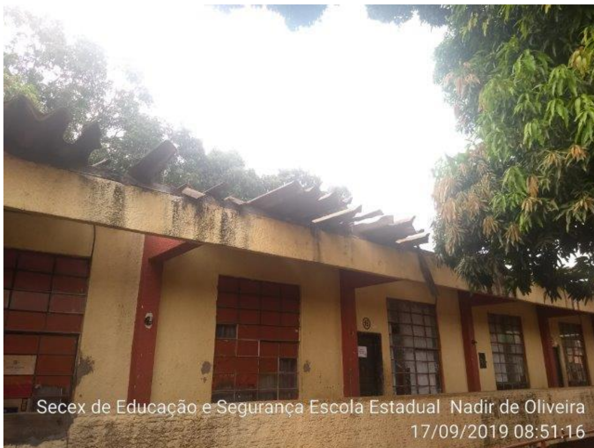
Telhado danificado
