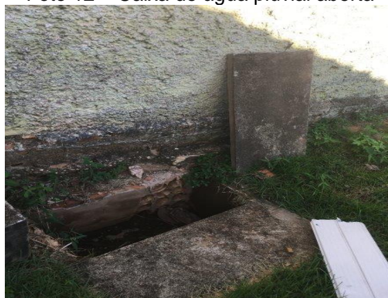
Foto 12 – Caixa de água pluvial aberta
