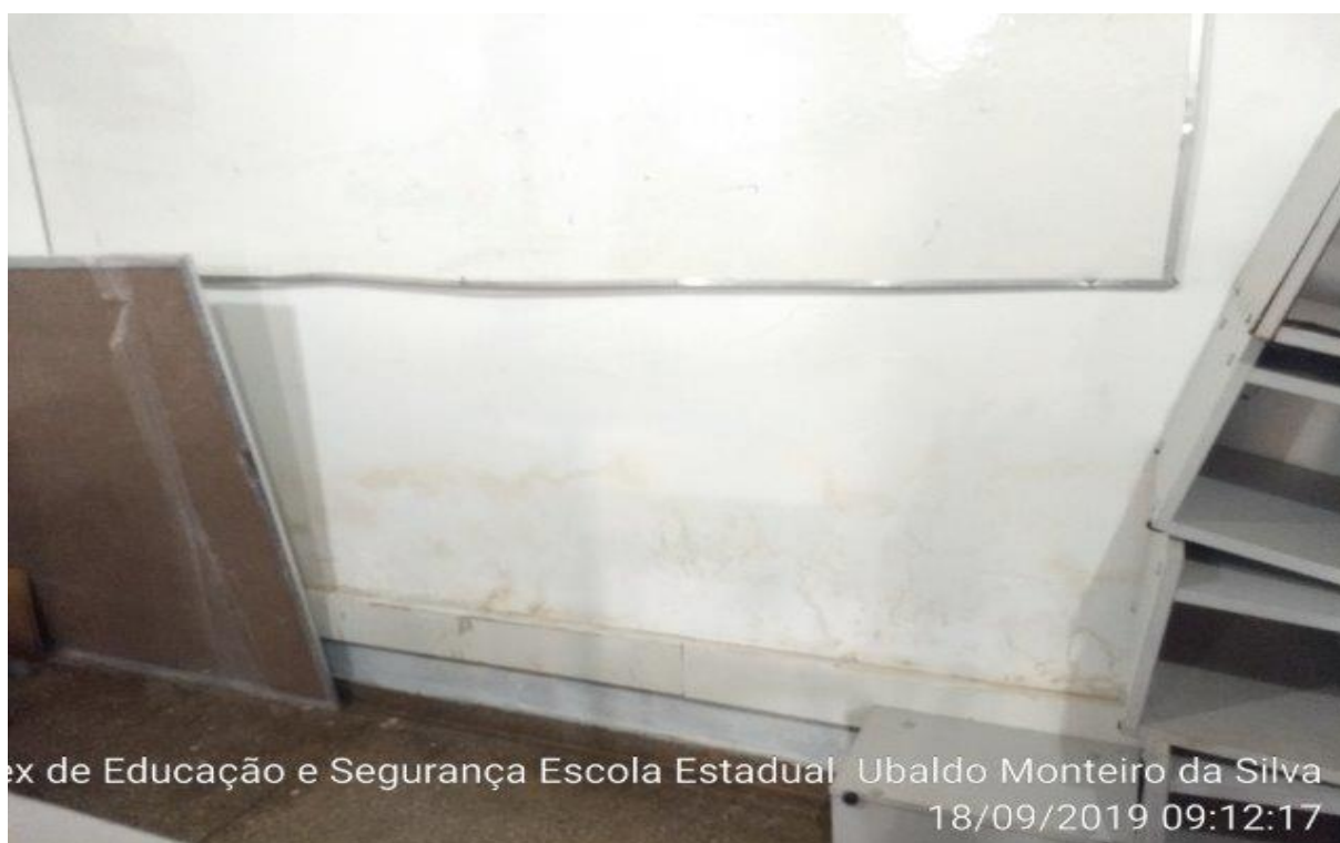
Paredes com infiltrações no laboratório de informática
