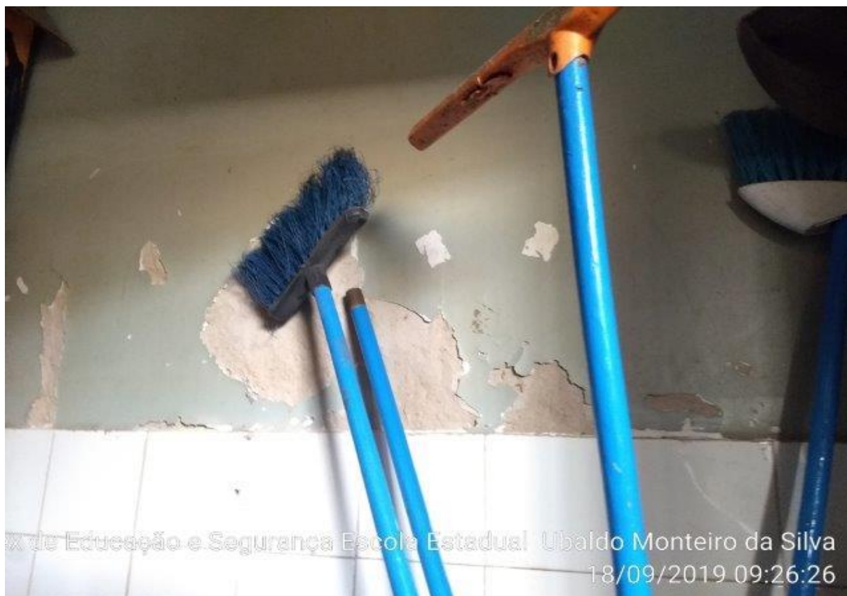
Paredes com infiltrações no laboratório de informática
