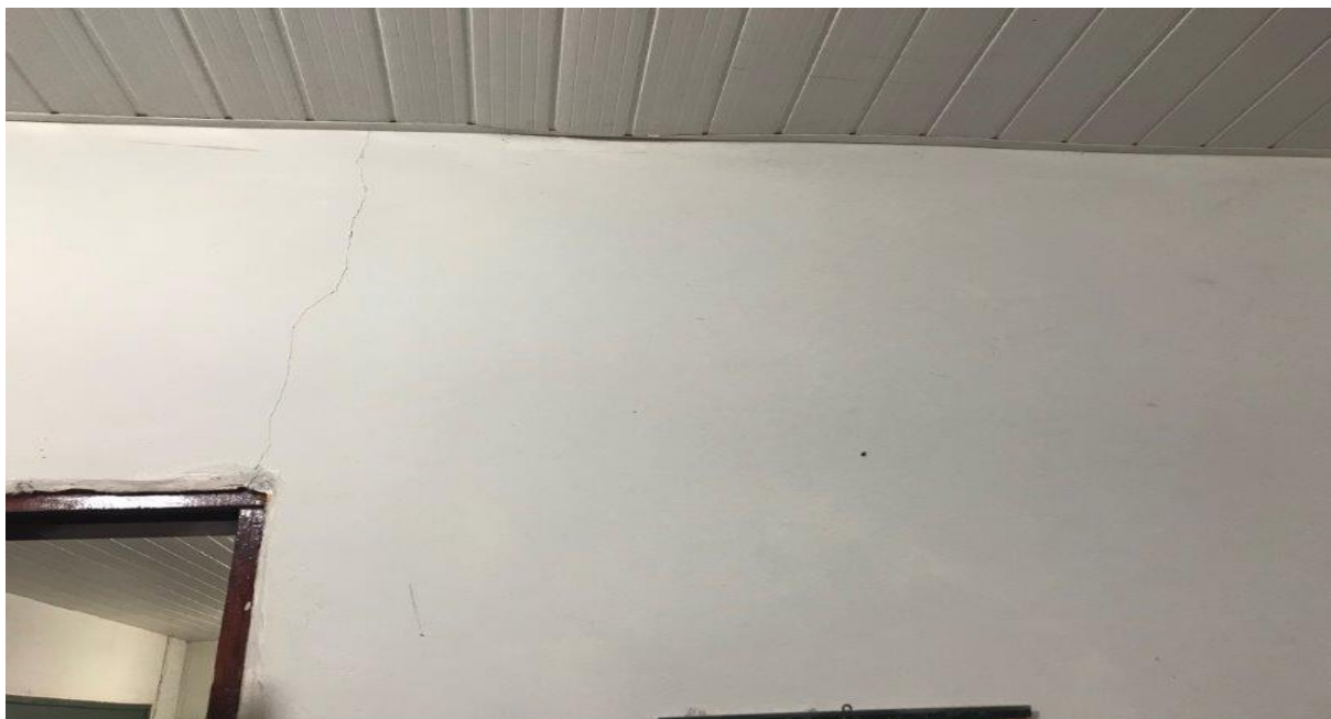
Parede área externa da escola com rachadura
