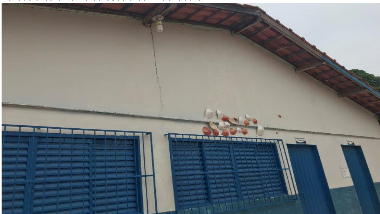
Parede área externa da escola com rachadura
